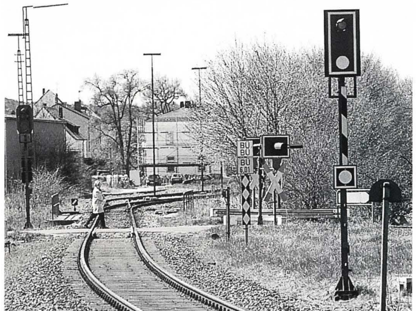
Abb. 7.13: Bü-Überwachungs-Signal Bü100/101 (Wiederholer) kurz vor einem Bahnübergang, außerdem noch Haltepunkt-Tafel Ne6 und Pfeiftafel Bü4
