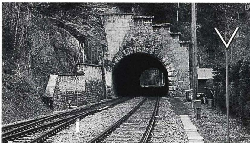
Abb. 2.15: Ein „Pärchen“ Schneepflug-Tafeln Ne7/So7 zum Schutz einer Gleis- verbindung gegen Beschädigung der Weichen durch den Schneepflug; rechts: „Senken“ hinter ei- ner (nicht sichtba- ren) Weiche; links hinten vor Stütz- mauer: „Heben“ vor einer Weiche. Zwischen den Gleis- sen: Ra12 in „ho- her“ Bauform
