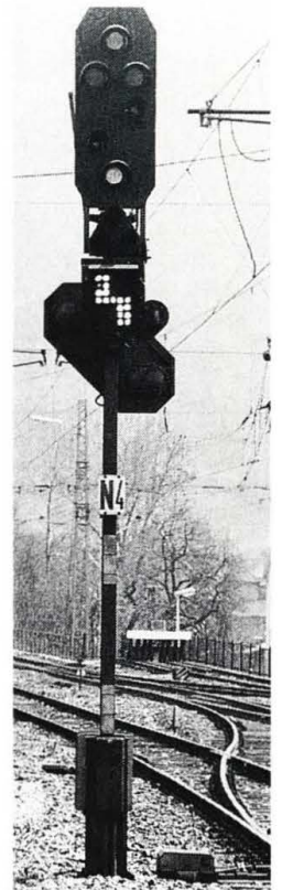
Abb. 6.15: Gleiswechselanzeiger Zs6 (hier von rechts nach links) unter einem Lichtsignal
