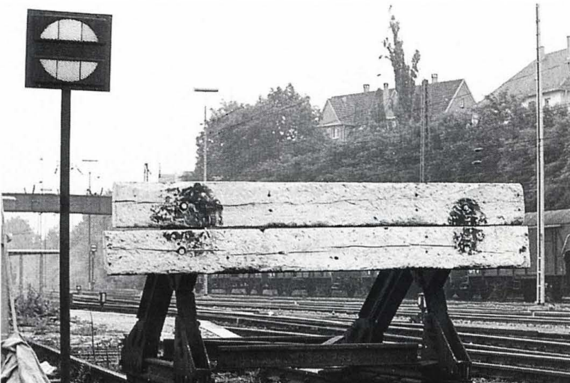
Abb. 9.1–9.3: Die Sh0-Scheibe als Gleisabschlußsignal in ver- schiedenen Aufstellungsversionen am Prellbock (oder was man dafür halten mag)
