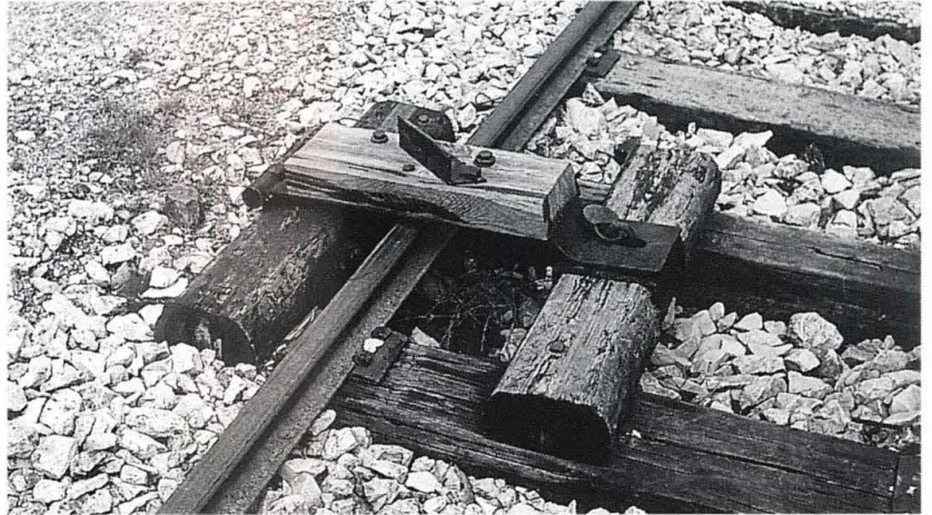
Abb. 4.8: Primitiv anmutend, aber dennoch wirk- sam: Gleissperre an der ehemaligen Härtsfeldbahn
