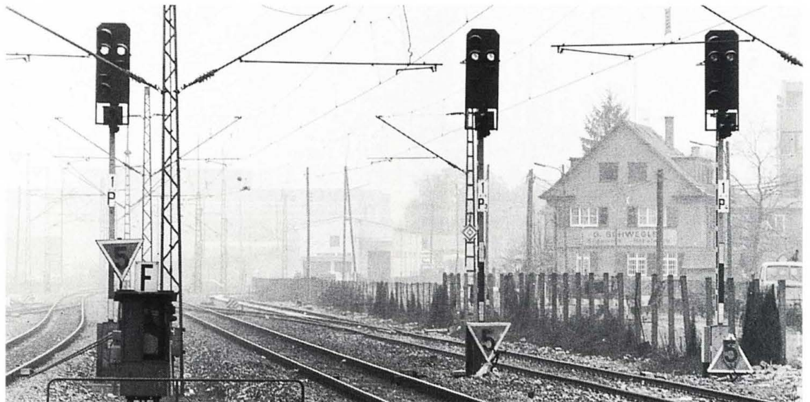
Abb. 10.6: Lf1-Signale an Ausfahrtsignalen; rechts mit der Dreieck-Spitze nach oben (offensichtlich mit gesondert – nach Bedarf – aufsetzbaren Ziffern)
