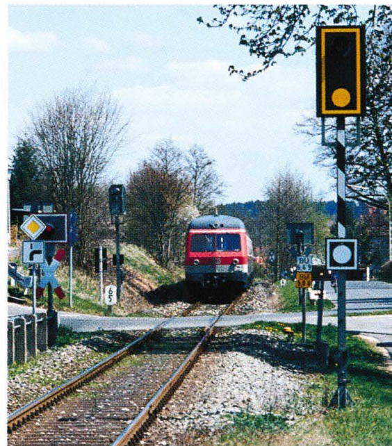
Zu den Seiten 96/97: Langenzenn, jedoch am anderen Ortsausgang; Bü-Signalwiederholer und Bü-Ankünde- bzw. Bü-Kennzeichen-Tafeln, hier jedoch alleinstehend ohne Rautentafel.
