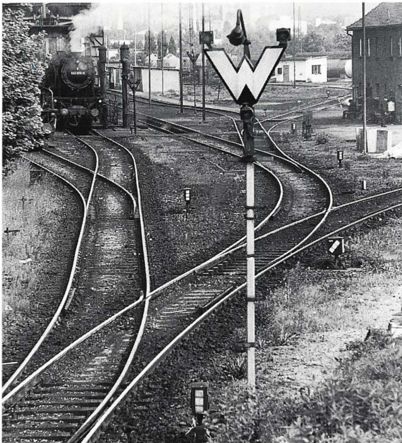
Abb. 8.13: Wartezeichen mit dem bis 1959 gülti- gen Vorrücksignal Ve6 (drei weiße Lichter in V-Form)
