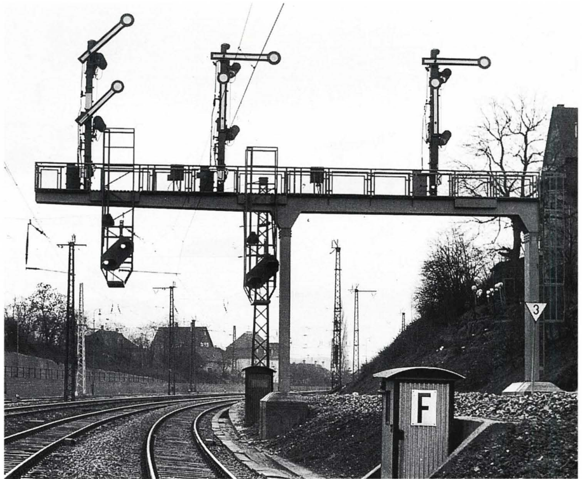
Abb. 3.17: Licht-Vorsignale und Form-Haupt- signale gemeinsam an einem Signal- Brücken-Ausleger
