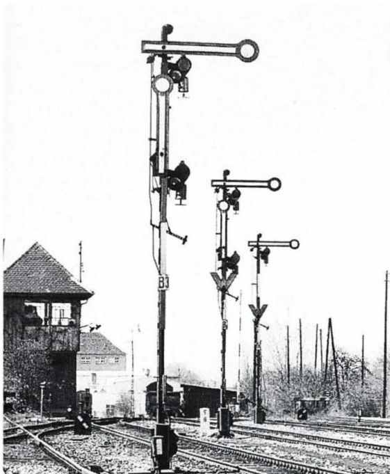
Abb. 3.13 (links): In zur Gleisachse schräger Linie aufgestellte Form-Hauptsignale
