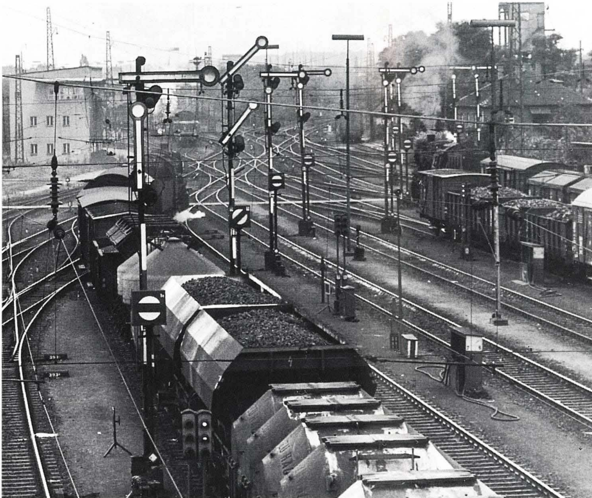
Abb. 3.30: Noch ein Bild vom Rangierbahnhof Nürnberg (vor der Modernisierung): Der Güterzug fährt mit Hp2 aus, das Gleisperrsignal ist vorschriftsmäßig gleichzeitig auf Sh1 gestellt. Die Sh-Si- gnale hatten übri- gens alle das kleine Quadrat-Schild (Kapitel 2 und 8).
