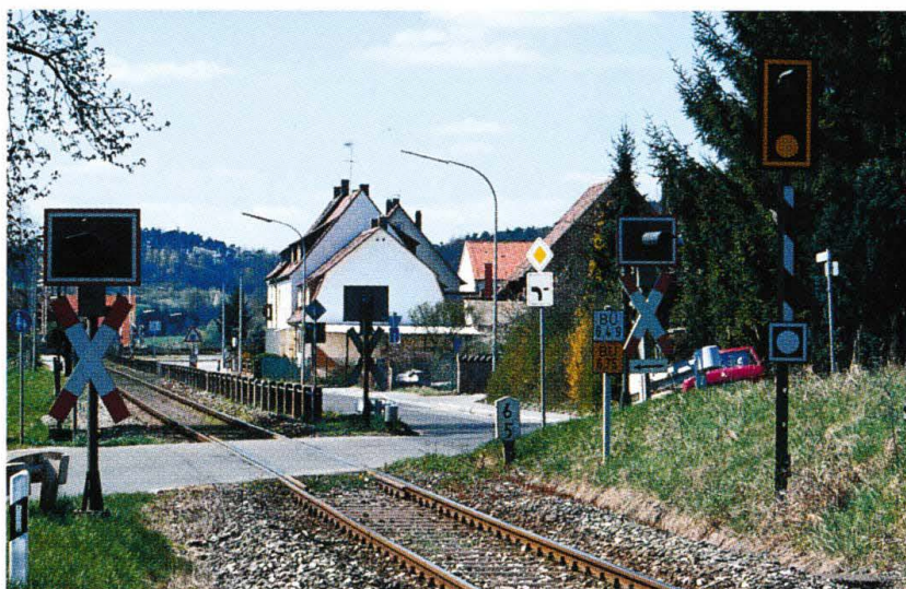
Zu den Seiten 96/97: Langenzenn, jedoch am anderen Ortsausgang; Bü-Signalwiederholer und Bü-Ankünde- bzw. Bü-Kennzeichen-Tafeln, hier jedoch alleinstehend ohne Rautentafel.
