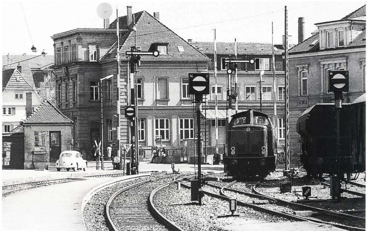
Abb. 7.6: Situation am rechten Bahnhofskopf von „Kirchheim/Teck“: am Ausfahr-Signal C1 (links) Lf4-Tafel für 15 km/h
