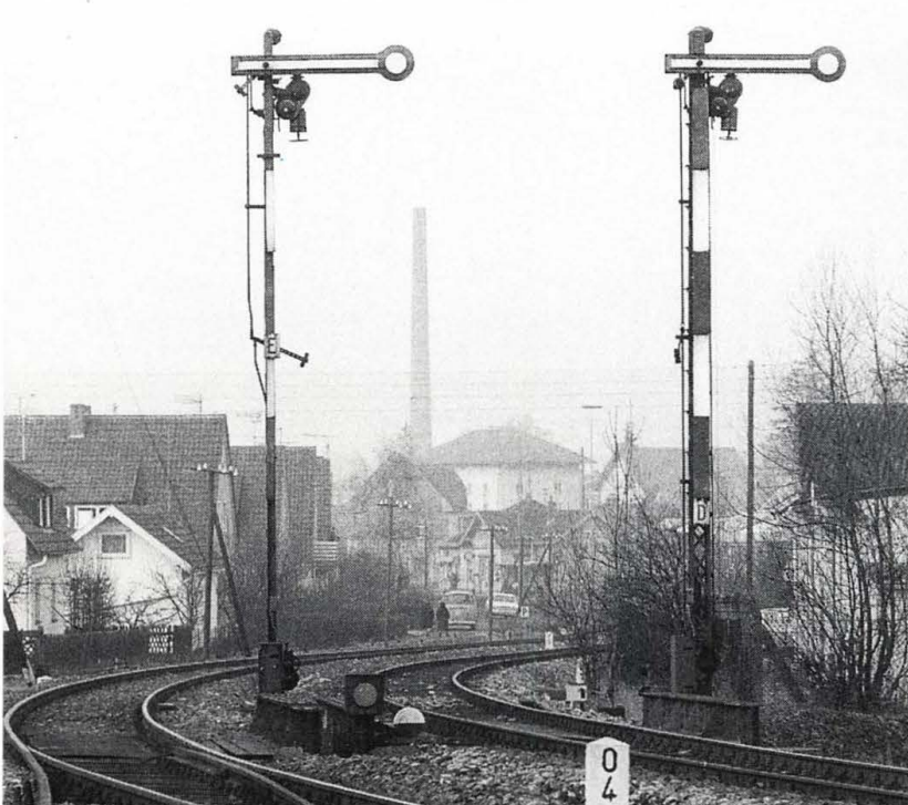
Abb. 3.7: Links: Hauptsignal mit Schmalmast, rechts: Normal- Mast
