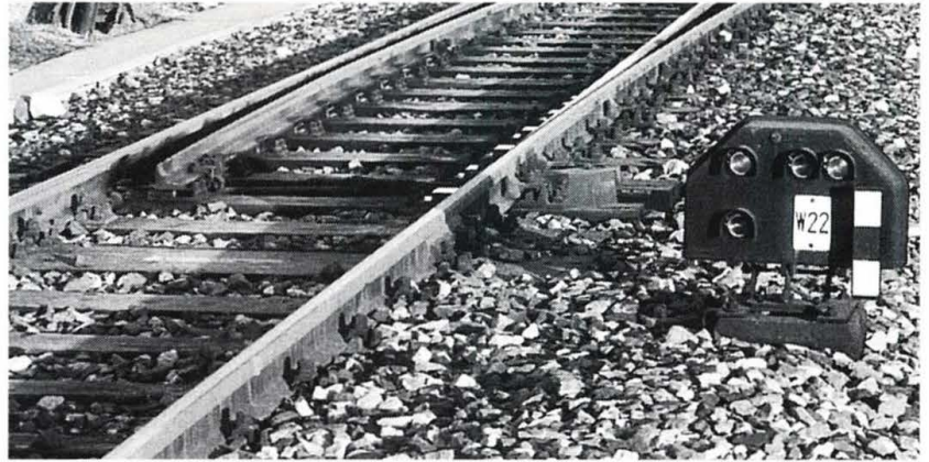
Abb. 8.9: Licht-Gleissperr- signal in Zwergform
