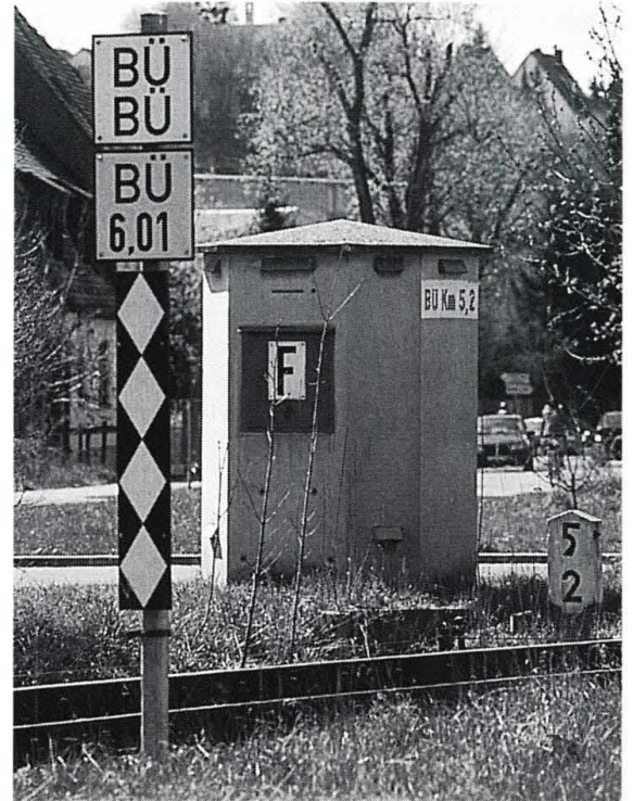
Abb. 7.15: Bü-Ankünde-Tafel und Bü-Kennzeichen-Tafeln über einer Rautentafel. Im Hintergrund Schalt-haus für die gesamte Steuermimik des Bahnüberganges
