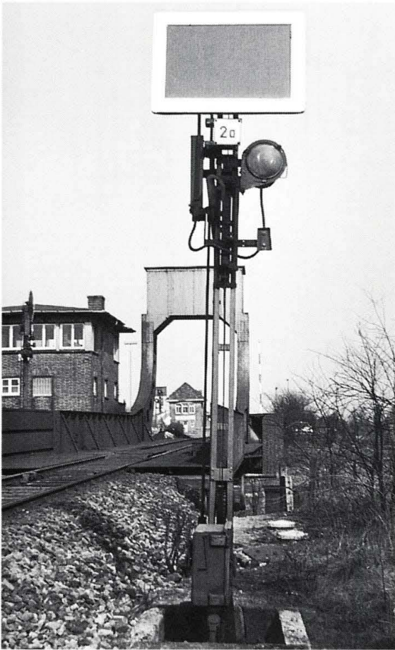
Abb. 5.8: Deckungsscheibe Sh2 vor einer Klappbrücke
