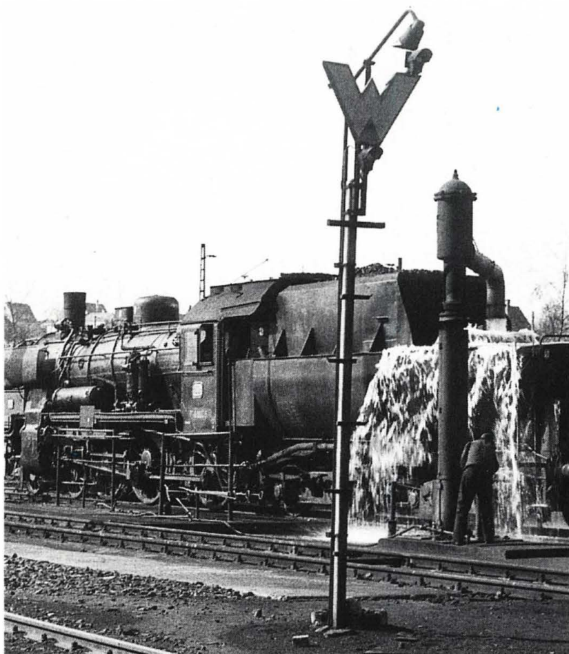
Abb. 8.11: Beleuchtetes Warte- zeichen Ra11 mit Lichtsignal Sh1
