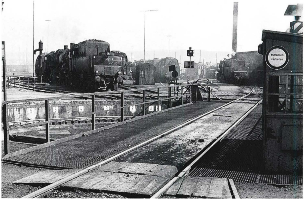
Abb. 8.7: Drehscheibe mit Gleisperrsignalen (hier in Sh1-Stel- lung): hinten am Drehscheibenende links und rechts über dem Wärterhaus
