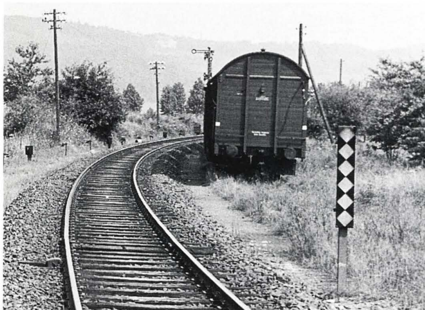
Abb. 2.14: Rechts vom Gleis die DB-Rautentafel Bü2: ein Überwa- chungssignal für Bahnübergänge ist zu erwarten.
