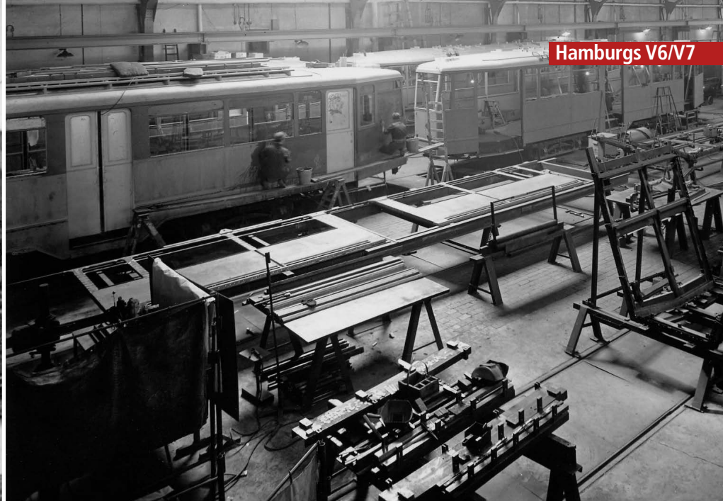
OBEN Fertigung der V6-Fahrzeuge in der Halle A der Fahrzeugwerkstätten Falkenried, dem HHA-eigenen Fertigungsbetrieb HHA, SLG. LUTZ ACHILLES (2)
