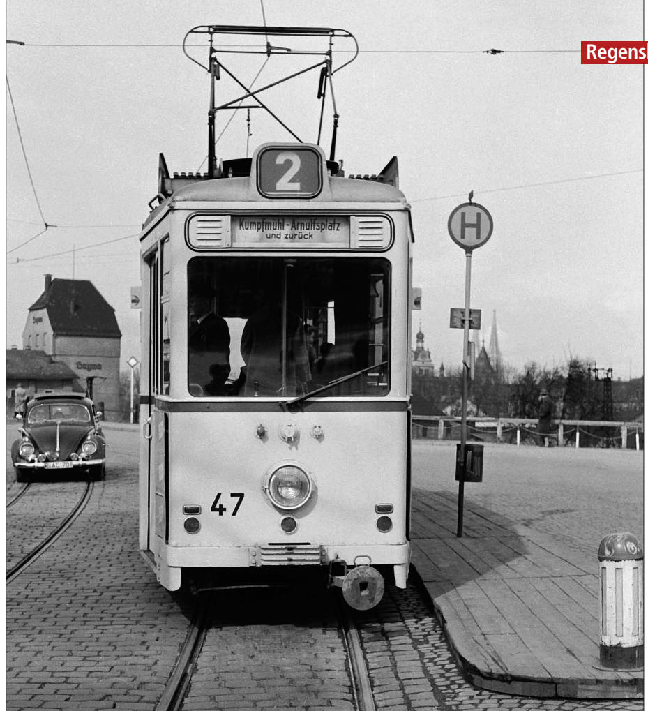
Tw 47 an der Ausweiche Friedenstraße im März 1959. Dieser Verbandswagen von der Firma Rathgeber wurde 1955 in einer Serie von vier Triebwagen und vier Beiwagen gekauft, um auf der geplanten zweigleisigen Strecke nach Kumpfmühl zu fahren
