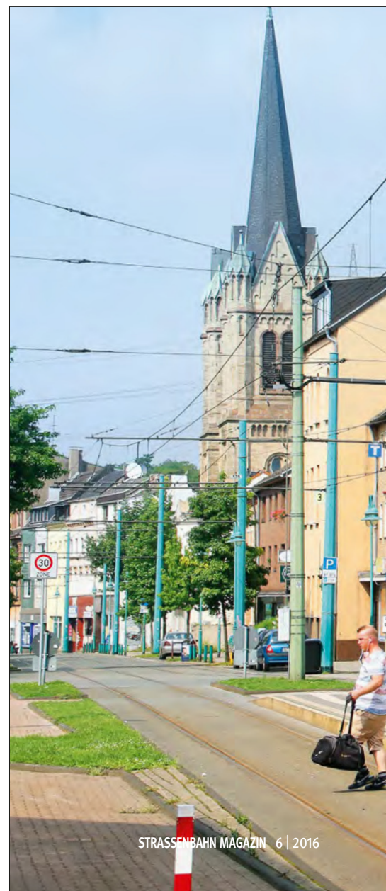
Dieser enge Gleisbogen in Ruhrort ist noch einer der wenigen Knackpunkte im Netz: Ihn dürfen bislang nur 2,20 Meter breite Fahrzeuge durchfahren. Für neue Fahrzeuge müsste hier eine Lösung gefunden werden, zum Beispiel ein Begegnungsverbot
