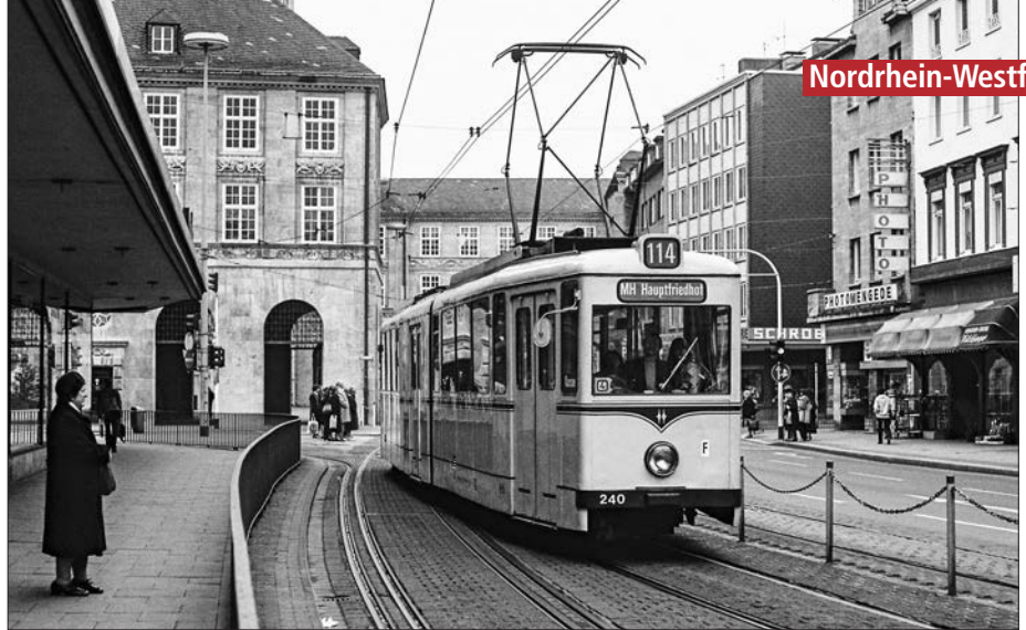
Anzeichen der „Verbundenheit“: Tw 240 neben dem Dreischienengleis für die Mülheim mit Duisburg verbindende Linie 901
