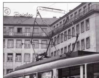
Osnabrücks Straßenbahn entwickelte die nachstellbare Kohlestütze, die dann auch in Hannover vereinzelt eingebaut wurde (hier KSW-Tw 232 im Juni 1955 auf dem Ernst-August-Platz)
