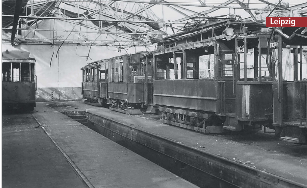
OBEN In der Kleinen Wagenhalle (von der Apelstraße aus erreichbar) steht 1945 links auf Gleis 21 ein nur wenig beschädigter „Pullmann-Beiwagen“ (LVB-Typ 56). Unter den beschädigten grün lackierten Arbeitstriebwagen befindet sich im Vordergrund ein Wagen des Typs 15, der später nach Reparatur trotz seines hohen Alters (erbaut 1900) noch weiter anderweitig Verwendung fand
