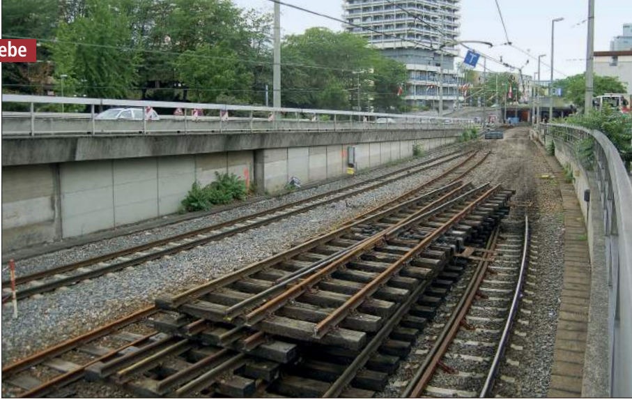
Der 2008 stillgelegte C-Tunnel ist bei Baumaßnahmen im Stadtteil Hemshof bereits vom Gleisnetz abgetrennt worden. Gleismaterial wartet auf eine neue Verwendung
