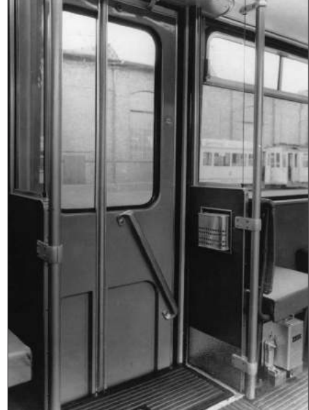
Die Mainzer Wagen von innen: Links erkennt man Quer- und Längssitze sowie den erhöhten Schaffnerplatz, in der Mitte der Fahrerstand und rechts ein Türbereich der nicht genutzten Fahrzeugseite mit Abdeckungen über den Trittstufen
