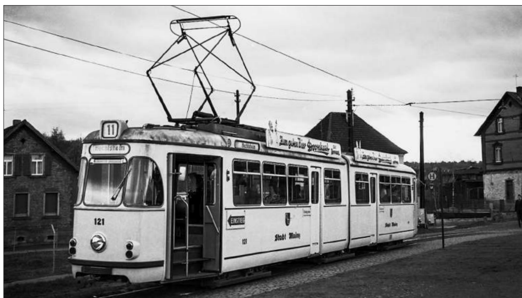
Tw 121 an der Endstation Finthen im April 1959. Die geöffnete Hecktüre gibt den Blick auf die Einstiegsverhältnisse und den Schaffnerplatz mit Wechselkasse frei
