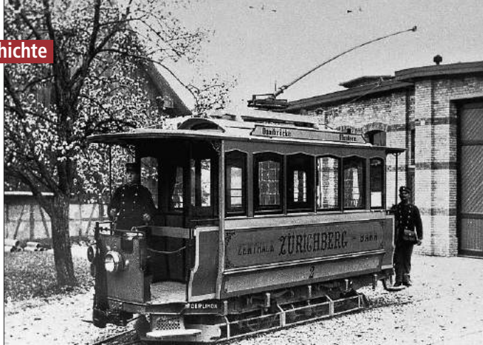
MITTE Zentrale Zürichbergbahn (ZZB); das Bild zeigt den Ce 2/2 Nr. 2 vor dem Depot in Fluntern im Jahr 1895. Die Fahrzeuge waren sehr ähnlich denjenigen der ESZ, besaßen aber von Anfang an zwei Fahrmotoren
