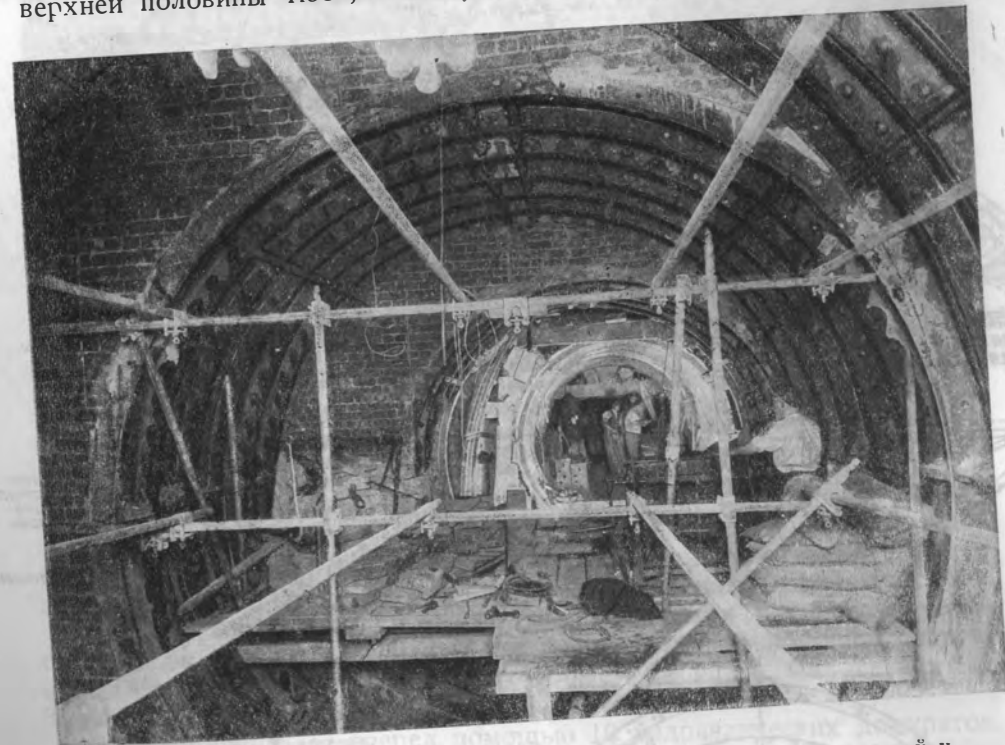
Рис. 59. Пересечение тубов разных диаметров в месте подхода галерей и эскалаторного тоннеля к машинной камере.
