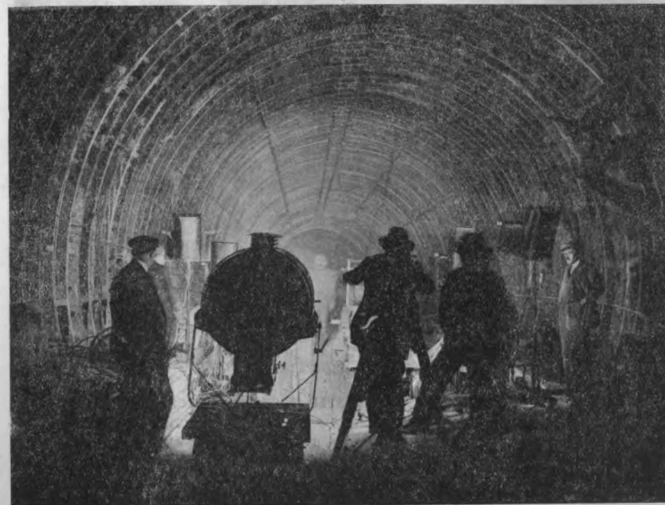
Рис. 25. Работы по разбивке оси тоннеля. Освещение прожекторами.
