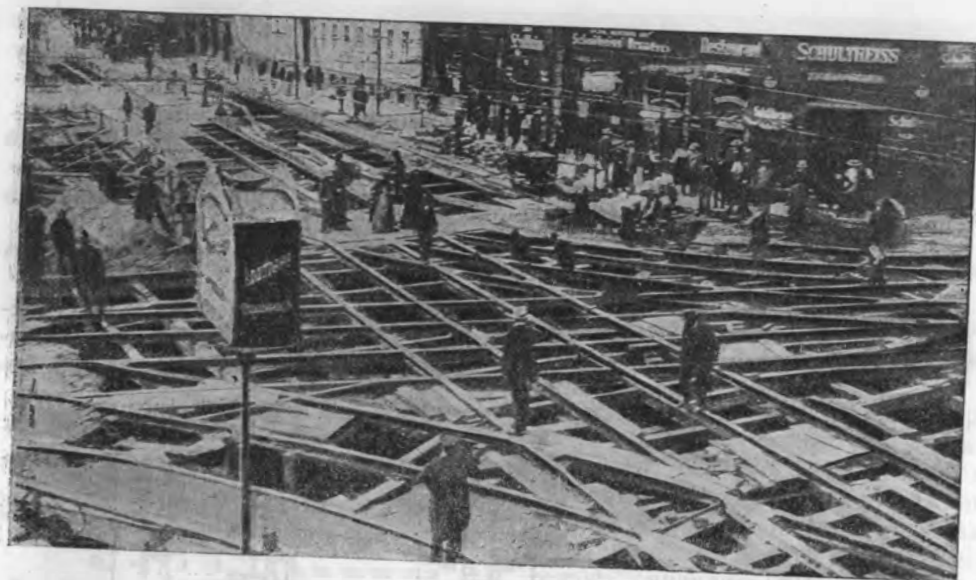
Рис. 321. Проходка открытым берлинским способом под сложным трамвайным узлом на „Хаузее“.
