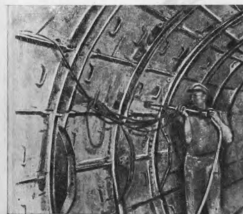
Рис. 409. Работа с вибратором, сотрясающим металлическую опалубку тоннельной обделки.
