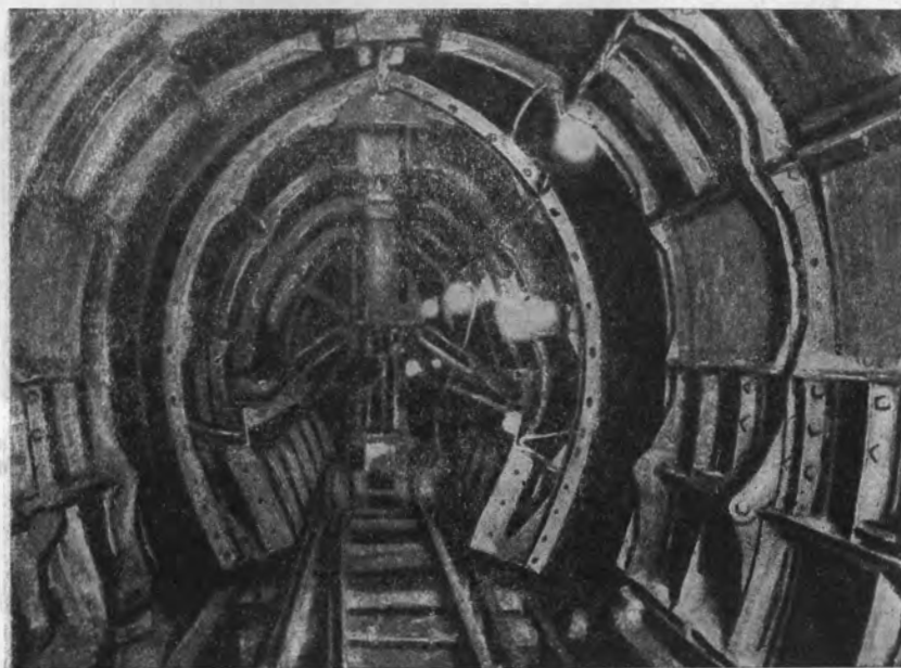
Рис. 406. Подвижная металлическая форма Блоу Нокс для бетонирования обделок сводчатых тоннелей.
