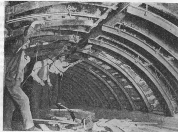
Рис. 82. Устройство опалубки для работ по заполнению ребер тубингов тоннеля бетоном.
