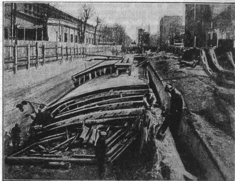
Рис. 163. Вид работ по сооружению станции „Эдуард Виллан“. Уложена одна половина свода.
