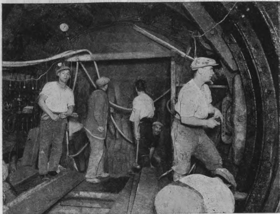
Рис. 26. Лоб забоя в лондонской глине, при работе пневматическими лопатами под защитой щита Гредхэда.
