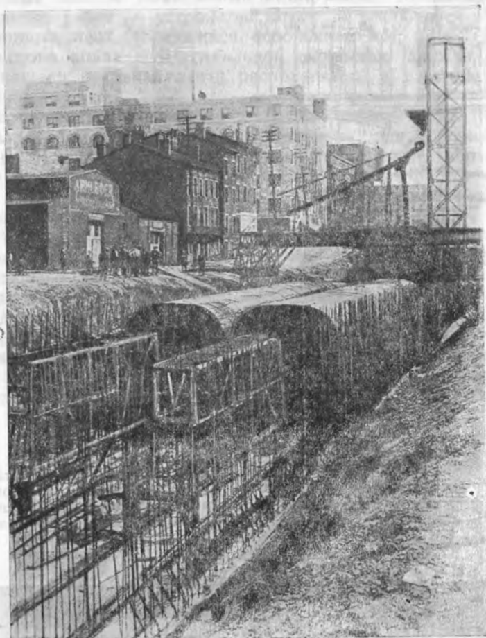
Рис. 401. Металлические подвижные формы системы Блоу Нокс для сооружения железобетонных конструкций тоннелей метрополитенов при открытом способе работ.
