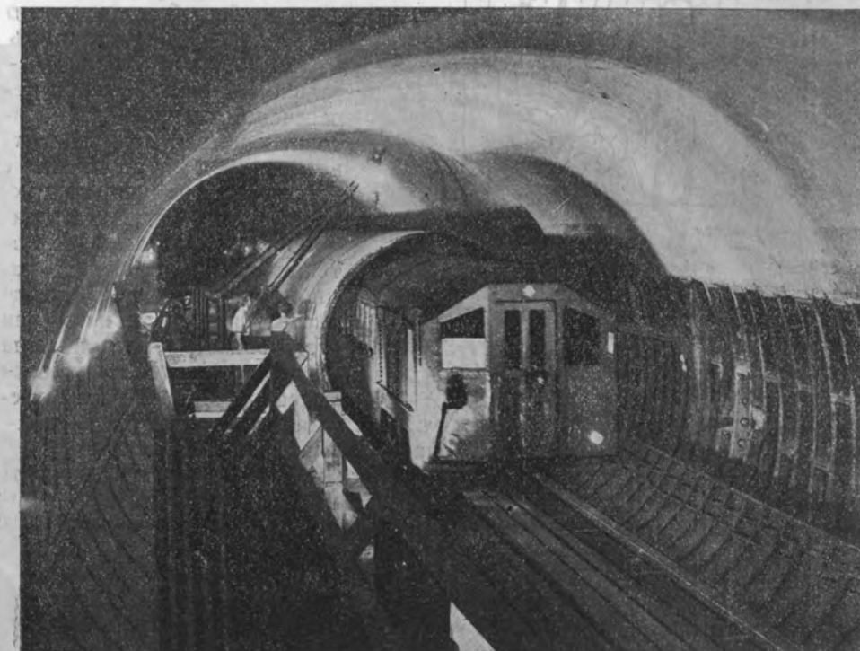
Рис. 63. Реконструкция станции „Холборн“. Расширение профиля перегонного туба в станционный для увеличения длины платформы; производится без перерыва нормального движения поездов.
