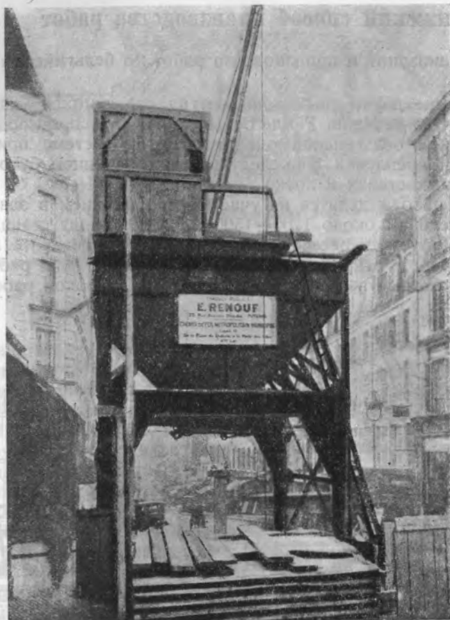
Рис. 116. Металлический бункер и кран над устьем шахты посередине улицы.
