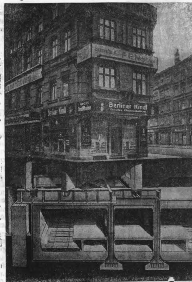
Рис. 265. Схема расположения подземной станции «Котбюсер Тор» линии «Гезундбруннен Нейкельн». Специальная конструкция стен и колонн, поддерживающая дом, независимо от тоннеля станции.
