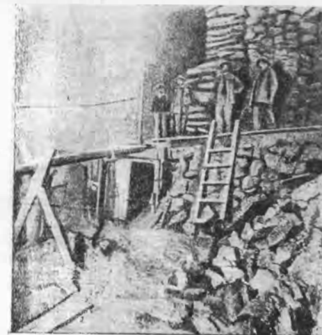
Рис. 386. Защитная перемычка, образованная из мешков с песком, глиной и бутовым камнем.
