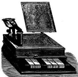
Рисунок 2.24 – Клавиатура телеграфного аппарата Бодо
