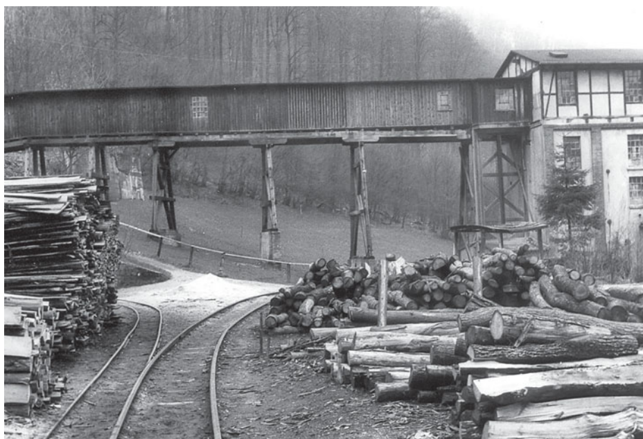
Abb. 53/54: Eine lange Holzverschalte Förderbrücke diente dem Erztransport vom Stapelschacht und dem Entladebunker der Waldbahn zur Waschanlage. Das Gleis zum Grubenholzlagerplatz liegt schon sechs Meter höher als das Streckengleis. Beide Fotos: Slg. Foto-Lindenberg, Bad Lauterberg
