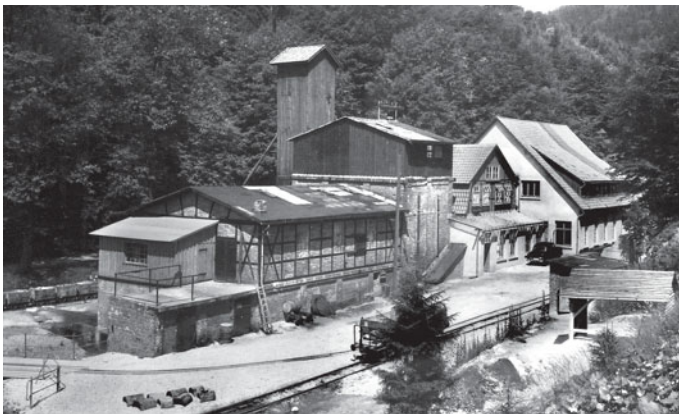
Abb. 57: Überblick über die Grube Wolkenhügel von Südosten gesehen. Das im Bogen liegende Gleis gehört nicht zur Grubenbahn, sondern ist 500-mm-spurig wie die untertägige Förderbahn. Foto: Heimatmuseum Bad Lauterberg
