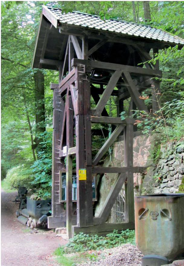
Abb. 66: Das Fördergerüst des Ostschachtes hier vor dem Eingang des Bergbaumuseums Scholmzeche in Bad Lauterberg wieder errichtet. Aus Platzgründen musste der untere Teil des hinteren Ständerwerks weggelassen und der obere auf eine vorhandene Mauer aufgesetzt werden, was jedoch den montanhistorischen Wert wenig mindert. Foto: OOK
