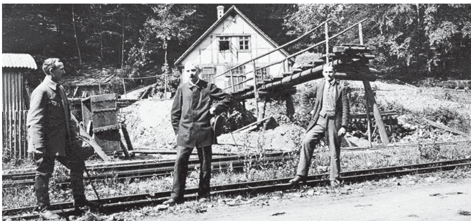
Abb. 67: Das Zeichenhaus der Knollengrube mit Grubenbahngleis und Sturzgerüst für die Erzverladung. Dieses Bild war dem Autor der erste Beweis, dass es eine Bahn zur Knollengrube tatsächlich gegeben haben musste.
