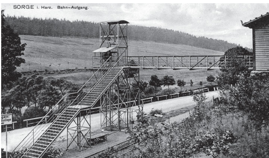
Abb. 25: Nachdem die SHE das Potential der Umsteigefahrgäste erkannt hatte, scheute sie keine Mühen und Kosten, ihnen das Umsteigen in Sorge zu erleichtern. Auf den flachen Treppen der Brückenkonstruktion war der Aufgang zum oberen Bahnsteig viel leichter zu bewältigen als mit der alten steilen Treppe am Bahndamm. Für das Gepäck war ein Aufzug eingebaut. Das Konstrukt bewährte sich jedoch offenbar nicht und wurde durch die Kurswagen auch recht überflüssig. Schon 1935 wurde es abgebrochen.
