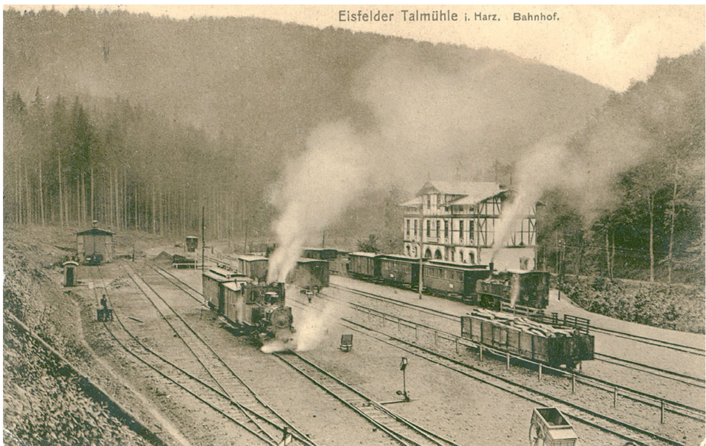
Abb. 9 und 10: Zwei frühe Ansichtspostkarten, die uns viel über den Betrieb im Anschlussbahnhof Eislefelder Talmühle erzählen: Die GHE-Züge sind kurz. Im Bild oben reichen ein Personenwagen und ein PwPost. Beim NWE-Zug ist es ein Personenwagen mehr, aber es sind zahlreiche Güterachsen angehängt. In Gleis 3 stehen Güterwagen, die von der GHE zur NWE übergehen sollen, auf Gleis 4 solche der Gegenrichtung. Wenn die Aufnahme unten, die frühestens 1911 entstanden sein kann (s. Stellwerksbude neben dem EG!) einigermaßen korrekt coloriert ist, dann können wir zwischen Güterwagen der NWE (rotbraun) und denen der GHE unterscheiden, die grün waren. Beide AK: Slg Steimecke
