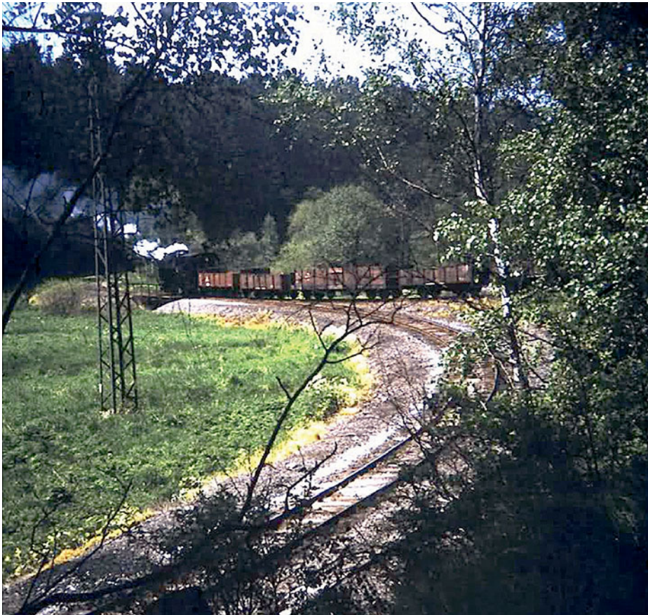
Abb. 43: Die Spitzkehre an der Selkebrücke bestand bis zum Wiederaufbau des Streckenabschnittes nach Stiege (1984). Links vom Strommast ist schwach der Prellbock zu erkennen. Die Lok drückt ihre Übergabefahrt nun zum Herzogschacht hinauf. Sofort nach der Weiche beginnt die 40-‰-Steigung. Ein seltener, wertvoller Schnappschuss, trotz der Unschärfe. Foto: Helmut Böhme
