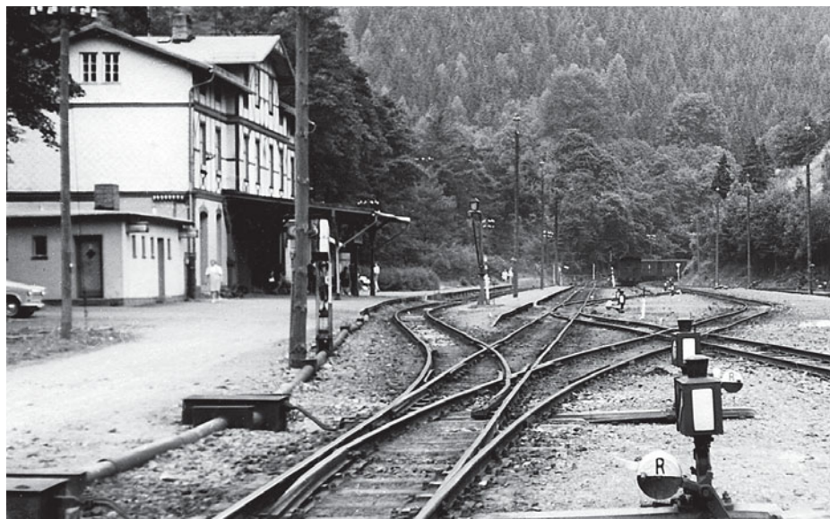
Abb. 6: Diese im Plan von 1932 erstmals sichtbare Weichenkonfiguration am Südeinde des Bahnhofs mit einer Doppelweiche und einer Kreuzung zur Ausfädelung der Gleise 8 und 9 ist im Plan von 1962 immer noch vorhanden, 1974, dem Jahr dieser Aufnahme ebenfalls, 1984 jedoch nicht mehr. Das Vorhandensein von Weichenhebeln resultiert daraus, dass die verrohrten Drahtzüge nicht zum Stellen der Weichen, sondern zu deren Verriegelung und Sicherung bestimmter Fahrstraßen dienen. Foto: OOK
