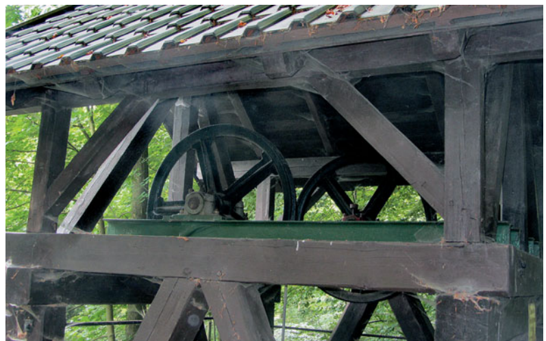
Abb. 65: Die Seilscheiben sind erhalten, doch leider ohne Seile, die die Funktion veranschaulichen könnten. Es ist aber eine Schautafel vorhanden, in denen Skizzen ähnlich den Abb. 64a und b den Zusammenhang zwischen Fördergerüst und Treibehaus erläutern. Foto: OOK
