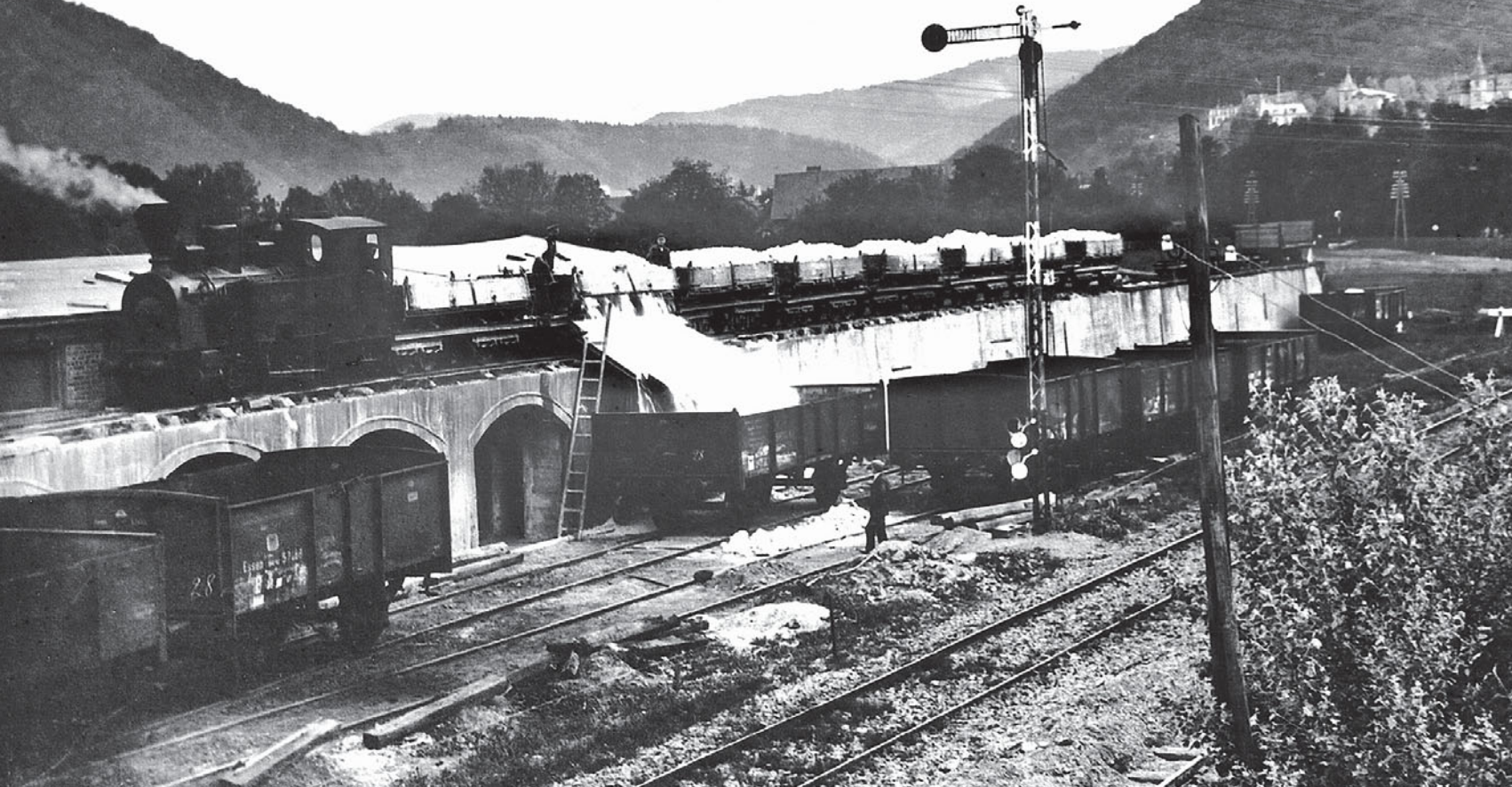
Abb. 1: Noch vor den großen Werksgebäude in Bad Lauterberg ließ Dr. Rudolf Alberti gleich nach der Eröffnung der Bahnlinie Scharzfeld–Lauterberg–St. Andreasberg eine Sturzbühne zur Umladung des Schwerspats von der Grubenbahn in die Wagen der Staatsbahn errichten. Die Dn2t-Lok JOHANNE ELISE hat die acht Seitenkipper auf die Bühne gedrückt. Slg. Foto-Lindenberg, Bad Lauterberg
