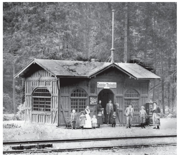
Abb. 3: Zwei Gleise und ein winziges EG: das war Eisfelder Talmühle, bevor die GHE hier an die NWE anschloss. Der Bahnbeamte im Eingang zeigt, dass der Bahnhof besetzt war. Der (geöffnete) Sperrbaum im Vordergrund hingegen deutet an, dass das zweite Gleis nicht nur für Zugkreuzungen genutzt wurde, sondern fallweise auch als Ladegleis. Foto: Slg Steimecke
