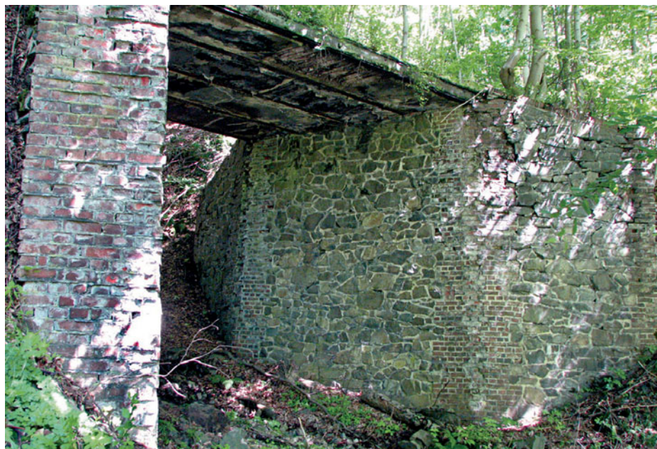
Abb. 5: Im Sekundärwald gut versteckt kann man noch heute die beiden Talquerungen der ehemaligen Verbindungsfeldbahn zwischen den Brüchen am Füllental und am Möhrenrücken finden. Das Füllental wird auf dieser ca. vier Meter breiten Fahrbahn in rund dreieinhalb Metern Höhe überquert.
