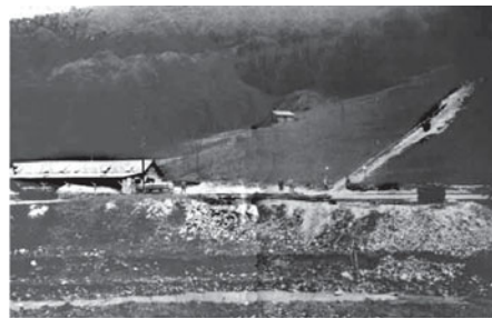
Abb. 70: Aus dem Hübichental wurde das gewonnene Erz über einen Bremsberg hinunter ins Luttertäl befördert.
