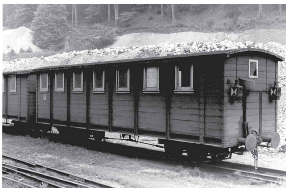
Abb. 45: Auch die Mannschaftswagen waren handgebremst – nur, dass der Bremser hier relativ geschützt im Wageninnern stand. Das kleine Stirnwandfenster ließ vom talseitigsten Wagen aus Blickkontakt mit dem Lokführer zu. Foto: A. Spühr
