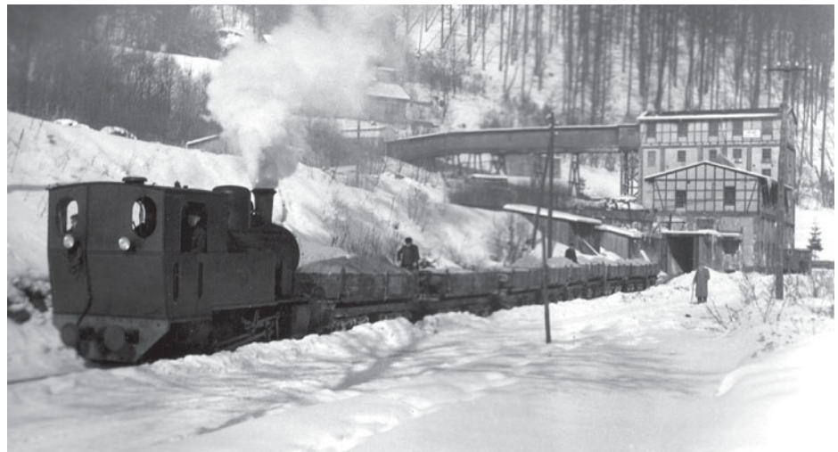
Abb. 17: Ob die Ladung dieses Zuges aus der Grube Wolkenhügel oder aus der im Hintergrund sichtbaren Grube Hoher Trost stammt, ist nicht zu sagen, denn der Rohspat aus beiden Gruben geht durch die Waschanlage Hoher Trost, deren Entladehalle ganz oben halb verdeckt von der Dampffahne der Lok zu erkennen ist. Der lange Zug ist nur noch mit zwei Bremsern besetzt, die jeder vier Bremsen zu bedienen haben. Wie das möglich ist, steht im Text. Foto: Heimatmuseum Bad Lauterberg
