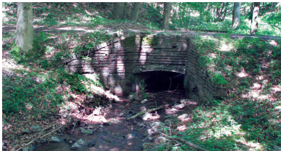
Abb. 6: Weniger auffällig die Querung des Baches aus dem Tal Gr. Lindenhöhle mittels eines kleinen aus Ziegelsteinen gemauerten Durchlasses. Fotos: OOK (2)
