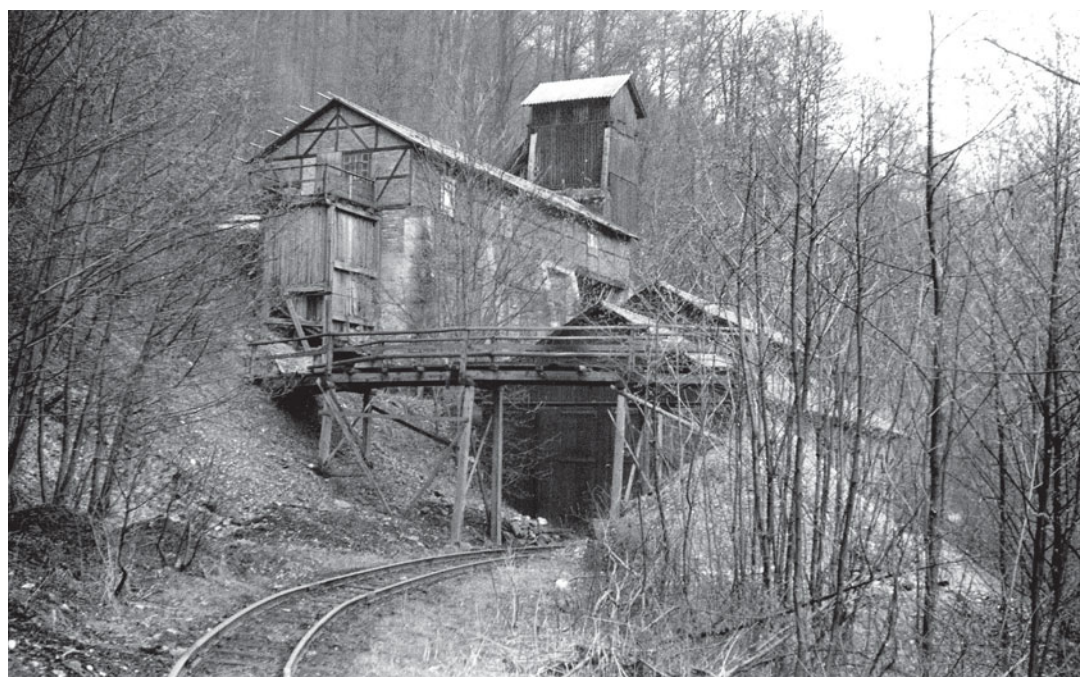
Abb. 55: Fördergerüst und Fördergebäude von Hoher Trost liegen hoch oben am Hang des Mittelberges, fast 30 m über der Talsohle mit der Grubenbahnstrecke. Das Haldengleis kommt als Verlängerung der Waldbahn aus dem hinteren Tor des Entladebunkers und führt zu einer Abraumkippe. Foto: OOK
