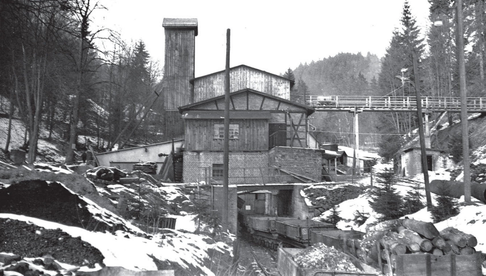
Abb. 59: Der Ladekanal der Grube Wolkenhügel hatte eine eigene Umfahrung, sodass die Grubenlok zunächst einen beladenen Halbzug aus dem Ladebunker ziehen und dann einen leeren Halbzug hineindrücken konnte. In diesem Falle geht gleich noch eine Ladung Grubenholz mit hinein, das im Bunker entladen und unter Tage verbracht werden wird. Foto: OOK (1965)
