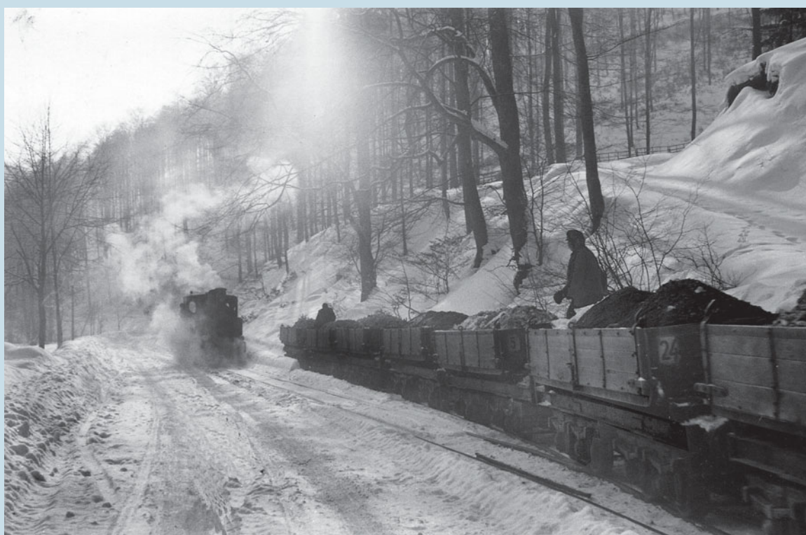
Abb. 25: Der schnellste Zug der Barytbahn. An die 30 Stundenkilometer schnell braust der schwerkraftgetriebene Spatzzug über die Weiche auf die Waldbahn. Foto: OOK
