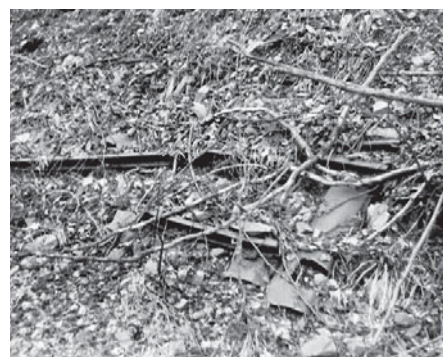
Abb. 14: Oben auf der Trasse wurde vor zwei Jahren dieses Reststück Feldbahn-gleis gefunden. Fotos: Volker Dehnke (2)
