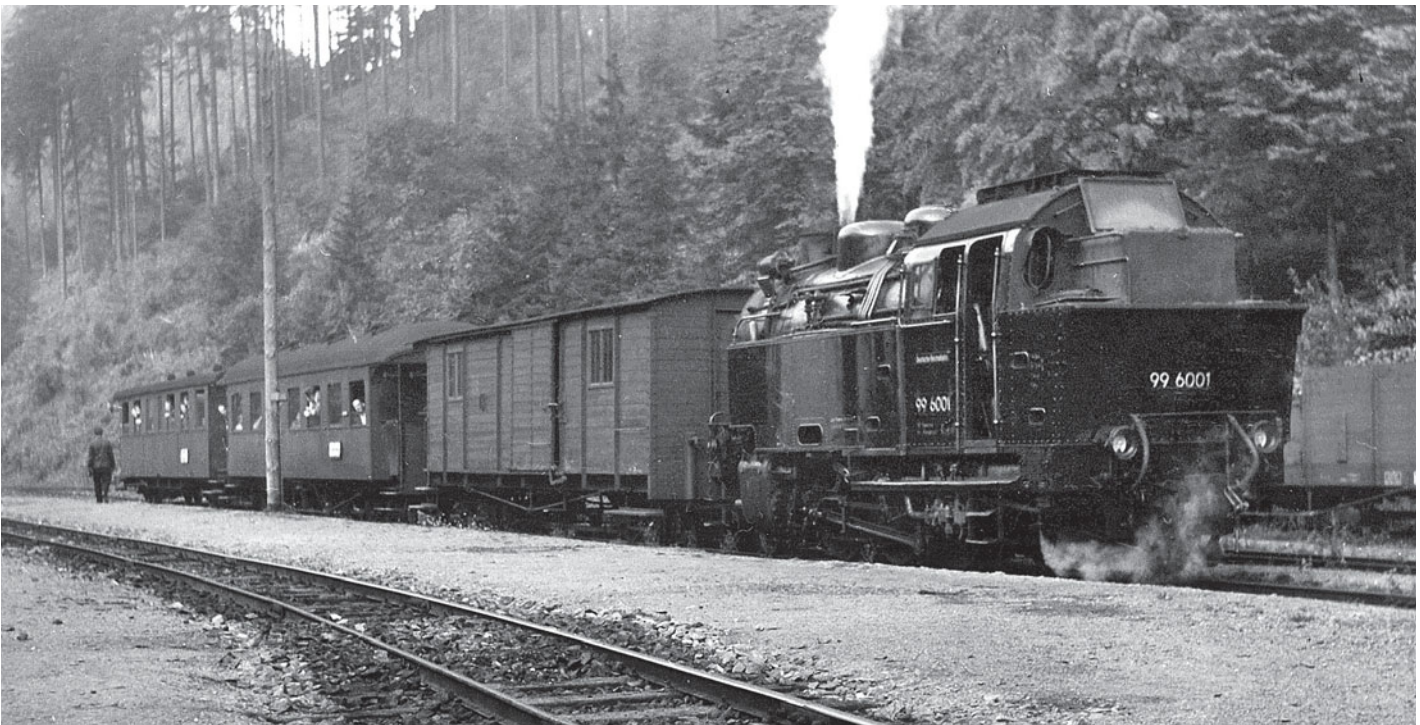
Abb. 20: Noch mal die gleiche Lok 1959 in Eisfelder Talmühle, diesmal vermutlich mit einem Sonderzug auf Gleis 5. Warum Gleis 5, einem Stumpfgleis? Vermutlich hatte es eine spitze Kreuzung gegeben und der Zug nach Hasselfelde ist soeben aus Gleis 4 ausgefahren. Der Zug auf Gleis 5 wird in Kürze zurückdrücken – der Schaffner marschiert schon in Richtung Weiche –, dann nach Gleis 4 umsetzen und anschließend nach Nordhausen weiterfahren. Foto: Slg. Heinz-Rudolf Ott
