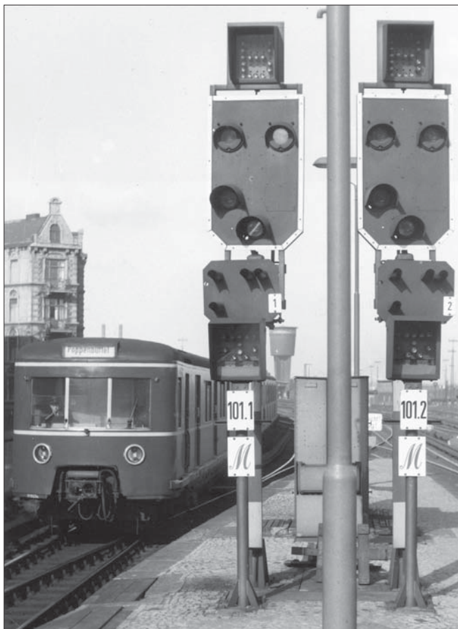
Links: Sv-Signale der Hamburger S-Bahn im Bahnhof Hamburg-Altona (1959). Beide Signale, an denen auf mündlichen Auftrag vorbeigefahren werden darf, sind mit Richtungsanzeigern, Sperrsignalen, Türschließ- und Abfahrtauftragssignalen ausgerüstet. Foto Hollnagel, Slg. SC
