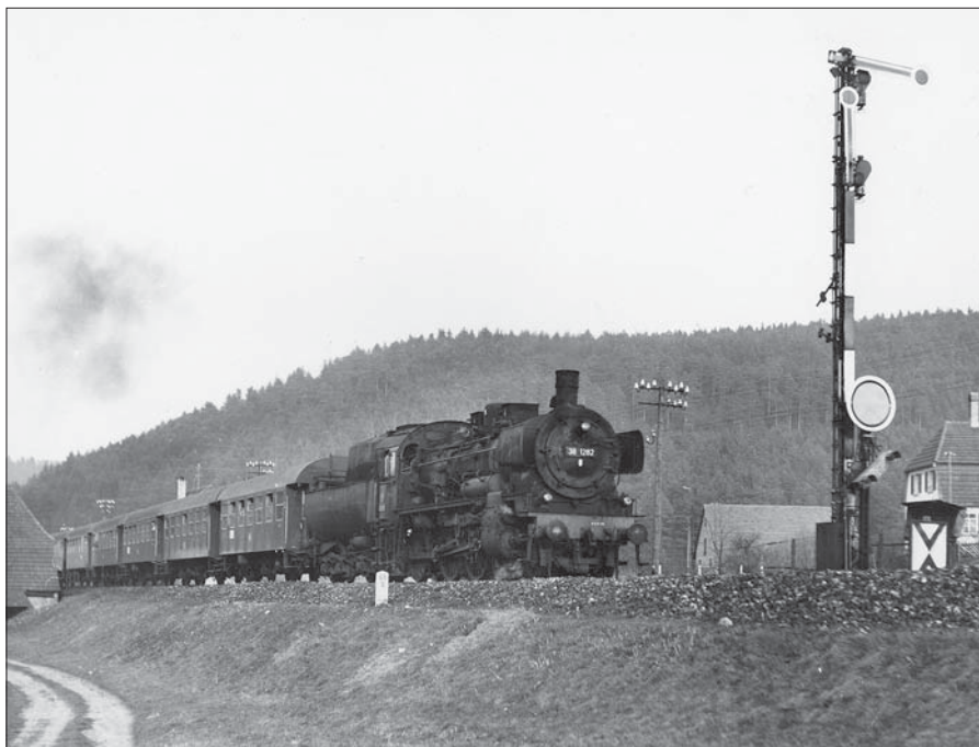
38 1282 verlässt mit einem Personenzug nach Horb im Jahr 1968 Biringen. Rechts das Einfahrtsignal (mit Negativflügeln) der Gegenrichtung und das Ausfahrtsignal mit Lichtlenkboxen. Da in Biringen nur Durchfahrten auf dem durchgehenden Hauptgleis stattfanden, war diese zweibegriffige Signalbauform ausreichend. Foto Herbert Stemmler
