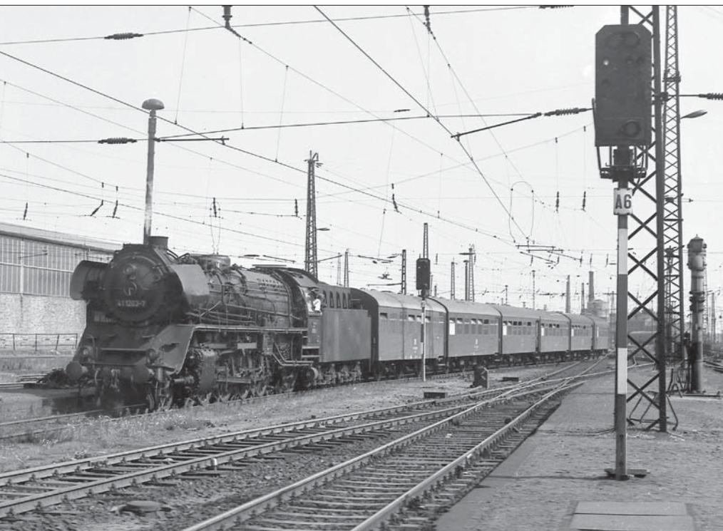
Ehemalige Hv-Lichtsignale aus den 50er Jahren am 9. März 1975 in Leipzig Hbf. Beide Signale sind inzwischen als HI-Signale geschaltet, sodass die kleinen roten Lampen des Sperrsignals entfallen konnten. Neu ist dafür ein weißes Kennlicht für betrieblich abgeschaltete Signale hinzugekommen, das beide Signale zeigen. Daneben 41 1263-7, die ihren Leerreisezug zum Abstellbahnhof schiebt. Sammlung SC
