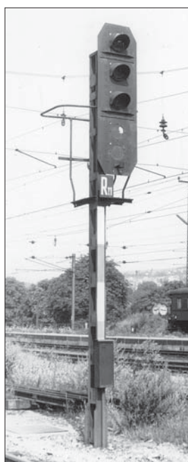
Links und oben Mitte das der Bauform 1943 entsprechende Einfahrtsignal des Bahnhofs Niklasdorf. Foto Pfeiffer, Slg. Heless. Oben rechts ein Ausfahrtsignal des Bahnhofs Wien-Hüttelsdorf im August 1964. Foto Hermann Heless
