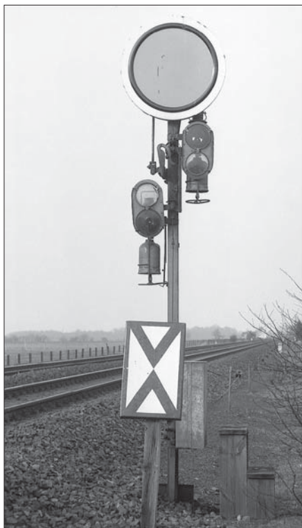
Zweibegriffiges Vorsignal der geschweißten Einheitsbauform in den Stellungen „Halt erwarten“ und „Fahrt erwarten“ in doppelter H0-Größe
