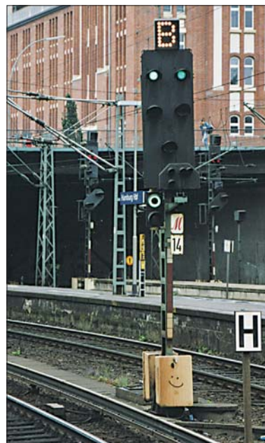
Die Ausfahrsignale in Hamburg Hbf sind die jüngsten Blendenrelais-signale im Netz der Hamburger Gleichstrom-S-Bahn. Die Fotos zeigen ein solches Signal im August 2005 für die Ausfahrt einer S-Bahn nach Berliner Tor (mit aufleuchtendem Abfahrtrautrag) und nach Harburg.
