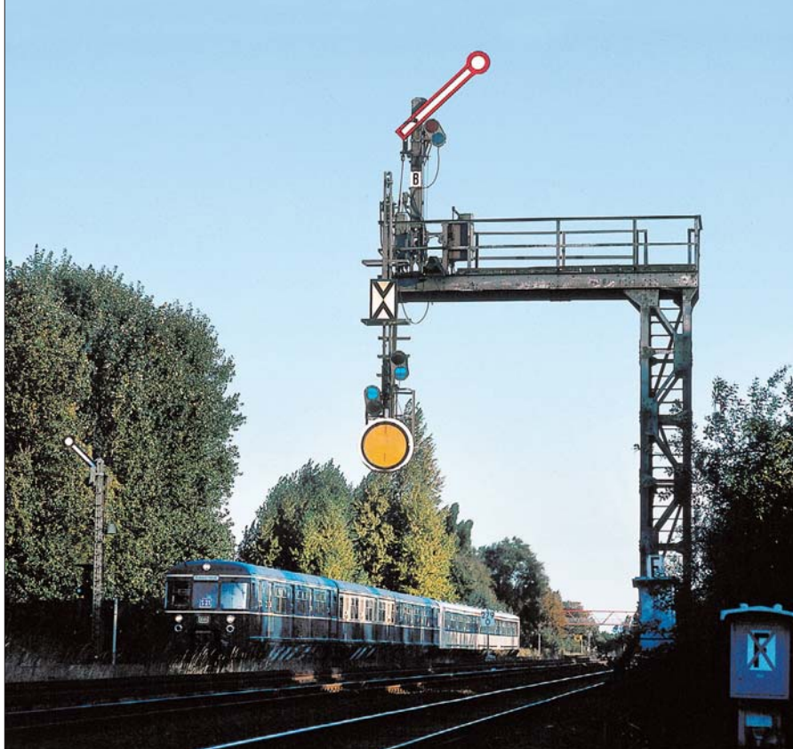
Ein Einheitssignalausleger mit elektromechanisch angetriebenen Signalen im Oktober 1983 bei Hamburg-Billwerder.
