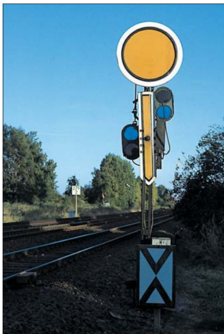
Das Einfahrersignal des Gbf Billwerder im Oktober 1983. Das Signal besitzt einen Mast der Ursprungsbauforn und hat nachträglich den Zusatzflügel sowie die Blendensteuerung eines Signals der Bauart Vo 44 erhalten.
