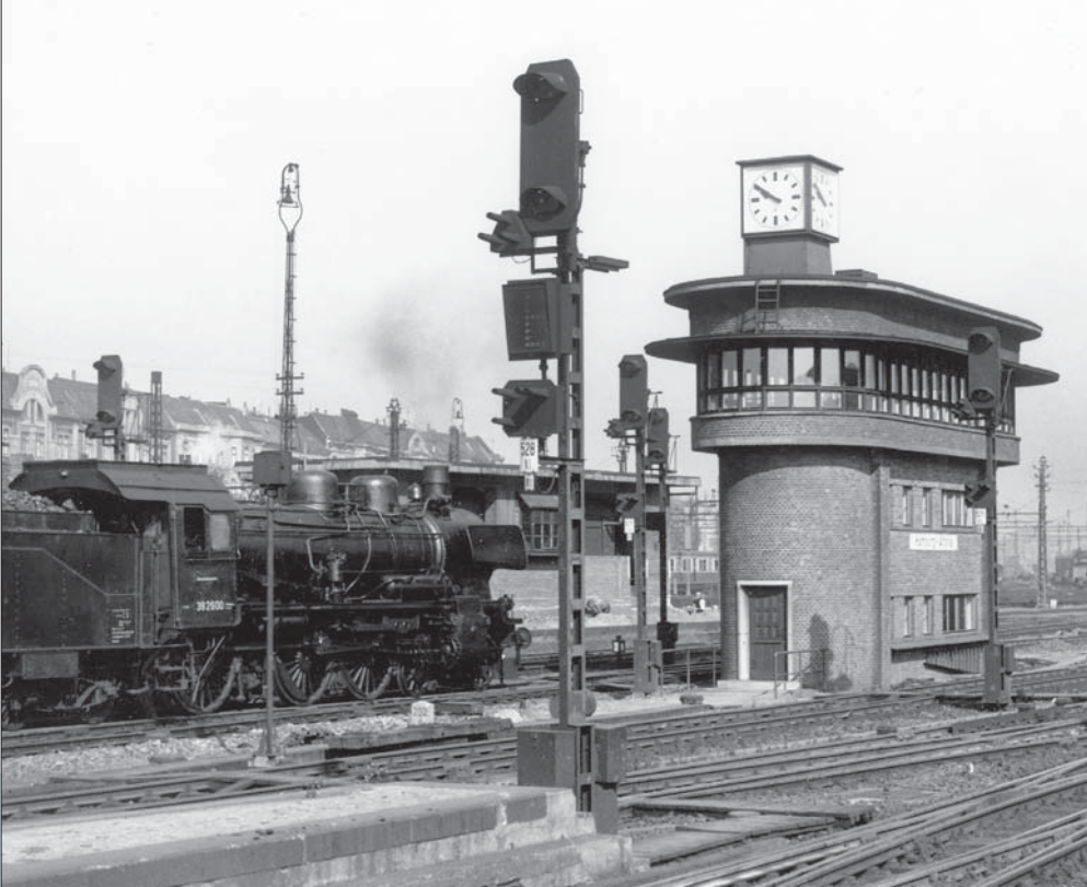
Bf Hamburg-Altona am 2. September 1953 mit dem damals neuen Dr-I-Stellwerk „Af“ sowie den Ausfahrtsignalen für die Gleise 4 bis 8. Das Bild ist in mehrfacher Hinsicht interessant. Zum einen besaßen die Lichtsignale, die damals wegen der kürzeren Gleislängen viel weiter vorn standen als heute, noch keine Mastschilder. Zum anderen waren die Signalmaste viel dunkler (vmtl. in RAL 7011) gestrichen als heute. Links die 38 2600 vom Bw Kiel, die mit ihrem Zug auf die Ausfahrt wartet. Foto Hollnagel, Sammlung SC
