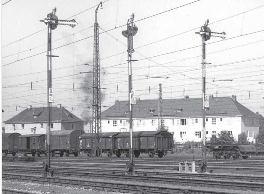
Freilassing war einer der letzten Bahnhöfe, die noch mit bayerischen Ruhsignalen ausgerüstet waren. Das Foto vom 12. September 1960 zeigt drei der Ausfahrtsignale, von denen das mittlere in der Stellung Hp Ru ist. Foto Joachim Claus
