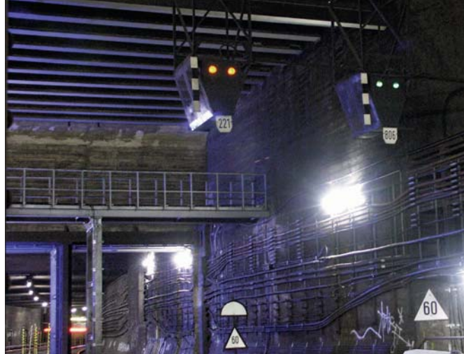
Hängende Blendenrelaissignale als Blocksignale im Nordsüd-S-Bahn-Tunnel: links das Blocksignal 221, rechts 806. Foto Mike Straschewski
