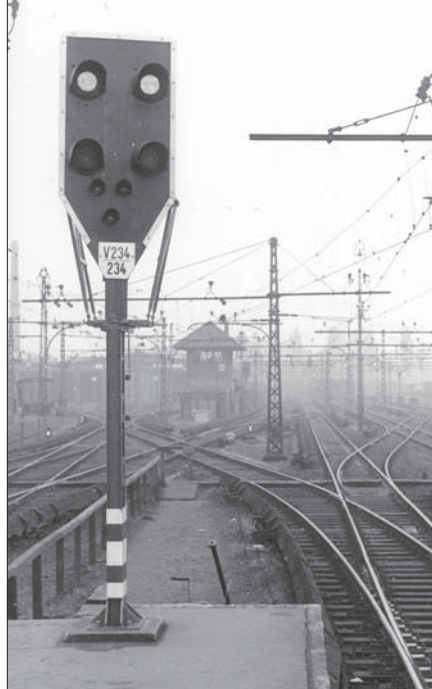
Das Ausfahrtsignal 234 des Bf Ohlsdorf in Richtung Hamburg mit außermittig angeordnetem Vorrücksignal (für die Rangierfahrt in das im Hintergrund sichtbare Bw Ohlsdorf) im November 1951.
