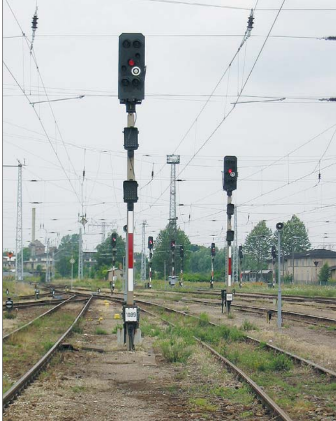
Links: HI-Signale mit zwei Zusatzanzeigern an hohen Betonmasten im Juli 2004 im Bahnhof Waren (Müritz).
