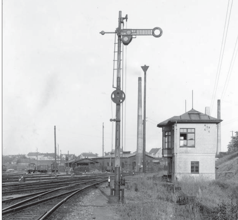
Das Stellwerk 5 in Riesa. Beachtung verdient nicht nur das sächsische Signal, bei dem sich die Hubscheibe am Mast befindet, sondern insbesondere das hinter dem Hauptsignal stehende Vorrücksignal.
