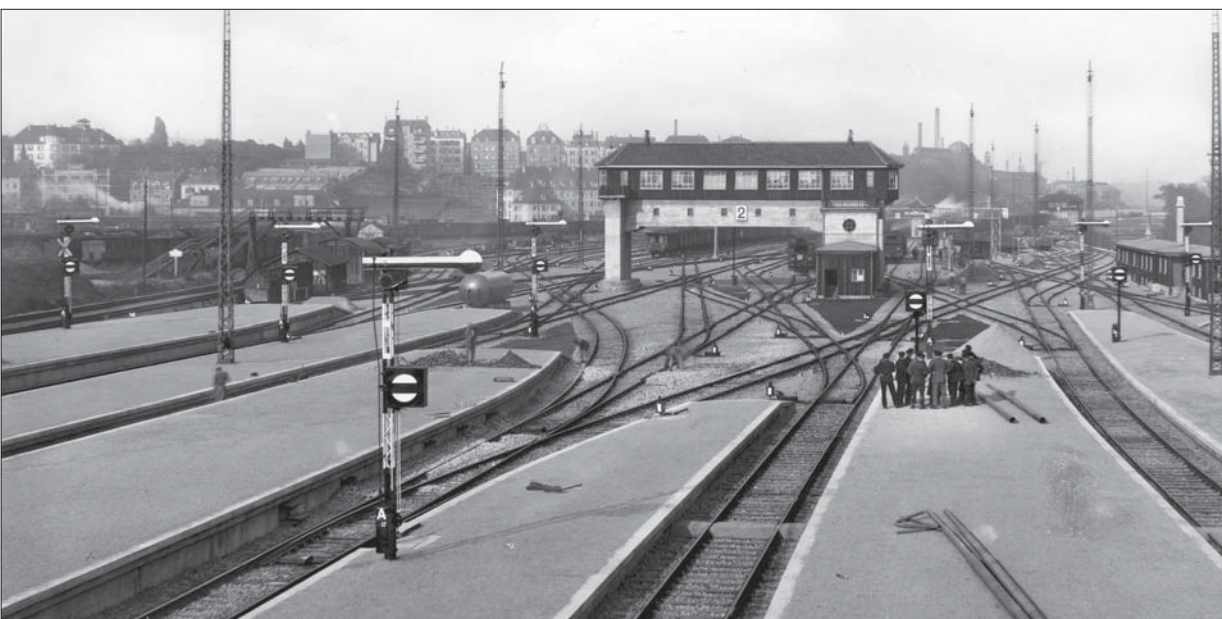
Blick über den Stutt-garter Hbf kurz vor der Fertigstellung. Die württembergi-schen Ausfahrtsignale (das ganz linke ist noch mit einem Kreuz als ungültig gekennzeichnet) be-sitzen bereits ge-schlossene Flügel. Dort wo Sperrsignal und Ausfahrtsignal am gleichen Stan-dort sind, ist das Sperrsignal am Hauptsignalmast montiert. Werkfoto MF Esslingen, Samml-ung Hermann Hoyer
