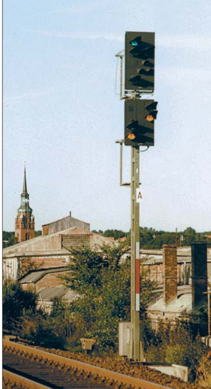
Links: Einfahr- und Ausfahrversignal des Bahnhofs Itzehoe im August 1991. Die auf dem Bild erkennbare Ausführung der SEL-Signalschirme mit abgedeckten Lampenöffnungen und Deckleisten auf dem Vorsignalschirm unterscheidet sie von der Siemens-Form.
