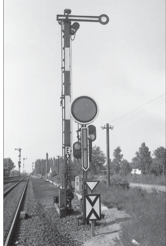
Zwischensignal und das in verkürztem Bremswegabstand stehende Ausfahrtsignal in Richtung Lübeck im Bahnhof Lübeck-Blankensee im Juni 1979
