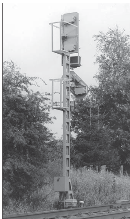
Rückansicht des Einfahrsignals des Bahnhofs Tornesch im September 1991 (mit einem von der Regelform abweichenden Schaltkasten)
