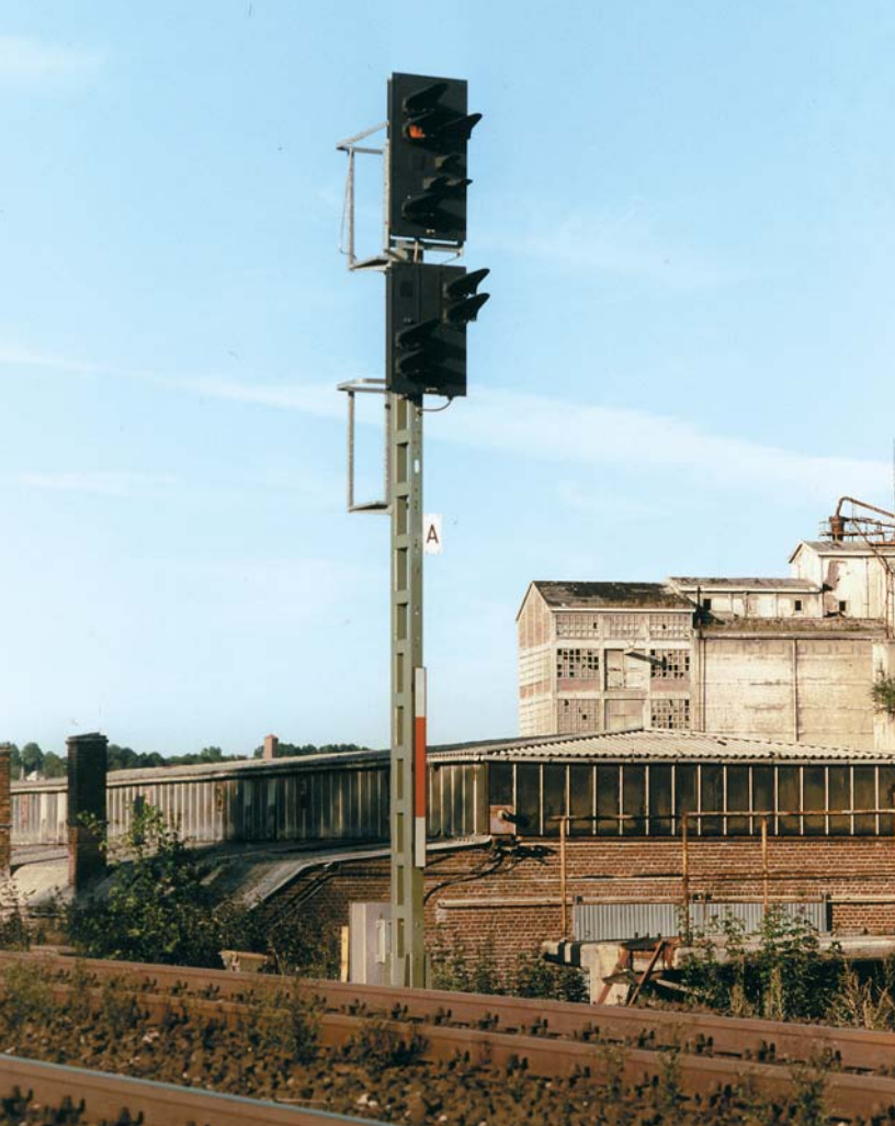
Einfahrtsignal und Ausfahrvorsignal des Bahnhofs Itzehoe. Das Bild entstand im August 1991, kurz nach Inbetriebnahme des mit Kompaktsignalen ausgerüsteten elektronischen Stellwerks „Izf“. Im Hintergrund die Ruinen des stillgelegten Zementwerks Alsen.
