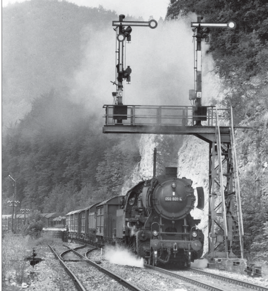
050 601-4 passiert mit dem Ng 17403 Tuttlingen–Mengen am 12. Juli 1973 die Ausfahrtsignale des Bahnhofs Thiergarten, die aus Platzgründen auf einem Signalausleger stehen. Im Hintergrund das Einfahrsignal, das 100 m vor der ersten Weiche – als maßgeblichem Gefahrenpunkt – steht. Foto Herbert Stemmler
