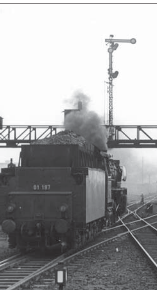
Noch in den 50er Jahren überspannten Signalbrücken viele große Bahnhöfe. Im Bahnhof Hamburg Hbf steht auch heute noch für die Einfahrt aus Richtung Süden eine Signalbrücke, allerdings mit Lichtsignalen. Das Foto zeigt die alte Signalbrücke mit Formsignalen im Juni 1954. Die Einfahrtsignale für das Pz-Gleis (links) und Gz-Gleis (rechts) sind mit Fahrwegsignalen für 30 km/h, und zusätzlich Geschwindigkeitsanzeigern und Kurzhaltanzeigern als Lichtsignalen ausgerüstet. Foto Hollnagel, Sammlung SC
