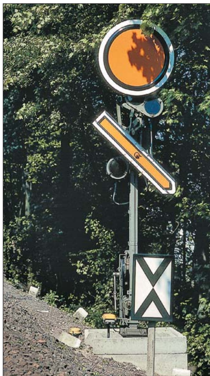
Vr 2 am Einfahrtsignal des Bahnhofs Blanke im Mai 1985. Das Signal ist zweibegriffig mit einer nichtbeweglichen Signalscheibe und fester unterer Laternenblende.
