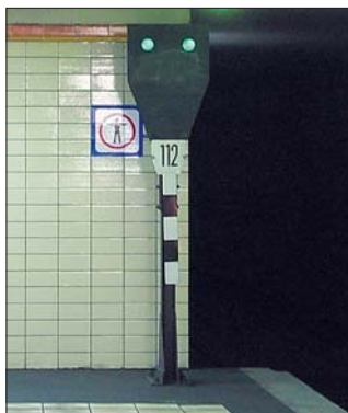
Blendenrelaissignale im Nordsüd-S-Bahn-Tunnel. Links das Blocksignal 112 am Hp Oranienburger Straße im April 2004, rechts das Signal 422 im Bf Potsdamer Platz im Juli 2004. Fotos Alexander Lindner
