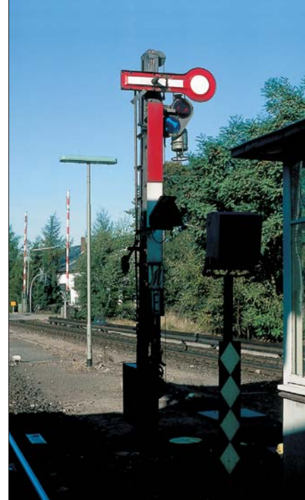
Kürzer gehts nicht: Das Ausfahrtsignal der S-Bahn-Station Sülldorf wurde auf ein Mindestmaß gekürzt, damit es hinter dem unmittelbar davorstehenden Bahnsteigdach zu erkennen ist. Auf dem Foto vom Juli 1983 sind deutlich die Roststellen an der Schweißnaht zu erkennen.
