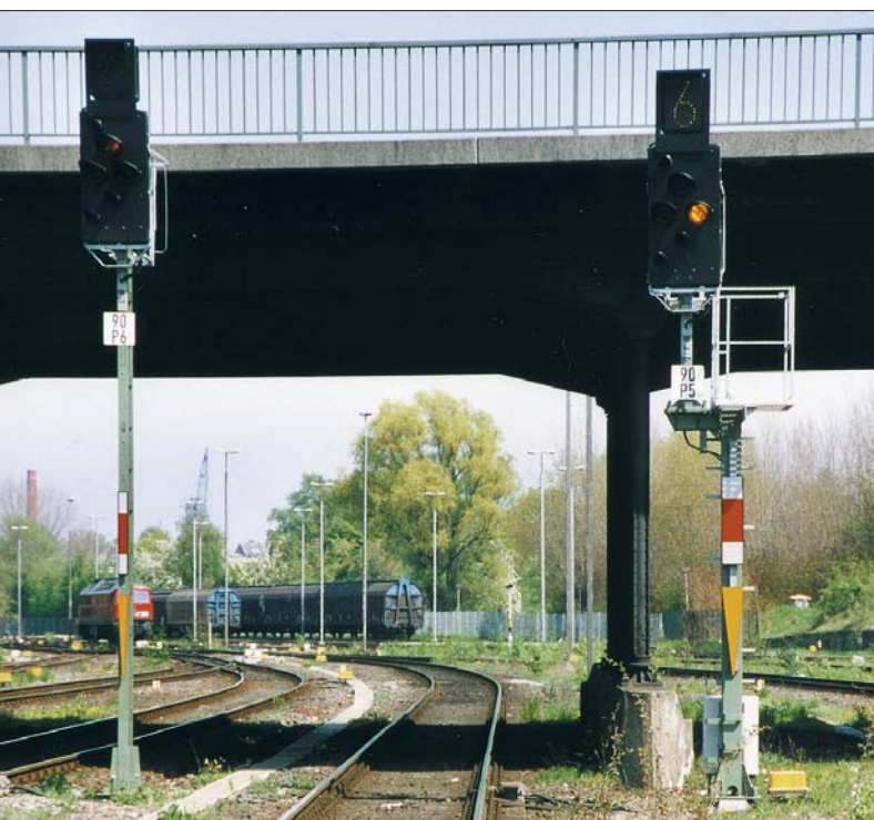
Links: Zwei Mehrabschnittssignale in Lübeck Hbf im April 2004. Das linke Signal hat einen einfachen Mast. Das rechte, Ks 2 (mit 60 km/h) anzeigende Signal hat einen 3,48 m langen Auslegermast.
