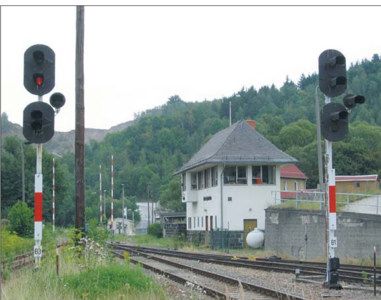
Links: EZMG-Ausfahrtsignale des Bahnhofs Loitsch-Hohenleuben im August 2004. Das linke Signal kann Hp 0, Hl 3 sowie Hp 0 zusammen mit dem Rangierfahrtsignal anzeigen, das rechte Hp 0, Hl 1 und Rangierfahrtsignal.
