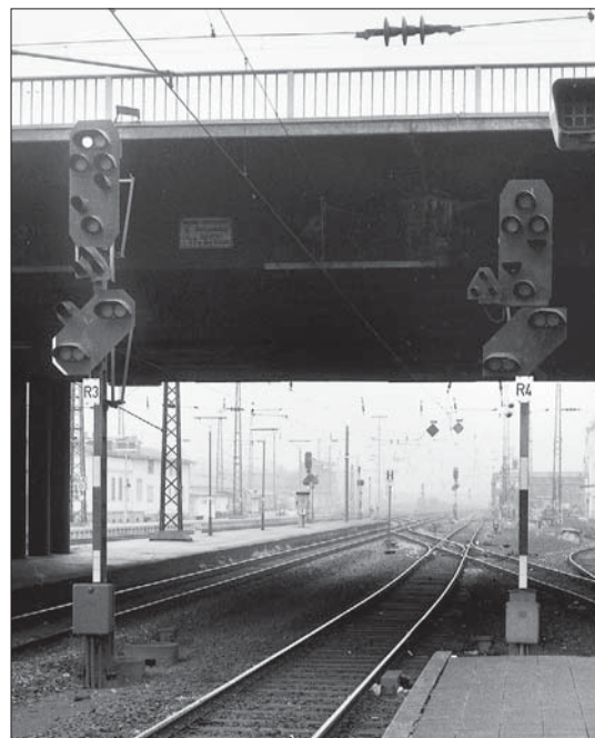
Signale der Bauform 51 im Bahnhof Weinheim/Bergstraße. Das linke Signal besitzt für das Kennlicht oben eine Doppeloptik. Beim rechten Signal ist der Vorsignalschirm verkleinert, damit der Hauptsignalschirm tiefer gesetzt werden kann und trotzdem eine ausreichende Signalsicht gewährleistet ist. Foto Günter Berg
