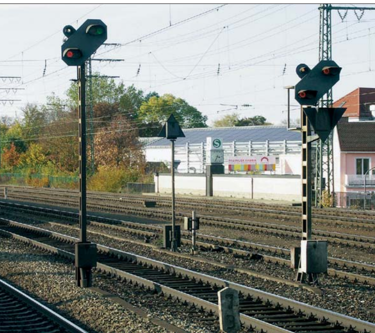
Links: Zwei Vorsignalwiederholer im Bf München-Pasing im Oktober 2004. Das linke Signal entspricht der Bauform 1951 und hat zum Freihalten des erweiterten Regellichtraums einen langen Signalmast. Rechts ein Signal der Einheitsbauform mit einem Geschwindigkeitsvoranzeiger. Zwischen den beiden Signalen ein allein stehender Geschwindigkeitsanzeiger für die Gegenrichtung. Foto Alexander Lindner
