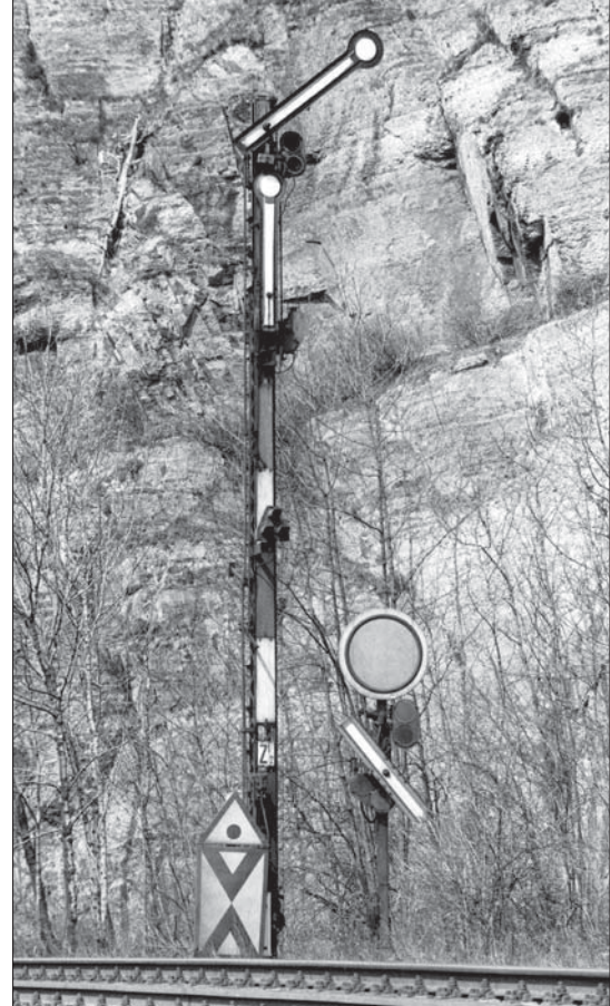
Einfahrtsignal und Ausfahrtsignal des Bahnhofs Saalfeld im April 1977. Für das Signaltypbild Vf 2 wird zusammen mit dem Flügel bei der DR die untere Laternenblende bewegt.
