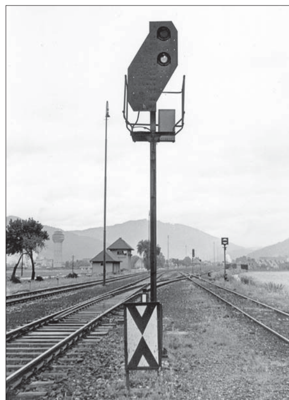
Rechts: Lichtvorsignal der DRG-Bauform 1943 im ÖBB-Bahnhof Niklasdorf. Ähnlich wie bei der DR, sah die Signalordnung der ÖBB für Vorsignale Signalbilder mit nur einem gelben oder grünen Licht für die Begriffe „Halt erwarten“ bzw. „Fahrt erwarten“ vor. Foto Pfeiffer, Slg. Heless
