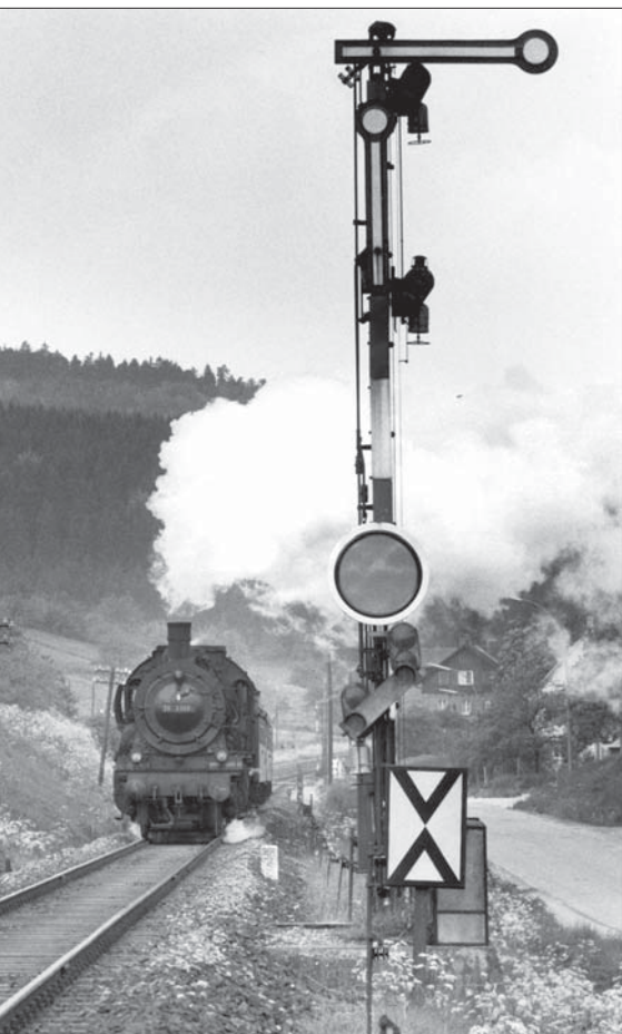
Einfahrtsignal und Ausfahrsvorsignal des Bahnhofs Laufen, den 38 3369 vom Bw Tübingen am 23. Mai 1968 mit einem Personenzug nach Sigmaringen verlässt. Das Vorsignal ist mit einem Lichtlenkkasten ausgerüstet. Foto Ludwig Rotthowe
