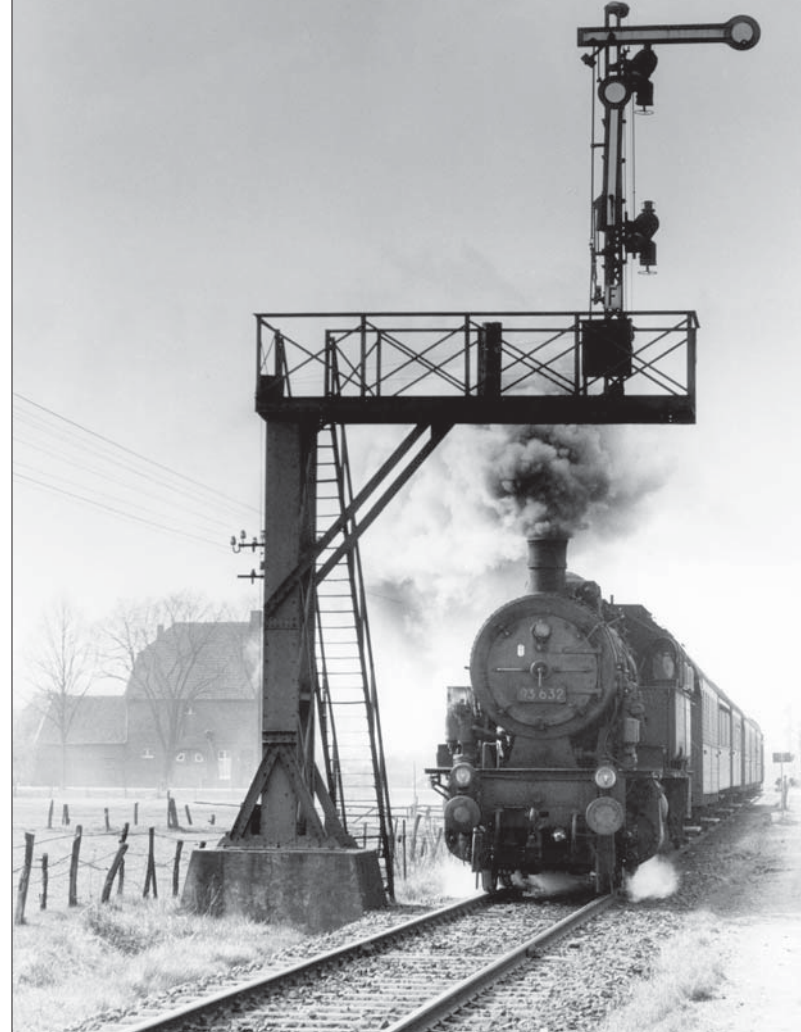
Da in Telgte dicht neben der Bahnstrecke eine Straße verläuft, konnte das Einfahrsignal hier nicht rechts aufgestellt werden. Um die Linksstellung zu vermeiden, baute die Preußische Staatsbahn einen Signalausleger. Das Foto vom April 1957 zeigt einen von 93 632 gezogenen, nach Warendorf fahrenden Personenzug. Foto Ludwig Rotthowe
