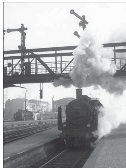
1951 überspannte auch den Bahnhof Hamburg-Altona eine Signalbrücke, die Rauchabweiser unter den Signalen hatte. Das Foto zeigt sie mit 38 2207 vom Bw Neumünster, die mit ihrem Zug gerade den Bahnhof verlässt. Im Hintergrund wartet eine weitere 38 10 auf die Abfahrt. Foto Hollnagel, Sammlung SC
