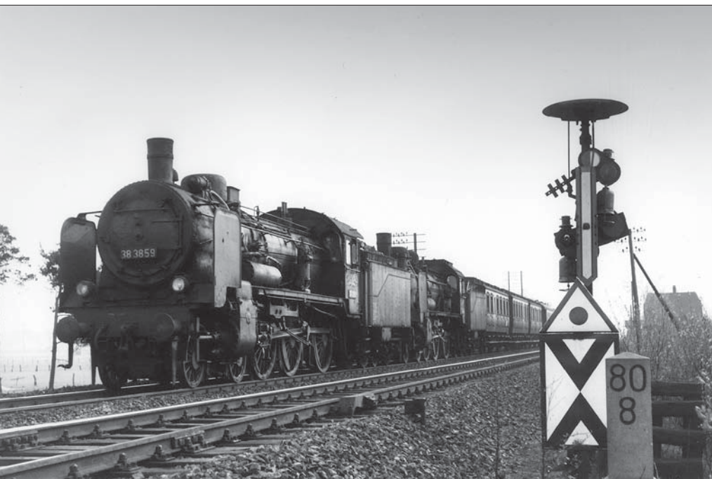
38 3859 und 38 2375 mit einem Personenzug Münster–Osnabrück im Mai 1956 in der Nähe von Westbevern. Rechts ein Vorsignal mit Zusatzflügel und Spiegelkasten, das für einen Gegenzug „Fahrt erwarten“ (damals noch Vz 3) anzeigt. Foto Ludwig Rotthowe
