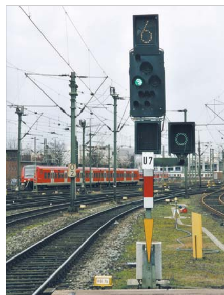
Ks-Mehrabschnittssignal als Ausfahrtsignal in Hannover Hbf im Februar 2004. Das Signal ist mit Geschwindigkeits- und Voranzeiger sowie einem Abfahrauftragsignal ausgerüstet.
