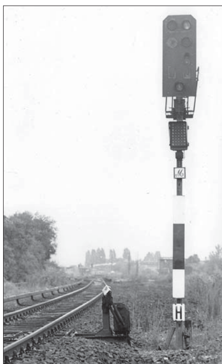
Der als HI-Signal bestückte Signalschirm dieses im August 1976 fotografierten Signals der Berliner S-Bahn ist vermutlich aus einem ehemaligen Hauptsperrsignal entstanden: Dort wo sich die oberen Einzeloptiken befinden, ist zuvor ein Blech eingeschweißt worden, darunter ist die linke Rotlichtöffnung verschlossen und die ehemaligen Öffnungen für weitere Nebenoptiken sind ebenfalls noch zu erkennen. Foto DR, Sammlung SC
