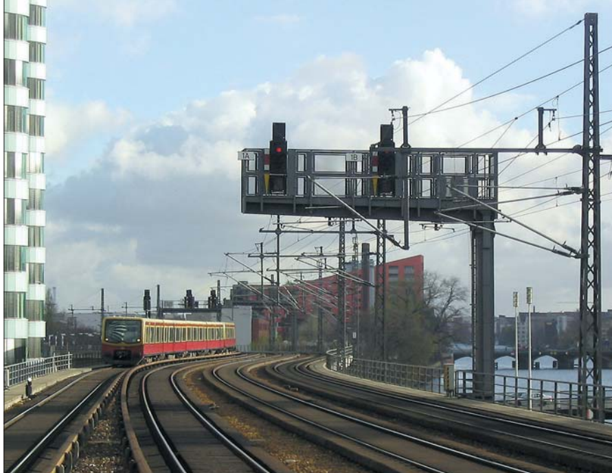
Auf der Berliner Stadtbahn erfordern viele Signale seit jeher Signalbrücken. Dies hat sich auch bei der Ausrüstung mit Ks-Signalen nicht geändert. Oben ein Signalausleger für die Fernbahngleise in der Nähe des S-Bahn-Haltes Janowitzbrücke, im Hintergrund weitere Ausleger und Signalbrücken, rechts ein Signalausleger für die S-Bahn im Bf Zoo, beide Aufnahmen November 2004.
