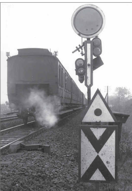
Links: Vorsignal mit Spiegelkasten in der Stellung Vz 1 „Halt erwarten“ im Oktober 1952. Foto Hollnagen, Sammlung SC
