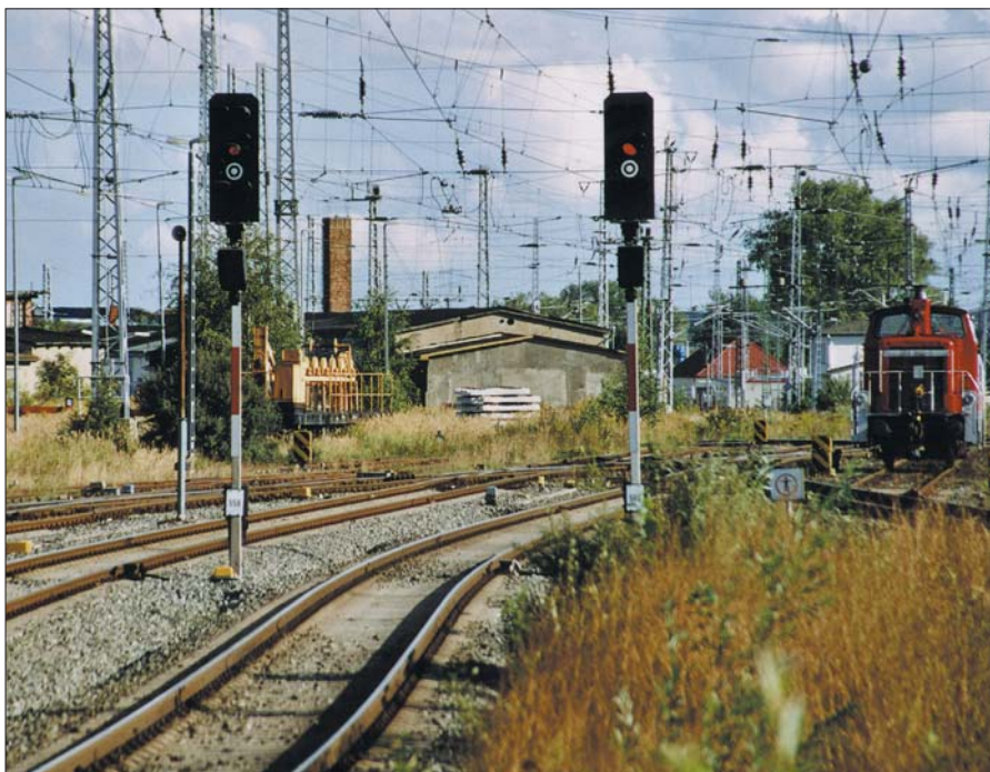
Zwei HI-Signale der Einheitsbauform mit Zusatzanzeiger an 5,70 m langem Schleuderbetonmast im September 2005 im Bahnhof Rostock Hbf
