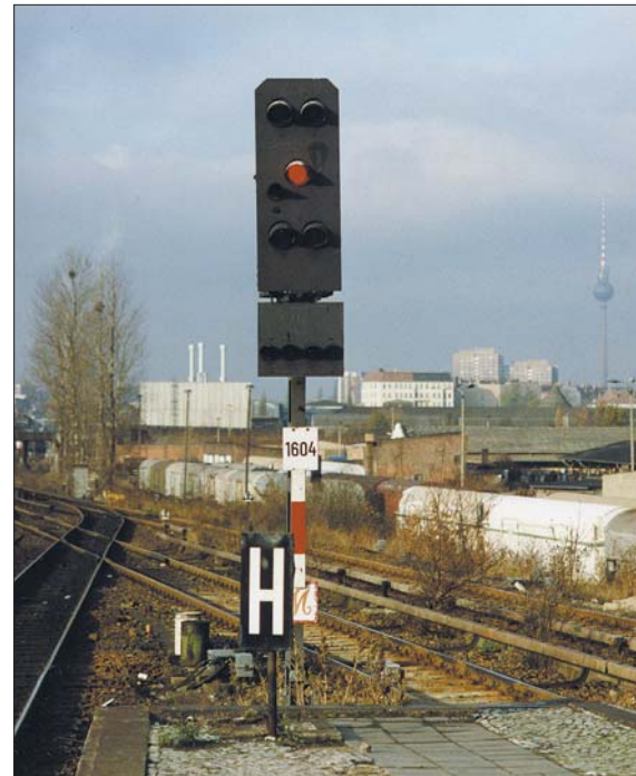
Rechts: HI-Signal der Einheitsbauform mit Zusatzschirm für den Lichtstreifen am Berliner S-Bahnhof Ostkreuz im November 1991. Das Signal besitzt einen niedrigen Stahlmast, die vor dem Signal stehende H-Tafel hat noch die Abmessungen der alten preußischen Tafeln.
