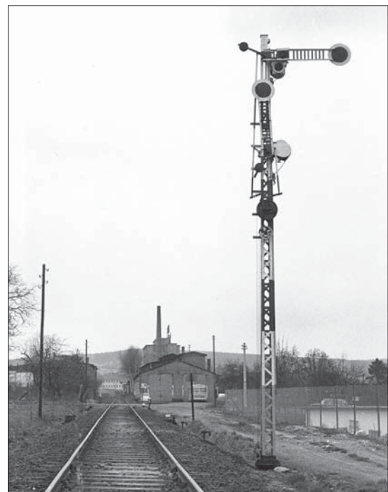
Das vermutlich von Gast stammende Einfahr-signal des Bahnhofs Butzbach der BLE im März 1967 fotografiert. Trotz des hellen Hintergrundes besitzt es noch Negativflügel. Foto Herbert Stemmler
