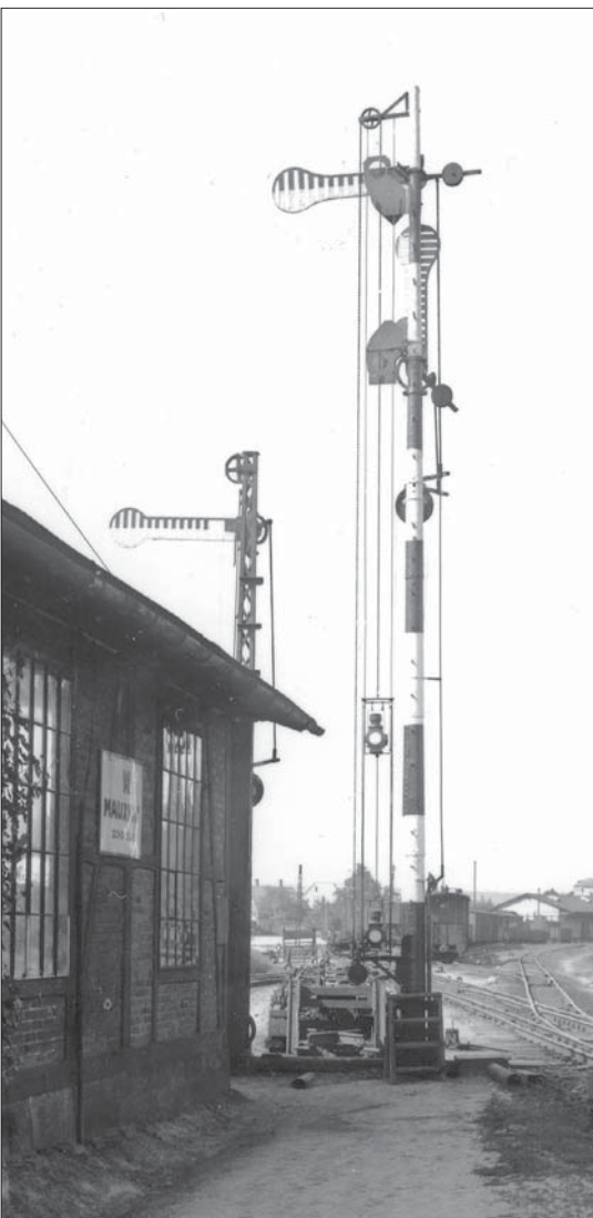
Das Stellwerk 5 in Riesa. Beachtung verdient nicht nur das sächsische Signal, bei dem sich die Hubscheibe am Mast befindet, sondern insbesondere das hinter dem Hauptsignal stehende Vorrücksignal.
