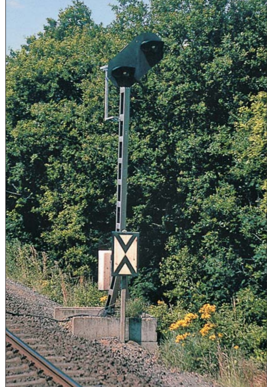
Links: Zwei Vorsignalwiederholer im Bf München-Pasing im Oktober 2004. Das linke Signal entspricht der Bauform 1951 und hat zum Freihalten des erweiterten Regellichtraums einen langen Signalmast. Rechts ein Signal der Einheitsbauform mit einem Geschwindigkeitsvoranzeiger. Zwischen den beiden Signalen ein allein stehender Geschwindigkeitsanzeiger für die Gegenrichtung. Foto Alexander Lindner
