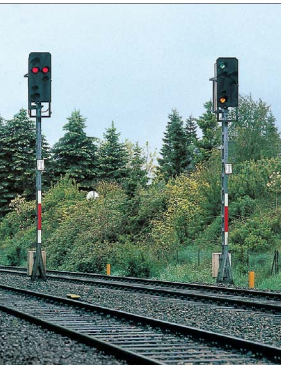
Hp 00 und Hp 2 an den Ausfahrtsignalen des Bahnhofs Bönningstedt der AKN im Juli 1991. Die Signale besitzen – für Lichtsignale ungewöhnlich – keine Ersatzsignale, da bei der AKN bei Störungen der Auftrag zur Vorbeifahrt über Funk erteilt wird.
