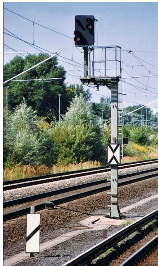
Rechts: Kompakt-Vorsignal als Auslegersignal an der Ausbaustrecke Hamburg–Berlin zwischen Hamburg-Bergedorf und Billwerder-Moorfleet im August 2005. Die Vorsignalbake im Vordergrund kündigt ein Vorsignal am S-Bahn-Gleis (rechts) an und konnte wegen des Bahnsteigs nicht rechts vom Gleis aufgestellt werden.
