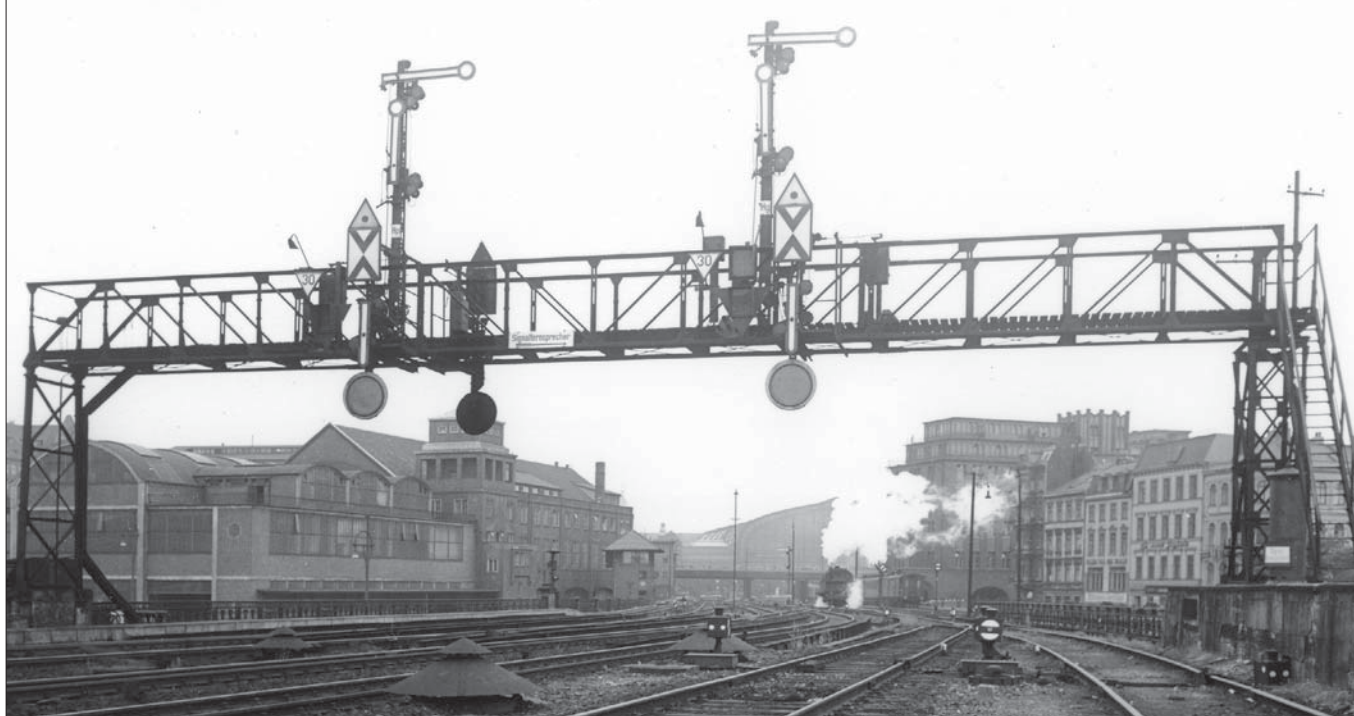
Noch in den 50er Jahren überspannten Signalbrücken viele große Bahnhöfe. Im Bahnhof Hamburg Hbf steht auch heute noch für die Einfahrt aus Richtung Süden eine Signalbrücke, allerdings mit Lichtsignalen. Das Foto zeigt die alte Signalbrücke mit Formsignalen im Juni 1954. Die Einfahrtsignale für das Pz-Gleis (links) und Gz-Gleis (rechts) sind mit Fahrwegsignalen für 30 km/h, und zusätzlich Geschwindigkeitsanzeigern und Kurzhaltanzeigern als Lichtsignalen ausgerüstet. Foto Hollnagel, Sammlung SC
