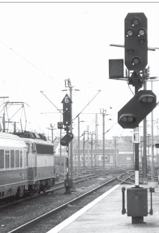
Ausfahrtsignale der Bauform 1951 in Hannover Hbf. Links leuchtet Hp 2 mit Geschwindigkeitsanzeiger für 60 km/h, Vr 1 sowie das Abfahrtauftragssignal, rechts Hp 00. Foto Scholtis
