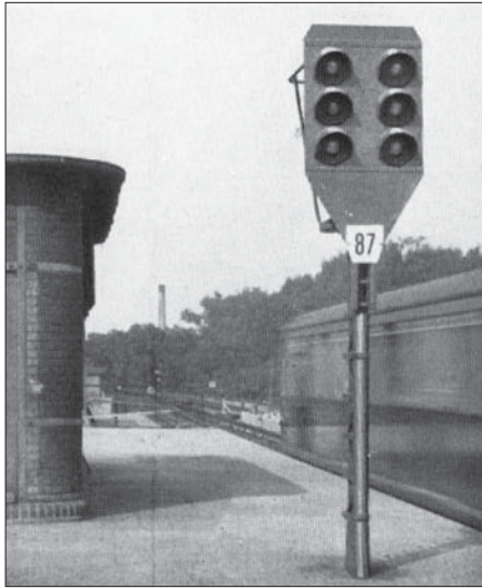
Ursprüngliches Ausfahrtsignal des Bf Berlin-Zoo, noch ohne Mastschild, um 1930 fotografiert. Sammlung Steffen Buhr
