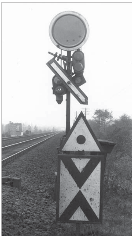
Dreibegriffes Vorsignal mit Spiegelkasten in der Stellung Vz 3 „Langsamfahrt erwarten“ im Oktober 1952.
