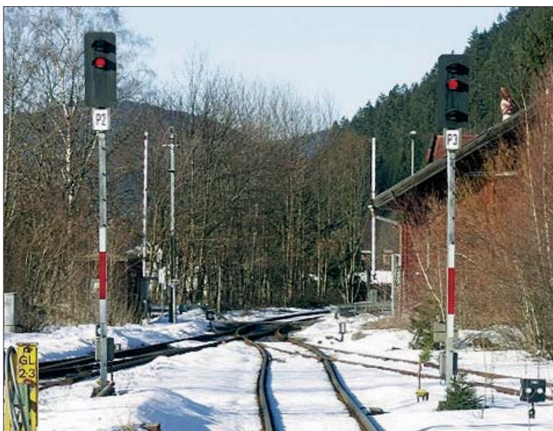
Nebenbahnsignale im Bahnhof Bayerischzell im Januar 2005. Das linke Signal am durchgehenden Hauptgleis kann die Signalbilder Hp 0 und Hp 1 anzeigen, das rechte Hp 0 und Hp 2. Foto Alexander Lindner
