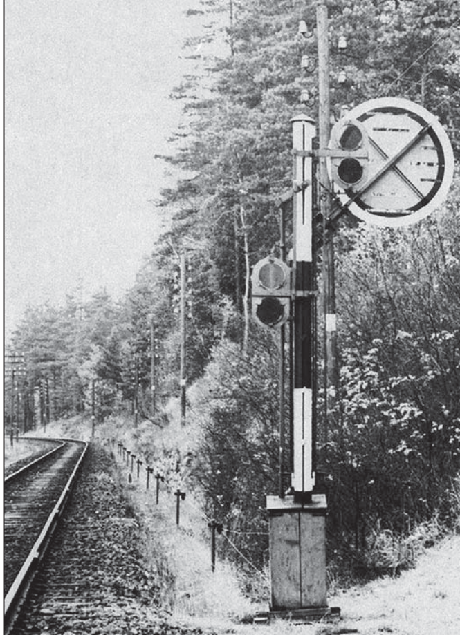
Links: Ein bayerisches Vorsignal mit durchbrochener Signalscheibe im Sommer 1926 vor dem Bahnhof Neuenreuth (Strecke Nürnberg–Bayreuth)
