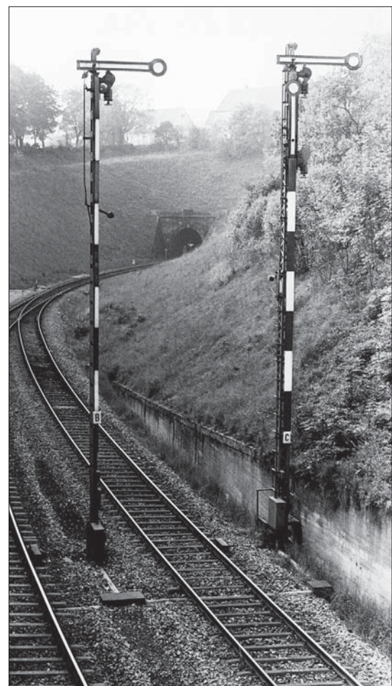
Ausfahrtsignale des Bf Döggingen im September 1976. Die 12 m hohen Signale sind erforderlich, um trotz Einschnitts eine ausreichende Signalsicht sicherzustellen. Foto H. Stemmler
