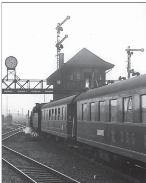
Noch in den 50er Jahren überspannten Signalbrücken viele große Bahnhöfe. Im Bahnhof Hamburg Hbf steht auch heute noch für die Einfahrt aus Richtung Süden eine Signalbrücke, allerdings mit Lichtsignalen. Das Foto zeigt die alte Signalbrücke mit Formsignalen im Juni 1954. Die Einfahrtsignale für das Pz-Gleis (links) und Gz-Gleis (rechts) sind mit Fahrwegsignalen für 30 km/h, und zusätzlich Geschwindigkeitsanzeigern und Kurzhaltanzeigern als Lichtsignalen ausgerüstet. Foto Hollnagel, Sammlung SC
