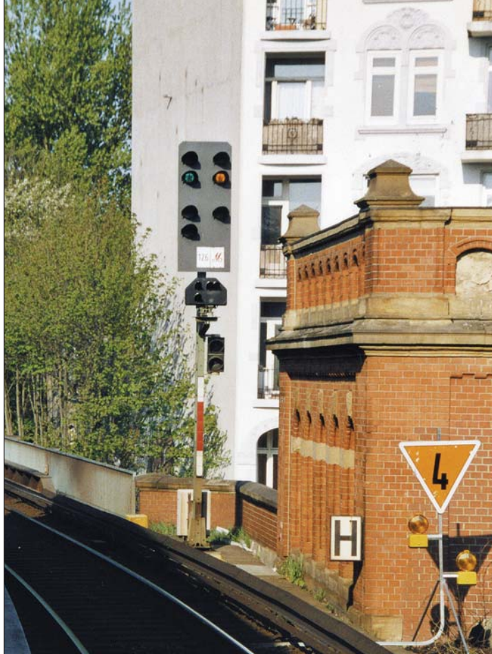
Ausfahrsignal des Bahnhofs Sternschanze in Richtung Altona im Mai 2004. Hinter dem Bahnsteig befindet sich ein Kehrgleis, sodass das Sv-Signal für Rangierfahrten mit einem Sperrsignal ausgerüstet ist. Wegen Brückenbauarbeiten war zum Zeitpunkt der Aufnahme die Höchstgeschwindigkeit im anschließenden Streckenabschnitt auf 40 km/h begrenzt.
