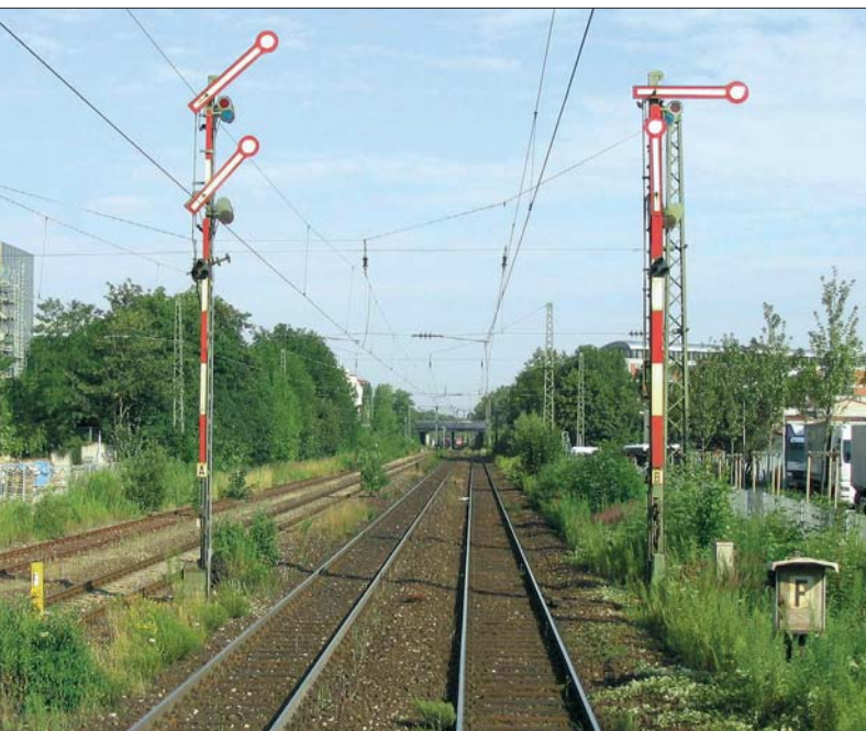
Einfahrtsignale des Bahnhof München-Laim Rbf im Juli 2004. Das Signal A (links) zeigt für einen Zug aus Richtung München-Mittersending Hp 2, das Signal B (aus Richtung Südring) Hp 0. Foto Frank Zimmermann
