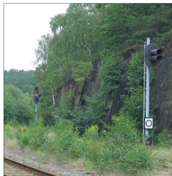
Links: EZMG-Ausfahrtsignale des Bahnhofs Loitsch-Hohenleuben im August 2004. Das linke Signal kann Hp 0, Hl 3 sowie Hp 0 zusammen mit dem Rangierfahrtsignal anzeigen, das rechte Hp 0, Hl 1 und Rangierfahrtsignal.
