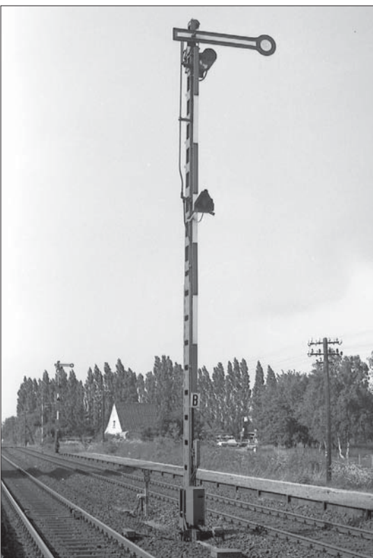
Links: Ein einflügeliges Hauptsignal sowie im Hintergrund ein zweiflügeliges Signal Juni 1979 in Lübeck-Blankensee in der Stellung Hp 0.
