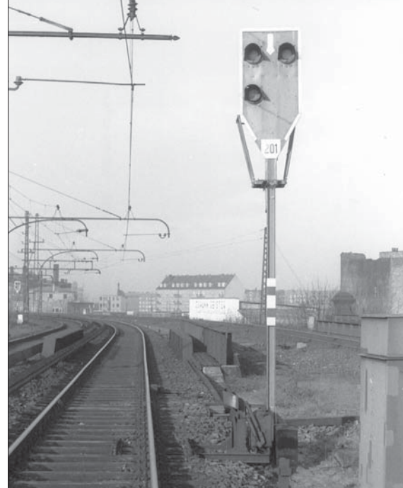
Das in verkürztem Bremswegabstand stehende Signal 201 in Hamburg Barmbek in Haltstellung im Dezember 1951. Bis Mai 1955 fuhren auf dem S-Bahn-Netz noch Gleich- und Wechselstromzüge. Fotos Hollnagel, Slg. SC
