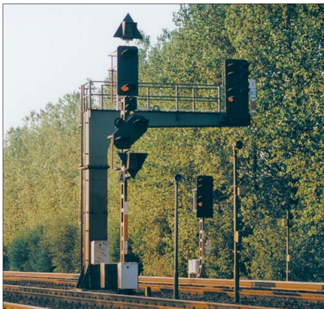
Einfahrsignale des Bahnhofs Pinneberg im September 1991. Im Vordergrund das Fernbahnsignal mit Geschwindigkeits- und Geschwindigkeitsvoranzeiger (für Durchfahrten durch das Überholungsgleis mit 60 km/h), dahinter die beiden Einfahrsignale der Gleichstrom-S-Bahn.
