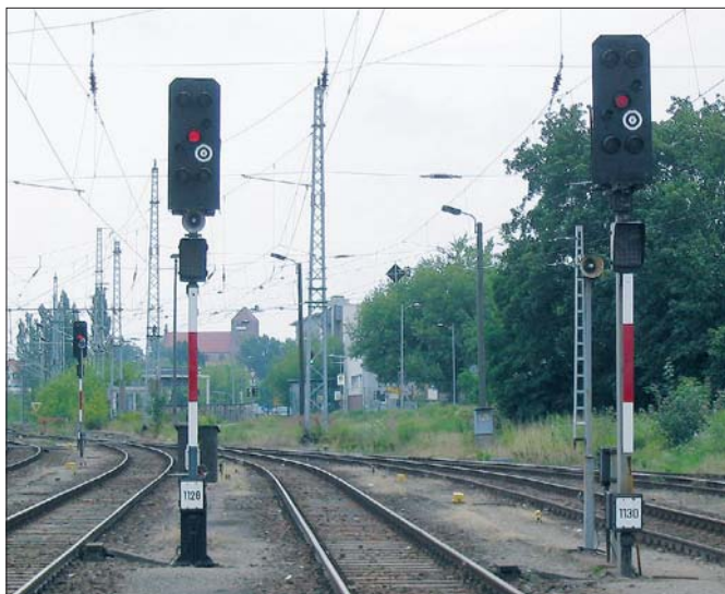
Links: Hp 0 – ehemals HI 13 – „Halt“ an den Ausfahrtsignalen des Bahnhof Waren im Juli 2004
