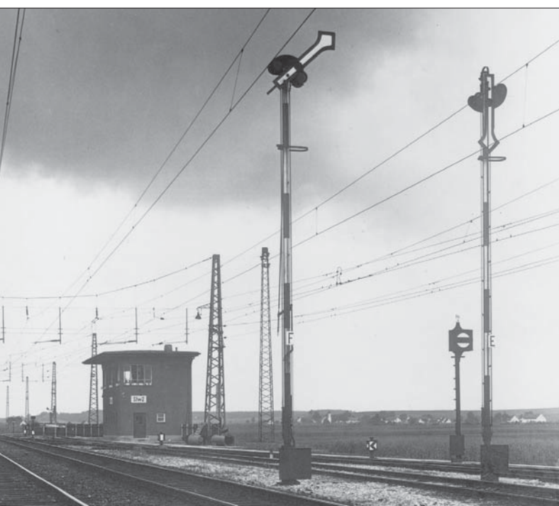
Bayerische Ausfahrtsignale mit Emailleflügeln in der Signalstellung Hp 1 und Ru 201, vmtl. im Bahnhof Maisach fotografiert. Interessant an dieser Aufnahme ist, dass am rechten Gleis bereits ein Hauptsperrsignal aufgestellt ist. Werkfoto Krauss Maffei, Sammlung Helge Hufschläger
