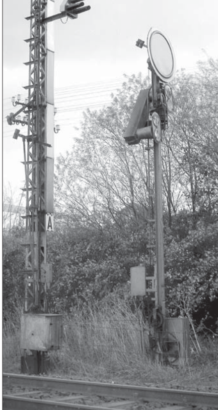
Ausfahrsvorsignal des Bahnhofs Bad Segeberg im Herbst 1979. Das hohe Signal hat einen Lichtlenkkasten, der für die Verwendung an Signalen mit Zusatzflügel konzipiert war.
