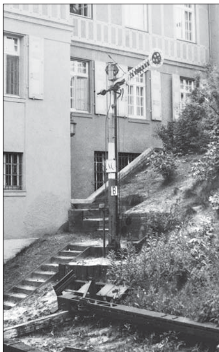
Das auf einem Podest neben dem Gleis stehende Blocksinal der S-Bahn-Haltestelle Pichelsdorf hatte die typischen Merkmale der von Siemens & Halske gebauten Signale. Foto Kroll, Sammlung Hermann Hoyer
