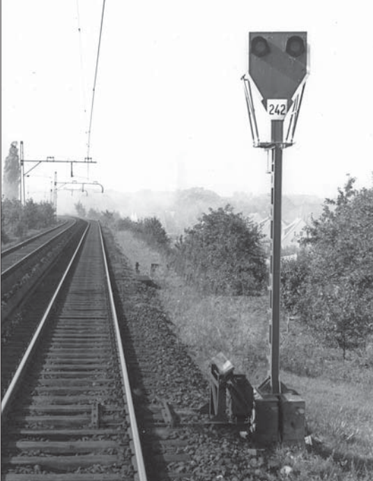
Blendenrelaissignale der ersten Generation im Netz der Hamburger S-Bahn. Oben das zwischen Kornweg und Ohlsdorf stehende Selbstblocksignal 242 im Jahr 1952 in Fahrtstellung mit abliegender Fahrsperr.
