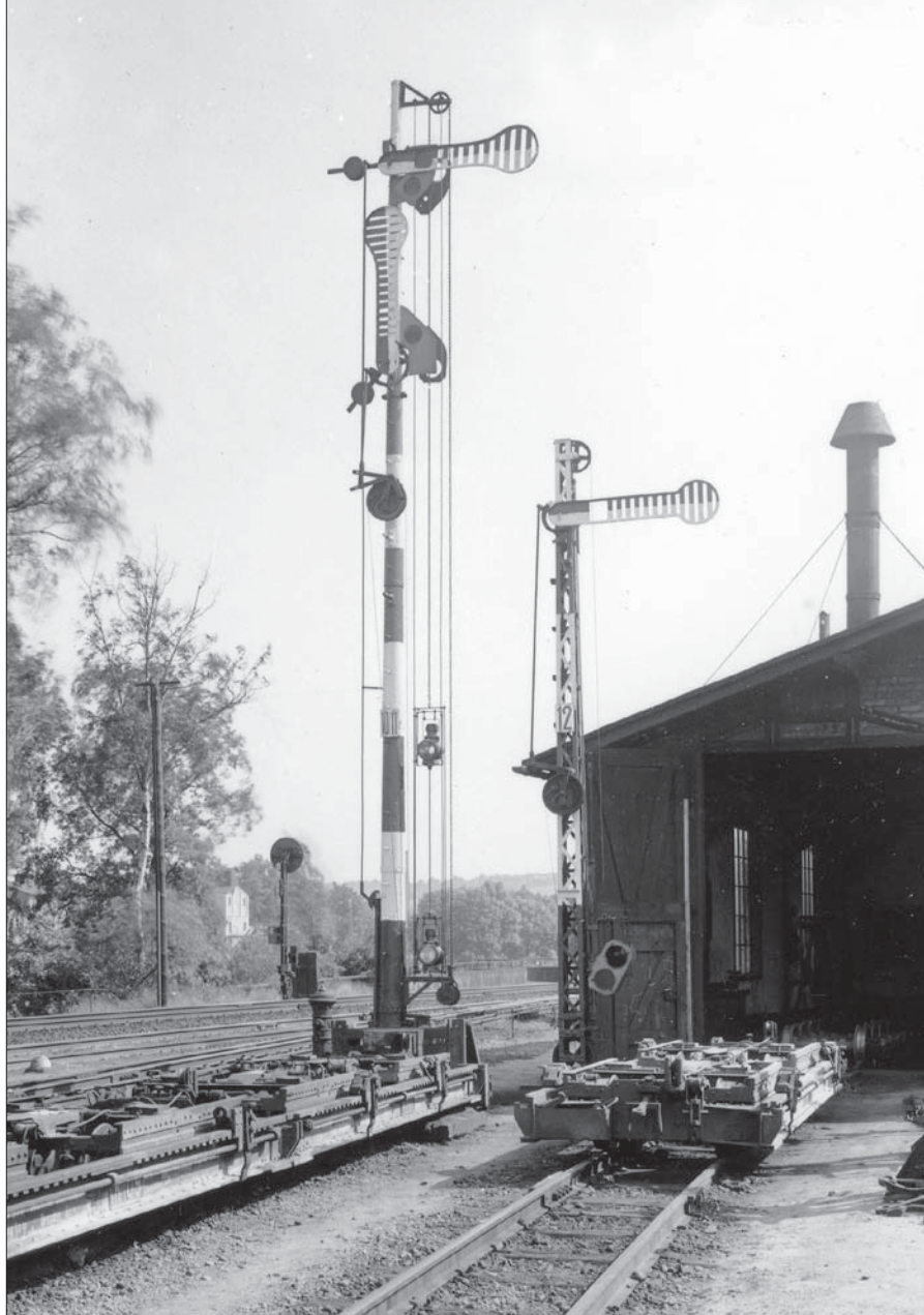
Sächsische Ausfahrtsignale im Bahnhof Groß Bauchlitz Anfang der 30er Jahre. Interessant sind die unterschiedlichen Signalbauformen: Bei dem linken Signal, das einen runden Mast besitzt, sind die Laternenblenden fest mit den Flügeln verbunden, tagsüber werden nur die Laternen herabgelassen. Bei dem rechten, kleineren Signal sind die Laternenblenden vom Flügel getrennt und werden zusammen mit der Signallaterne aufgezogen. Beiden Signalen gemeinsam ist die Anordnung der Hubscheibe auf halber Höhe am Signalmast.
