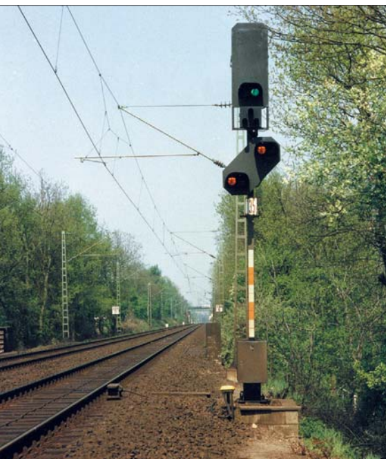
Selbstblocksignal zwischen Hittfeld und Hamburg-Harburg im Mai 1994. Die obere Laterneöffnung ist mit einem Blech verschlossen.
