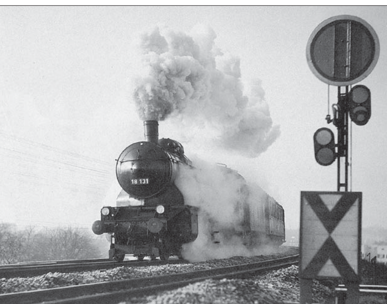
18 131 passiert auf der Fellbacher Rampe das Einfahrtvorsignal des Bahnhofs Cannstadt. Das Signal entspricht – bis auf die Hakenhebelsteuerung – der Ursprungsanführung der Einheitsvorsignale mit zusammen-genietetem Signalmast und flacher, mit Winkelprofilen verstärkter Signalscheibe. Foto Alfred Ulmer, Sammlung Dietrich Braitmaier
