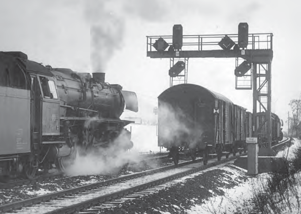
Zwar ist dieses Foto gestellt, dennoch verdeutlicht es die Funktion der Beschleunigungs- und Verzögerungsanzeiger. Das Bild aus dem Jahr 1956 zeigt einen von 01 1077 geführten Schnellzug, der auf der Cornberger Rampe einen auf dem rechten Gleis fahrenden Güterzug überholt. Foto Först, Sammlung SC
