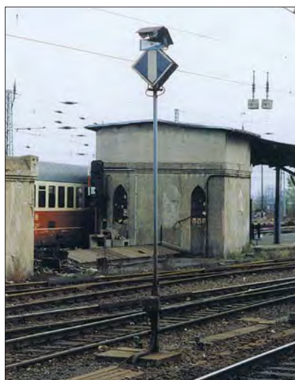
Mit Anstrahlleuchten beleuchtetes „Bügel-an“ (von der Rückseite „Bügel-ab“-) Signal mit Zuordnungstafel im November 1991 im Bahnhof Berlin Hbf
