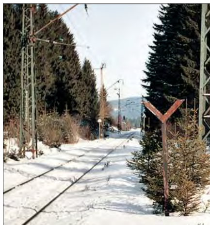
Vermutlich bereits um 1920 aufgestellte Schneepflugtafel an der Höllentalbahn im Januar 2006. Foto Michael Schnippering
