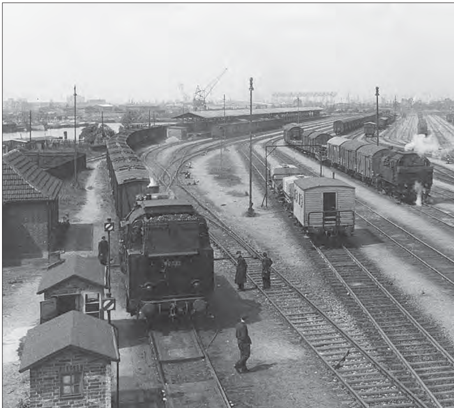
Rbf Hamburg Süd am 7. Juni 1957. Links im Bild zwei Gleiswaagen, über die gerade 82 030 fährt, nachdem sie eine lange Reihe gedeckter Güterwagen amerikanischer Bauart abgestellt hat. Die in Bildmitte abgestellten Eichwagen lassen darauf schließen, dass die Messgenauigkeit der Gleiswaagen gerade überprüft werden soll. Foto Hollnagel, Sammlung SC
