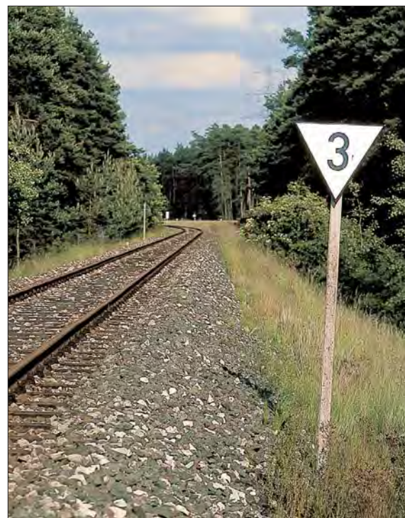
Lf 4-Signal für 30 km/h bei Georgensgmünd im Juni 1985
