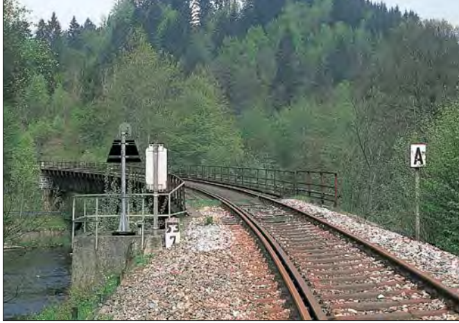
Links: Anfangstafel an der Strecke Passau–Freyung im Mai 1989 vor einer Ilzbrücke, die nur mit verringerter Geschwindigkeit befahren werden darf. Links im Bild eine Trapeztafel für die Gegenrichtung.
