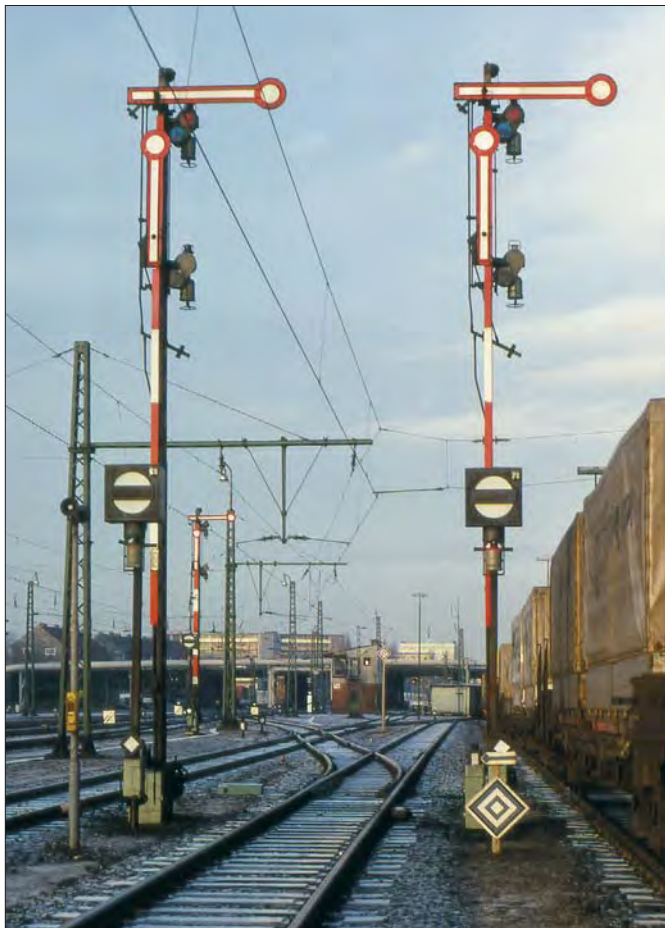
Niedriges El 6-Signal im Rbf Hamburg-Rothenburgsort im Dezember 1985 mit falschem, in die Richtung der weiterlaufenden Oberleitung zeigendem Richtungspfeil
