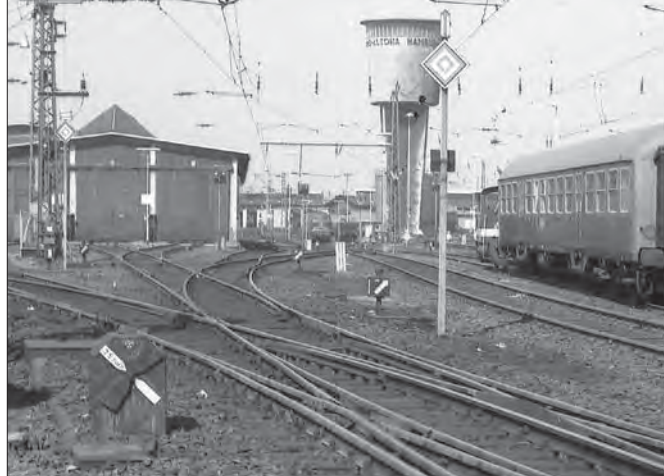
Bw Hamburg-Altona im Sommer 1978. In Bildmitte ein El 6-Signal mit geradeaus zeigendem Richtungspfeil, links im Hintergrund ein Signal mit zwei nach rechts zeigenden Pfeilen.
