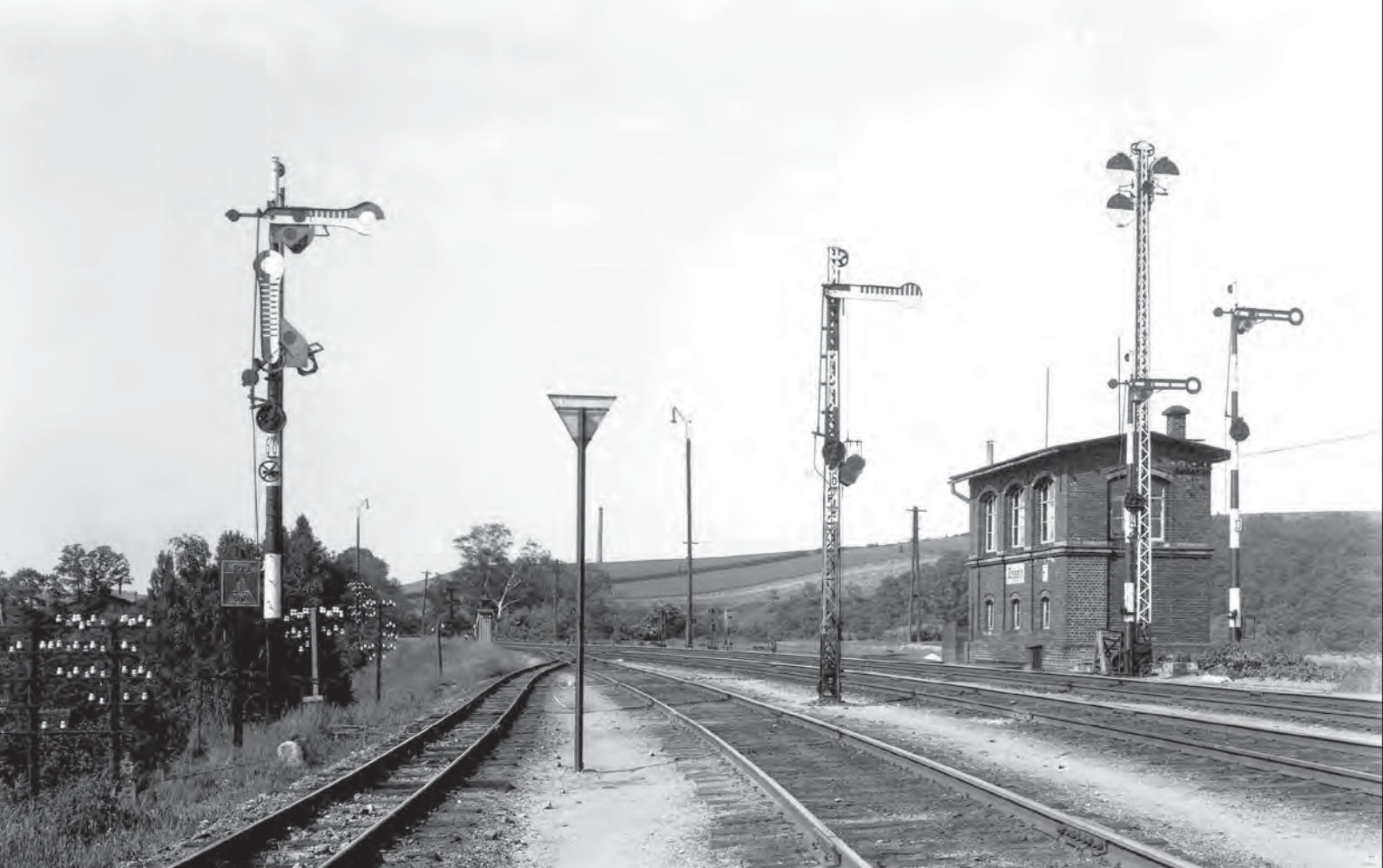
Bf Döbeln um 1930. Beeindruckend ist die Vielfalt unterschiedlicher Signale (v. l. n. r.): Neigungswechseltafel und dahinter das zweiflügelige Deckungssignal der Schmalspurbahn für den Dreischienenabschnitt. In Bildmitte die Rückansicht eines Geschwindigkeitsanzeigers, rechts drei einflügelige Ausfahrtsignale unterschiedlicher Bauart und das Fahrstraßenräumungssignal für die Hauptbahn. Im Bildhintergrund ist obendrein links neben den Gleisen ein Lütewerk zu erkennen. Foto Kroll, Sammlung Hermann Hoyer
