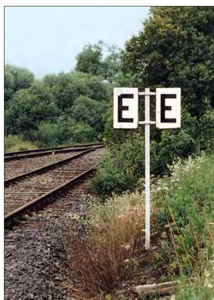
Obwohl das K 7e bei der DB 1959 entfallen ist, stand im Sommer 1991 noch ein solches Signal im Bahnhof Würzburg.
