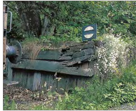
Als Gleisabschluss eines Nebengleises dient im Bahnhof Hartmannshof im Juni 1985 ein mit Altschwellen abgestützter Erdhaufen. Insbesondere bei solchen Gleisabschlüssen ist die Kenntlichmachung mit einem Sh 0-Signal unabdingbar, vorgeschrieben ist sie für alle Gleisabschlüsse.
