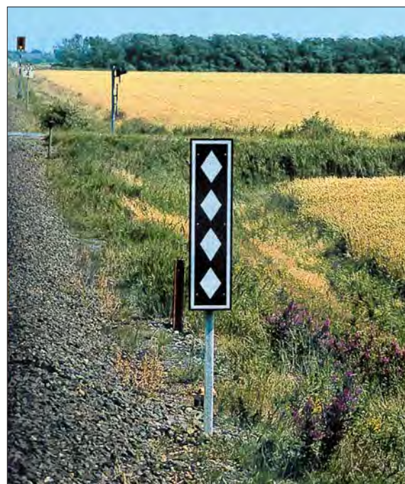
Links: Signal BÜ 2: Ab 60 km/h werden die großen Tafeln aufgestellt, unter 60 km/h die kleinen. Beide können mit ein oder zwei BÜ-Ankün- detafeln kombiniert werden.
