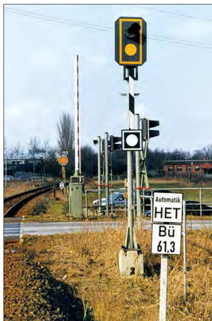
Überwachungssignal-Wiederholer neuer Bauform sowie davor eine BÜ-Tafel im Februar 2004 in Heide. Über der BÜ-Tafel eine Tafel mit dem Hinweis auf die HilfsEinschaltTaste.
