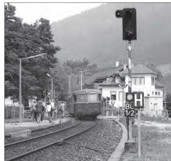
In verkürztem Bremswegabstand stehender Überwachungssignal-Wiederholer der Bauform 1975 bei Neuffen im Sommer 1984
