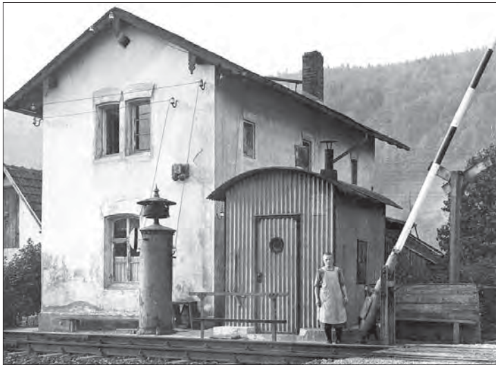
Nur wenige Fotografen nahmen Motive am Rande der Bahn auf. Einer von ihnen war Ernst Köditz, der 1947 diesen Schrankenposten bei Kulmbach dokumentierte. Vor dem Wohnhaus ein Läutewerk der Bauart Mantelbude mit senkrecht stehender Fallscheibe, die in der Ruhestellung waagrecht liegt und durch das Läuten ausgelöst wird. Foto Köditz
