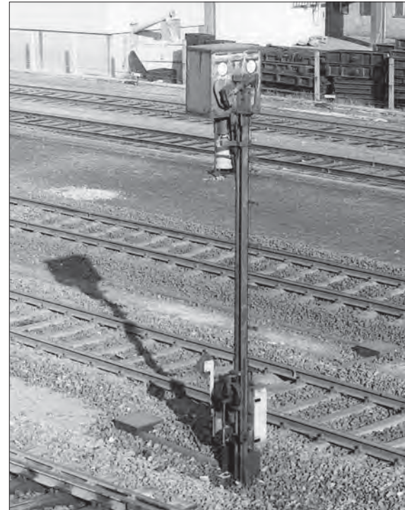
Rückansicht eines Gleissperrsignals im Bahnhof Mölln im Juli 1979. Auf dem Bild ist zu erkennen, dass rückseitig die untere Blende bei diesem Signal, obwohl nicht mehr erforderlich, nicht demontiert wurde.
