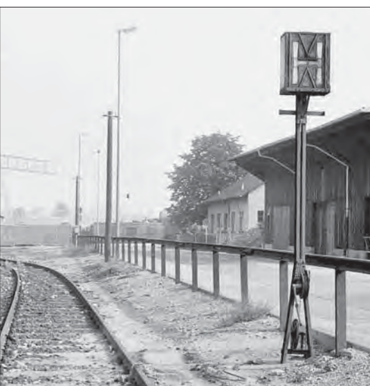
Links: Niedrige Ausführung der H-Tafel mit Innenbeleuchtung im August 1972 in Mannheim-Hafen. Foto Günter Berg
