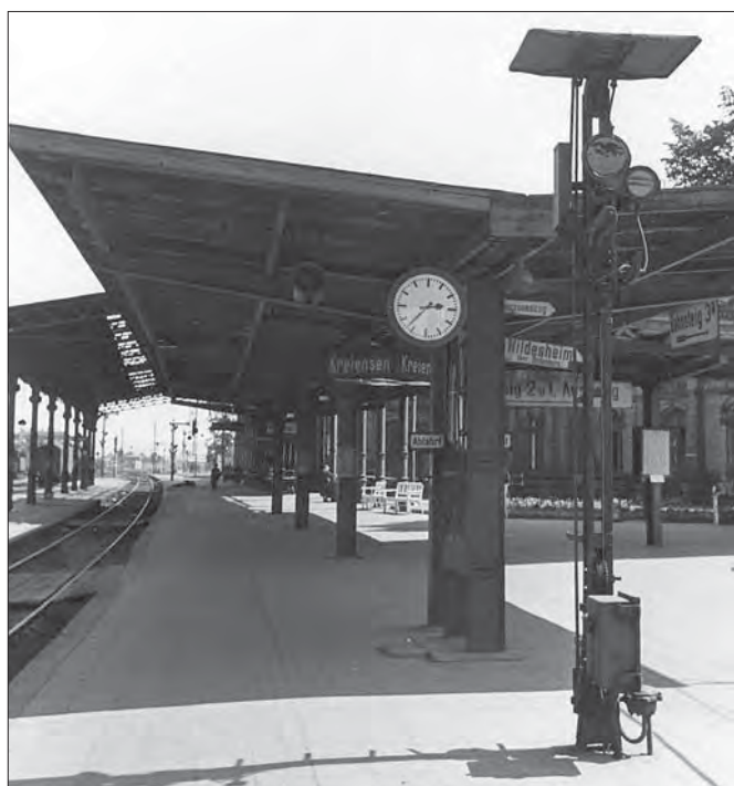
Ebenfalls im Juli 1952 in Kreiensen entstand das Foto einer niedrigen Deckungsscheibe mit elektromechanischem Antrieb und elektrischer Beleuchtung. Foto Bustorff, Sammlung SC
