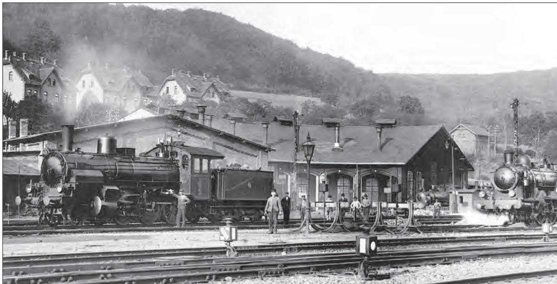
Das Bw Elm um 1910. Links wartet die G5 4 Frankfurt 4191 auf den nächsten Einsatz. Im Vordergrund Weichensignale, deren Kastenlaternen zwar schon die Signalbilder der Einheitssignale zeigen, jedoch noch nicht der Einheitsform entsprechen. Die Prellböcke sind mit beleuchteten Sperrsignalen ausgerüstet.
