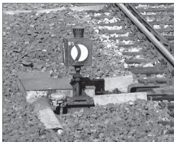
Signal an einer Außenbogenweiche im Bahnhof Furth i. W. im Juli 1997. Während Weichensignale mit Reflektorschildern im Grundriss quadratische Signalkörper haben und daher die Signalbilder der Regelausführung entsprechen, besitzen beleuchtete Weichensignale einen im Grundriss 300 x 220 mm großen Signalkörper, sodass die Pfeile an den Stirnseiten andere Abmessungen haben.
