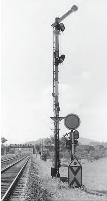
Das 10 m hohe Einfahrtsignal des Bahnhofs Kreiensen mit Negativflügeln und einem bei der Einfahrt in das durchgehende Hauptgleis weggeklappten Signal Fw 101 (Vorläufer des Geschwindigkeitsanzeigers) sowie daneben das Ausfahrtsignal im Juni 1952. Foto Bustorff, Sammlung SC
