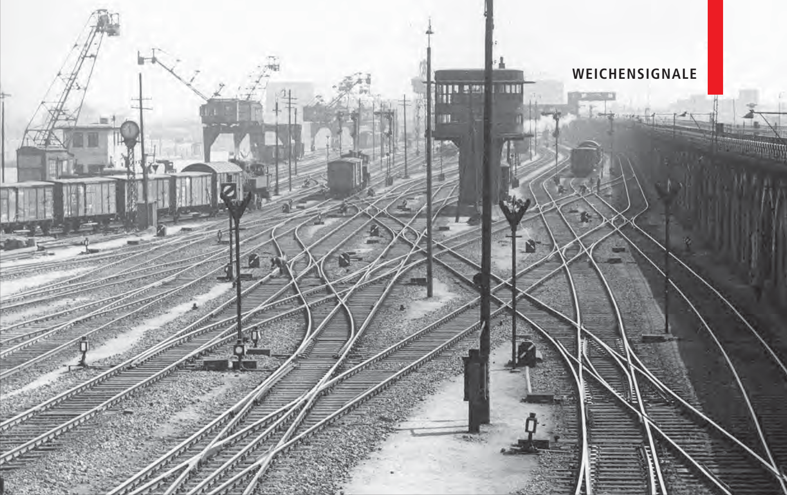
Bahnhof Hamburg Hgbf, ehemals Hannöverscher Bahnhof, im Jahr 1951. Im Hintergrund zwei rangierende Lokomotiven der Baureihe 91 3 . Von den Anlagen auf dem Bild – Stellwerke, Kräne, diagonal über den Bahnhof verlaufende, parallele Weichenverbindungen mit allein 14 auf dem Bild zu zählenden DKW – ist heute nichts mehr zu finden. Foto Hollnagel, Sammlung SC
