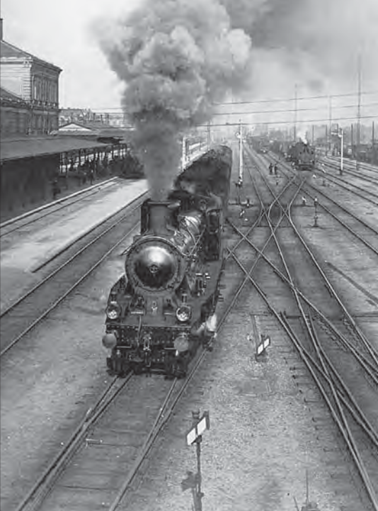
XV Nr. 181 der Sächs. Staatsbahn fährt 1904 mit dem D 22 Berlin–München aus Altenburg/Thür. aus. Im Vordergrund mehrere Weichensignale sächsischer Bauart. Foto Contius
