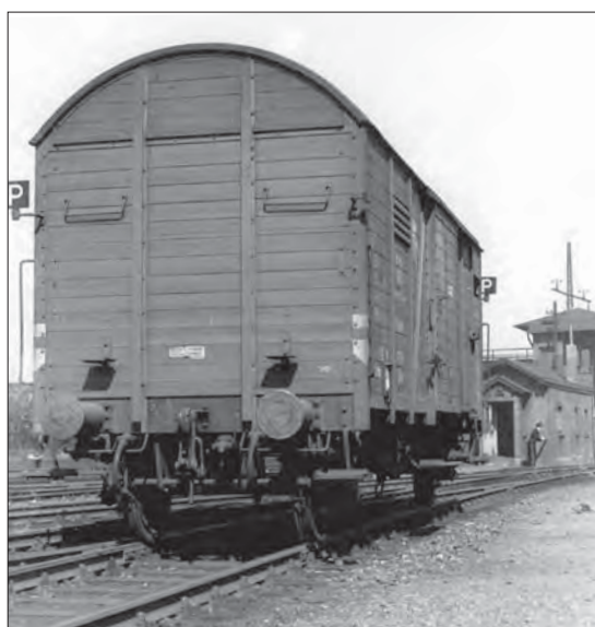
Pulverflaggen an einem Ghs Oppeln im Rbf Hmb-Wilhelmsburg (1951). Stirnseitig waren zusätzlich Zettel mit der Aufschrift „Vorsichtig rangieren“ aufgeklebt.
