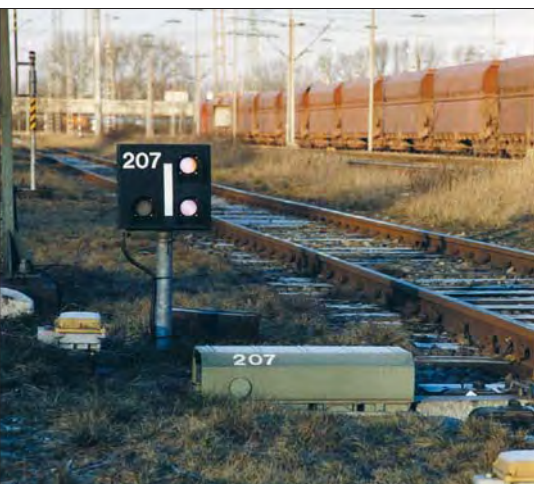
Lichtsignal an einer EOW im Erzverladebahnhof Hansaport im Februar 2004. Die Weiche steht auf dem geraden Strang, der auch als Grundstellung vorgeschrieben ist – kenntlich gemacht mit dem senkrechten weißen Streifen auf dem Signalkörper.
