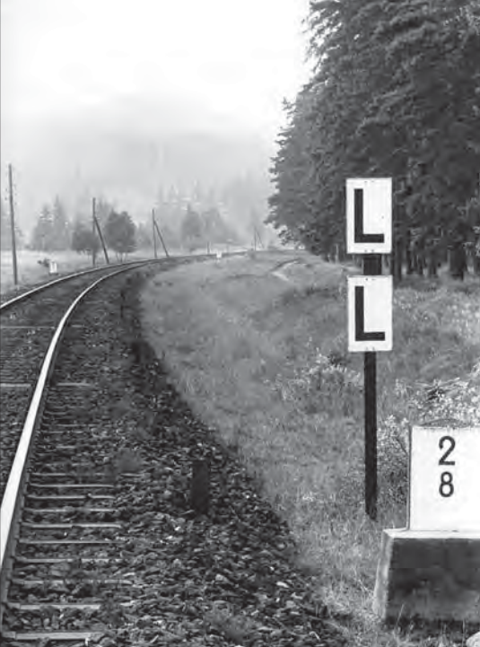
Durchläutebeginntafel bei Langelsheim (an der inzwischen abgebauten Strecke nach Altenau) im Juli 1952. Foto Bustorff, Slg. SC
