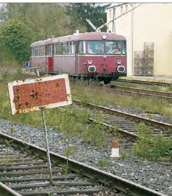
Zur Verringerung des Winddrucks durchbrochene „Uraltausführung“ einer Wärterhaltscheibe am 5. Mai 2005 im Bahnhof Frontenhausen. Foto Alexander Lindner
