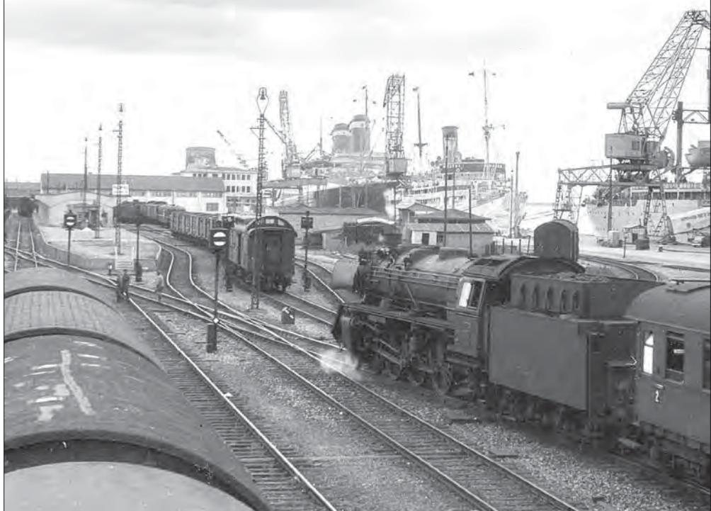
Zum Flankenschutz der diagonal über den Bahnhof Bremerhaven-Columbusbahnhof führenden Fahrstraße stehen unmittelbar vor der Einmündung der Abstellgleise Gleissperrsignale. Das Foto, das einen einfahrenden, von 03 131 des Bw Bremen Hbf gezogenen Schnellzug zeigt, entstand am 9. Oktober 1952. Im Hintergrund hinter kleineren Passagierschiffen die S.S. United States, die auf ihrer Jungfernfahrt am 3. Juli 1952 das Blaue Band für die schnellste Atlantiküberquerung erwarb. Foto Hollnagel, Sammlung SC
