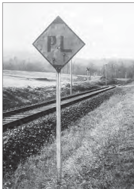
Bayerische Läute- und Pfeiftafel 1949 an der Nebenbahn Neustadt (Aisch)–Steinach b. Rothenburg o. T.
