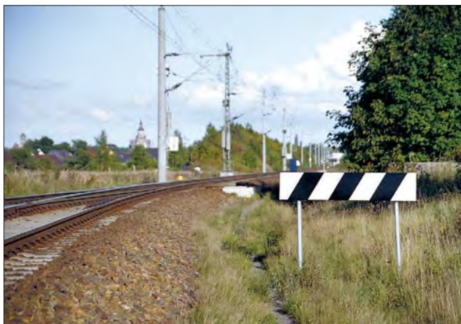
Vermutlich bereits um 1920 aufgestellte Schneepflugtafel an der Höllentalbahn im Januar 2006. Foto Michael Schnippering
