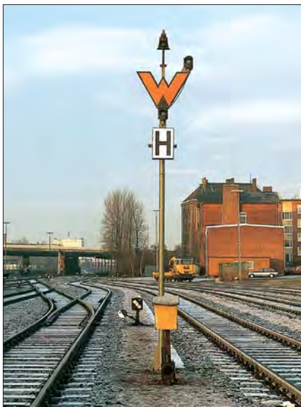
Wartezeichen an Lokabstellgleisen im Bahnhof Büchen im Juni 1983. Da bei dem linken Wartezeichen der Gleisabstand weniger als 4,50 m beträgt, ist es mit einem Gefahranstrich versehen.
