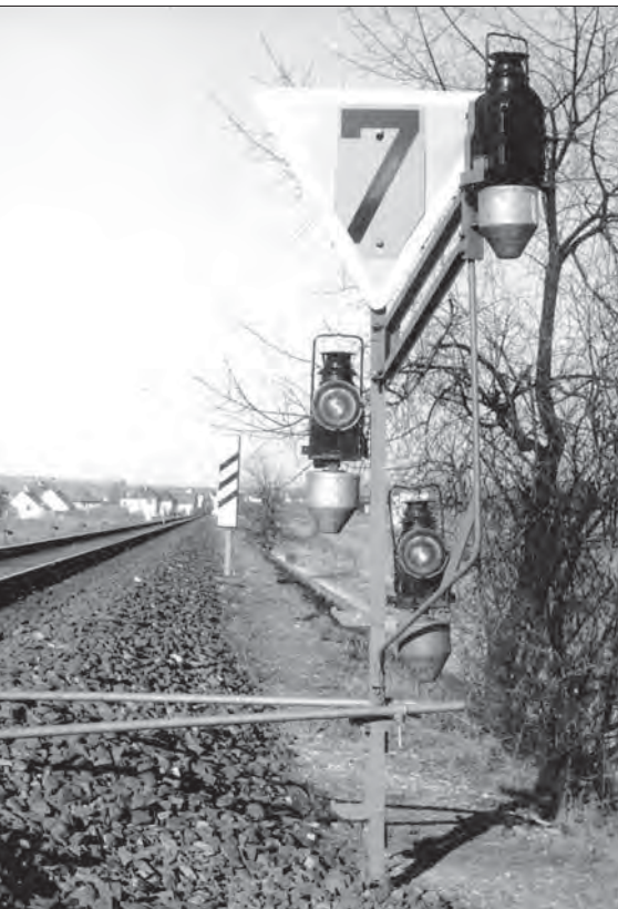
Verschiedene Ausführungen der Langsamfahrscheibe mit Anstrahlleuchte. Links oben ein hohes Lf 1-Signal im Bahnhofsbereich, darunter die niedrige Ausführung (beide Zeichnungen in H0-Größe). Rechts ein hohes Signal an der freien Strecke in doppelter H0-Größe.
