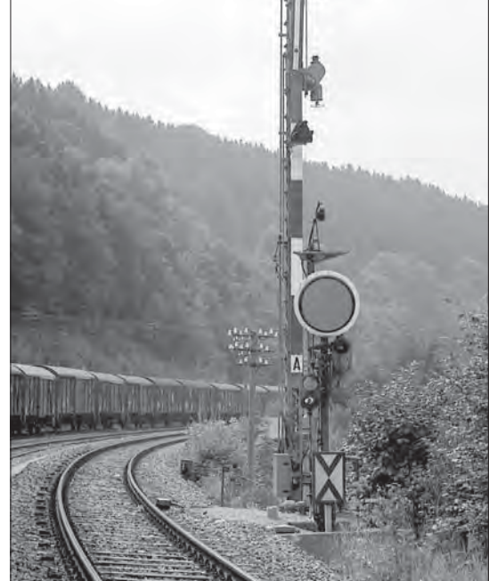
Hingegen fuhren Züge aus Pforzheim nur selten in das Stumpfgleis, der Geschwindigkeitsanzeiger war daher weggeklappt.
