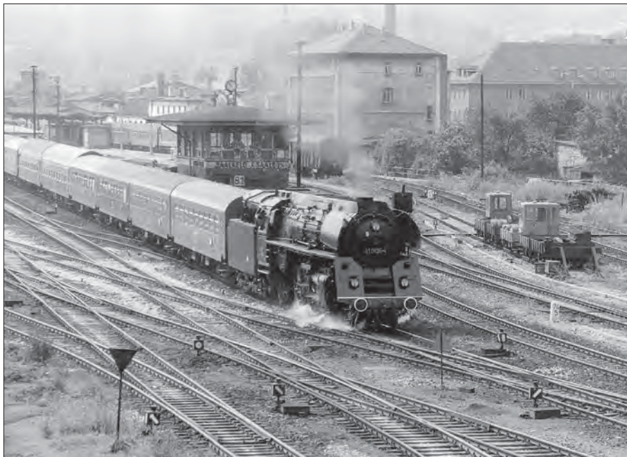
01 0525-4 verlässt mit dem D 504 nach Leipzig am 26. Juli 1977 den Bahnhof Saalfeld. Im Vordergrund zwei einfache Kreuzungsweichen mit Weichensignalen der Einheitsbauform.
