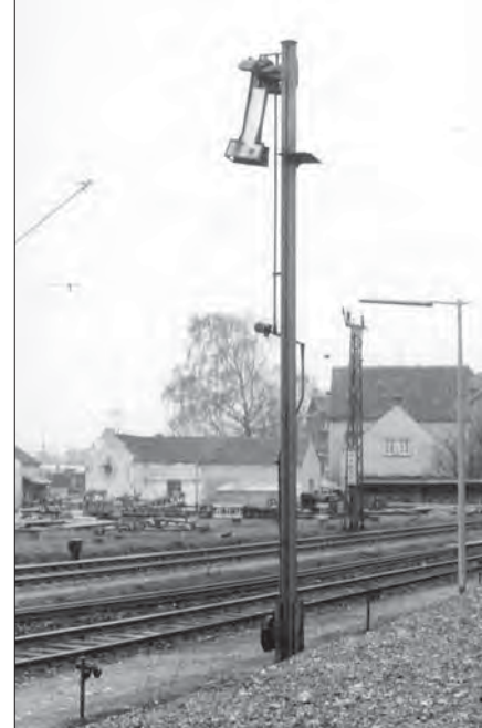
Hammersignal am Ablaufberg im Bahnhof Freilassing Ostern 1970 in der Stellung „Mäßig schnell abdrücken“. Foto Siegfried Bufe
