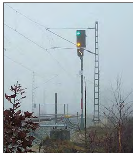
Lichtleiter-Gleiswechselanzeiger bei Unterhaching im November 2003. Foto A. Lindner
