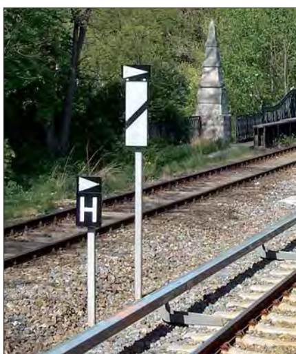
Links stehende H-Tafel und Vorsignaltbake mit Zuordnungstafeln am S-Bahn-Haltepunkt Berlin-Mexikoplatz im Mai 2003
