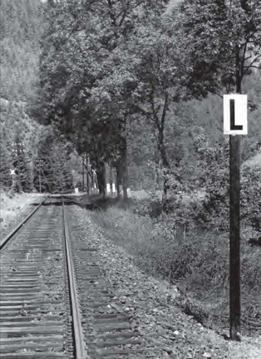
Alte Ausführung der Läutetafel an einem Holzpfosten vor einem technisch nichtgesicherten Bahnübergang zwischen Lautenthal und Wildemann im Juli 1952.
