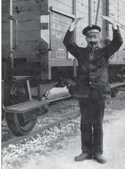
Signalbilder der Bremsprobesignale v. l. n. r.: Bremsen anlegen, Bremsen lösen und Bremsen in Ordnung
