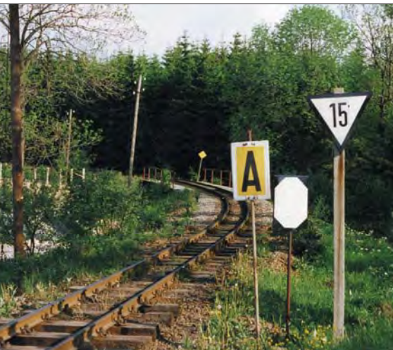
Lf-Signale am Haltepunkt Vierenstraße (Strecke Cranzahl–Oberwiesenthal) im Mai 1992. Die mit der Geschwindigkeitstafel angezeigten 15 km/h sind von der daneben stehenden Trapeztafel an einzuhalten. Daneben eine Anfangstafel, da wegen Bauarbeiten die Geschwindigkeit auf 10 km/h reduziert werden muss (zuvor durch ein Lf 1-Signal angezeigt). Foto Michael Schnippering
