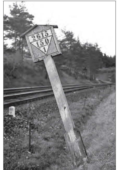
Bayerischer Neigungswechselanzeiger für eine 2,6 km lange Gefällestrecke mit einer Neigung von 1:150 bei Kirchenlaibach im Jahr 1949 fotografiert. Foto Robert Zintl
