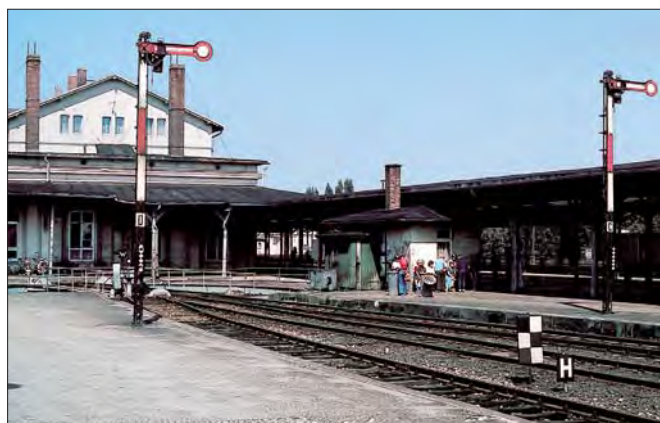
Nicht nur die Anordnung und Zwergausführung der Schachbretttafel und der H-Tafel im Bahnhof Leinefelde sind interessant, sondern auch die Hauptsignale preußischer Bauform am Ende der Einfahrstraßen. Sie lassen sich nicht auf Fahrt stellen, da über die Signale hinaus nur Rangierfahrten zum Umsetzen der Lokomotiven möglich sind im Juni 1979.
