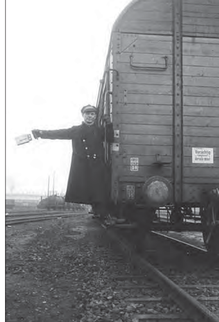
Zwei Bilder aus dem Rbf Hamburg-Rothenburgsort vom 19. November 1951. Links gibt der Rangierleiter für eine Rangierabteilung das Signal Ra 1 „Wegfahren“, rechts signalisiert er durch das Signal Ra 2 „Herkommen“ vom ersten Wagen der geschobenen Rangierabteilung aus, dass der Fahrweg frei ist. Fotos Hollnagel, Sammlung SC
