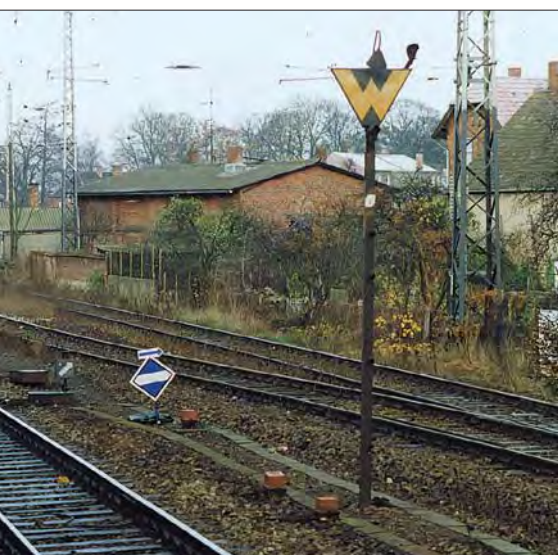
„Bügel-ab“-Signal mit einem Richtungspfeil für den abzweigenden Strang der Weiche vor einer Baustelle im November 1991 im Bahnhof Ludwigslust
