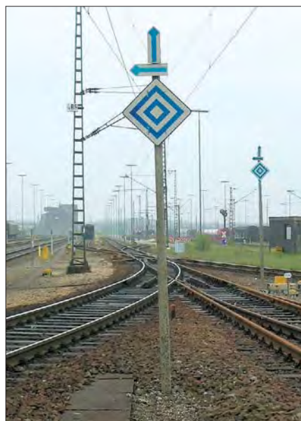
Reflektierende Ausführung des Signals „Halt für Fahrzeuge mit Stromabnehmern“ mit Richtungspfeilen nach links und für den geraden Strang für die im Hintergrund sichtbaren Weichen im Rbf Maschen im Juni 2004
