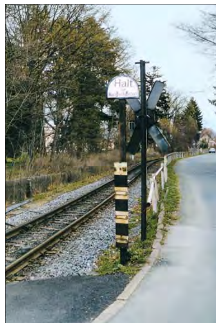
Warntafel zur Ankündigung eines Überwachungssignals einer Wegübergangssicherungsanlage und Rangierhalttafel bei Drei-Annen-Hohne im April 2004. Foto Knut Habicht
