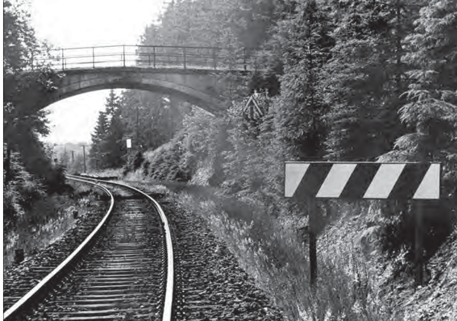
Haltpunkttafel für den im Hintergrund sichtbaren Haltepunkt an der Strecke Langelsheim–Altenau im Juli 1952. Dicht vor der Brücke steht seitlich im Gebüsch eine Schneepflugtafel. Foto Bustorff, Sammlung SC
