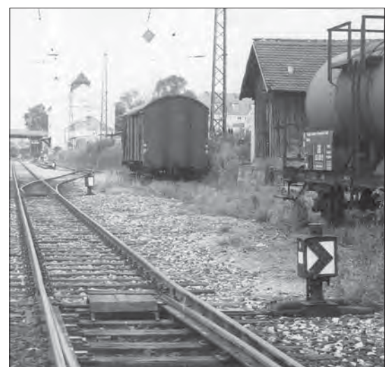
Bahnhof Spalt im Jahr 1957. Für die Rangierfahrt der 98 301 stehen die beiden ortsgestellten DKW für die Fahrt durch die Nebenrichtung.
