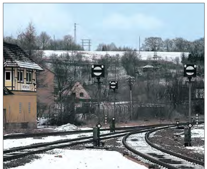
Links die Ausfahrt in Richtung Walkenried mit dem Stellwerk „Ho“ im Hintergrund. Links das Ausfahrtsignal N2 am durchgehenden Hauptgleis, rechts die Signale N4 am Gleis nach Rhumspringe sowie N5 bis N7 für die Güterzuggleise. Während an den Gleisen 4–6 vor den Hauptsignalen niedrige Sperrsignale stehen, um die Sicht auf die Hauptsignale nicht zu behindern, konnte an Gleis 6 ein hohes Sperrsignal seitlich versetzt aufgestellt werden. Außerdem konnte das Ausfahrtsignal N7 darüber hinaus mit normalgroßen Flügeln ausgerüstet werden (bei den zwischen den Gleisen stehenden Signalen würde die untere Laterne ins Profil ragen).
