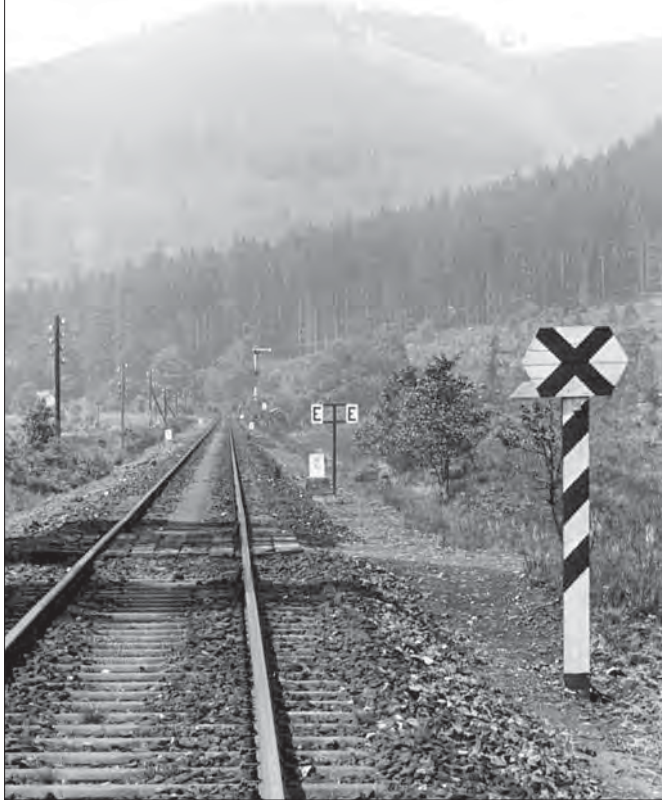
Kreuztafel an der Strecke Langelsheim–Altenau zur Ankündigung des Einfahrsignals des Bahnhofs Innerste Talsperre im Bildhintergrund im Juli 1952 fotografiert. Foto Bustorff, Sammlung SC
