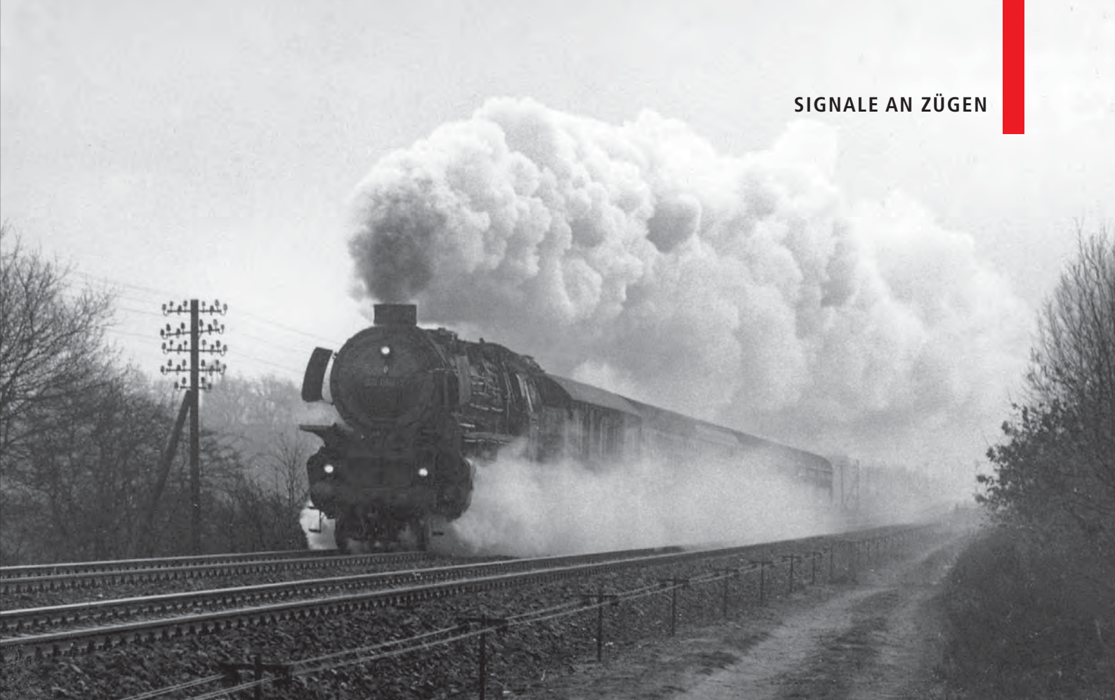
012 066-7 mit dem E 1631 Rheine–Norddeich-Mole am 23. Februar 1974 in der Nähe des Blocks Bentlage. Wegen des Frühnebels hat der Lokführer noch das Dreilichtspitzensignal eingeschaltet.
