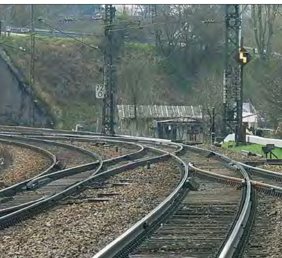
Hinter den Ausfahrtsignalen des Bahnhofs Reichertshofen stehender Gleiswechselanzeiger der Einheitsbauform mit Schirmblech im Winter 2004. Foto Alexander Lindner
