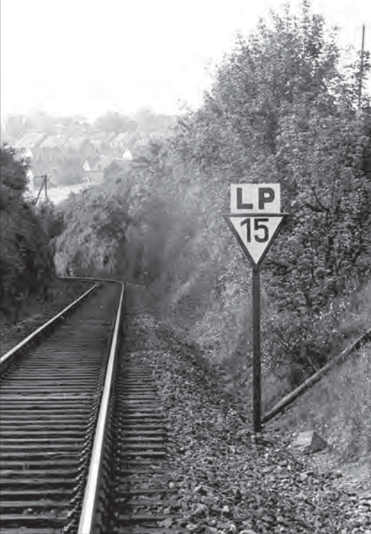
Gusseiserne LP-Tafel und Geschwindigkeitstafel der DRG für 15 km/h im Juli 1952 an der Strecke Langelsheim–Altenau.
