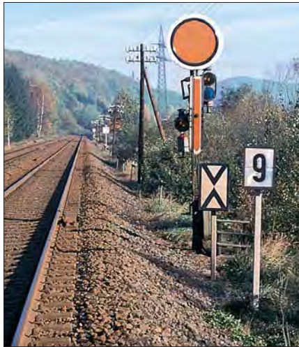
Das Einfahrvorsignal aus Richtung Northeim und das Geschwindigkeitssignal für 90 km/h im Oktober 1984. Fotos Horst Müller-Kuntzer
