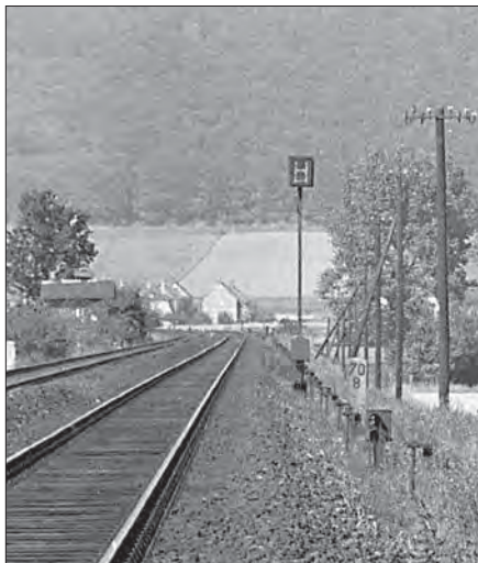
Richtungsvoranzeiger – „H“ für Hannover – vor dem Einfahrsignal des Bahnhofs Kreisen im Juli 1952. Foto Bustorff, Sammlung SC
