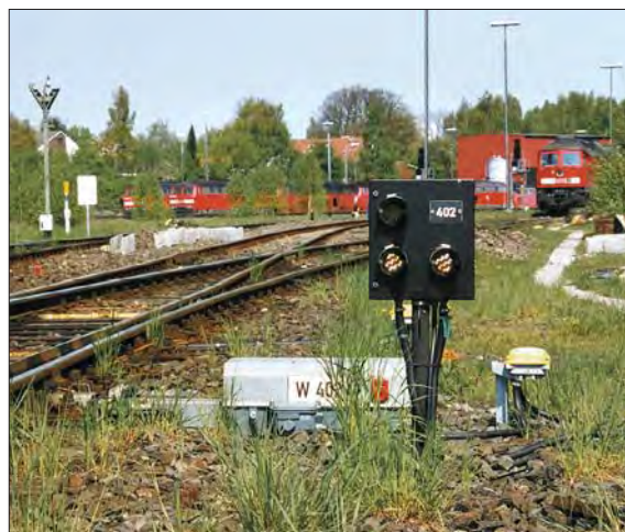
Rechts: EOW-Signal in der Stellung für die Fahrt über den abweigenden Strang an einer Weiche in Lübeck Hgbf im April 2004. Deutlich ist auf diesem Foto das aus Leuchtdioden zusammengesetzte Signallicht zu erkennen.
