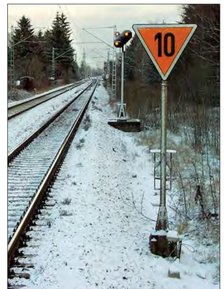
Rechts: Ehemals beleuchtetes Geschwindigkeits-Ankündesignal im Dezember 2003 am Hp München-Leienfelsstraße. Foto A. Lindner
