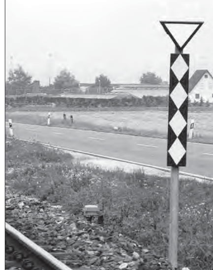
Rechts: Rautentafel für einen im verkürz- ten Bremswegab- stand liegenden Ein- schaltpunkt im Juli 2004 bei Dettingen
