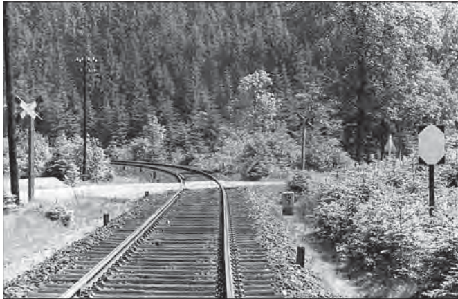
Links: Eckentafel vor einem schwer zu erkennenden Bahnübergang an der Strecke Langelsheim–Altenau im Juli 1952.
