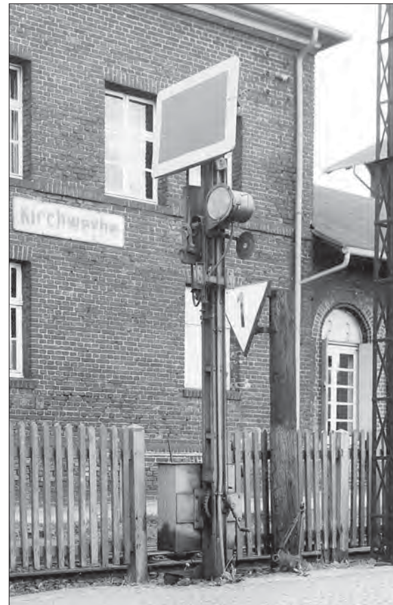
Rechts: Niedrige Deckungsscheibe mit elektrischer Beleuchtung im Mai 1961 im Bahnhof Kirchweyhe zum Schutz des Bahnsteigzugangs. Foto Joachim Claus
