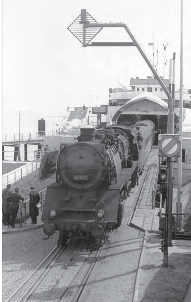
Das Hauptsperrsignal vor der Fährbrücke im Bahnhof Großenbrode Kai am 23. Mai 1955. Das Signal zeigt für 41 012 vom Bw Lübeck, die den D 82 „Alpen-Express“ Kopenhagen–Roma vom Fährschiff „Deutschland“ zieht, Sh 1 (bzw. damals noch Ve 4 ) „Fahrverbot aufgehoben“. Foto Hollnagel, Sammlung SC
