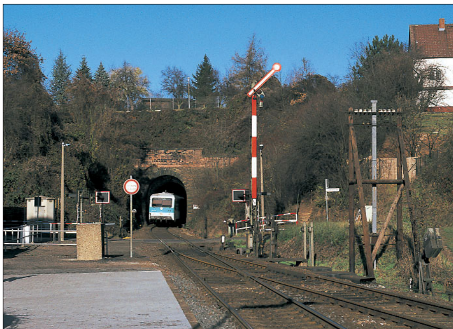
In Bahnhöfen auf Nebenbahnen gibt es oft nur ein gemeinsames Ausfahrsignal für zwei Gleise, das dann auch nur zweibegrig sein kann.
