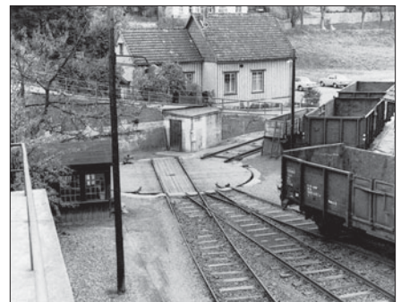
Die Erzverladung der Grube „Hilfe Gottes“, deren Bedienung über Waggondrehscheibe und Spillanlage umständlich und Zeit raubend war. Fotos: Klaus Lier
