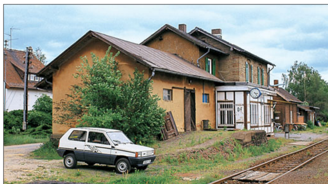
Nochmals Gleis- und Straßenseite des Empfangsgebäudes mit dem später angebauten Güterschuppen und dem nachträglich angefügten Stellwerksvorbau in Fachwerkbauweise
