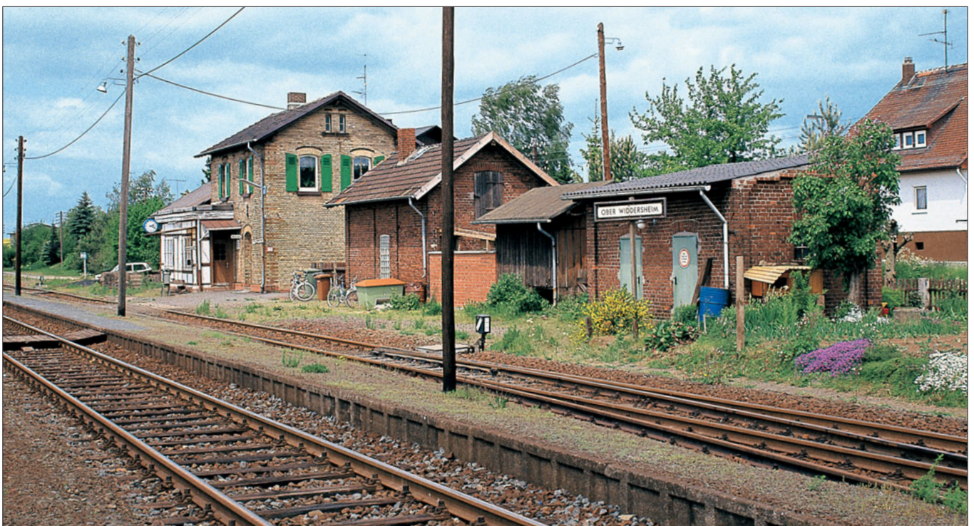
Das „Empfangsgebäude“ ist ein typischer Backsteinbau (um 1890) für Stationen der Klasse IV.
