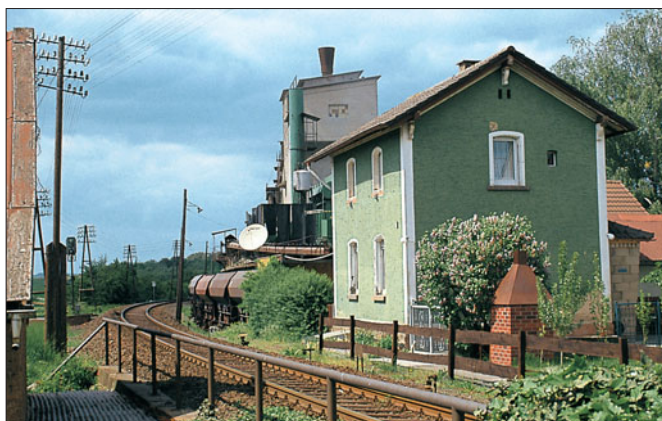
Nochmals Gleis- und Straßenseite des Empfangsgebäudes mit dem später angebauten Güterschuppen und dem nachträglich angefügten Stellwerksvorbau in Fachwerkbauweise
