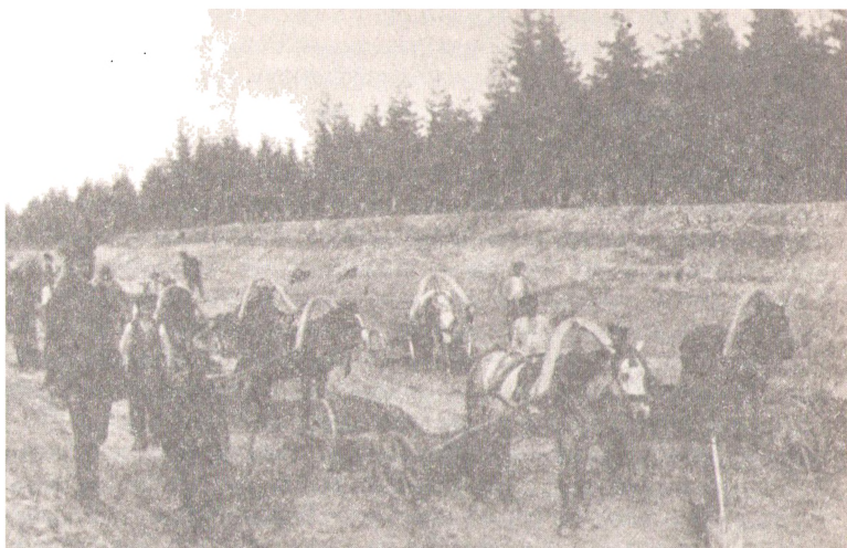
Перемещение грунта конной тягой
