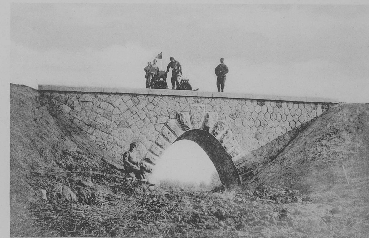
Постройка каменн. арочн. моста отъв. 2.00 саж. на 377 вер. пик. № 3768+23 Главной (западной) линіи.
