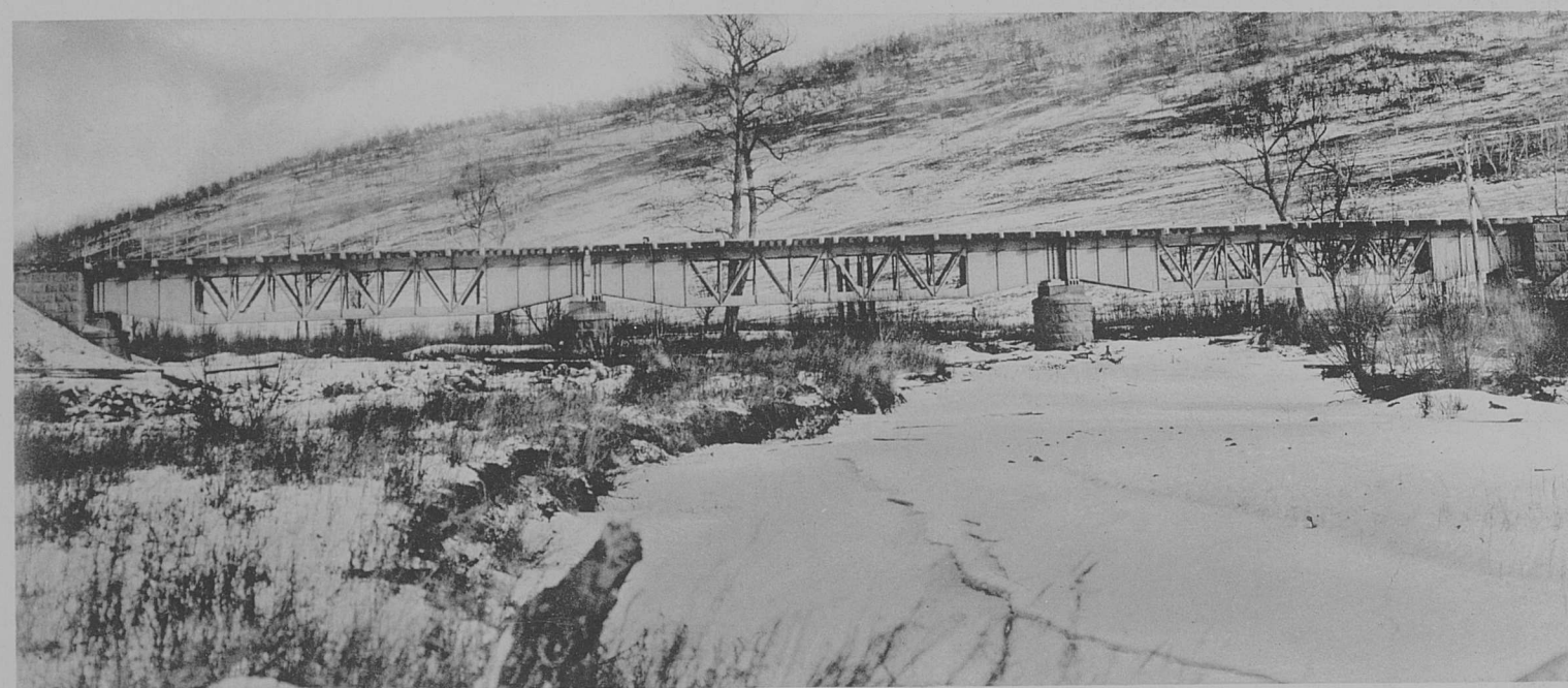
ОБЩІЙ ВИДЪ МОСТА ЧЕРЕЗЪ Р. БАРИМЪ ОТВ. 30.00 САЖ. (3×10.00) СЪ ѲЗДОЙ ПО ВЕРХУ. НА 441 ВЕР. ПИК. № 4400+45.50 ГЛАВНОЙ (ЗАПАДНОЙ) ЛИНІИ. ПРИ Н—4.12 САЖ.
