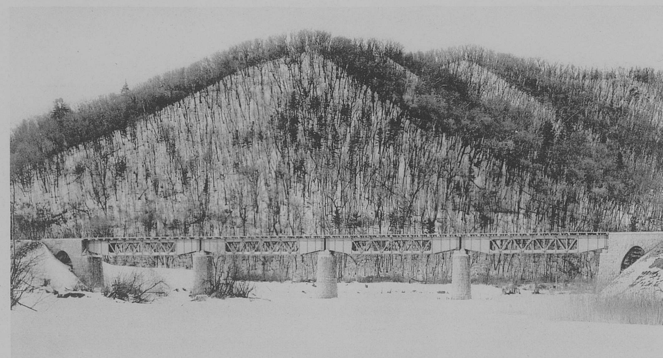
ОБЩІЙ ВИДЪ МОСТА ЧЕРЕЗЪ Р. МАЙХЕ II ОТВ. 40.00 САЖ. (4×10.00) СЪ ѲЗДОЙ ПО ВЕРХУ. НА 1052 ВЕР. ПИК. № 4707+34 ГЛАВНОЙ (ВОСТОЧНОЙ) ЛИНІИ. ПРИ Н—5.75 САЖ.
