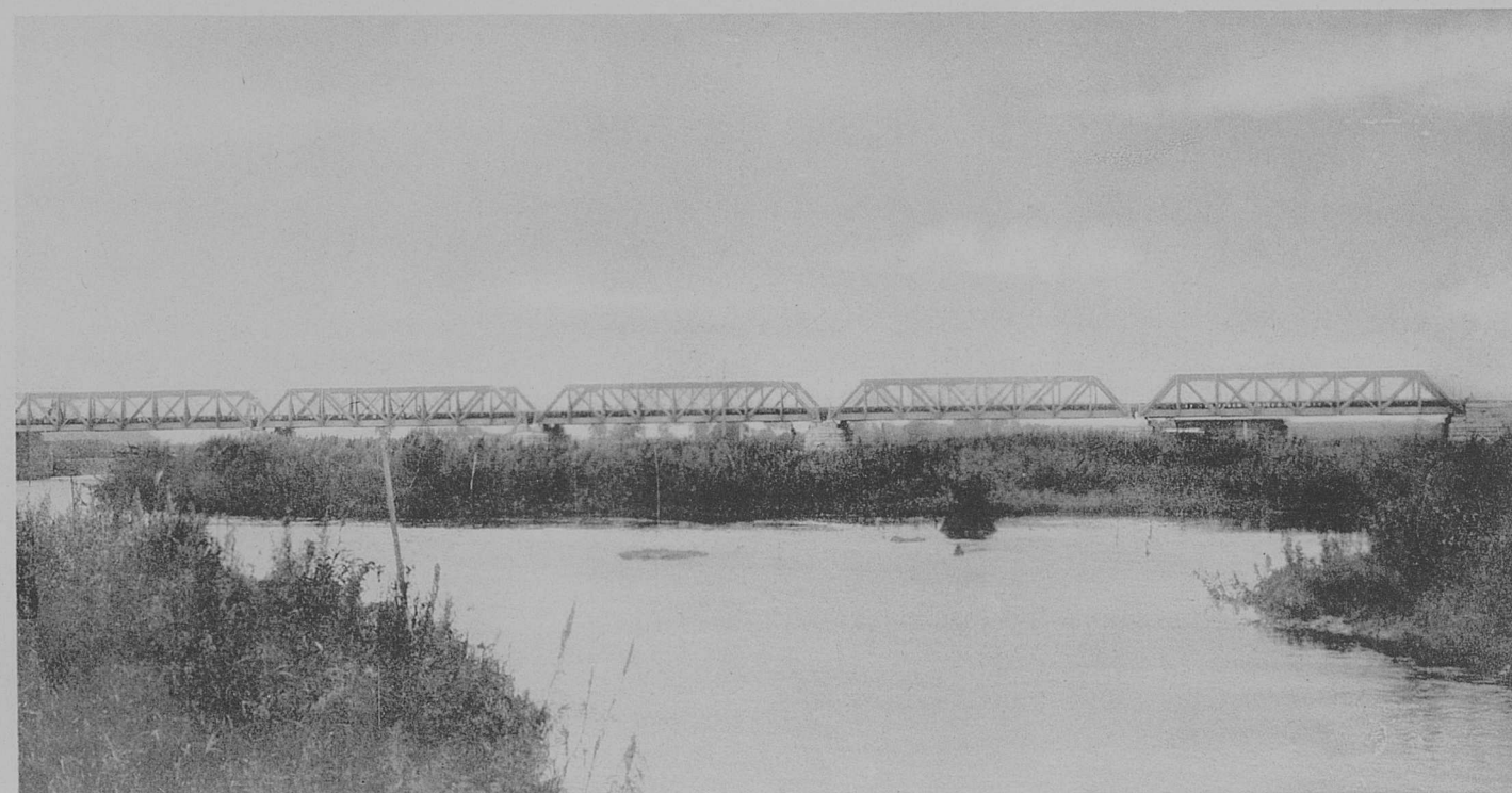
ОБЩІЙ ВИДЪ МОСТА ЧЕРЕЗЪ Р. ХОАШИГОУЗА ОТВ. 50.00 САЖ. (5×10.00) СЪ ѲЗДОЙ ПО НИЗУ. НА 1204 ВЕР. ПИК. № 3170+26.87 ГЛАВНОЙ (ВОСТОЧНОЙ) ЛИНІИ. ПРИ Н—2.43 САЖ.
