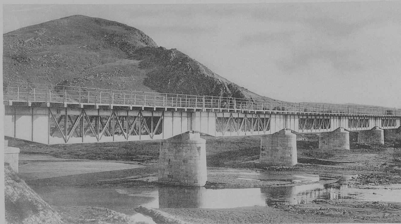
ОБЩІЙ ВИДЪ МОСТА ЧЕРЕЗЪ Р. АСАНХЕ ОТВ. 50.00 САЖ. (5×10.00) СЪ ѲЗДОЙ ПО ВЕРХУ. НА 599 ВЕР. ПИК. № 5969 ЮЖНОЙ ЛИНІИ. ПРИ Н—3.28 САЖ.
