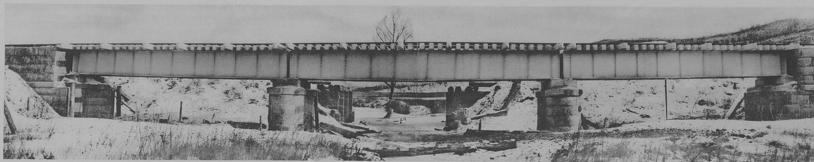
ОБЩИЙ ВИДЪ МОСТА ЧЕРЕЗЪ Р. ЛУНХЕ ОТВ. 20.00 САЗ. (5×4.00) НА 694 ВЕР. ПИК. № 6917 ЮЖНОЙ ЛИНИИ ПРИ Н-1.60 САЗ.
