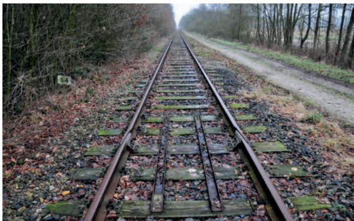
Het spoor tussen Boxtel en Veghel is deels 'langgelast', dus zonder het karakteristieke 'kabing-kabing' dat zo typerend is als treinen over dit soort marginale spoorlijnen boemelen. De spoorstaven zijn als één lange slang aan elkaar gelast. Toch moeten om spoorspattingen te voorkomen hier en daar marges in de rails zitten, waarvoor deze compensatielassen dienen. Bij uitzetten en inkrimpen schuiven de spoorstaven schuin langs elkaar; 30 januari 2011.
