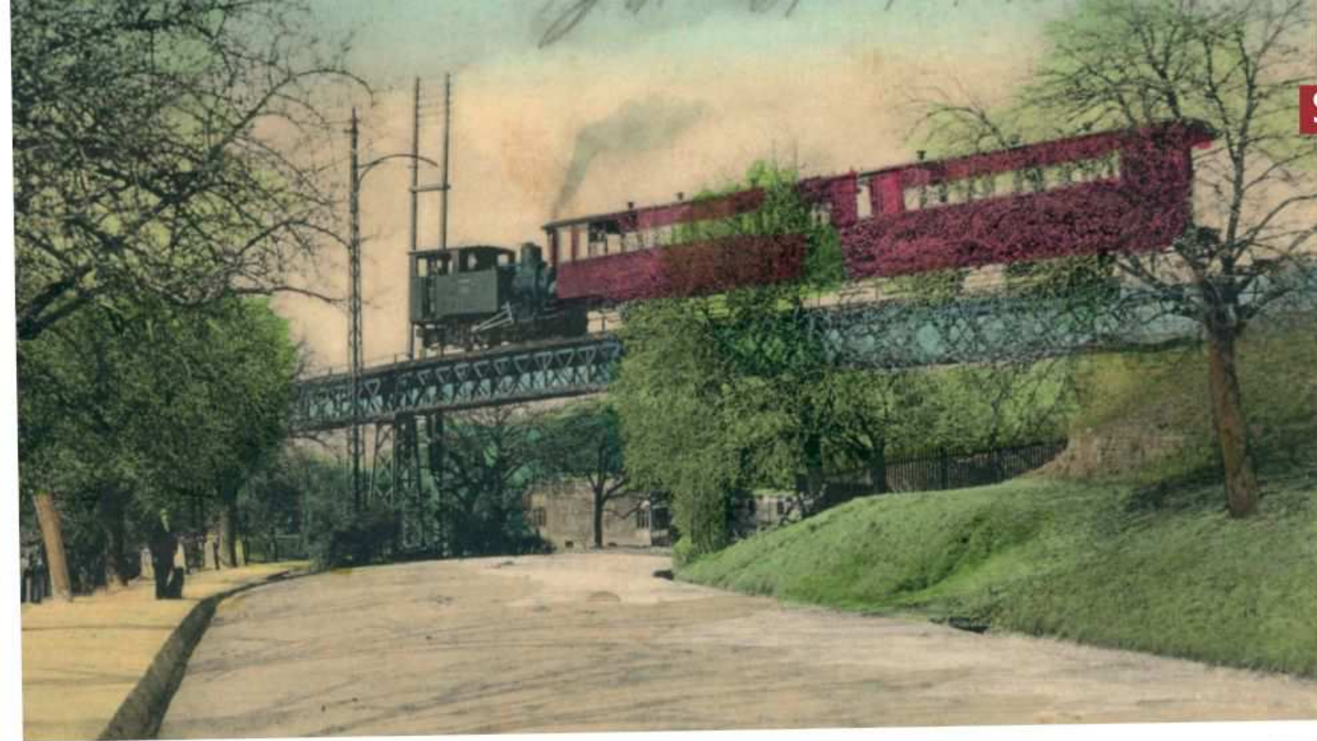
1884 fuhren die ersten Züge auf der liebevoll „Zacke“ genannten Zahnradbahn. Die Maschinenfabrik Esslingen lieferte die Erstausrüstung, darunter drei Zahnrad-Dampflok
