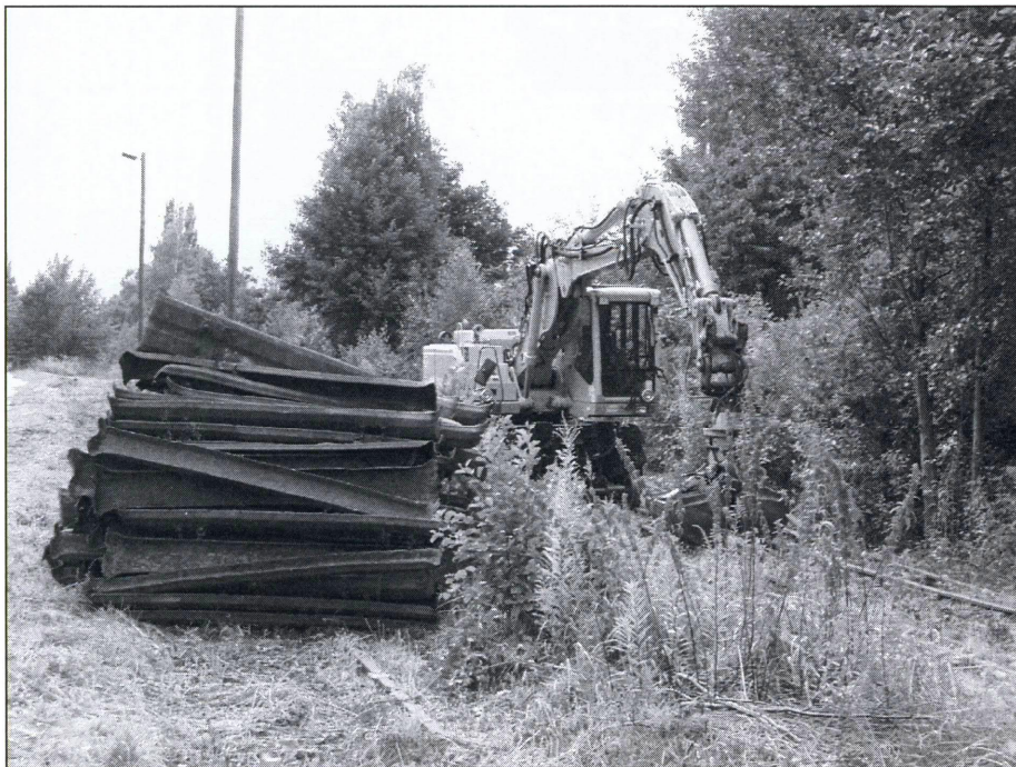
Abbau der zugewachsenen Gleise in der Ladestelle Copitz. (Foto: S. Otto, August 2005)
