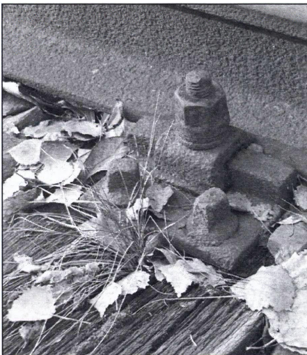
Der Kratzbach sorgt im Bereich der regelspurigen Gleisanlagen im Feldbahnmuseum für ständig hohen Wasserstand. Deshalb waren die Gleise bis zur Wiederinbetriebnahme bereits vollständig zugewachsen, und die jährliche Gleisentkrautung ist entsprechend aufwendig. (Foto: S. Otto)
