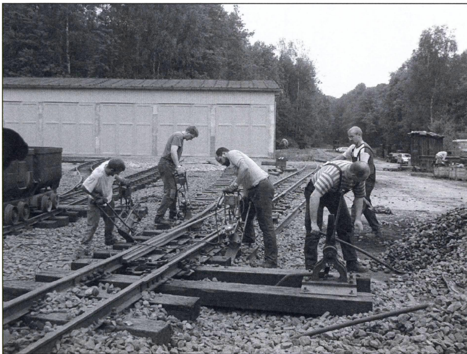
Gleisbauarbeiten für die Feldbahn im Vorfeld der Museumshalle, Mai 2003 (Foto: M. Sommer)
