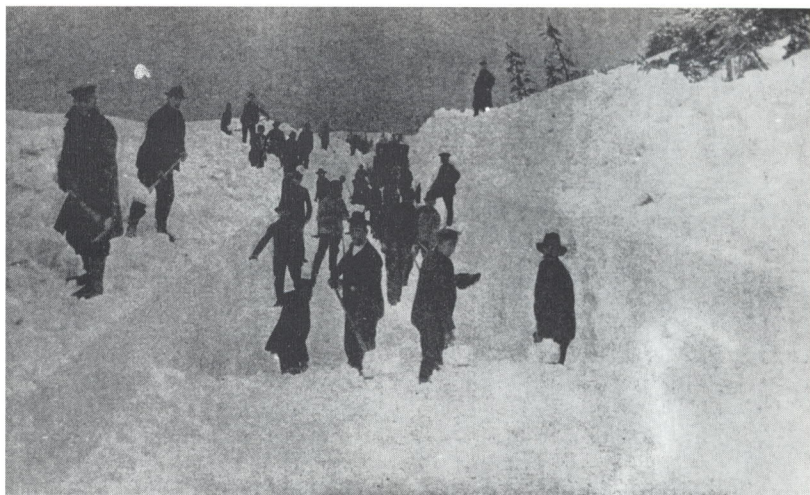
Die Ausschauelfung der Gelfeise der Brockenbahn. Nach einer Aufnahme des Holzhofphotographen Maefßer in Wernigerode.
