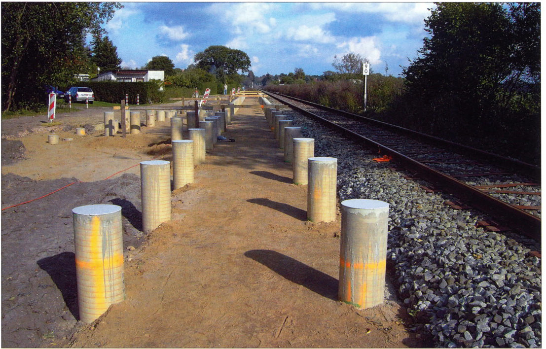
Graal-Müritz Koppelweg: Bahnsteigbau mit CFK-Rohren, die mit Beton verfüllt die tragenden Elemente aus Stahl für den Bahnsteig aufnehmen. Bauzustand 5.Oktober 2006. FOTO LOTHAR SCHULTZ
