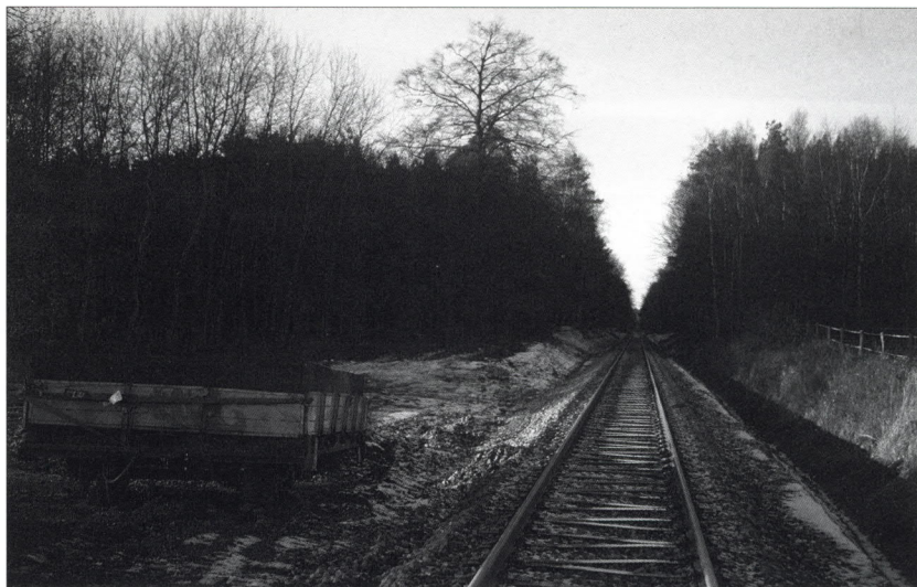
Sanierung der Strecke: Bauzustand am nördlichen Ortsrand Rövershagen, Das neue Gleis mit Y-Schwellen ist im Schot- terbett verlegt, 21. No- vember 2004. FOTO: PETER WILHELM
