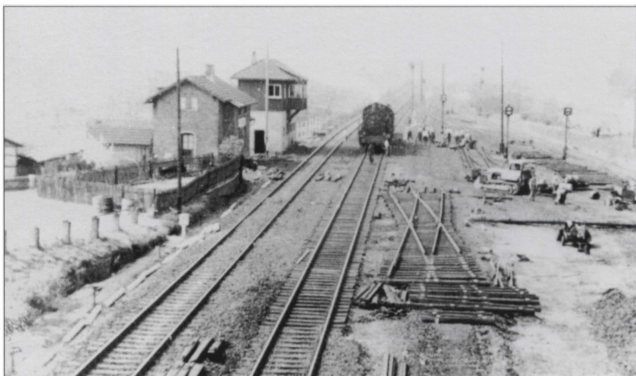
Baubeginn des Grenzbahnhofes in Gerstungen, 1961. Das Foto zeigt die Hauptgleise in Untersuhl, die hinter den Lokschuppen verlegt werden.
