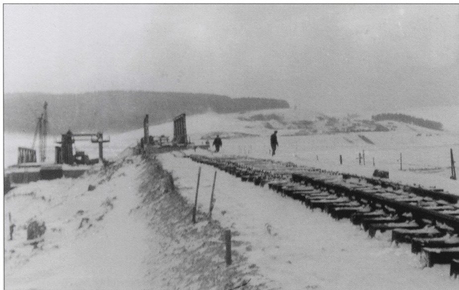
Verlegung der Schienen von Gerstungen bis zur Trassenbrücke.
