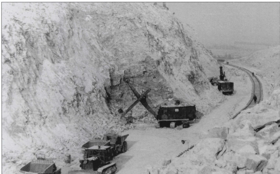
Die Trasse Gerstungen-Förtha-Eisenach wurde vom 18.9.1961 bis zum 13.4.1962 erbaut (Rekordtempo). 3,6 Millionen Kubikmeter Erdmassen wurden beseitigt, davon 3,2 Millionen Kubikmeter Fels!
