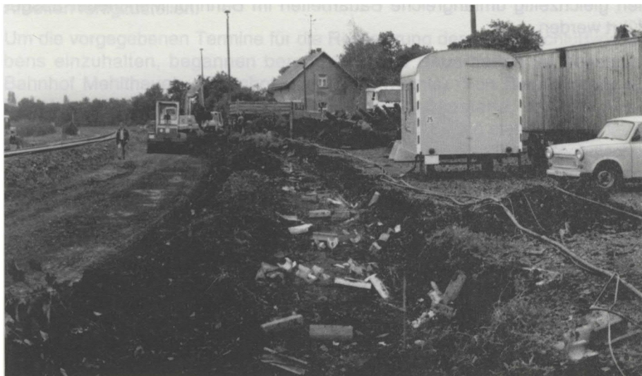
Nicht geplante Umlegung von Kabeln aus dem Bahnbereich
