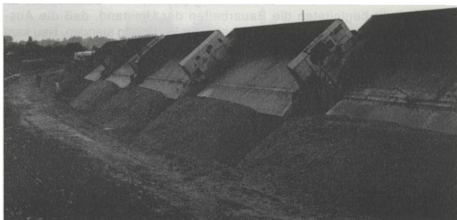
Massentransporte mit Selbstentladewagen
