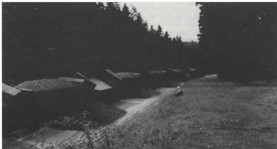
Schottereinbau für Verlegeplanum bei Kilometer 118,900 am 18. September 1990
