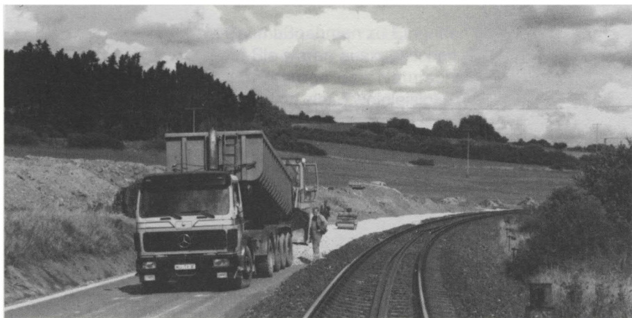
Gleis Feilitzsch-Hof km 158,4; Schotteranlieferung mit LKW
