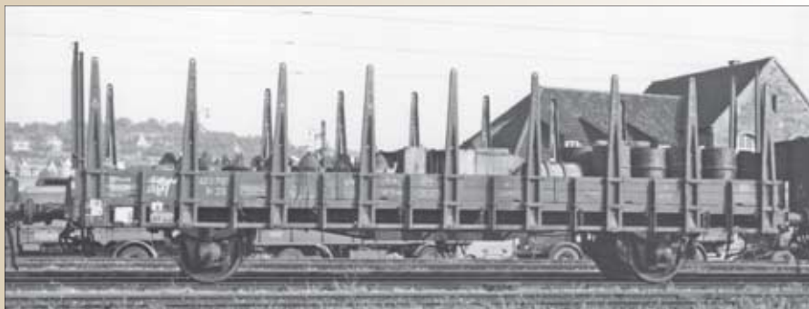
Zwei Austauschbauwagen in den 50er-Jahren fotografiert: Oben der R 20 402 984 mit Bremsenhaus, unten der Rr 20 403 703 mit Druckluftbremse. Fotos: Fritz Willke, Slg. Klaus Heidt
