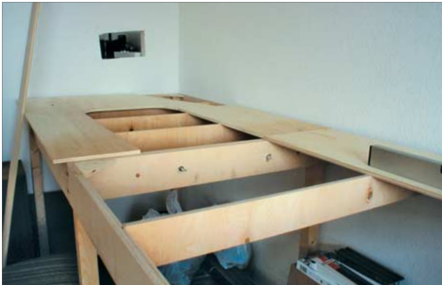
Der Anlagenunterbau – darüber ist die durch das auswandernde, lange Sägeblatt etwas schief geratene Maueröffnung zu sehen, die später durch die Bahnhofshallen getarnt wird.
