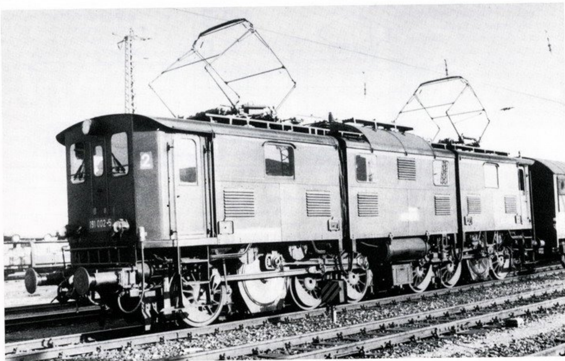
C'C'-Güterzuglokomotive 191 002-5 der DB, letzter Betriebszustand in München-Laim im Januar 1974
