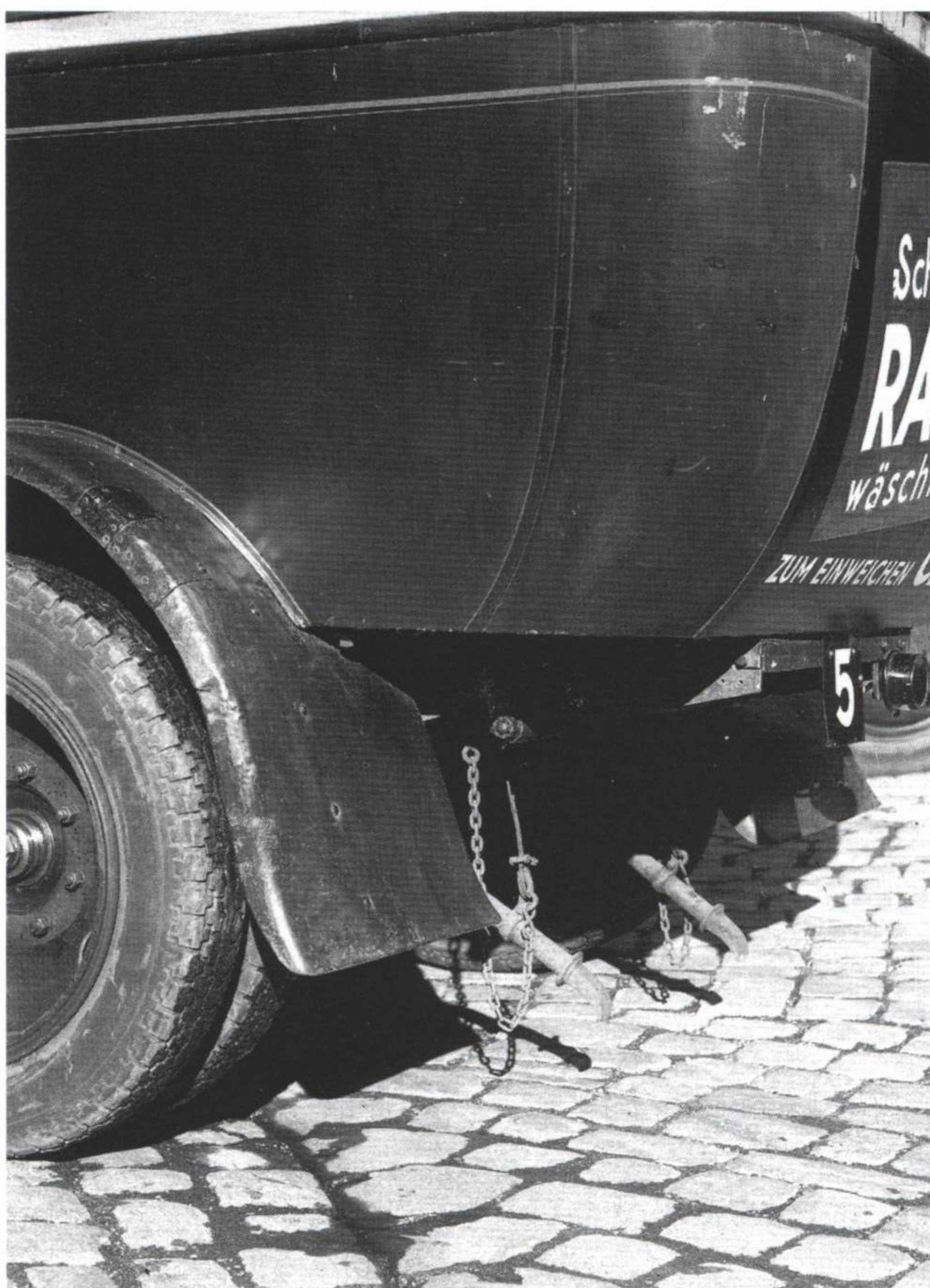
Auf diesen Bildern des Wagens Nr. 5 sieht man die Funktion der „Bergstütze“: Links in der Betriebsstellung (angehoben) und rechts abgesenkt, um ein Zurückrollen des Wagens zu vermeiden.
