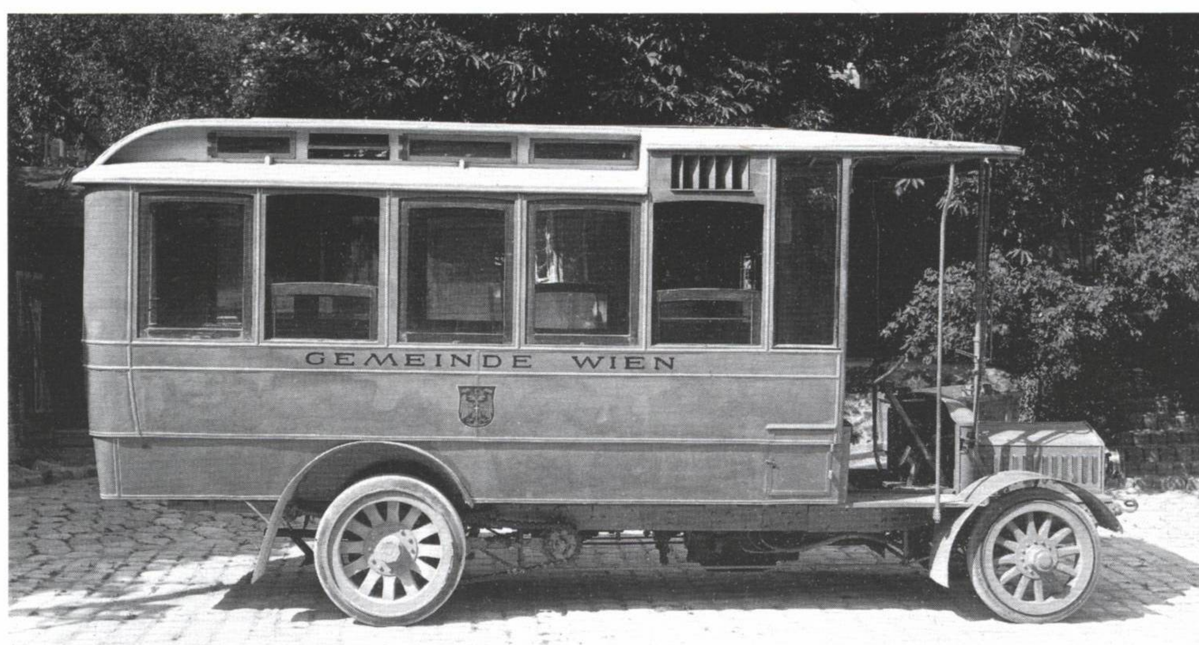
Der ehemalige Benzinbus Nr. 4 nach dem Umbau zum Elektrobus für die „Gleislose Bahn“.
