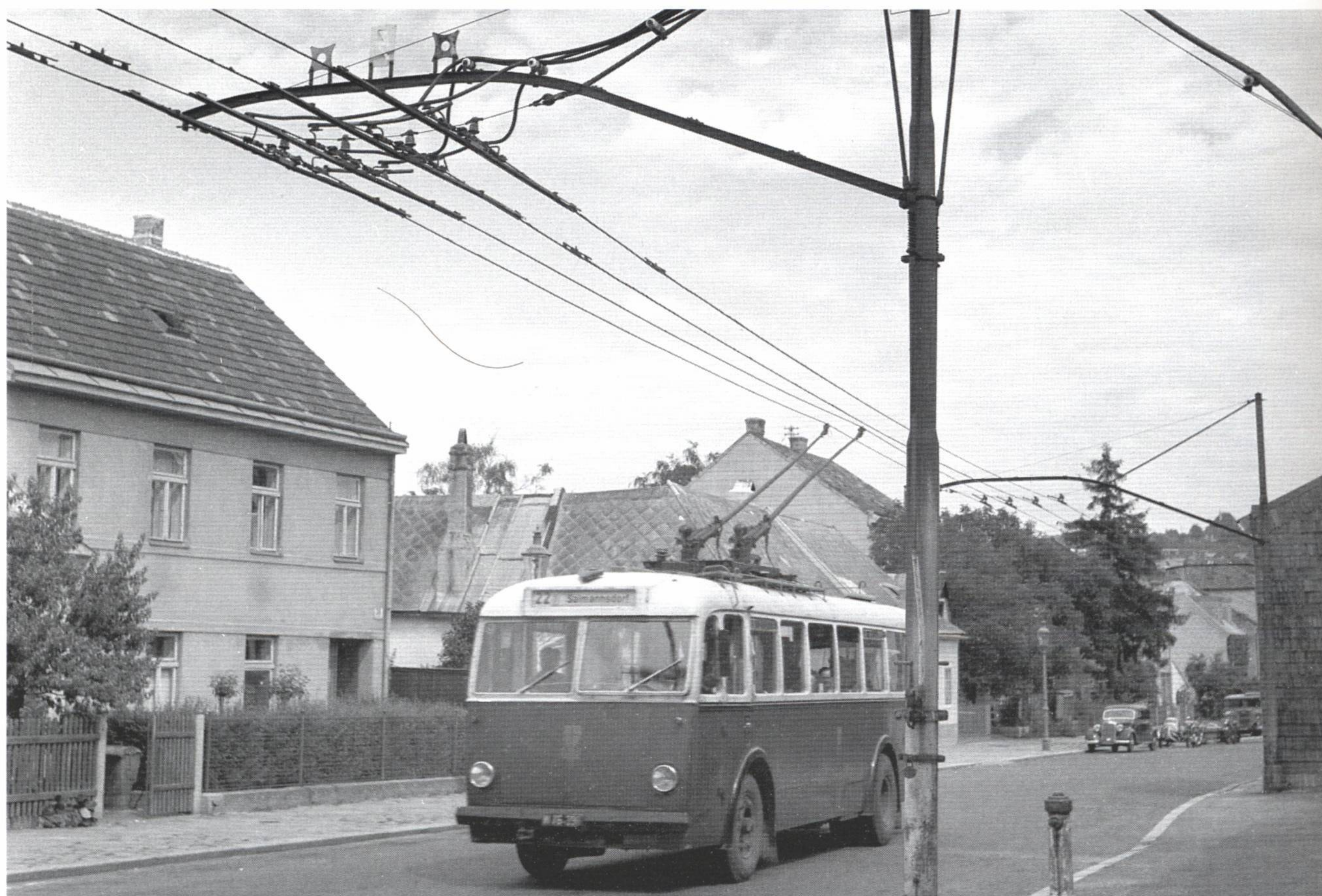
W 76.390 unmittelbar vor dem Speisepunkt in der Krottenbachstraße bei der Obkirchergasse. Die von der Straßenbahn übernommenen Signale (Bogenviereck mit Loch) am Oberleitungs-Ausleger bedeuten: 12 km/h Höchstgeschwindigkeit. Wiener Linien
