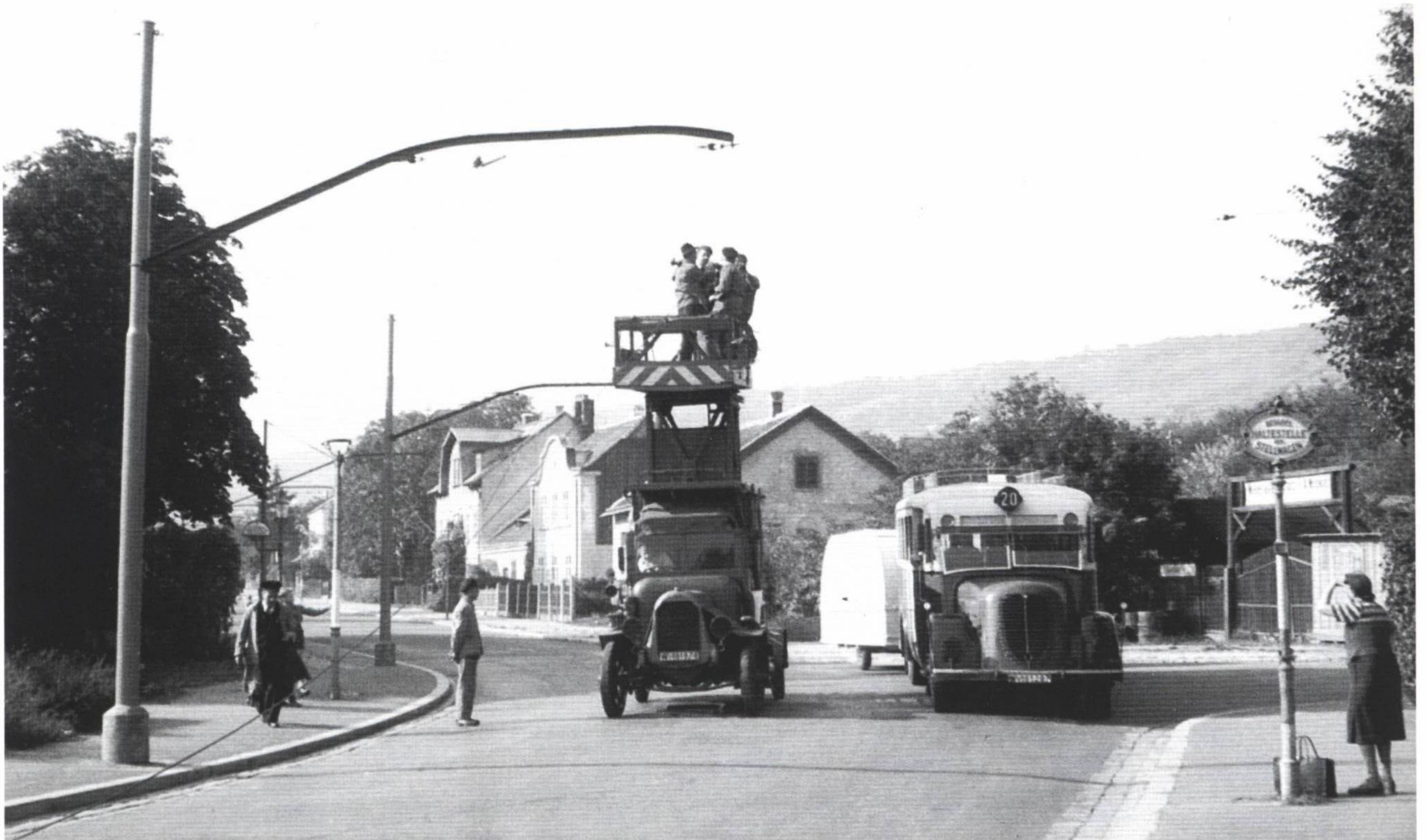
Bau der Obus-Fahrleitung in der Billrothstraße. Ein Austro-Fiat AF-4 D 90 B - Bus mit Gasanhänger fährt am Montagewagen vorbei. Auf der Haltestellentafel steht der Text: Bedarfs-Haltestelle der Stellwagen.
