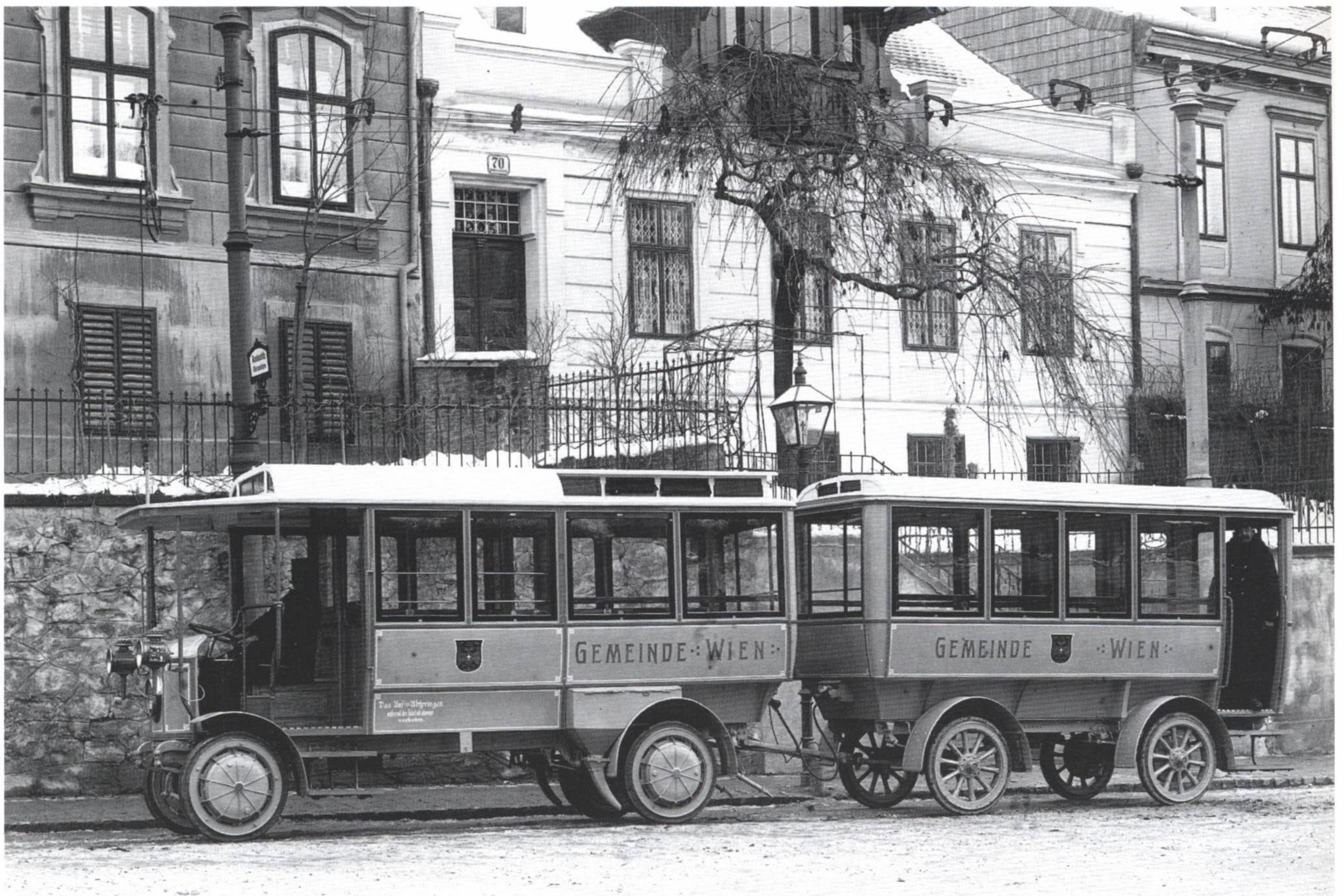
Der viermotorige Versuchs-Motorwagen bei einer seiner wenigen Probefahrten mit dem Anhänger. Wiener Linien
