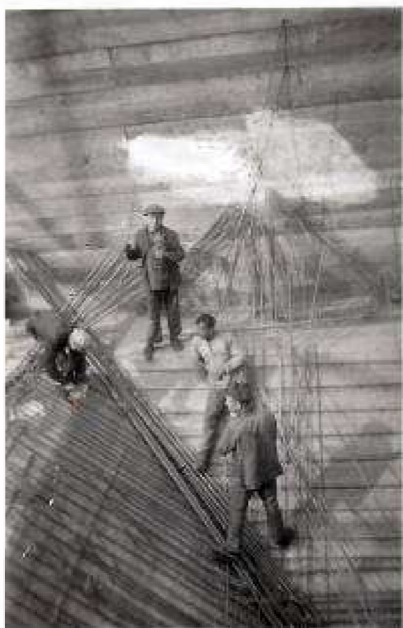
Бетонирование эстакады, предназначенной для заправки паровозов углем
