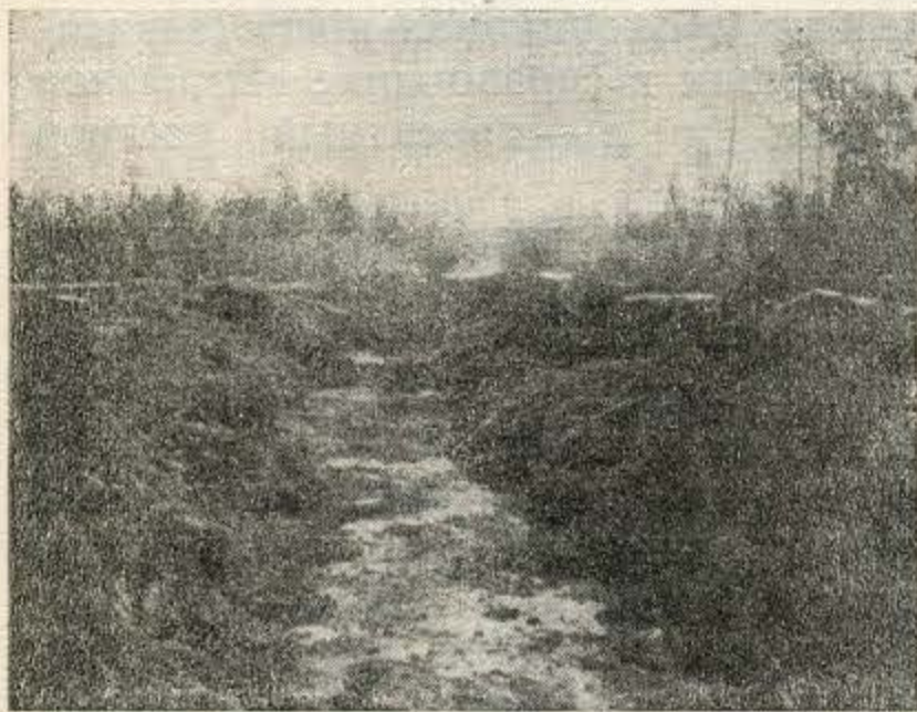
Фиг. 115. Результат взрывов низовой части канавы.
