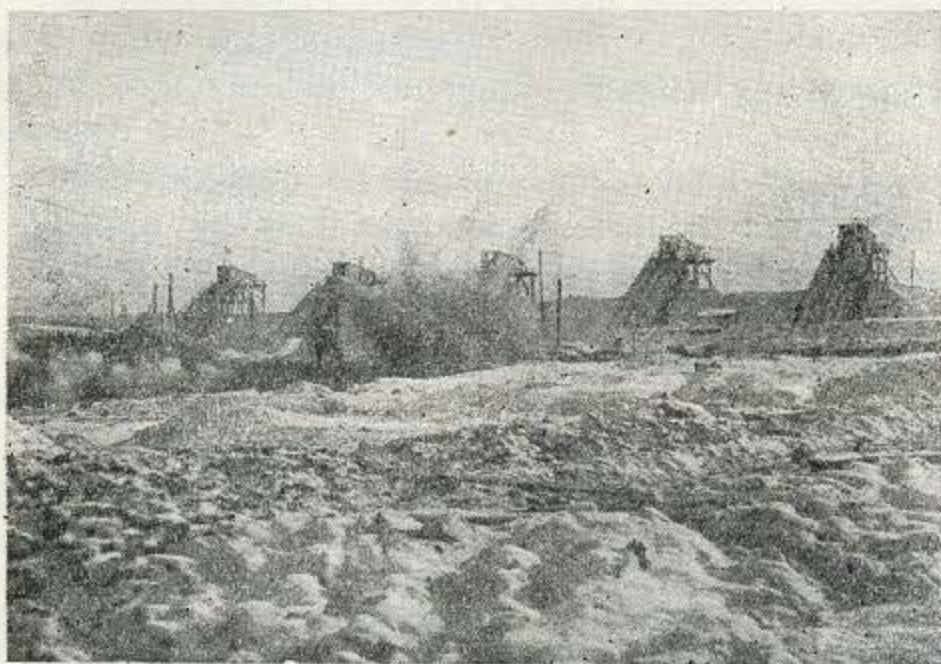
Фиг. 108. Рыхление грунта взрывами (момент взрыва).
