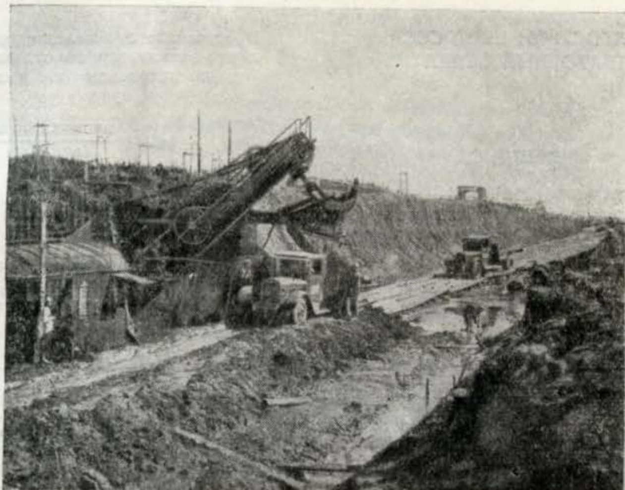
Фиг. 6а. Погрузка грунта экскаватором Ковровец на автомашины.
