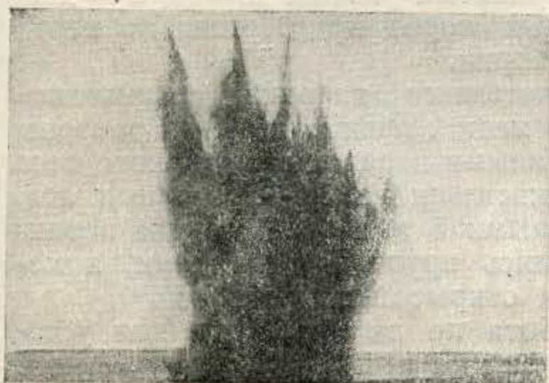
Фиг. 121. Спрявление р. Химки взрывами: а — момент взрыва; б — спрямленный участок реки.
