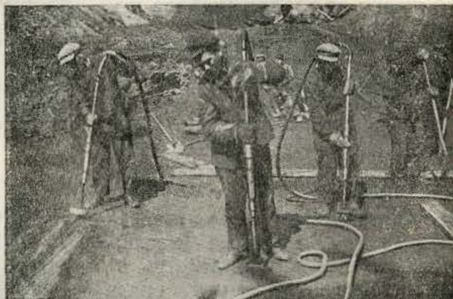
Фиг. 128. Работа пневматическими трамбовками.
