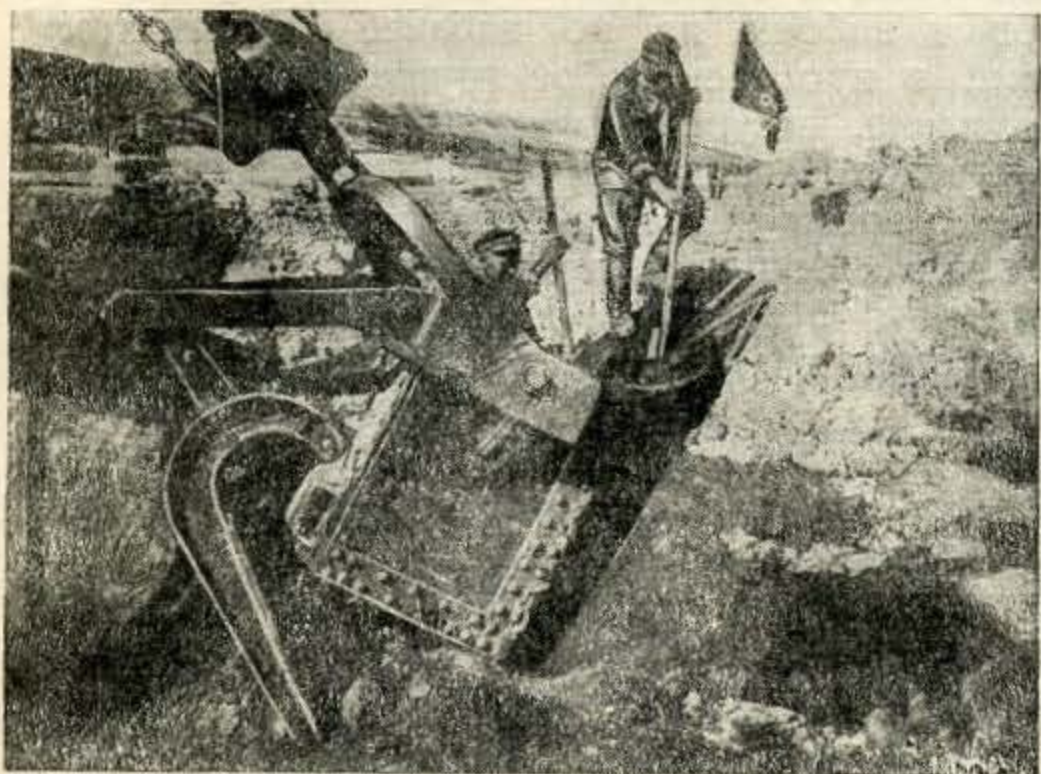
Фиг. 25. Очистка ковша экскаватора от налипшего грунта.
