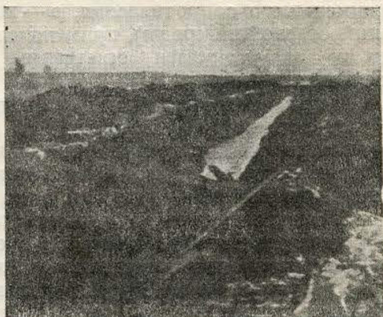
Фиг. 116. Результат взрывов верхового участка канавы.
