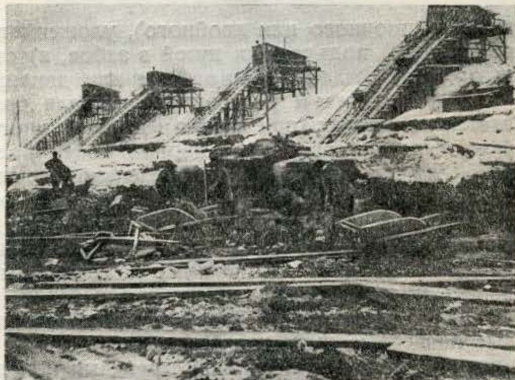
Фиг. 79. Общий вид разработки выемки канала землетасками.
