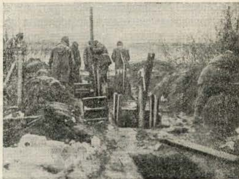
Фиг. 122. Изготовление минных колодцев при взрывах на выброс на р. Клязьме.
