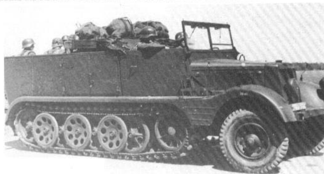
Linke und rechte Seitenansicht der Serienausführung des mittleren Zugkraftwagens 3t (Sd. Kfz. 11). Seitlich im Aufbau waren Munitionsfächer untergebracht, der Einstieg für die Geschützbedienung erfolgte von rückwärts.
