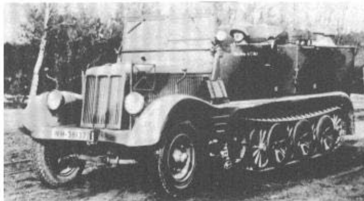
Das Vorserienfahrzeug »HL kl 5« mit dem endgültigen Aussehen des Produktionsmodelles. Es wies jedoch am Laufwerk noch einige Unterschiede auf. So waren die innen liegenden Laufräder noch als Vollräder ausgebildet.
