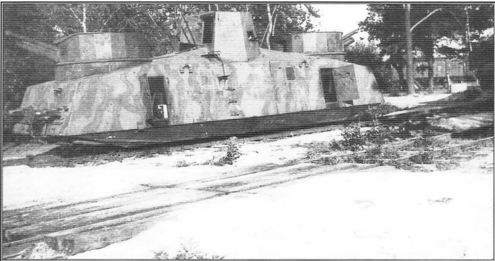
Zdobyty sowiecki wagon motorowy typu D-2 uzbrojony w dwie armaty kalibru wz. 1902 kalibru 76,2 mm. Po remoncie był używany jako Panzertriebswagen 18.
