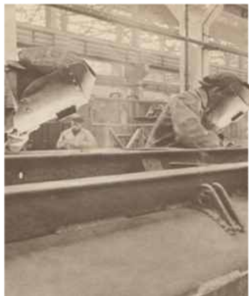
РУЧНАЯ СВАРКА ХРЕБТОВОЙ БАЛКИ ВАГОНА. ЖУРНАЛ «СССР НА СТРОЙКЕ». 1936 Г.
