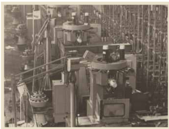
ГИБКАЯ ПРОИЗВОДСТВЕННАЯ СИСТЕМА НА БАЗЕ 9 ОБРАБАТЫВАЮЩИХ ЦЕНТРОВ ДЛЯ ОБРАБОТКИ ТАНКОВЫХ КОРПУСНЫХ ДЕТАЛЕЙ. 1986 Г.
