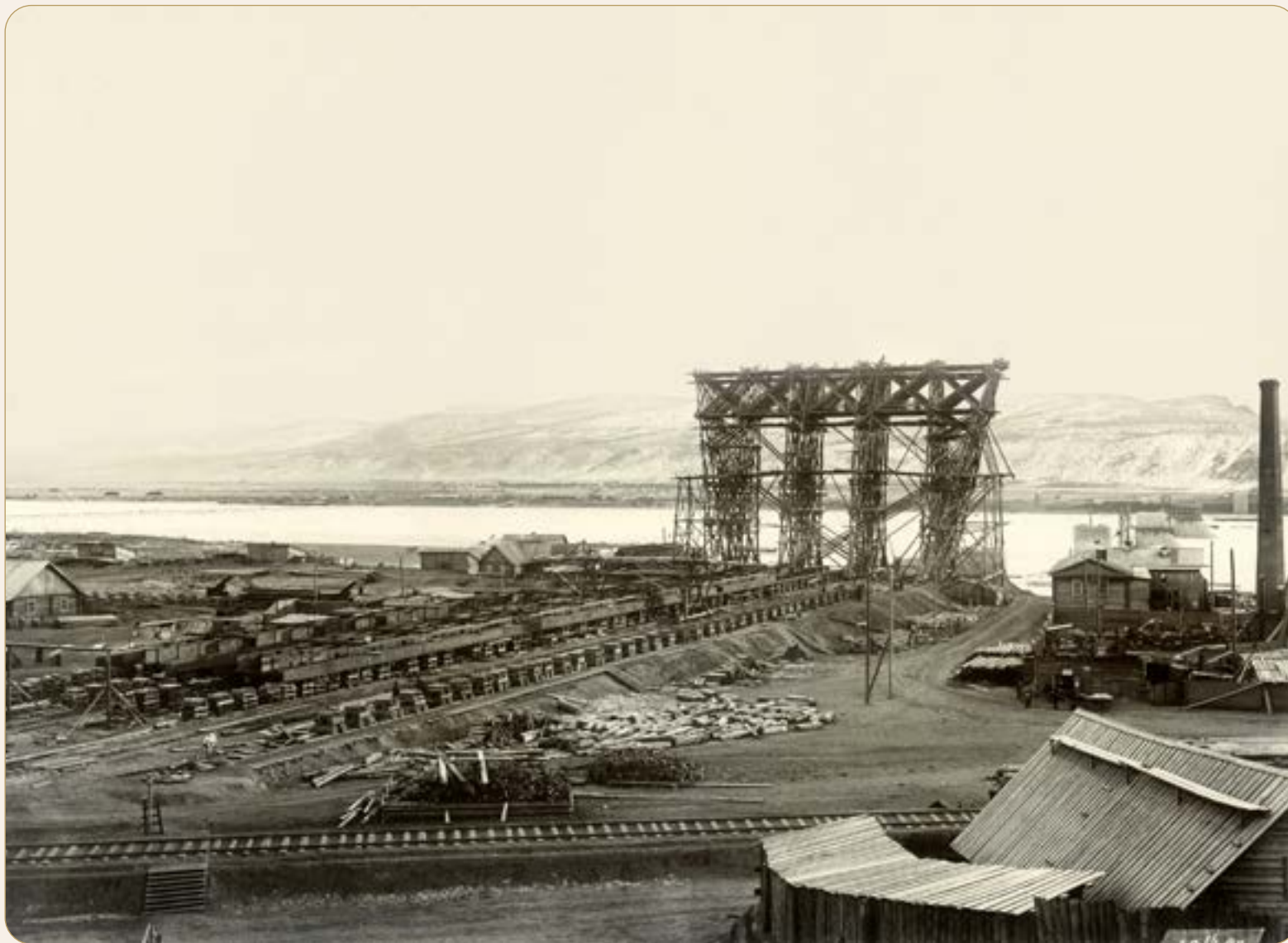
Начало сборки ферм на левом берегу. Кран еще не совсем окончен. 16 ноября 1897 г. (из фондов Красноярского краевого краеведческого музея)
