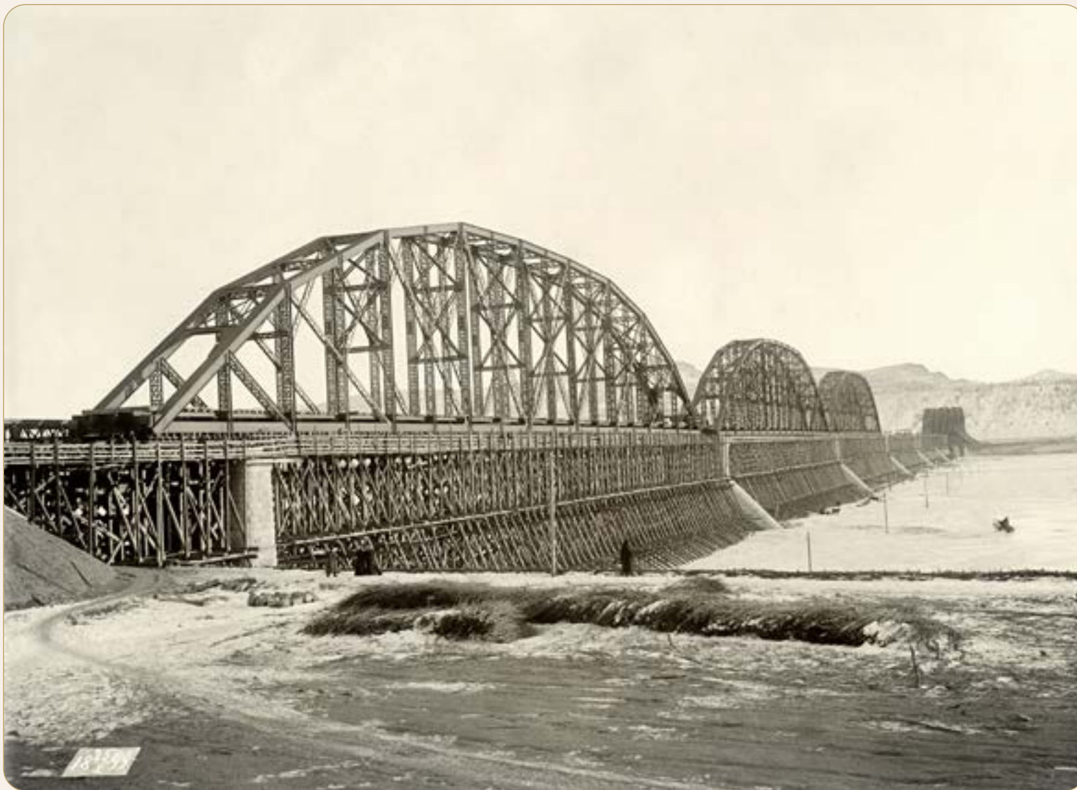
Перекатка с левого берега фермы 1-го пролета. Ферма доходит до места. 25 января 1899 г. (из фондов Красноярского краевого краеведческого музея)
