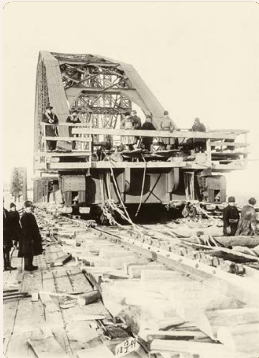
Перекатка фермы 2-го пролета с левого берега. 20 января 1899 г. (из фондов Красноярского краевого краеведческого музея)
