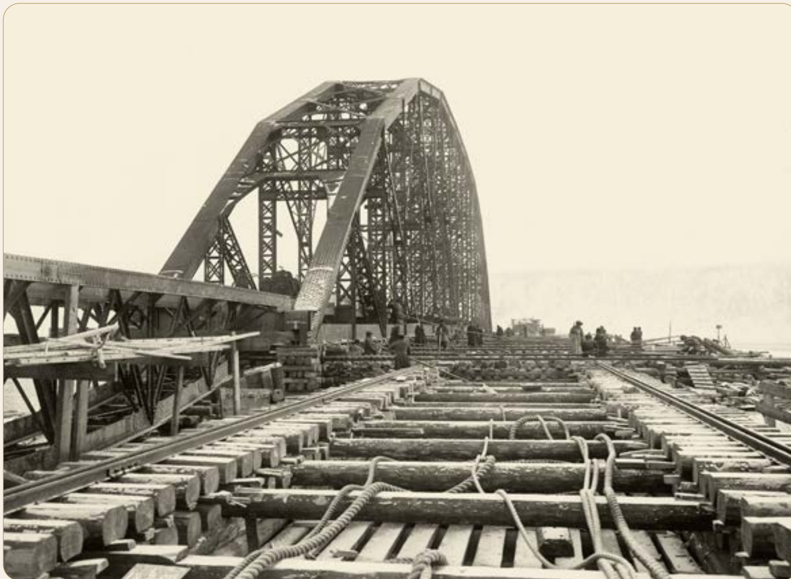
Боковая перекатка на правом берегу фермы 6-го и последнего пролета. 6 февраля 1899 г. (из фондов Красноярского краевого краеведческого музея)
