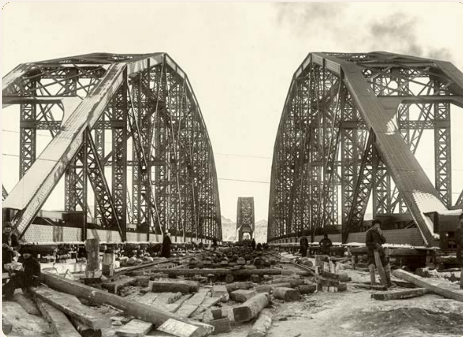
Сборка ферм на левом берегу. 13 января 1898 г. (из фондов Красноярского краевого краеведческого музея)
