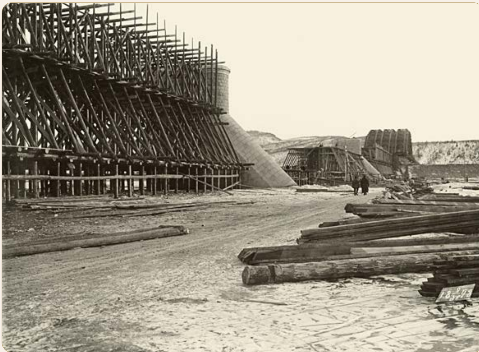
Устройство подмостей перекатки ферм (с середины реки на правый берег). 8 декабря 1898 г. (из фондов Красноярского краевого краеведческого музея)
