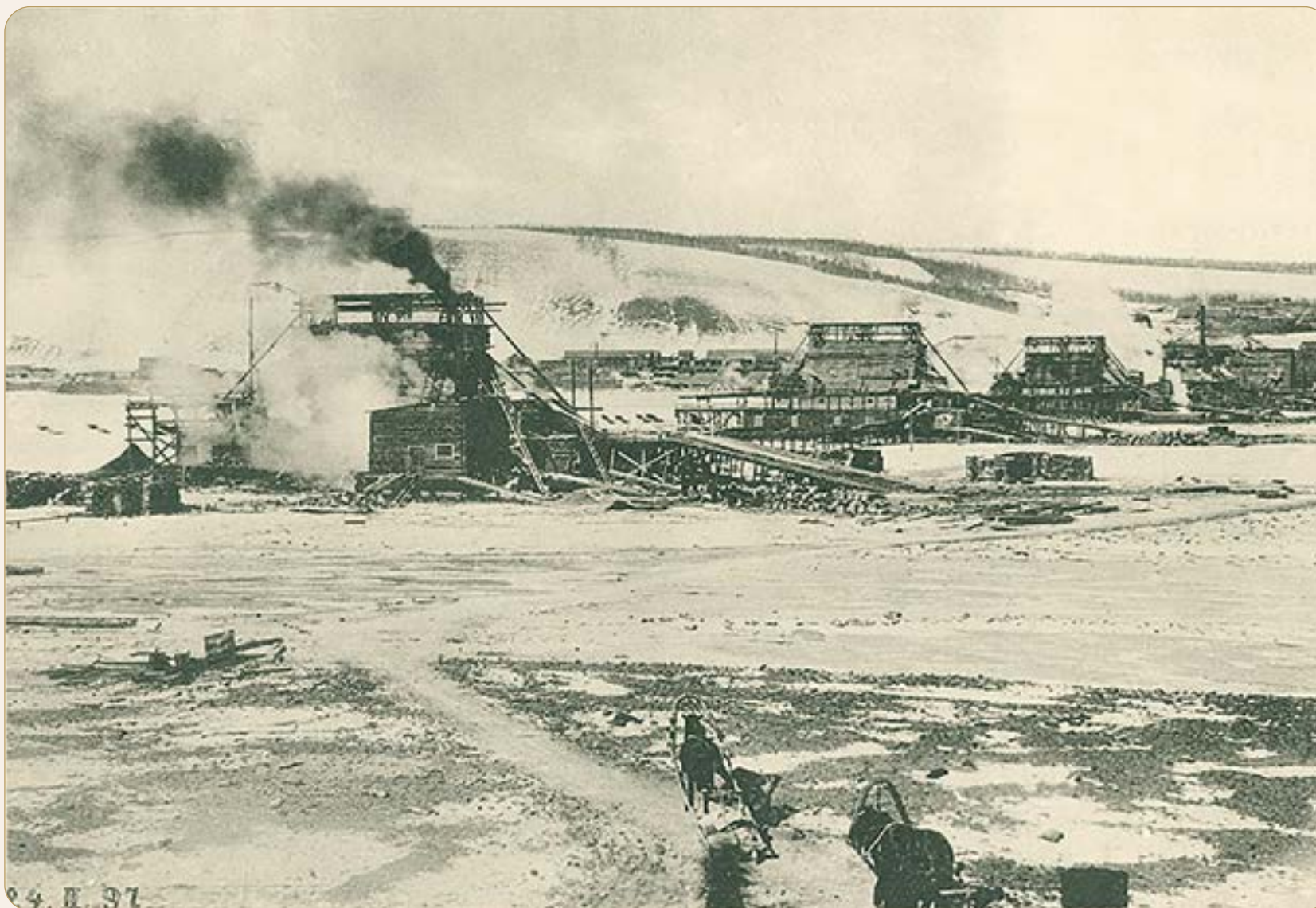
Общий вид зимних работ на реке с правого берега. Одновременное погружение кессонов на всех речных опорах в тепляках. 24 февраля 1897 г. (из личного архива А. Ю. Южанникова)
