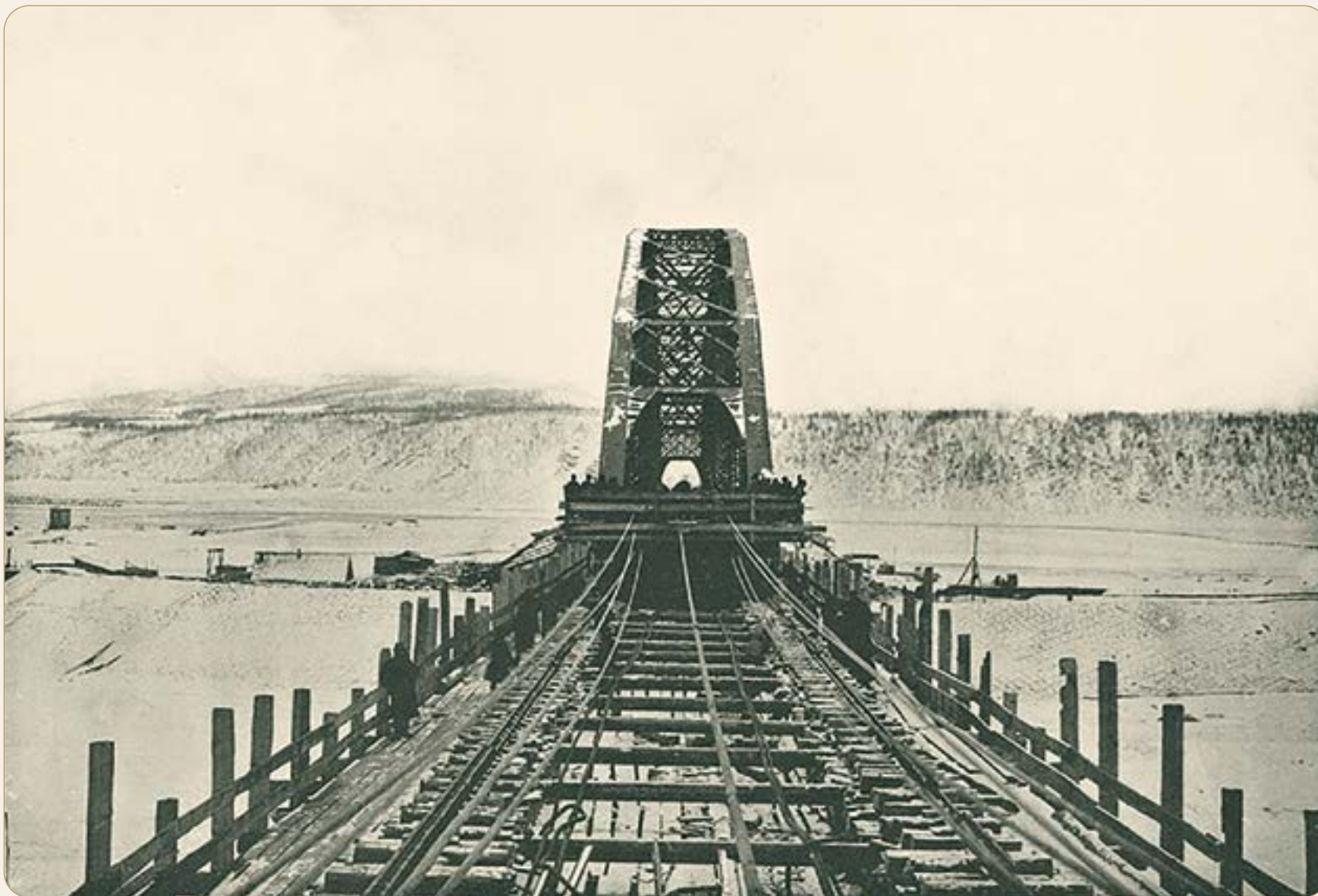
Вид перекатываемого по подмостям последнего пролета из трех собранных на правом берегу. На самом пролете установлены пять лебедок, которые с помощью канатов и людей подвигают пролет со скоростью 35 саж. в час. 8 февраля 1899 г. (из личного архива А. Ю. Южанникова)
