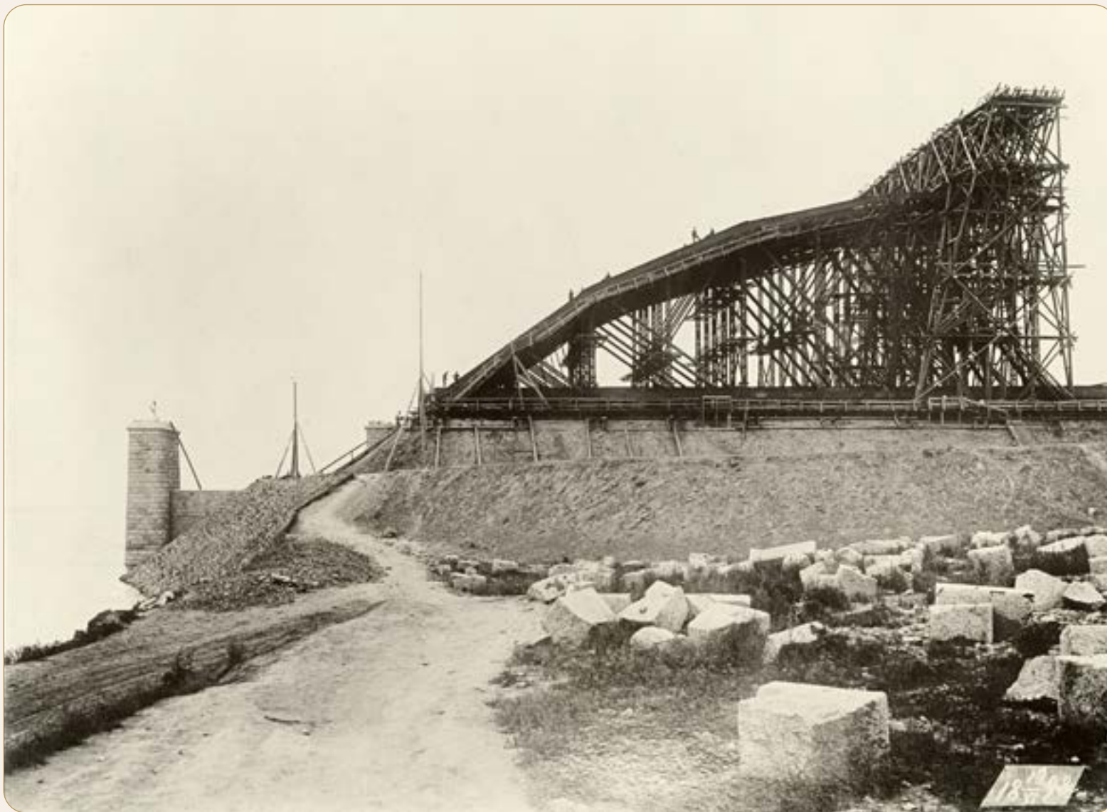
Сборка ферм на правом берегу. 19 июня 1898 г. (из фондов Красноярского краевого краеведческого музея)
