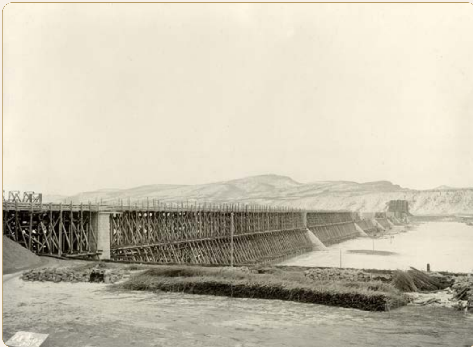
Устройство подмостей перекатки ферм. 8 декабря 1898 г. (из фондов Красноярского краевого краеведческого музея)
