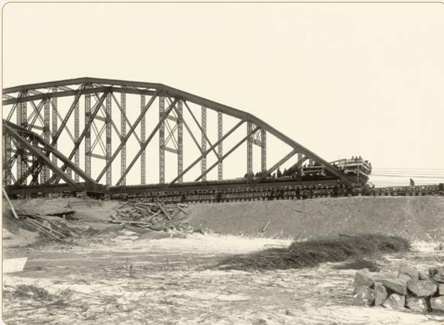
Перекатка с левого берега фермы 2-го пролета. 20 января 1899 г. (из фондов Красноярского краевого краеведческого музея)
