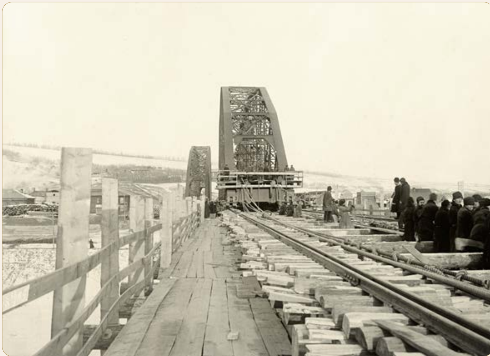
Перекатка ферм 3-го пролета с левого берега. Вид пути, по которому движется ферма. 13 января 1899 г. (из фондов Красноярского краевого краеведческого музея)
