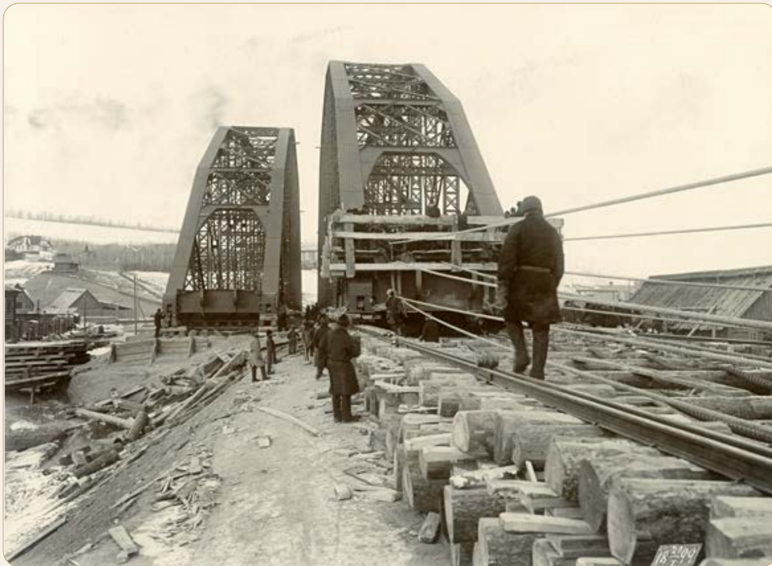
Перекатка фермы 2-го пролета с левого берега (во время движения). 20 января 1899 г. (из фондов Красноярского краевого краеведческого музея)
