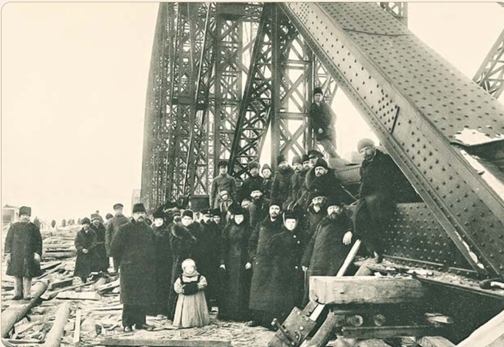
Окончание поперечной перекатки последнего пролета на левом берегу. 23 января 1899 г.
