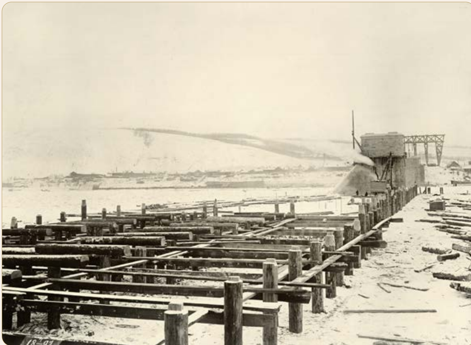
Забивка свай для подмостей перекачки ферм у быка № 3. 7 декабря 1897 г. (из фондов Красноярского краевого краеведческого музея)
