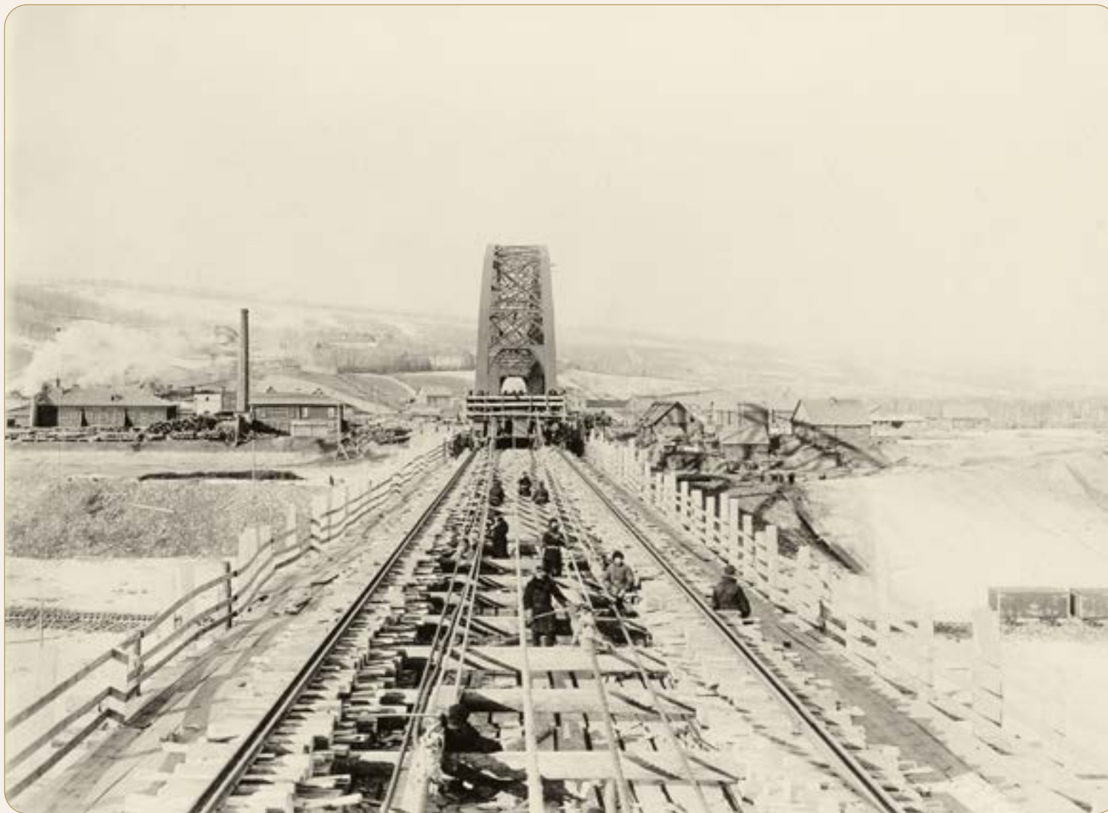
Перекавка фермы 1-го пролета с левого берега (вид с фермы 2-го пролета). 25 января 1899 г. (из фондов Красноярского краевого краеведческого музея)
