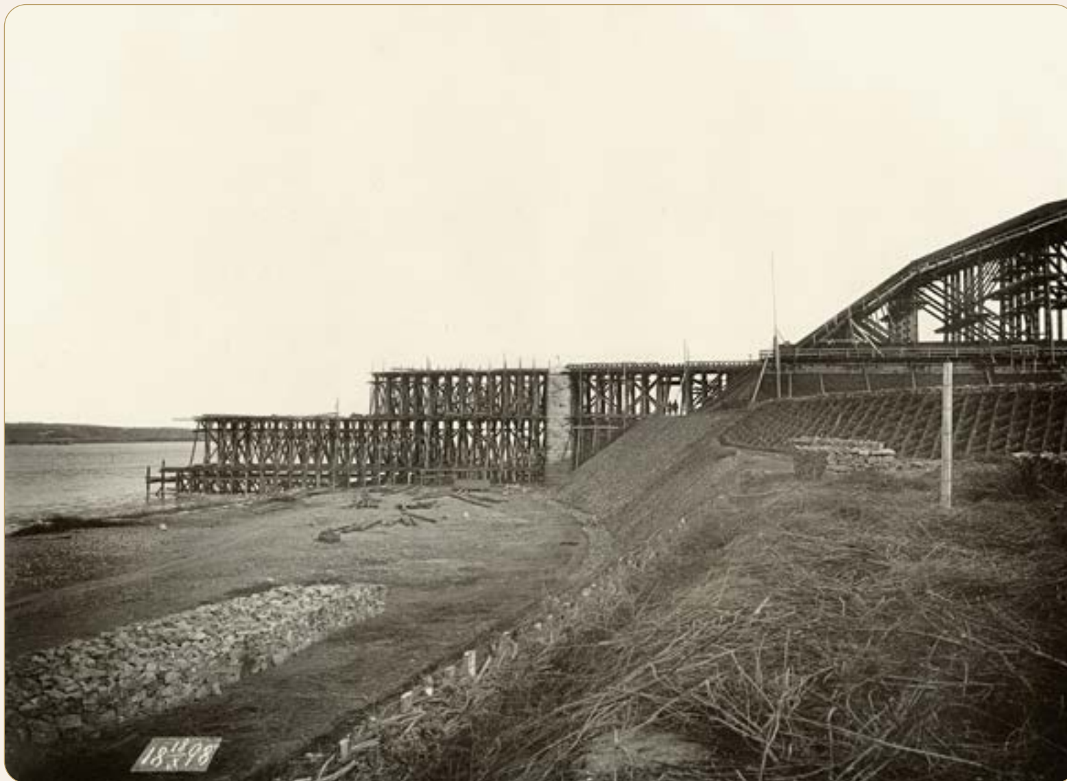
Устройство подмостей перекатки ферм у правого берега. 18 октября 1898 г. (из фондов Красноярского краевого краеведческого музея)
