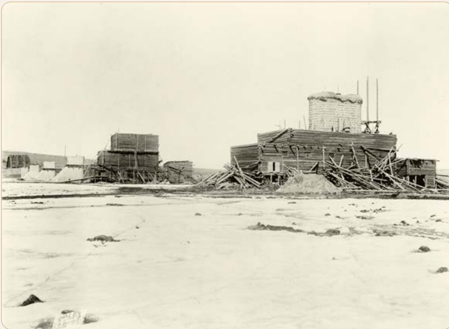
Начало разборки тепляка на быке № 5. 29 марта 1898 г. (из фондов Красноярского краевого краеведческого музея)
