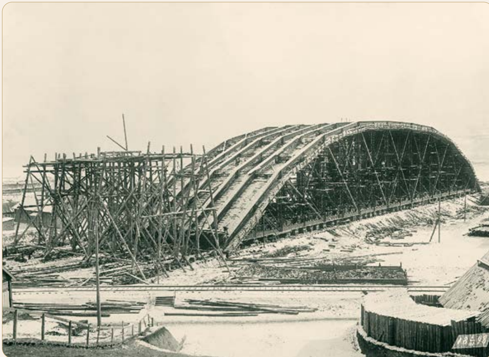
Окончание сборки ферм на левом берегу и разборка крана. 1 марта 1898 г. (из фондов Красноярского краевого краеведческого музея)
