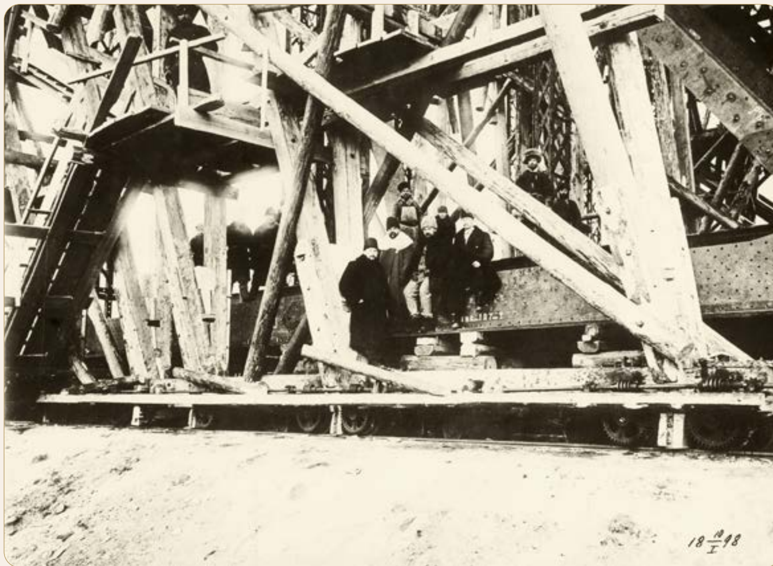
Нижняя часть крана для сборки ферм. 10 января 1898 г. (из фондов Красноярского краевого краеведческого музея)
