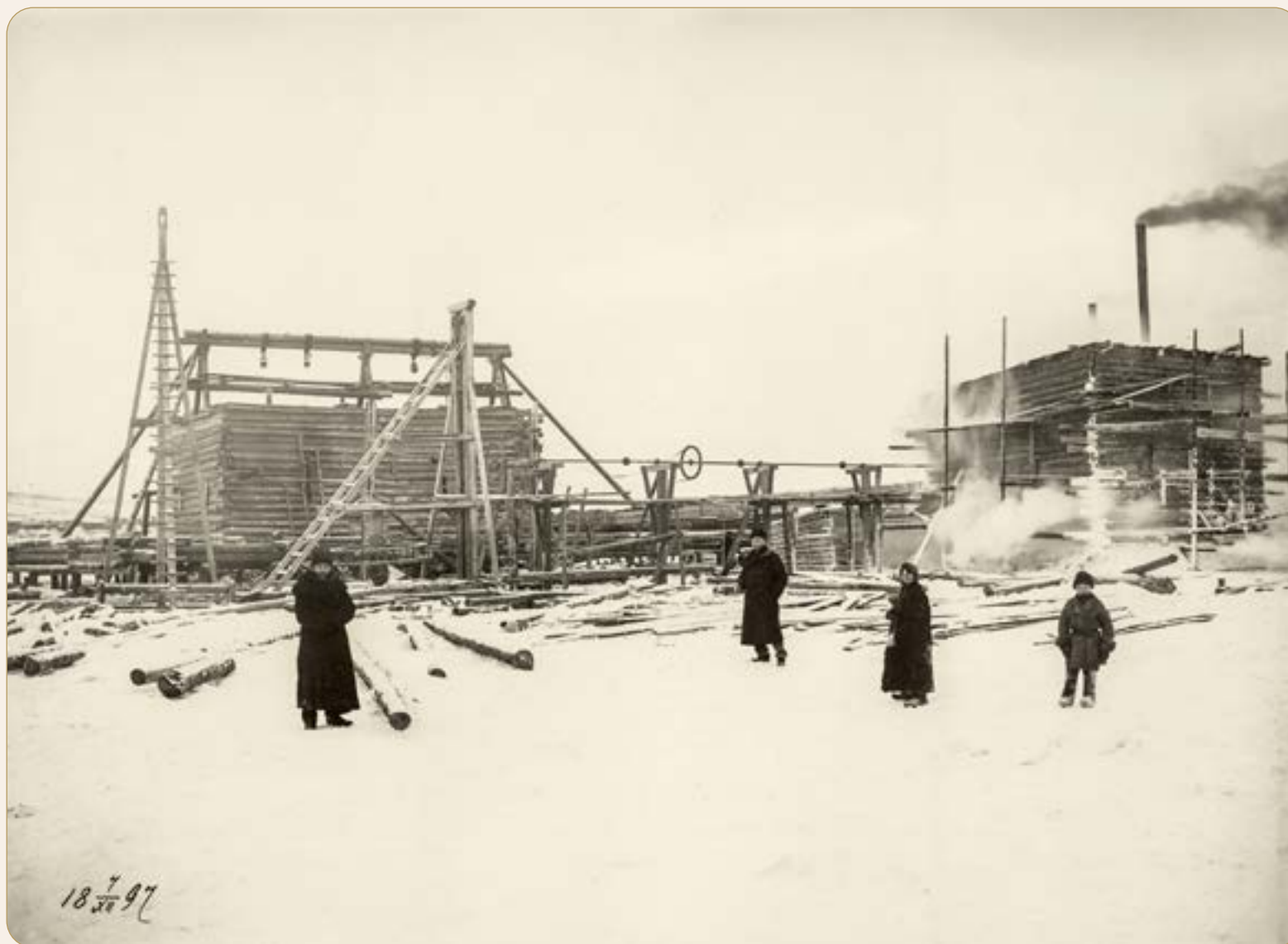
Выемка грунта от кессона быка № 4 (вид с правого берега). 4 декабря 1897 г. (из фондов Красноярского краевого краеведческого музея)
