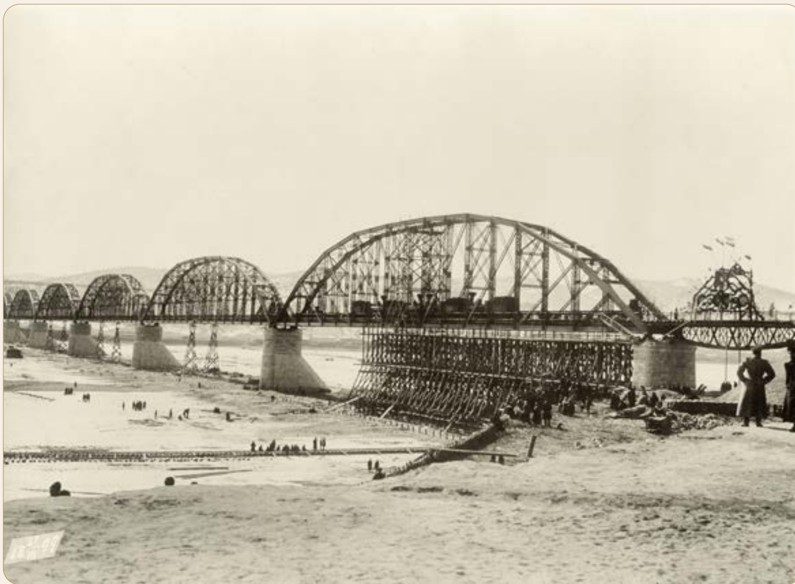
Испытание моста. Паровозы на 3-м и 4-м пролетах. Путь, проложенный по льду реки. 27 марта 1899 г. (из фондов Красноярского краевого краеведческого музея)
