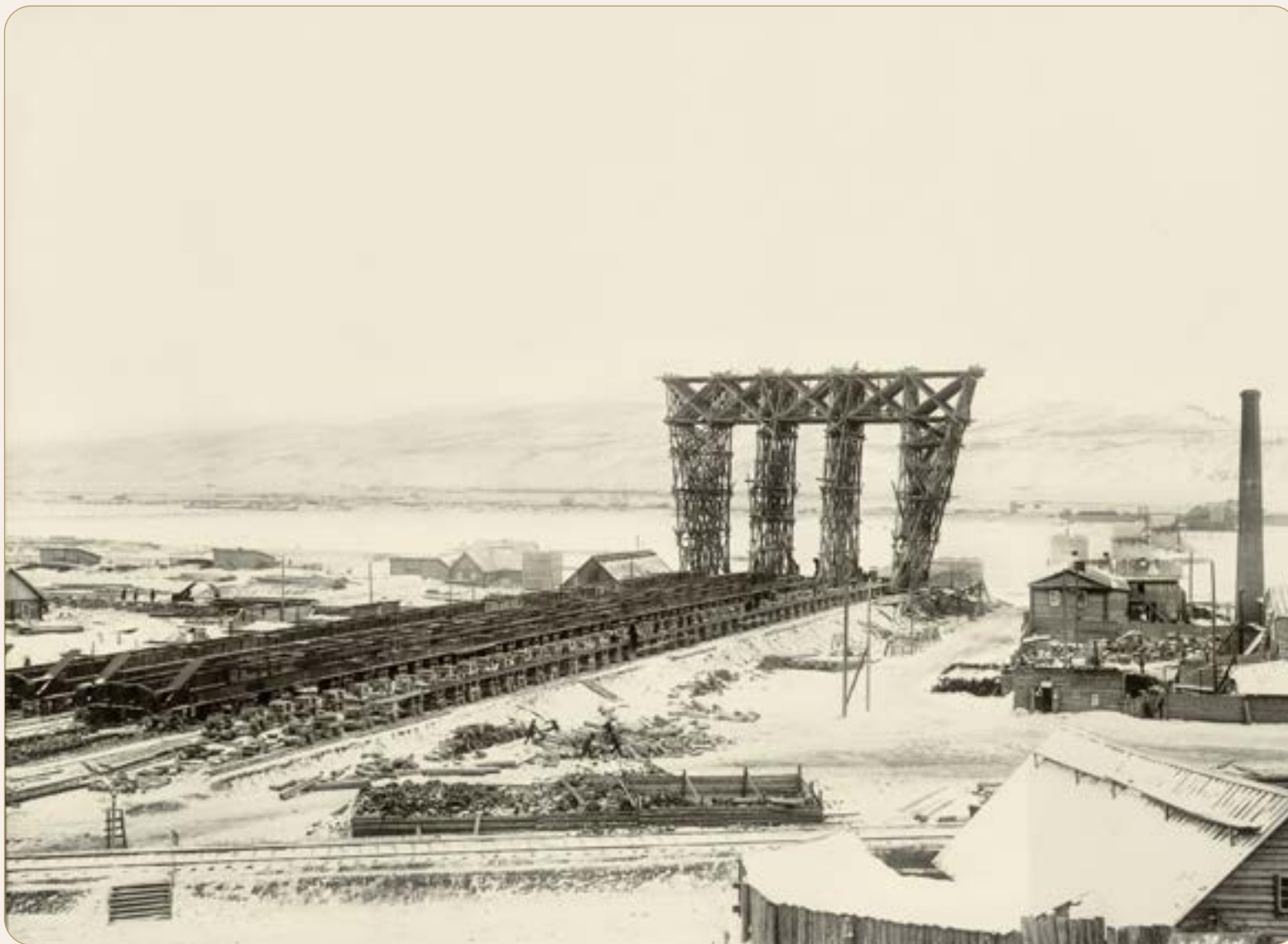
Сбор проезжих частей ферм на левом берегу Енисея. 30 ноября 1897 г. (из фондов Красноярского краевого краеведческого музея)
