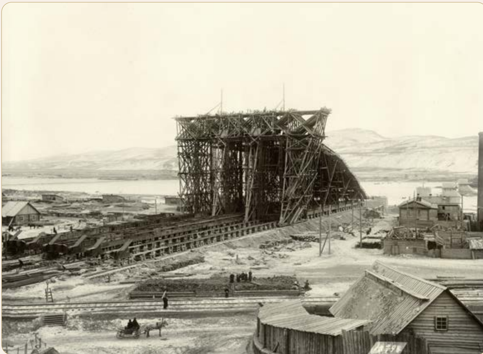
Сборка ферм на левом берегу. 11 февраля 1898 г. (из фондов Красноярского краевого краеведческого музея)
