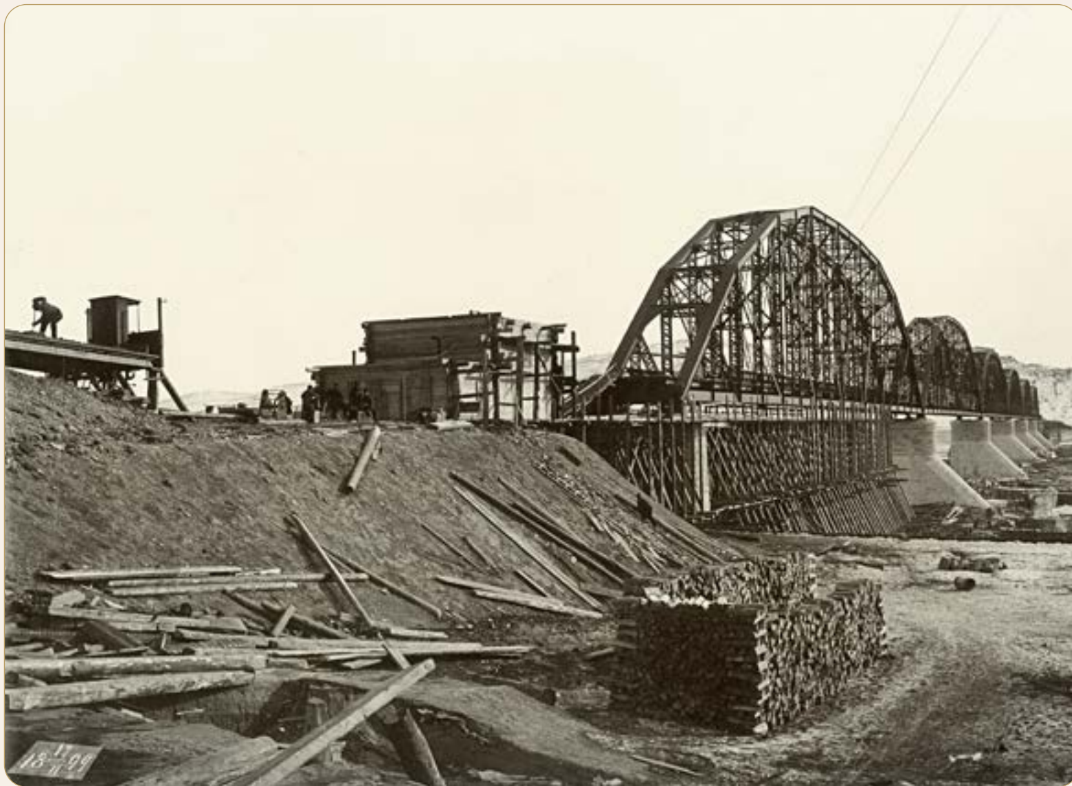
Тепляк для зимней кладки опорной стенки. 17 февраля 1899 г. (из фондов Красноярского краевого краеведческого музея)
