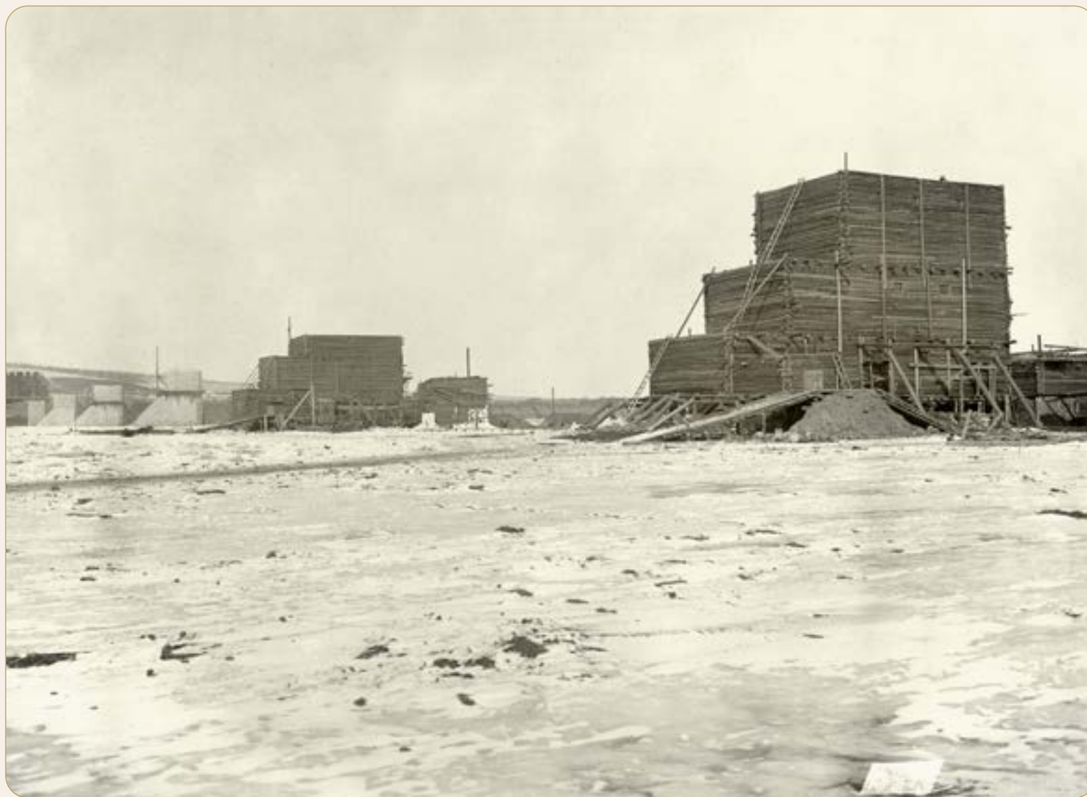
Тепляки для зимней кладки быков № 4 и 5. 1 марта 1898 г. (из фондов Красноярского краевого краеведческого музея)
