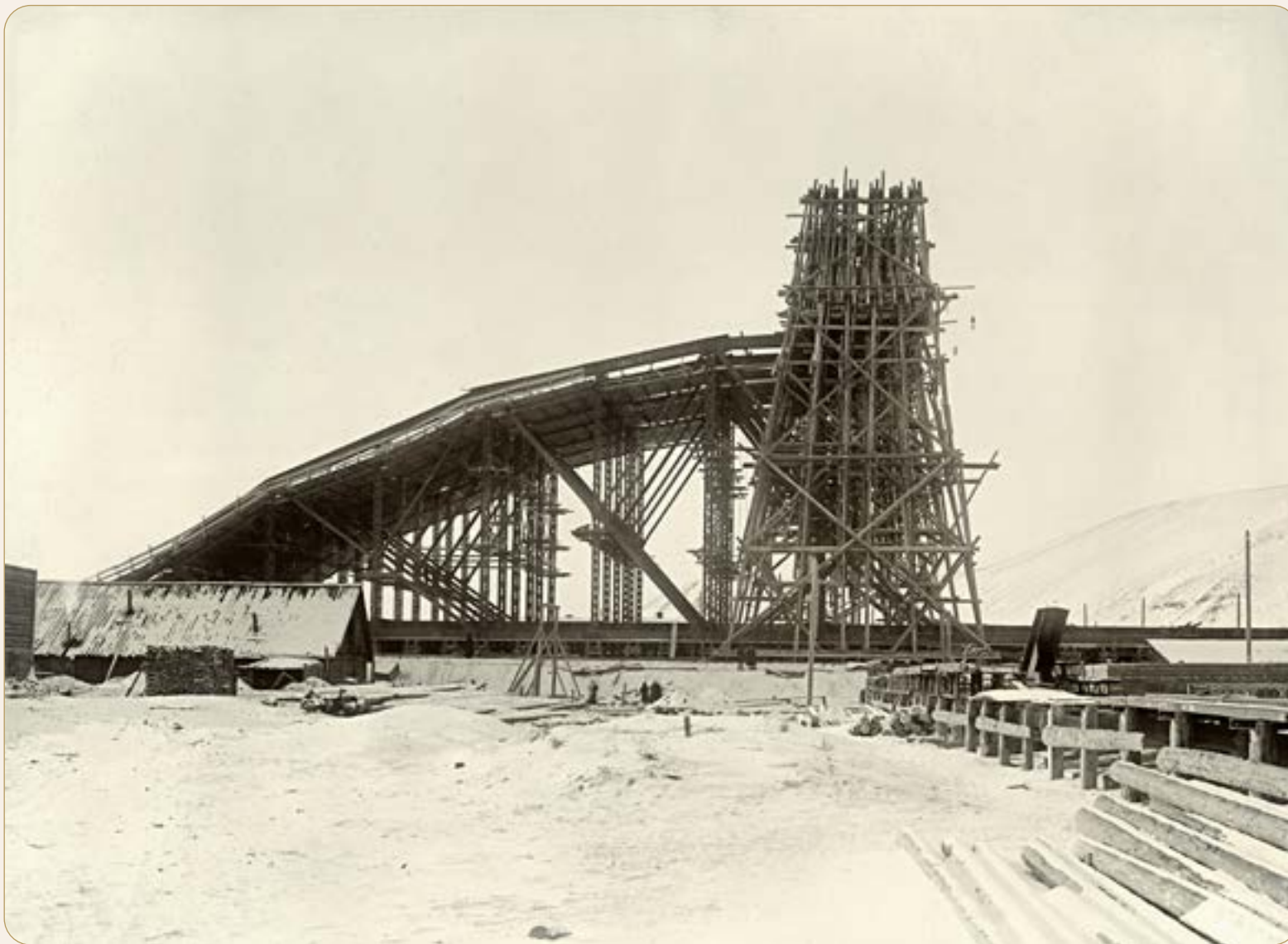
Тыл фермы 3-го пролета при перекатке с левого берега на место. 13 января 1899 г. (из фондов Красноярского краевого краеведческого музея)
