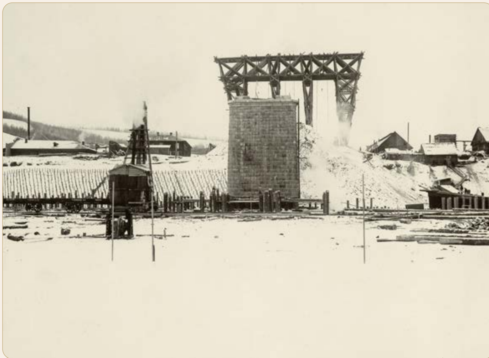
Начало свайной бойки для перекатки ферм у левого берега. 7 декабря 1897 г. (из фондов Красноярского краевого краеведческого музея)
