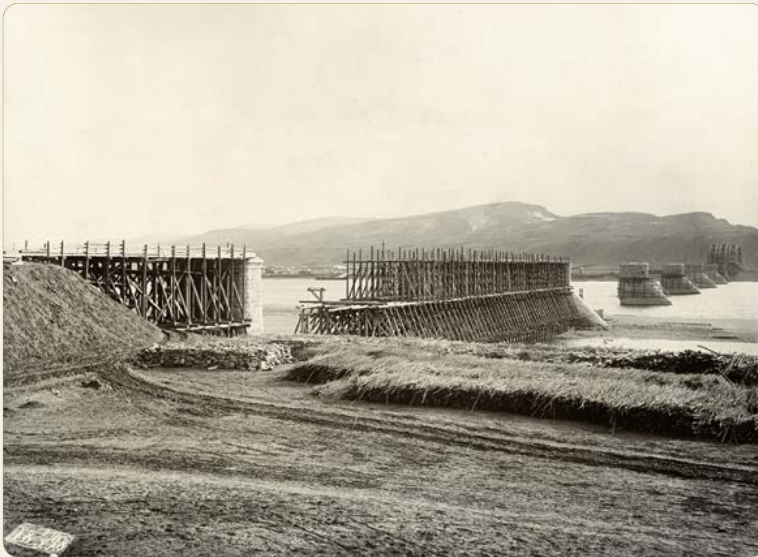
Устройство подмостей перекатки ферм. 1 октября 1898 г. (из фондов Красноярского краевого краеведческого музея)
