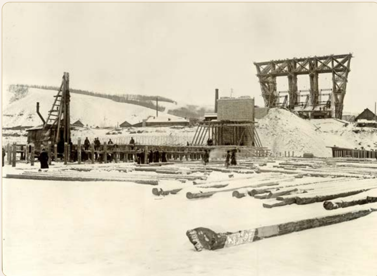
Начало устройства подмостей перекатки ферм у левого берега. 14 декабря 1897 г. (из фондов Красноярского краевого краеведческого музея)
