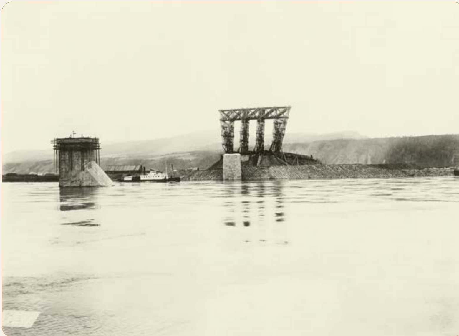
Окончание сборки крана на правом берегу и рештование быка № 5 для расшивки швов. 3 июня 1898 г.
