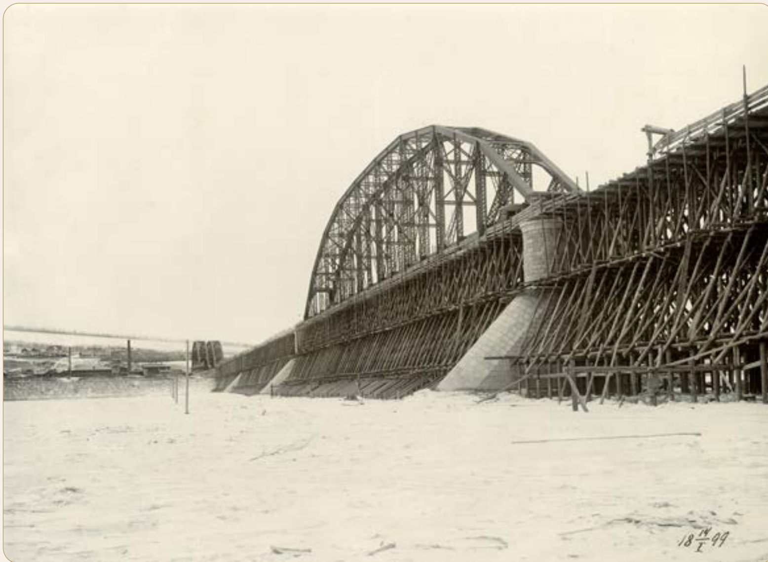
Ферма 3-го пролета поставлена на место, перекатана с левого берега. 14 января 1899 г. (из фондов Красноярского краевого краеведческого музея)
