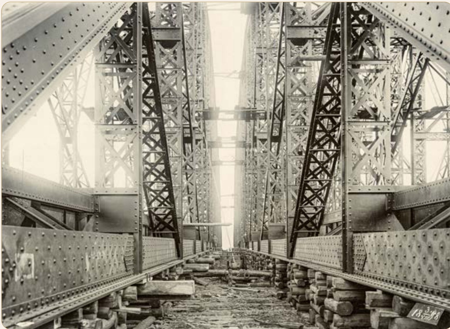
Внутри между ферм, по снятии верхних подмостей. 3 августа 1898 г. (из фондов Красноярского краевого краеведческого музея)
