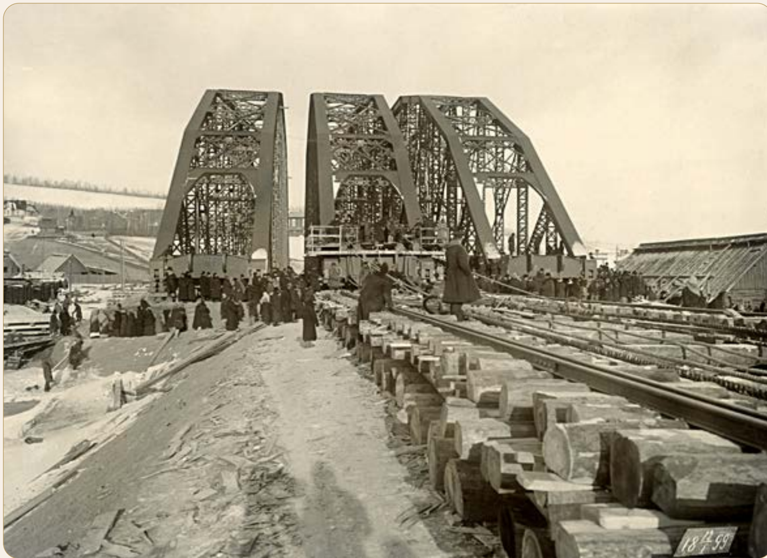
Фермы на левом берегу перед началом перекачки. 12 января 1899 г. (из фондов Красноярского краевого краеведческого музея)
