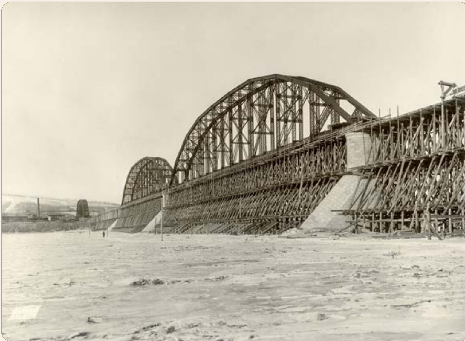
Перекатка ферм с левого берега. Фермы 2-го и 3-го пролетов на месте. 21 января 1899 г. (из фондов Красноярского краевого краеведческого музея)
