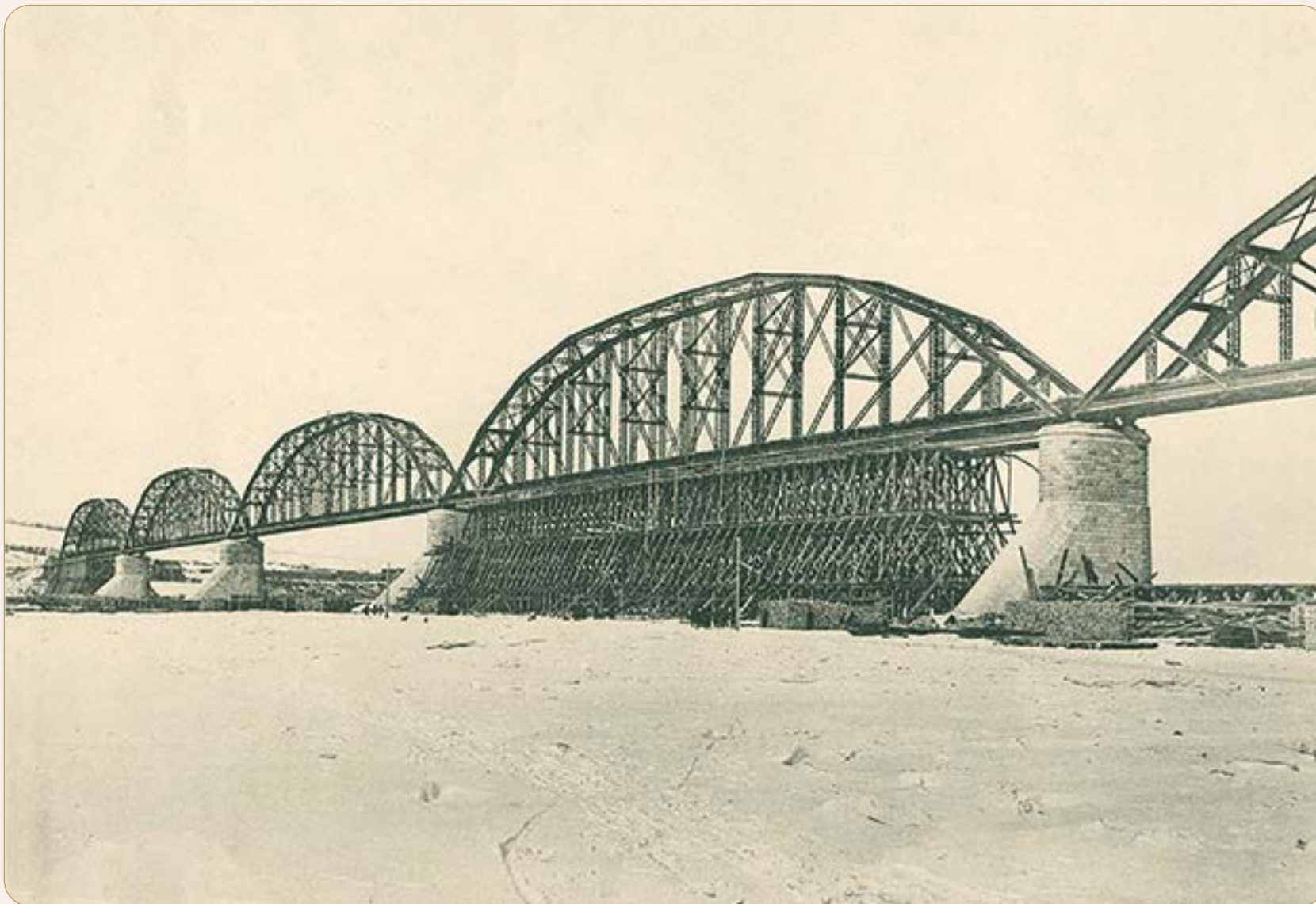
Приготовление к скорейшей разборке подмостей на 4-м пролете посредством роняния их. 14 февраля 1899 г.
