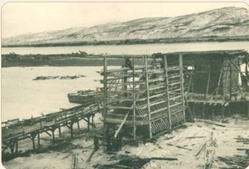
Сборка деревянного кессона левого устоя. Декабрь 1896 г. (из личного архива А. Ю. Южанникова)
