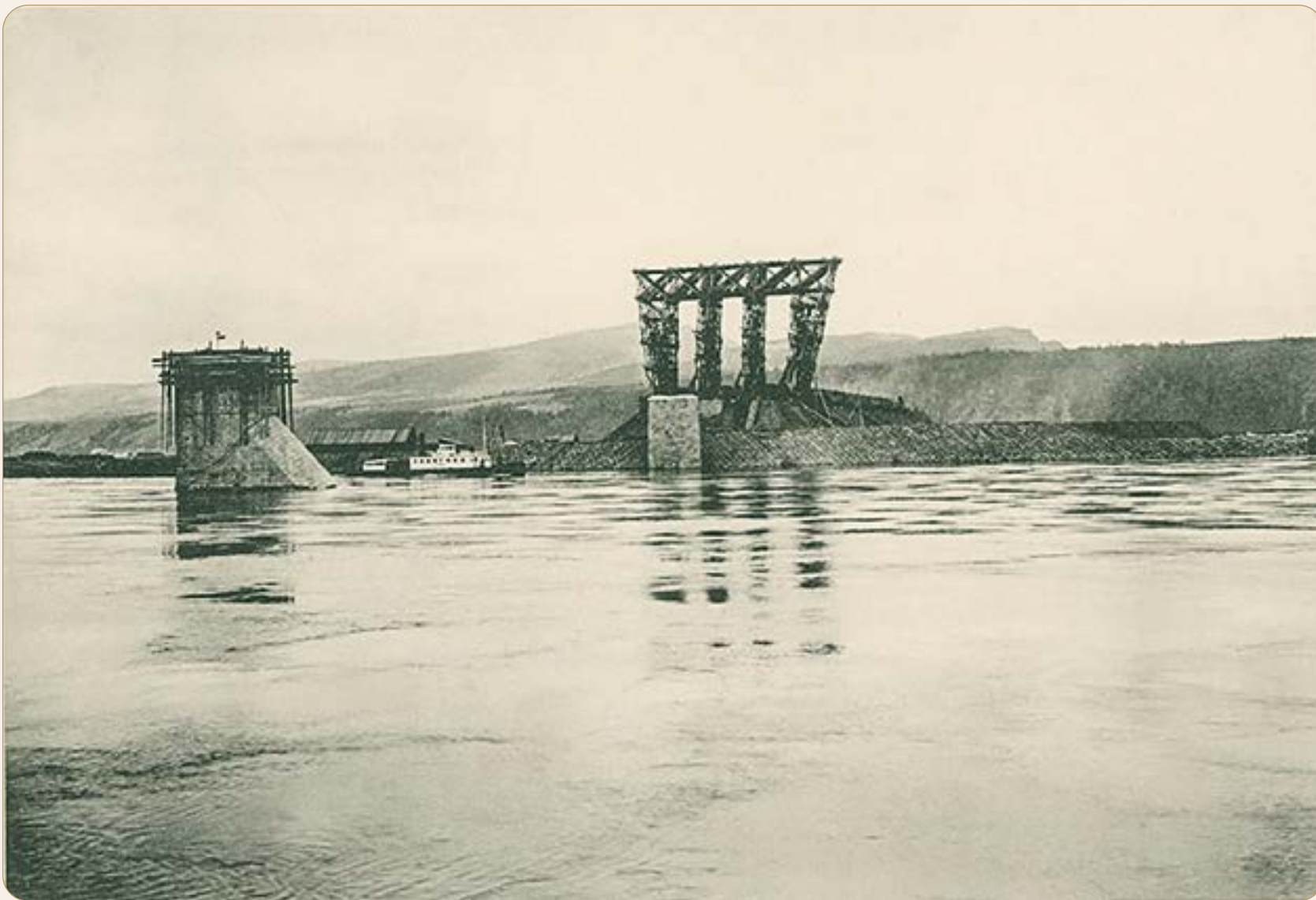
Вид собранного деревянного крана на правом берегу, на высокой насыпи для одновременной сборки трех пролетов. 7 июня 1898 г. (из личного архива А. Ю. Южанникова)
