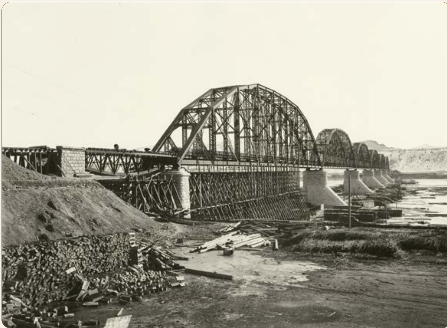
Опорная стенка кончена, тепляк снят, маленькая фермочка на месте. 10 марта 1899 г. (из фондов Красноярского краевого краеведческого музея)
