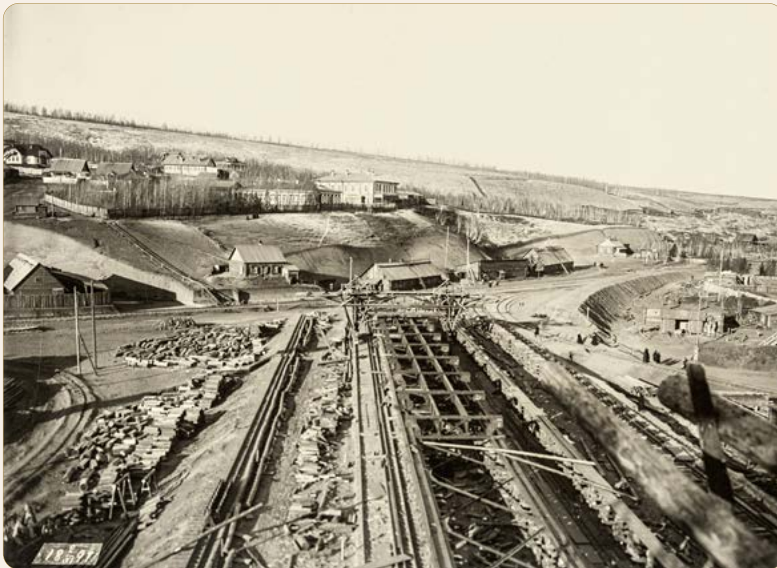
Начало сборки средней (проезжей части) с верхних подмостей крана. 2 ноября 1897 г. (из фондов Красноярского краевого краеведческого музея)
