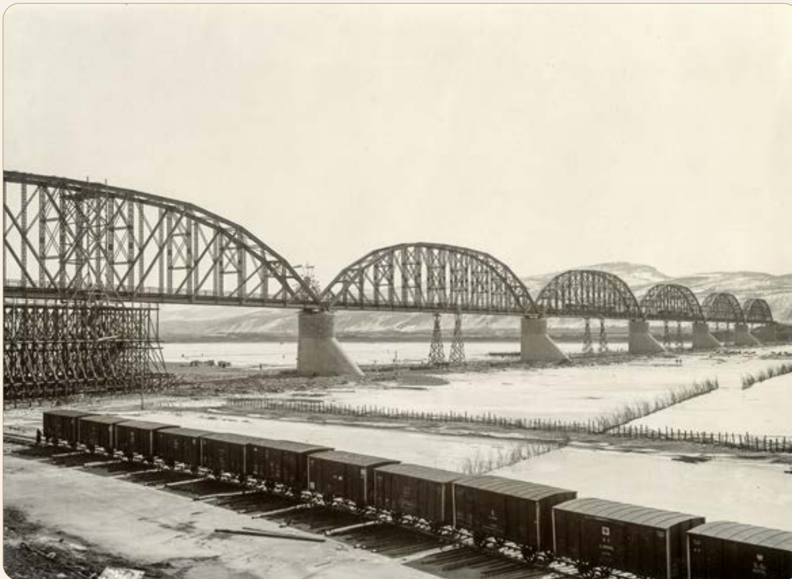
Испытание моста. 27 марта 1899 г. (из фондов Красноярского краевого краеведческого музея)
