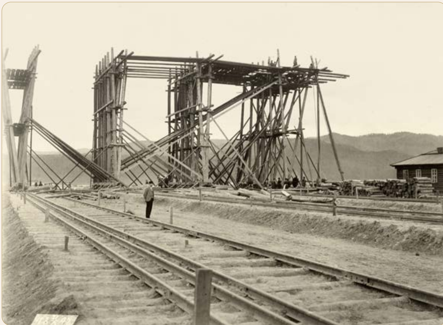
Начало постройки крана для сборки фермы. 21 сентября 1897 г. (из фондов Красноярского краевого краеведческого музея)
