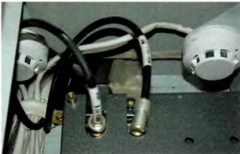
Рис. 12.3. Установка пожарных дымовых извещателей ИП1212 «Фрегат»
