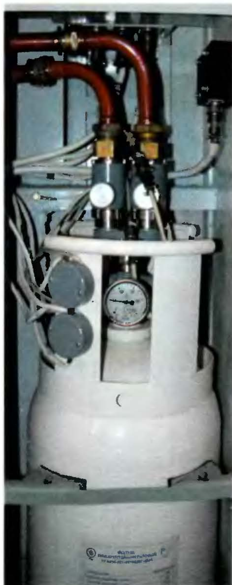
Рис. 12.2. РА-1. Модуль пожаротушения газовый в шкафу СОПБ
