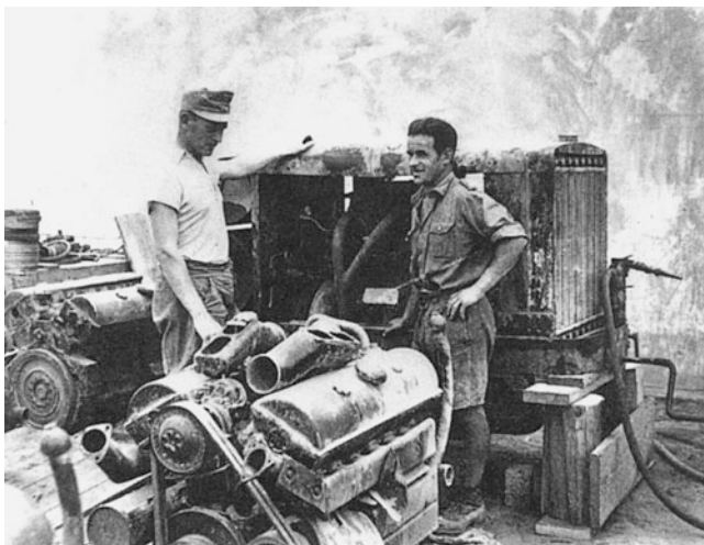
Abb. 11.28 Auch beim Afrikakorps wurden die Motoren im Feld unter primitivsten Voraussetzungen instand gesetzt. Im Vordergrund ein HL-120-Panzermotor
