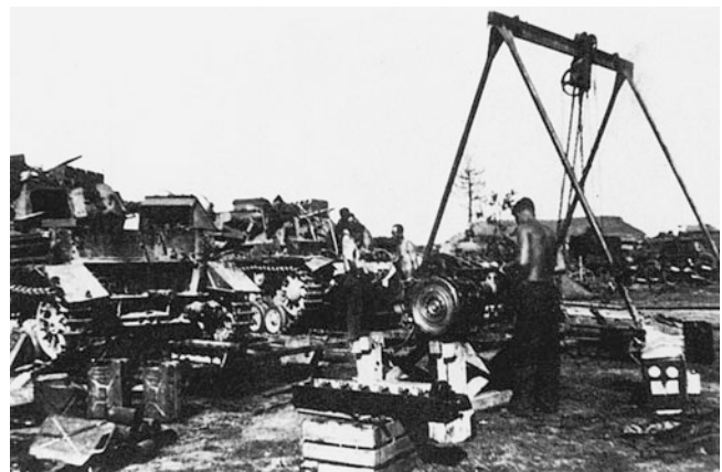
Abb. 20.15 Motorenreparatur in Russland. Schäden im Gefecht und Verschleiß an den Panzermotoren mussten bei der stets angespannten Versorgungslage der Front schnellstens repariert werden. Motoren und Getriebe wurden mit Gestell und Flaschenzug ausgebaut
