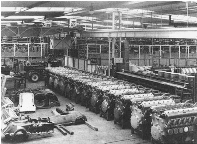
Abb. 10.12 GO-5-Motoren für Schnelltriebwagen vor dem Versand, um 1935. Karl Maybach und sein Mitarbeiter Dipl.-Ing. Richard Lang trugen mit ihren Ingenieurleistungen auf dem Gebiet schnelllaufender Dieselmotoren entscheidend dazu bei, dass die Deutsche Reichsbahn in den dreißiger Jahren ein Schnellbahnnetz einrichten konnte, das in der ganzen Welt als vorbildlich galt
