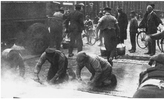
Abb. 9.41 Für jüngere Leser kaum noch vorstellbar, hatte ein Großteil der Straßen – auch in den Außenbezirken der Städte – in der Zeit zwischen den beiden Weltkriegen noch keine feste Fahrbahndecke. Das Aufbringen einer Teerschicht ( Bild ) galt daher Ende der zwanziger Jahre vielerorts als unerhörter Luxus. (Foto von Friedrich Seidenstücker, 1927)
