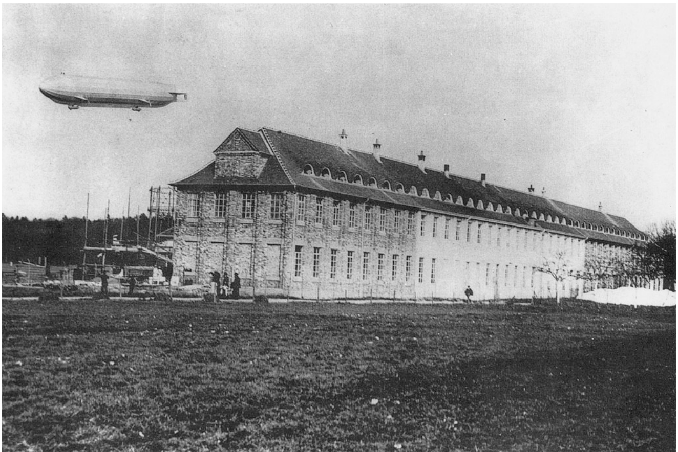
Abb. 8.12 Der »Hochbau I«, das erste Gebäude des Maybach-Motorenbaus in Friedrichshafen, im Frühjahr 1913. Mit dem Bau des Mittelteils war 1911 begonnen worden, 1912 wurde er bezogen; Baubeginn für den westlichen und östlichen Teil war Herbst 1912. Im oberen Teil
