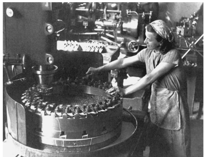
Abb. 11.22 Auch beim Maybach-Motorenbau waren ab 1942 Frauen verstärkt in der Produktion eingesetzt. Hier bedient eine Arbeiterin eine Rundtischfräsmaschine, auf der Schwinghebel für HL-Motoren geätzt werden
