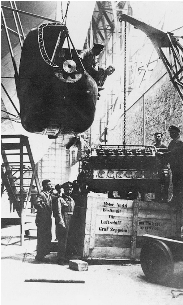
Abb. 4.17 Einbau eines VL-2-Motors in eine der fünf Motorgondeln von LZ 127. Die Forderung nach extremem Leichtbau einerseits und absoluter Zuverlässigkeit andererseits zwang nicht nur den LZ, sondern auch die nahezu 100 Unterteilhersteller zu Höchstleistungen. So brachte der Luftschiffbau die technische Entwicklung auf vielen Gebieten voran
