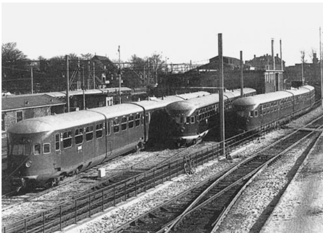
Abb. 10.51 Dreiteilige Schnelltriebzüge der Niederländischen Staatsbahn mit je drei Maybach-GO-6-Motoren (je 478 kW/650 PS) und elektrischer Kraftübertragung. Die Niederländische Staatsbahn war der wichtigste ausländische Kunde des Maybach-Motorenbaus vor dem Zweiten Weltkrieg
