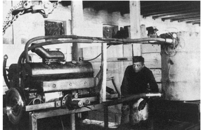
Abb. 20.17 Nach der Wiedermontage machten die Motoren einen Probelauf (unbelastet), bei dem lediglich die Funktionen überprüft werden konnten
