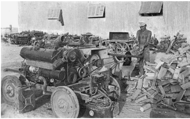
Abb. 12.16 Der »Motorenbau« in der frühen Nachkriegszeit: Wo vor Kurzem noch Panzermotoren in großen Stückzahlen produziert wurden, schneidet jetzt ein Mitarbeiter Bretter zu Brennholz. Als Antrieb dient ihm ein Panzermotor HL 120. An der Wand des Gebäudes sind weitere, nicht mehr benötigte Motoren für Halbkettenfahrzeuge und Panzer abgestellt
