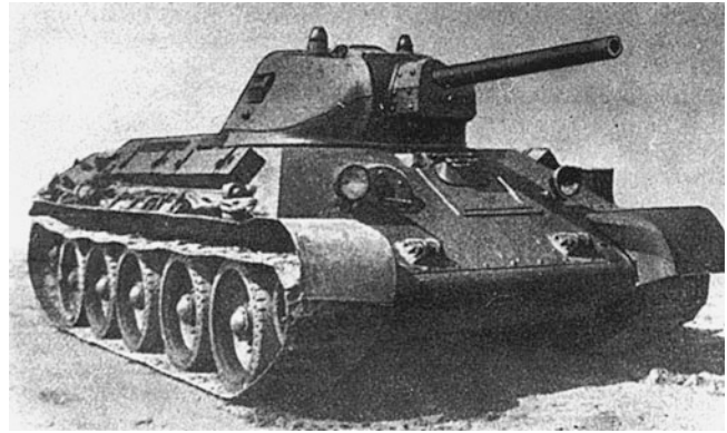
Abb. 11.13 Das erste Auftreten des sowjetischen T-34-Panzers, dessen Vorhandensein nicht einmal vermutet worden war, erwies sich für die Deutsche Wehrmacht im Sommer 1941 als böse Überraschung. Der T-34, von den Konstrukteuren Koschkin und Morozow entwickelt und in gewaltigen Stückzahlen gefertigt, war ein homogen durchgebautes Fahrzeug mit günstiger Formgebung der Panzerflächen, schwerer Bewaffnung, hoher Beweglichkeit und hervorragender Geländegängigkeit (aufgrund des breiten Kettenlaufwerkes und seiner günstigen Leistungsmasse). Er hatte einen kompakten, leistungsstarken und robusten Dieselmotor, dessen Gehäuse aus einer Al-Legierung bestand – in jenen Tagen genauso eine Neuheit wie die weitgehende Elektroschweißung bei der Montage des Panzers. Gefechtsmasse: 26.300 kg, Höchstgeschwindigkeit: 50 km/h, Fahrbereich: 400 km, Bewaffnung: eine 7,62-cm-Kanone, zwei 7,62-mm-MG; Besatzung: 4 Mann. Das Erscheinen dieses Panzers zwang die deutsche Führung, schnellstens etwas Ebenbürtiges zu entwickeln. Zuerst war daran gedacht, den T-34 mit wenigen Änderungen nachzubauen. Aus verschiedenen Gründen, u. a. weil einige für den Turm des T-34 verwendete Stahlliegierungen in Deutschland knapp waren, nahm man davon Abstand. Stattdessen ging man daran, den Panzer V »Panther« (als Gegenstück zum T-34) und den Panzer VI »Tiger« – jedoch wiederum mit Benzinmotoren – zu bauen
