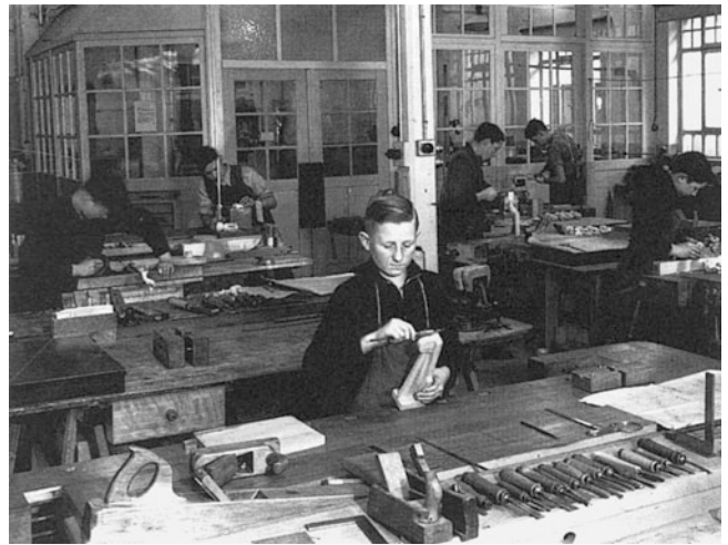
Abb. 3.24 Gerade in der Motorenfertigung mit ihren komplizierten Gussteilen hat der Modellbau als Bindeglied zwischen Maschinenbau und Gießerei besondere Bedeutung. Karl Maybach erkannte dies schon früh und ließ im »Maybach-Motorenbau« eine Modellschreinerei einrichten. Dieses Bild, aufgenommen im Jahre 1939, zeigt einen 15-jährigen Lehrling, der konzentriert die Maße eines Modells prüft
