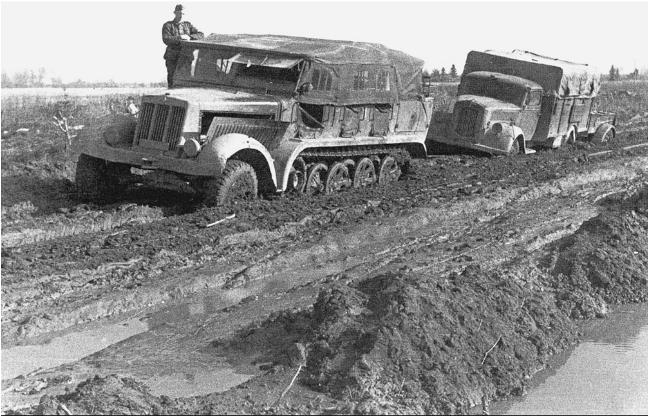
Abb. 11.10 Dieser 8-Tonnen-Zugkraftwagen HL 11m von Borgward mit Maybach-HL-62-TUK-Motor zieht einen Opel »Blitz« durch den Schlamm einer Rollbahn im Osten
