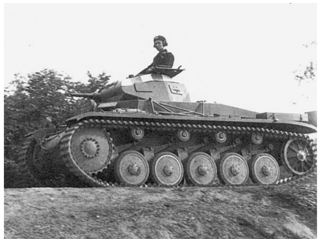
Abb. 11.6 Der leichte Panzer II, ausgerüstet mit Maybach-HL-57/62-Motor, war bereits zu Beginn des Krieges veraltet. Gefechtsmasse: 7.600 kg, Höchstgeschwindigkeit: 40 km/h, Fahrbereich: 180 km, Bewaffnung: eine 2-cm-KwK 30, ein MG 34; Besatzung: 3 Mann
