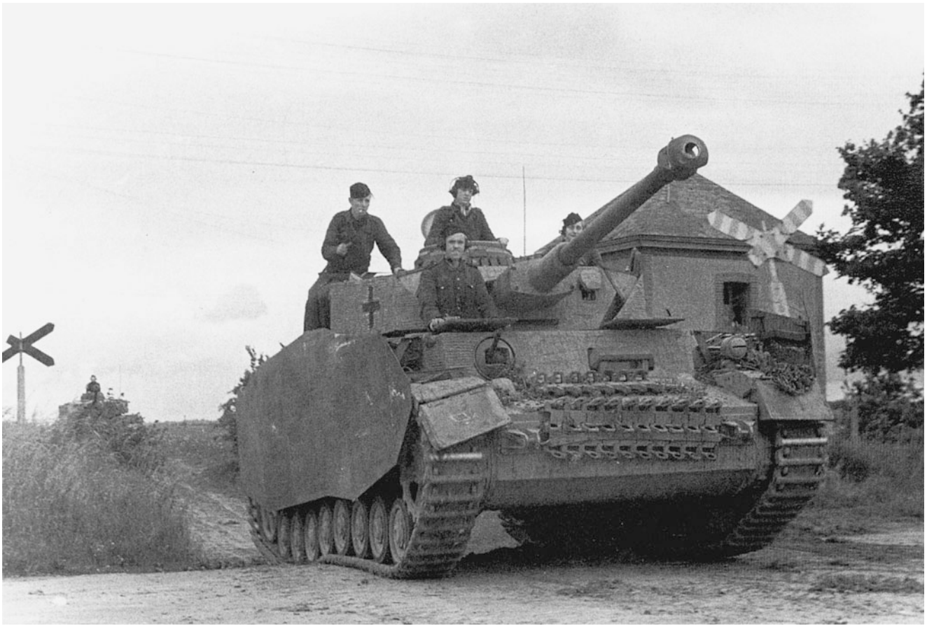
Abb. 11.8 Panzer IV, Ausführung H oder J, aufgenommen in der Gegend von Caen/Frankreich nach der Invasion der Alliierten in der Normandie im Sommer 1944. Die Wagen dieses Typs waren mit dem Maybach-HL-120-TRM-Motor und ZF-Aphon-Getriebe (sechs Vorwärtsgänge, ein Rückwärtsgang) ausgerüstet und hatten eine Gefechtsmasse von 25.000 kg. Die Schürzen seitlich der Wanne und am Turm dienen als Schutz vor Hohlladungsgeschossen, der pastos aufgetragene »Zimmerit«-Schutzanstrich soll das Anbringen von Haftminen erschweren. Höchstgeschwindigkeit: 38 km/h, Fahrbereich 250 km, Bewaffnung: eine 7,5-cm-KwK L/48, zwei MG 34; Besatzung: 5 Mann
