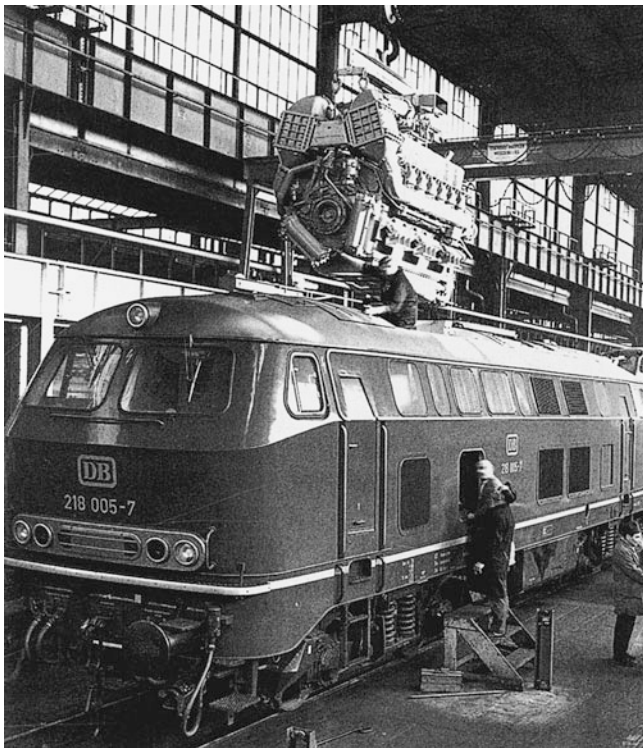
Abb. 21.51 Einbau eines MMB-Motors MC 1060 (MC 12 V 956) in eine Diesellokomotive der Baureihe V 218
