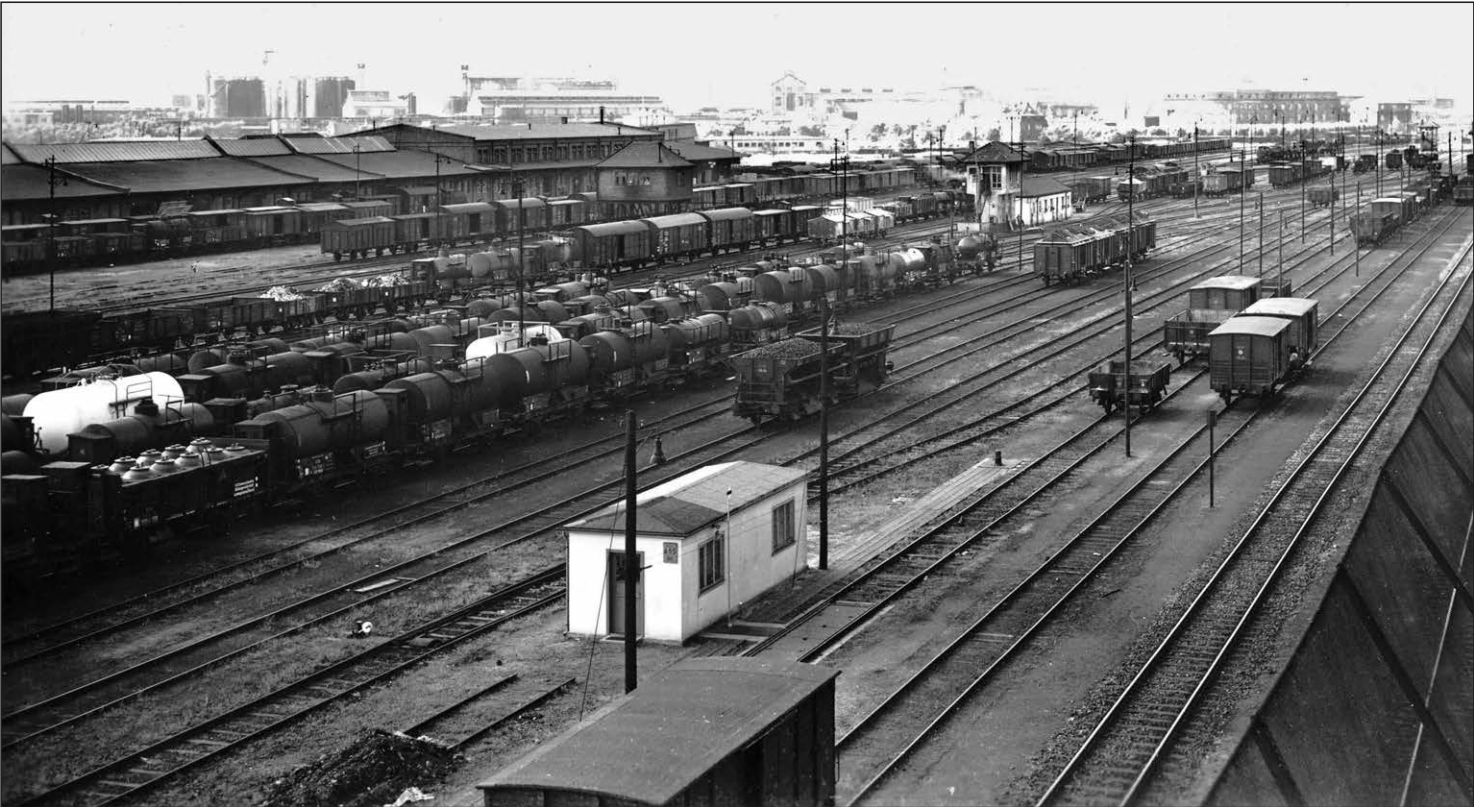
Dieses auf 1933 datierte Foto – im Nordbereich des Rangierbahnhofes der Badischen Anilin und Soda Fabrik in Ludwigshafen/Rhein aufgenommen – ist wohl erst in der zweiten Hälfte der 30er Jahre entstanden. Hierfür sprechen sowohl die zahlreichen Kesselwagen auf Untergestellen mit 4,50 m Achsstand, als auch einige im Hintergrund erkennbare G-Wagen. Zwar überwiegen weiterhin die Wagen mit Flachdach, auf dem Foto sind aber auch mehrere GI-Wagen der Austauschbauart – darunter ein offensichtlich neuer GIs – und mehrere Ghs Oppeln zu erkennen. (Foto BASF, Slg. H.-D. Kienitz)
