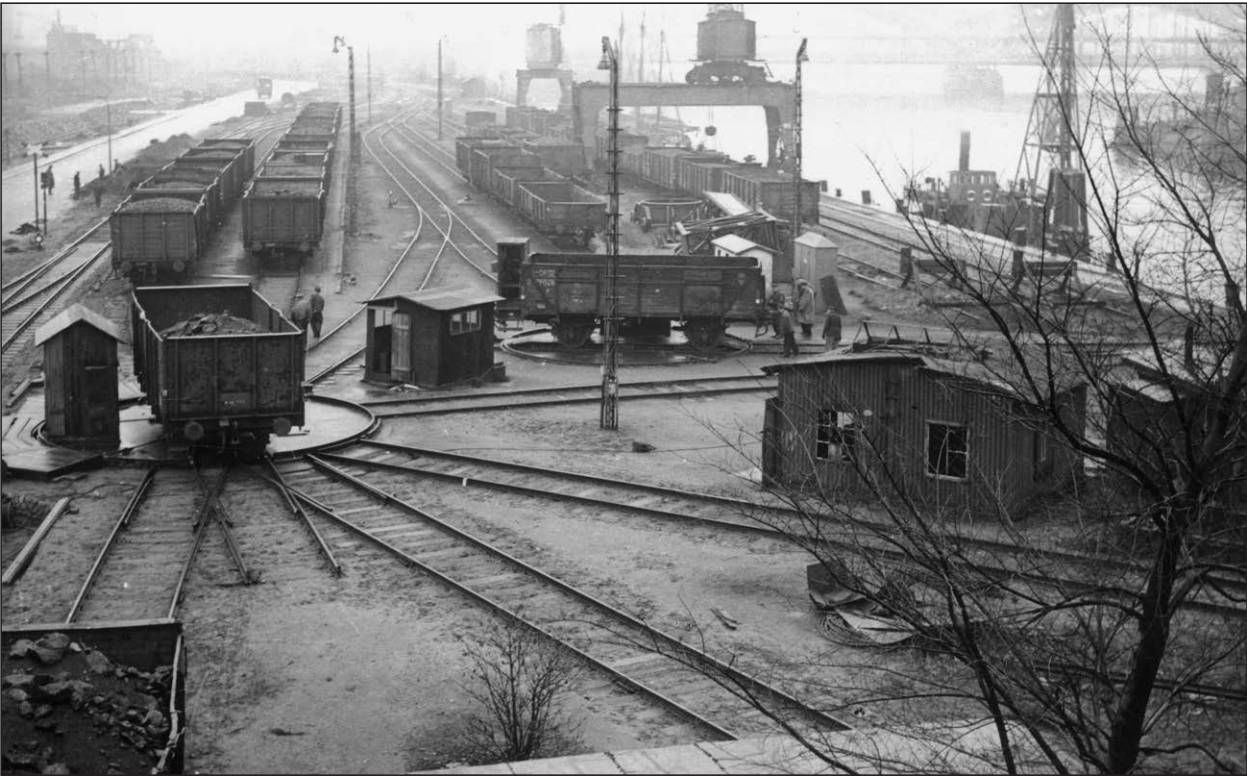
Chronologisch hätte dieses Bild, das am 15. Oktober 1950 im Hamburger Hafen am Kirchenpauerkai entstanden ist, an den Anfang des Kapitels gehört. Im Vordergrund auf der Waggondrehscheibe der Om Danzig 1327, auf der hinteren Drehscheibe ein „Pfeilwagen“, der O 712 418. Im Hintergrund sind weitere O-Wagen nahezu aller Bauarten zu erkennen. (Foto Cusian, Slg. Johannes Matthießen, AG Ortschronik St. Peter-Ording)
