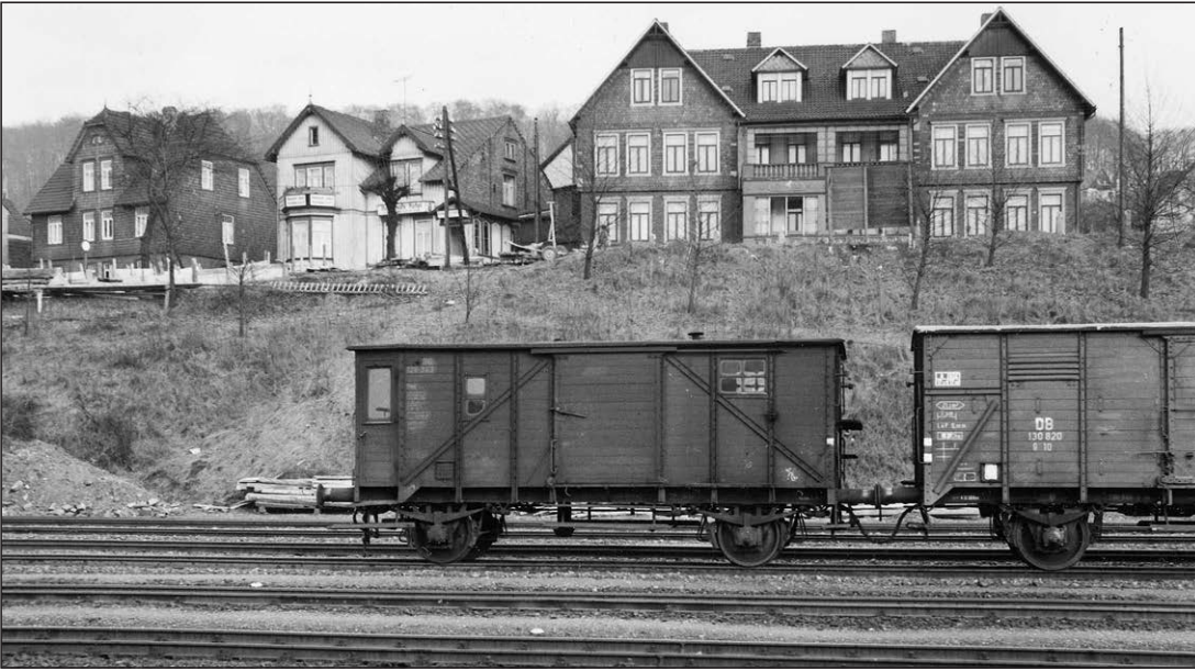
Auch der im Dezember 1958 in Kreiensen fotografierte 128 343 war ein Pwg pr 02a, der nicht nur verstärkt wurde, sondern auch der Dachkanzel und der Fenster in den Laderaumtüren beraubt worden war. Wie bei anderen älteren Pwg verzichtet die DB beim Umbau auf den Einbau des seitlichen „Erkers“. (Foto Reinhard Todt)
