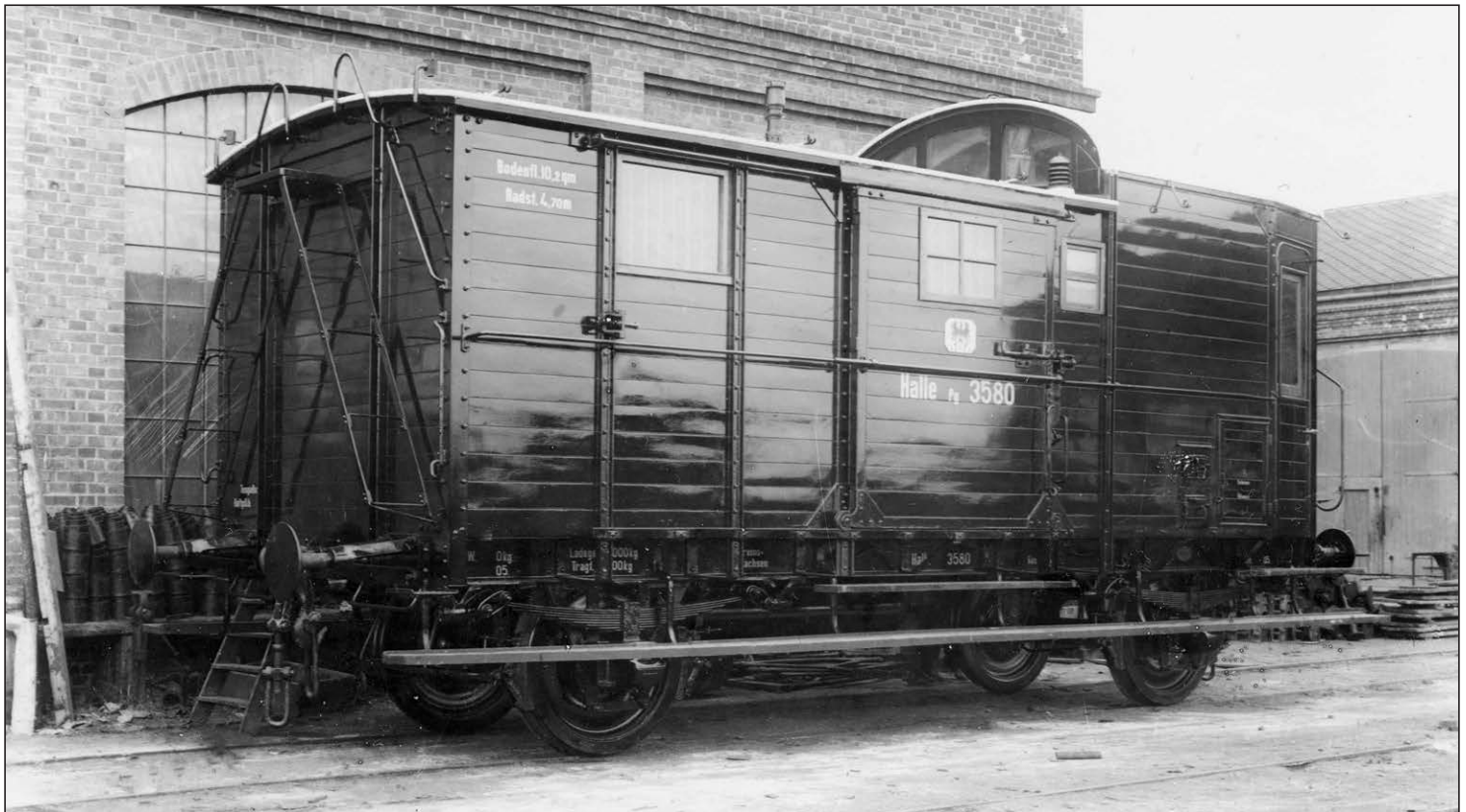
Der 1905 von der Waggonfabrik Lindner an die KED Halle gelieferte Pg 3580, bei der DRB als Pwg pr 02a eingereiht, entsprach dem 2. Entwurf für das Musterblatt Ila 13. Markante Merkmale dieser Wagen waren die über die ganze Wagenbreite reichenden Fenster in der Dachkanzel, die bis zum Wagendach reichenden Leitern am Packraumende und die Flacheisenachshalter. (Werkfoto Lindner, Slg. Wolfgang Theurich)
