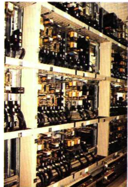
Fig. 2.4 Ensemble de relais NS 1 montés sur châssis 150 modules dans un poste tout relais à transit souple (PRS) (voir chapitre 13).
