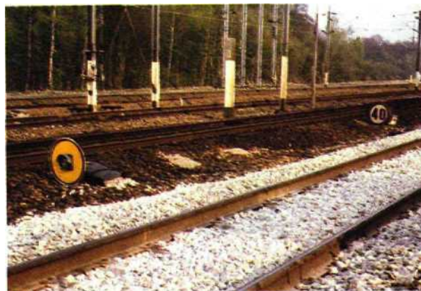
Fig. 1.85 Repère d'approche pour les signaux de chantier installés à l'improviste.
