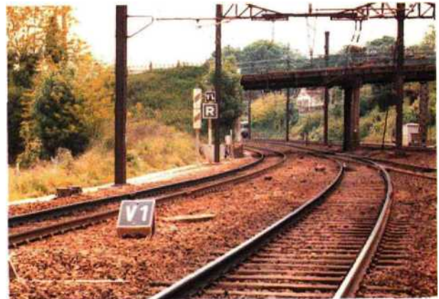
Fig. 1.105 — Pancarte de destination indiquant le numéro de la voie
