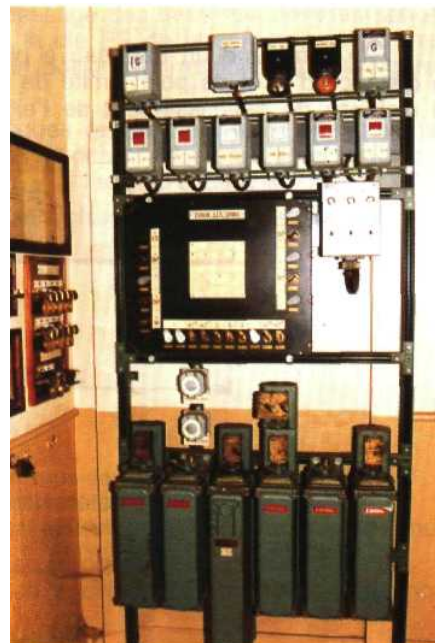
Fig. 10.16 Vue d'ensemble des installations de sécurité nécessaires à l'exploitation d'une gare-type VG 1011.
