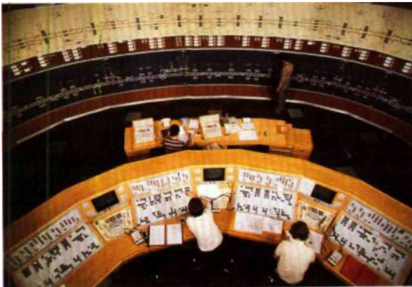
Fig. 17.4 — Poste d'aiguillage et de régulation (PAR) de la ligne à grande vitesse Paris-Sud-Est.
