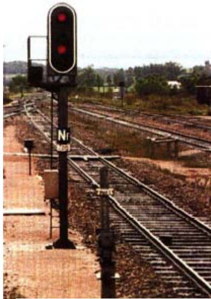
Fig. 8.51 Panneau C S A VL assurant la protection d'une petite gare sur une ligne équipée en block automatique.
