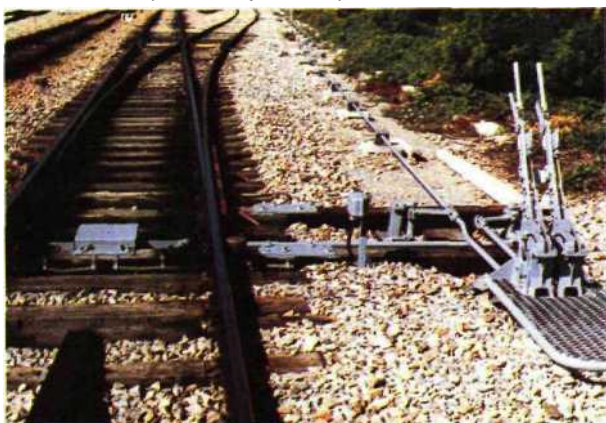
Fig. 4.17 — Aiguillage verrouillé par verrou indépendant — vue d'ensemble —
