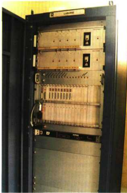
Fig. 18.19 Armoire d'un système normalisé de télétransmission informatique (SNTI) dans un poste secondaire
