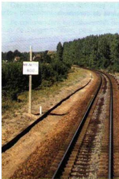
◀ Fig. 1.126 Pancarte repérant l'approche d'un établissement de pleine ligne desservi par certains trains.
