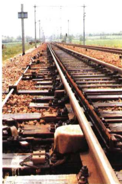
Fig. 19.51 Pointe d'aiguille d'un aiguillage tg 0,0218 d'un point de changement de voie.
