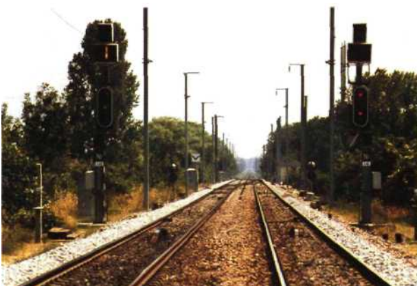
2. Panneaux de protection du point de changement de voie, sur la voie de gauche l'itinéraire tracé (voie libre et TIV effacé) permet au train de continuer à circuler en sens normal,
