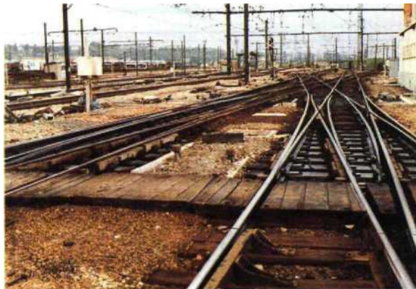
Fig. 4.2 — Ensemble de traversées jonction double et d'une traversée oblique.
