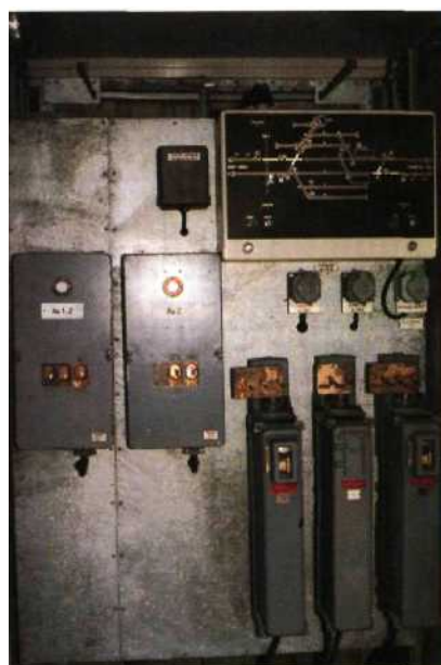
Fig. 8.54 Gare ordinaire équipée de verrous-commutateurs à manette assurant la protection des installations sur une ligne équipée en block automatique (BAL ou BAPR).
