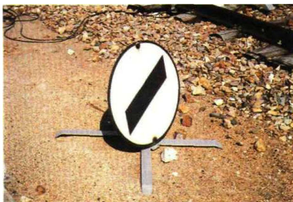
Fig. 1.86 Repère de proximité implanté en amont du TIV de chantier d'annonce lorsque ce dernier à une visibilité réduite
