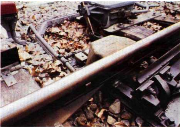
Fig. 4.29 — Aiguillage muni d'une installation de réchauffage électrique (les résistances électriques dites «linéaires» sont installées le long de l'âme du rail).
