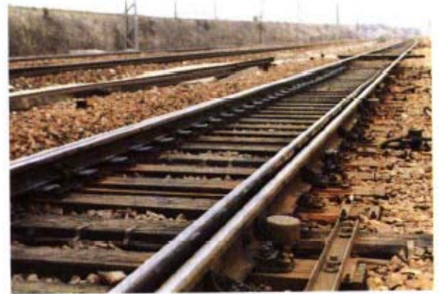
Fig. 4.51 — Ensemble de contrôleurs d'aiguillage conduits installés en talon d'un aiguillage sur un appareil long (tg 0,0218).
