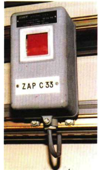
Fig. 7.9 — Contrôle de la zone d'approche par voyant électromécanique:
