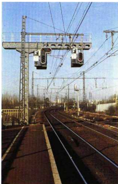
◀ Fig. 1.61 Signal installé sur potence présentant l'indication de ralentissement 30.
