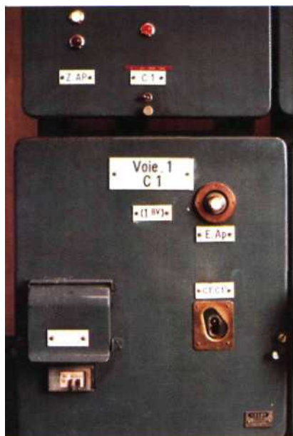
Fig. 8.53 Serrure de block automatique installée sur une ligne à double voie équipée de BAL.
