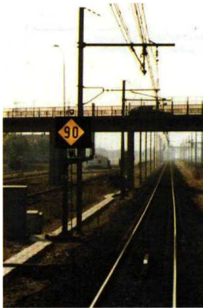
Fig. 1.72 TIV à distance mobile lumineux présenté.
