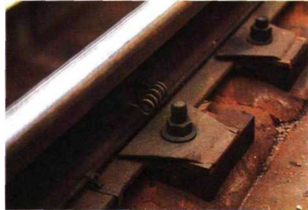
Fig. 3.17 — Repérage de la file isolée d'un circuit de voie monorail sur une voie équipée de longs rails soudés.
