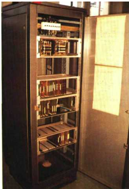
Fig. 13.48 Appareillage de télétransmissions permettant la télécommande et le télécontrôle de zones de PRS éloignées.
