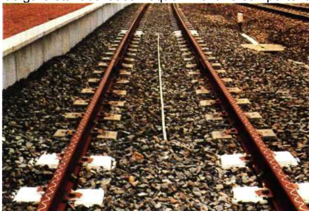
Fig. 19.64 — Cordons de shuntage inox installés sur une voie d'évitement.
