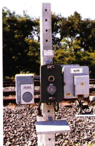
Fig. 13.40 — Dispositifs à utilisation contrôlée permettant d'envoyer à pied d'œuvre l'autorisation d'annulation de transit.
