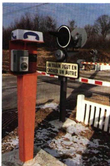
Fig. 11.47 — Téléphone type «autoroute» mis à la disposition de l'utilisateur de la route, notamment en cas de fermeture prolongée du PN.
