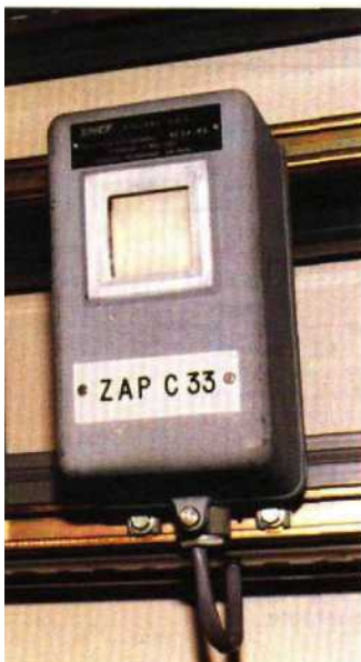
Fig. 7.9 — Contrôle de la zone d'approche par voyant électromécanique:
