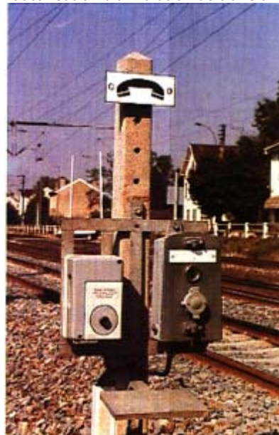
Fig. 14.43 - Dispositif à utilisation contrôlée permettant d'envoyer à pied d'œuvre l'autorisation d'annulation de transit.
