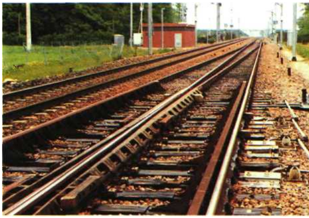
Fig. 19.48 — Poste de commande locale type PRS installé à proximité des appareils de voie.
