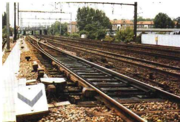
1. aiguillage verrouillé par VCC,
