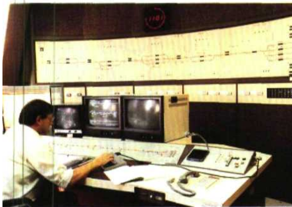
Fig. 15.69 — Vue générale du poste d'une commande centralisée de voie banalisée à commande Informatique (télécommande de plusieurs petits postes).
