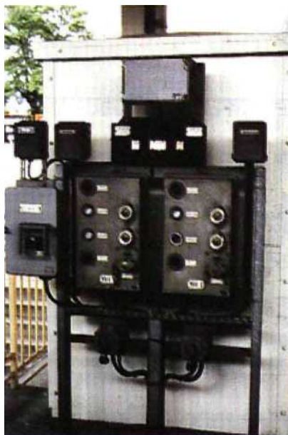
Fig. 8.13 Tableaux de block «formule 1959» installés sur une ligne à double voie équipée du BMU : cas du poste Intermédiaire avec reddition garage.
