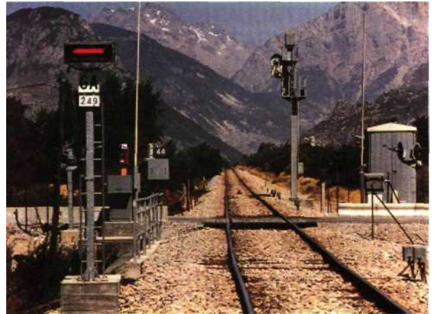
Fig. 10.37 — Guidon d'arrêt de limiteur de sas dans une gare-type VD 3142.
