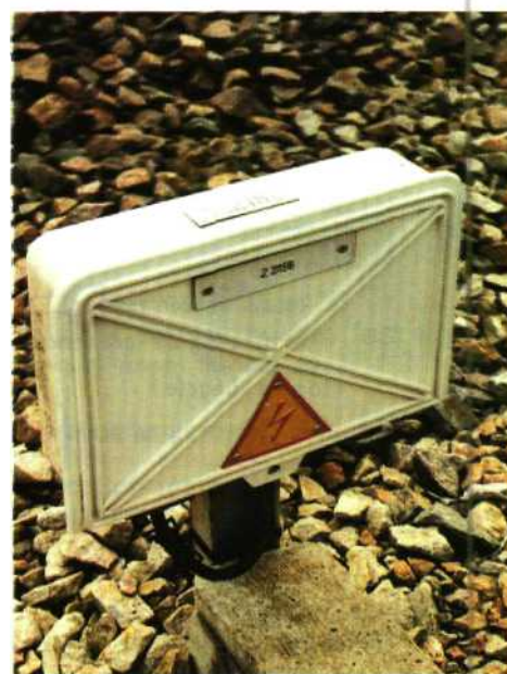
Fig. 19.13 Appareillage placé à la voie pour la connexion des extrémités d'un circuit de voie.
