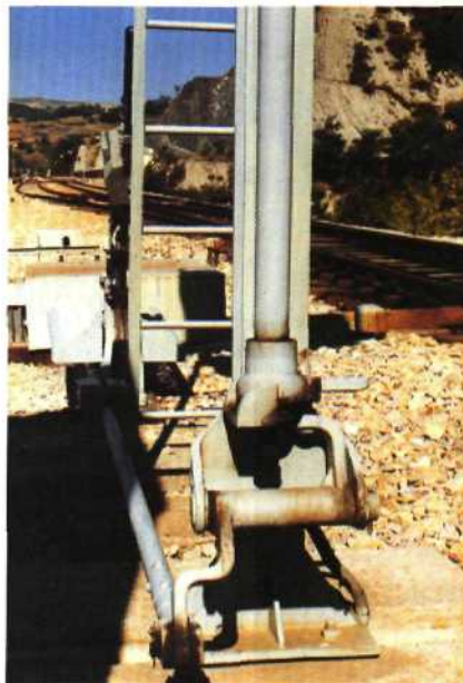
◀ détail de l'accouplement TIV-verrou de l'aiguillage (transmission rigide).
