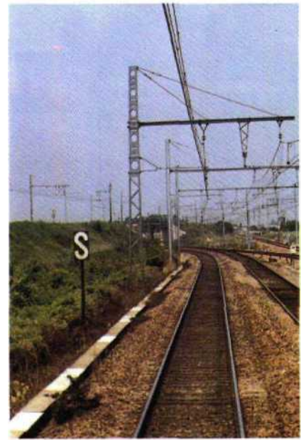
Fig. 1.130 Pancarte «n» repérant l'approche des ouvrages d'art à gabarit réduit et des obstacles permanents ou temporaires (échafaudages sur chantiers de travaux par exemple).
