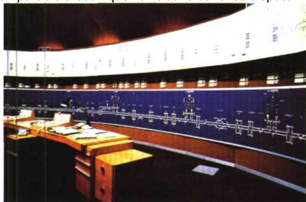
Fig. 19.84 — Ensemble TCO signalisation et du tableau de commande et de contrôle des installations de traction électrique.
