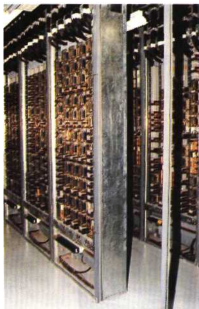
Fig. 13.7 — Châssis NS 1 — 150 modules installés dans la salle d'appareillage d'un PRS.
