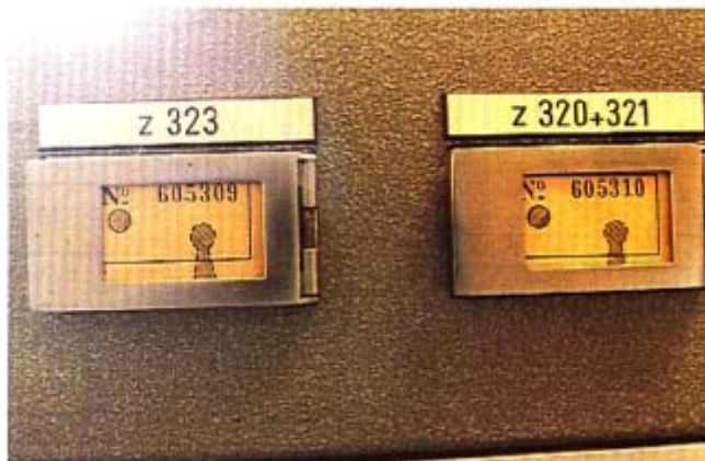
Fig. 14.41 Dispositifs à utilisation contrôlée permettant d'annuler directement l'action d'une ou de plusieurs zones.
