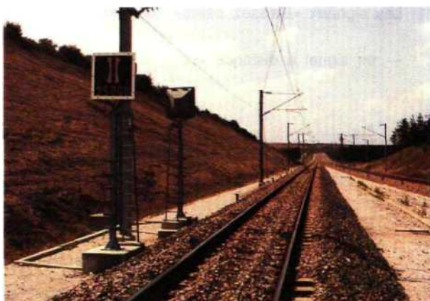
Fig. 1.161 — Signal de fin de parcours à pantographes abaissés.
