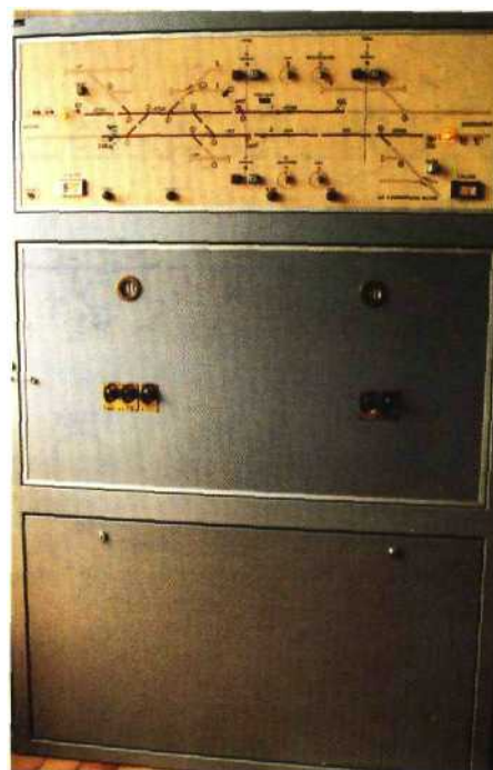
Fig. 12.1 Gare de double voie équipée de verrous-commutateurs et de voyants électromécaniques pour la réalisation des installations de sécurité.
