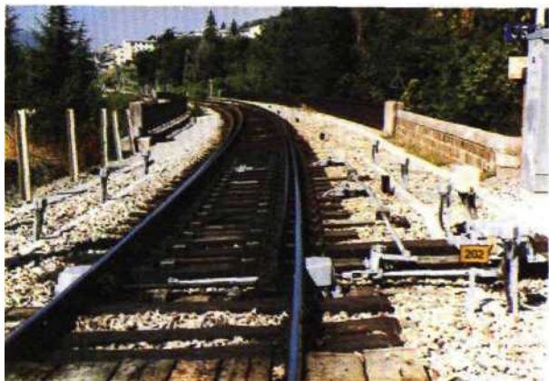
Fig. 4.14 — Vue d'ensemble d'un aiguillage muni de verrous carter-coussinet.
