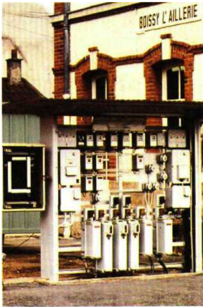
Fig. 6.13 Vue d'ensemble des installations de sécurité d'une petite gare sur une ligne à double voie équipée d'une serrure centrale, de verrous-commutateurs à manettes, de commutateurs à manettes ainsi que de voyants électromécaniques pour l'ensemble des contrôles de l'installation.
