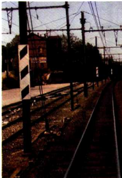
Fig. 1.172 Mirlitons repérant l'approche d'un signal à visibilité réduite.
