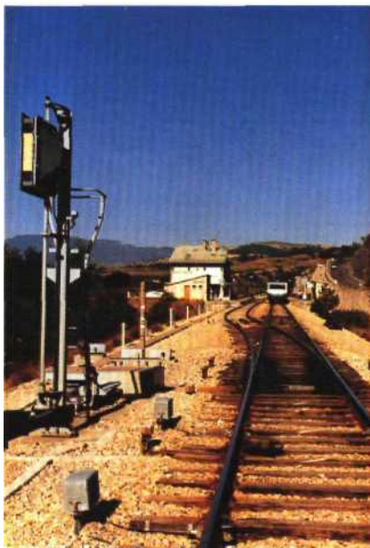
▲ TIV ouvert: aiguillage verrouillé,
