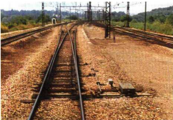
Fig. 4.1 — Branchement à deux voies à déviation à gauche incorporé dans une courbe à droite d'un rayon de 2 500 m.
