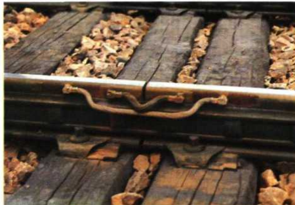
Fig. 3.6 — Sur les lignes électrifiées en courant continu 1 500 V, les connexions de 95 mm 2 sont doublées dans les zones proches des sous-stations afin d'assurer un meilleur chemin au retour du courant de traction (voir § 3.4).
