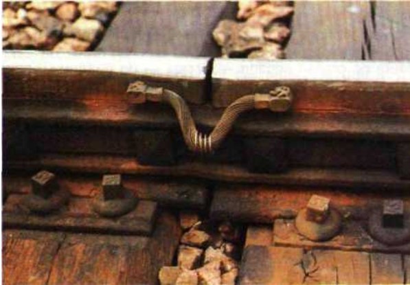
Fig. 3.16 — Repérage de la file isolée d'un circuit de voie monorail sur une voie équipée de rails avec joints.
