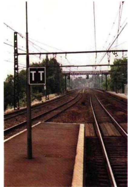
◀ Fig. 1.126 Pancarte repérant l'approche d'un établissement de pleine ligne desservi par certains trains.
