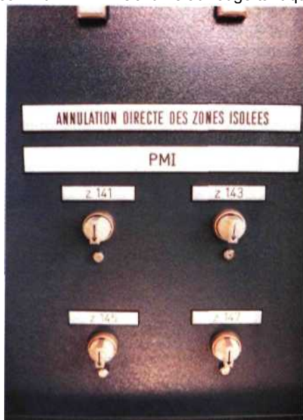
Fig. 16.34 Commutateurs permettant l'annulation de l'enclenchement des aiguillages par zone isolée dans une zone de débranchement.
