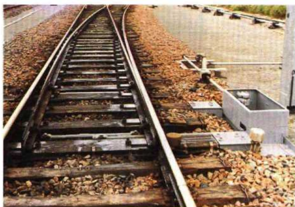
vue d'ensemble de l'appareil de voie et de son calage (capot de protection enlevé),
