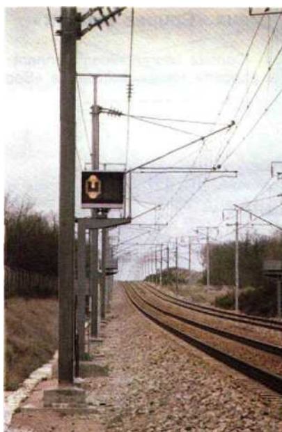
Fig. 1.166 Signal de fin de parcours à courant coupé mobile lumineux fermé.
