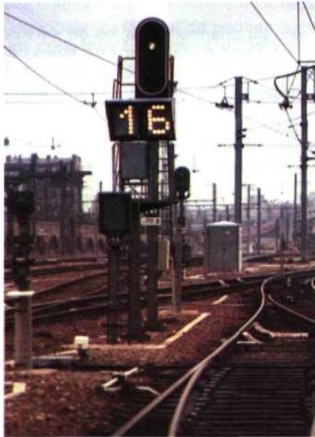
Fig. 16.8 Tableau indicateur de provenance commun à l'ensemble des voies d'un faisceau.
