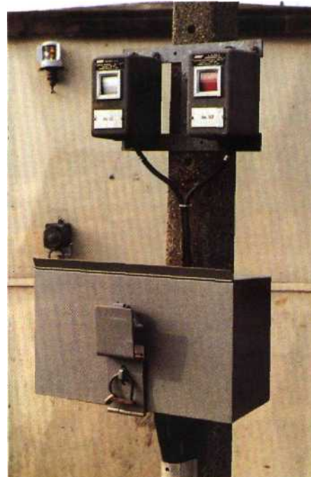
Fig. 11.45 Coffret et voyants permettant la reprise de gardiennage d'un PN à SAL lors de travaux, d'incidents, ...
