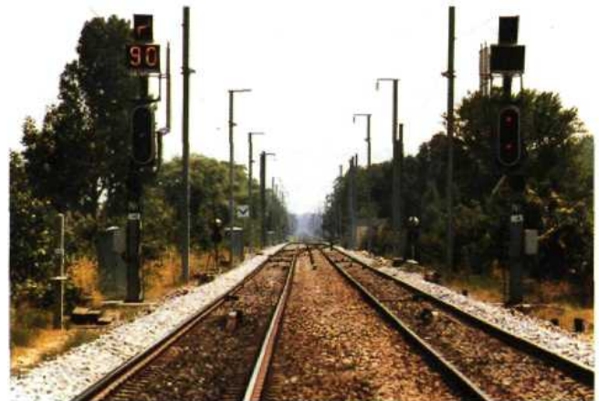
4. Sur la voie de droite, l'itinéraire de sortie de contresens est formé et enclenché, le TIV de rappel pour le franchissement des aiguillages et le tableau de sortie de contresens (TSCS) étant présentés. L'ouverture du signal carré interviendra automatiquement à la libération du canton aval.
