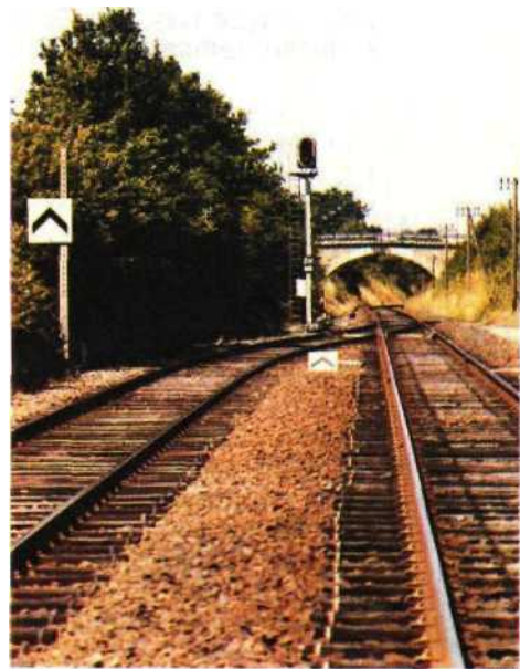
Fig. 1.26 Implantation du sémaphore sur une ligne à voie unique; les chevrons repèrent le point que le mécanicien ne doit pas dépasser lorsqu'il a un arrêt à observer en gare.
