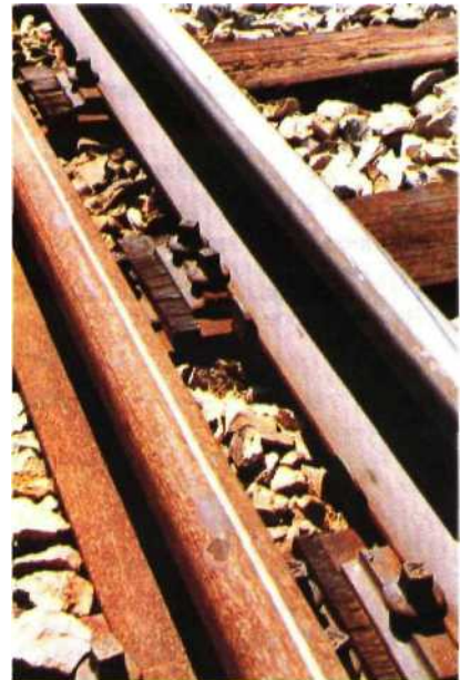
Fig. 3.3 Différentes poses de cordons d'acier inoxydables soudés sur la surface de roulement des rails.
