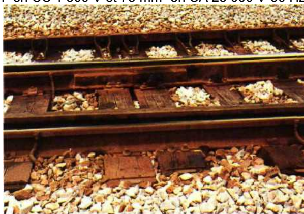
Fig. 3.11 — Différents reports de polarité réalisés en câble de 185 \text{ mm}^2 de section sur une ligne électrifiée en courant continu 1 500 V.
