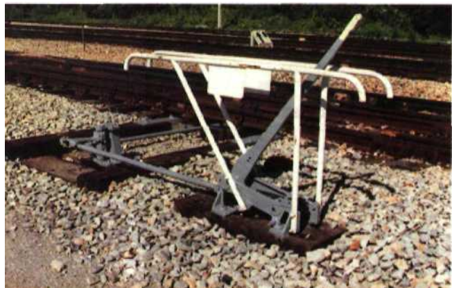
Fig. 16.9 - Aiguillage manœuvré à pied d'œuvre dans un chantier de voies de service de faible importance.
