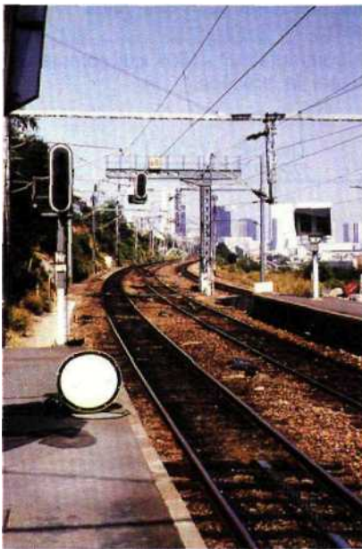
Fig. 1.91 Tableau blanc indiquant la fin de la partie de voie à franchir à vitesse limitée.
