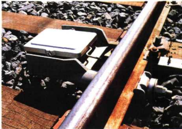
Fig. 13.24 Détecteur électromécanique installé dans la zone d'action d'un PRS permettant de réaliser la destruction automatique d'un itinéraire.
