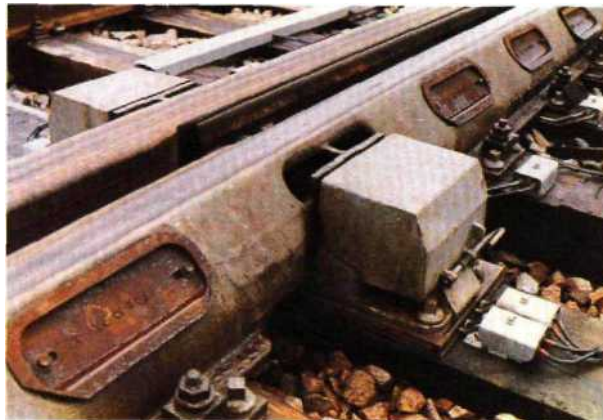
Fig. 4.15 — Verrou installé sur un croisement comportant un cœur à pointe mobile.
