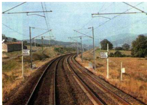
Fig. 1.163 — Pancarte indiquant un sectionnement à 1 000 m.
