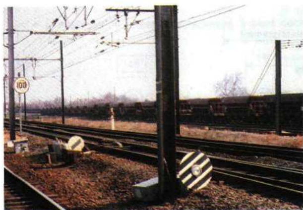
Fig. 1.84 TIV de chantier à distance complété d'un disque jaune installés au ras du sol lorsque l'entrevoie est réduite.
