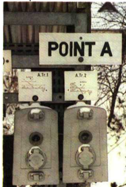
Fig. 7.26 Dispositifs d'autorisation d'annulation de transit installés à pied d'œuvre lorsque les zones isolées sont éloignées.
