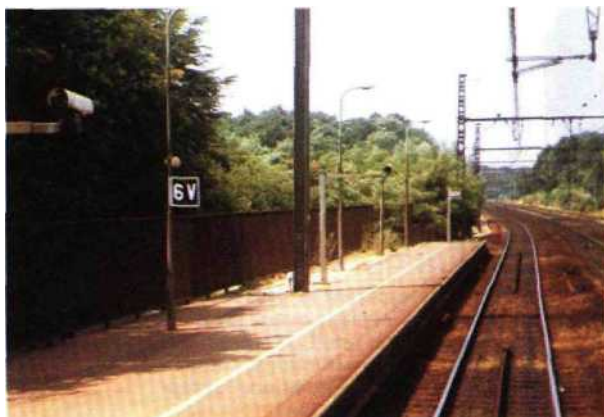
Fig. 1.125 Pancartes repérant, sur un quai, le point normal d'arrêt des trains de voyageurs de G (ou 10) véhicules.
