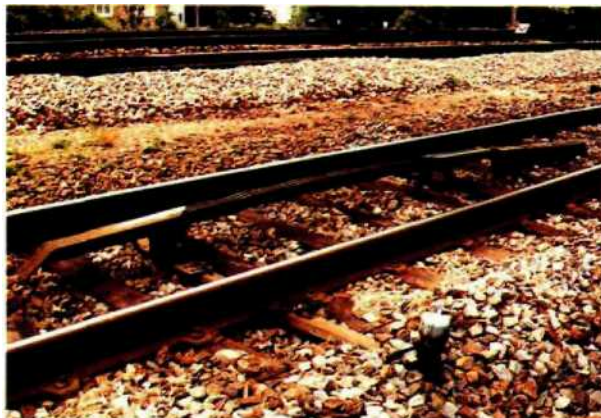
Fig. 1.175 Crocodile permettant la répétition sonore des signaux dans le poste de conduite.
