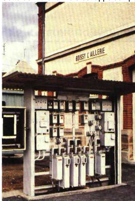
Fig. 12.1 Gare de double voie équipée de verrous-commutateurs et de voyants électromécaniques pour la réalisation des installations de sécurité.
