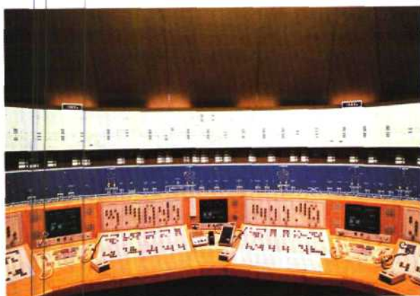
Fig 19.72 et fig. 19.73 — Vues générales du poste d'aiguillage et de régulation (PAR) de la ligne à grande vitesse Paris-Sud-Est.
