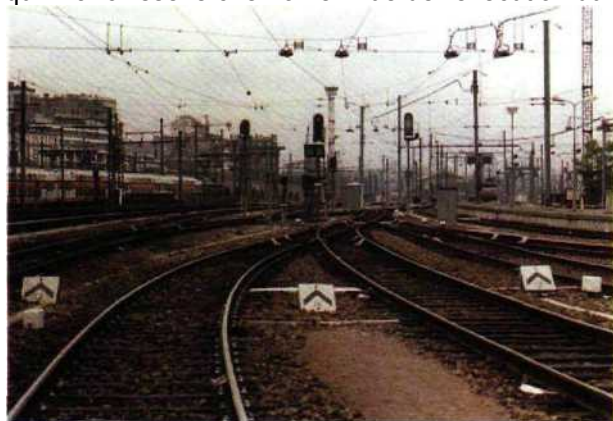
Fig. 1.141 — Chevrons pointe en haut repérant le point où les règlements imposent l'arrêt.
