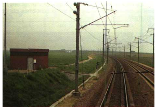
Fig. 19.49 — Centre d'appareillage intermédiaire (CAI) installé entre deux PRS.
