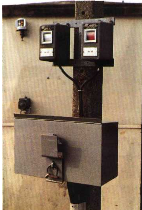
Fig. 11.45 Coffret et voyants permettant la reprise de gardiennage d'un PN à SAL lors de travaux, d'incidents, ...
