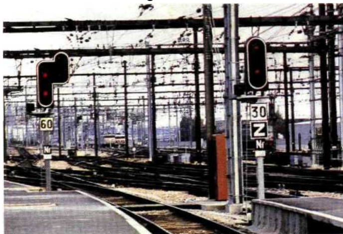
Fig. 1.14 — Carrés fermés à la sortie d'une grande gare protégeant des aiguillages en pointe.
