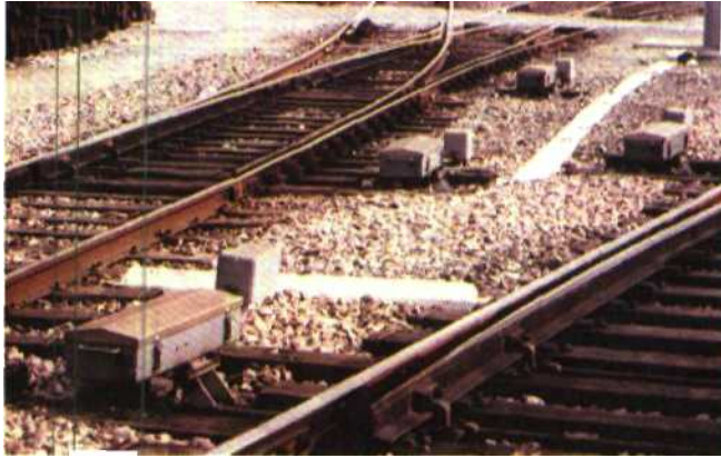
Fig. 16.11 - Aiguillages manœuvres électriquement dans un chantier de voies de service à grande activité.
