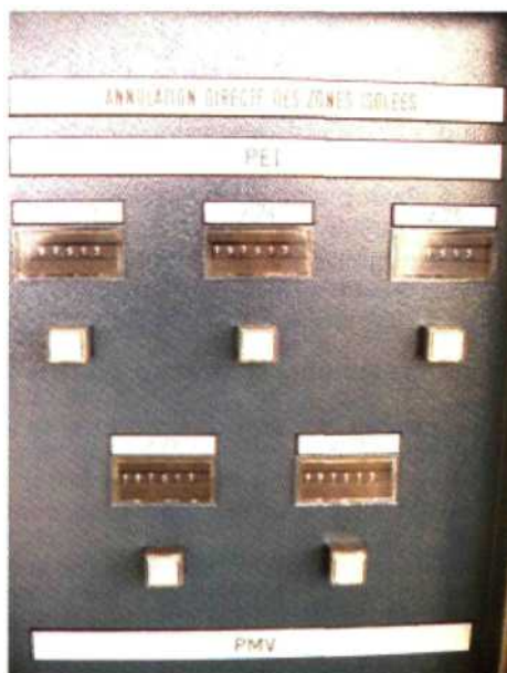
Fig. 16.42 Boutons-poussoirs permettant l'annulation directe des zones Isolées dans un PEI.
