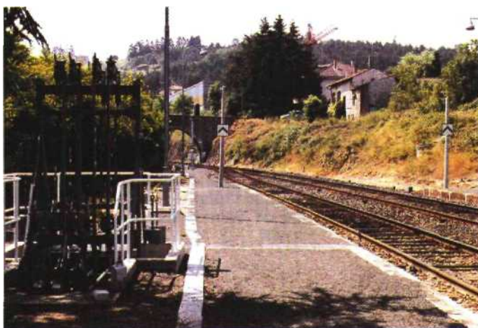
Fig. 12.14 — Signalisation extérieure d'une gare-type VD 1021 installée sur une ligne à voie unique.
