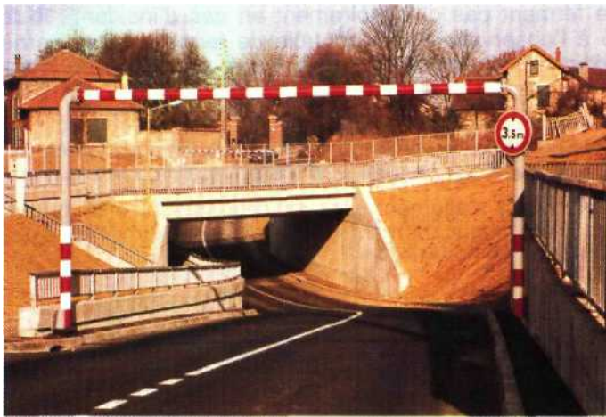
Fig. 11.18 Exemple de suppression d'un PN dans une zone à forte densité d'habitations.
