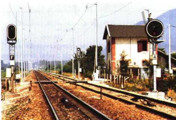
1. Sur la voie de droite, panneau rond à dis tance annonçant le point de changement de voie,
