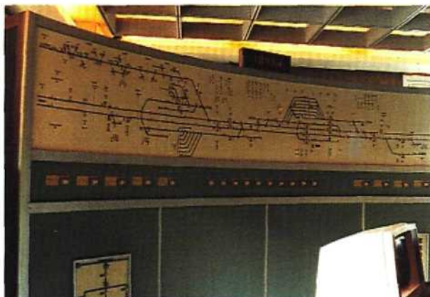
Fig. 15.12 — Vue générale du tableau de contrôle optique (TCO) d'un PRCI
