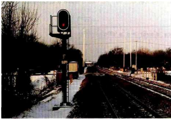
Fig. 1.38 Signaux sur mât présentant un avertissement fermé: cible ronde. ► ^ cible oblongue.
