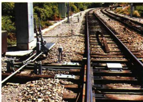
Fig. 13.44 — Manœuvre à pied d'oeuvre d'un aiguillage situé dans la zone d'action d'un PRS.
