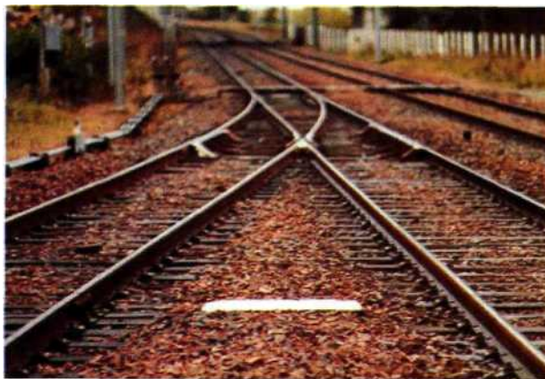
Fig. 1.10 Repérage du garage franc d'un aiguillage.
