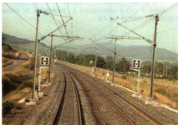
Fig. 1.168 — Signal de fin de parcours à courant coupé fixe.
