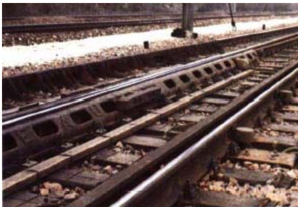
Fig. 4.53 — Ensemble de contrôleurs d'aiguillage conduits installés sur un croisement comportant un cœur à pointe mobile d'un branchement tg 0,0218.
