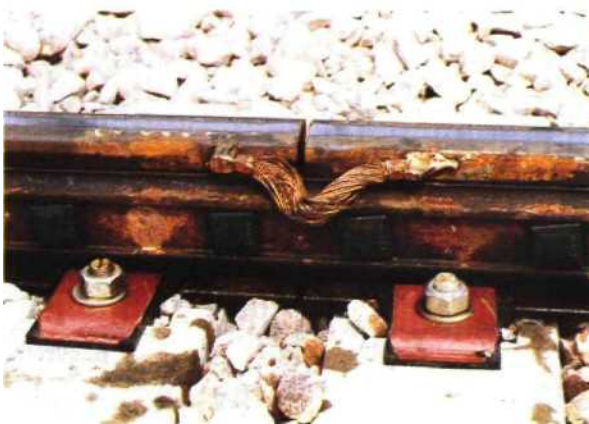
Fig. 3.5 — Connexion de 95 mm 2 de section permettant de réaliser l'éclissage électrique de deux rails sur une ligne électrifiée en courant continu 1 500 V.
