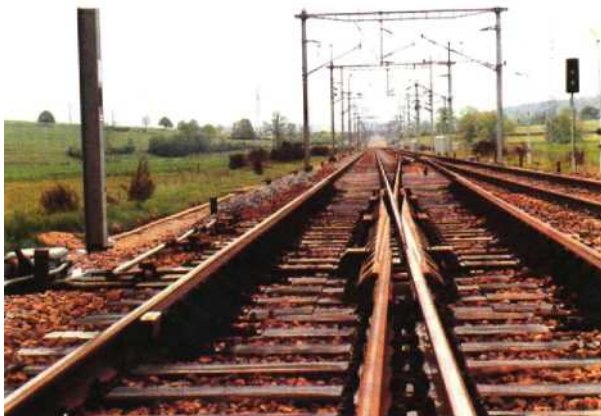
Fig. 19.53 Pointe de cœur mobile donnant la direction de gauche (voie directe) sur la photo.
