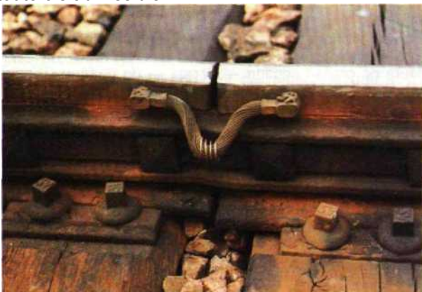
Fig. 3.21 — Connexions inductives permettant d'assurer le retour du courant de traction entre deux zones à impulsions de tension élevée (ITE) sur une ligne électrifiée en courant alternatif 25 000 V - 50 Hz.
