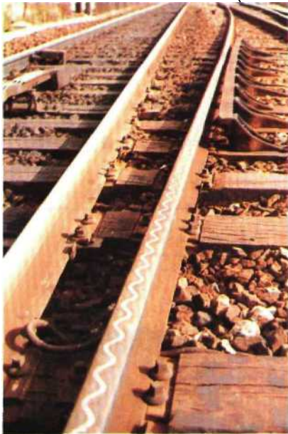
Fig. 3.3 Différentes poses de cordons d'acier inoxydables soudés sur la surface de roulement des rails.
