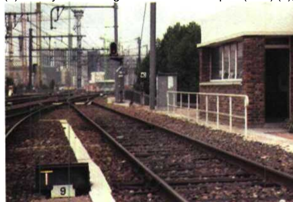
Fig. 16.7 — Tableau lumineux de correspondance pour voies convergentes présentant:
