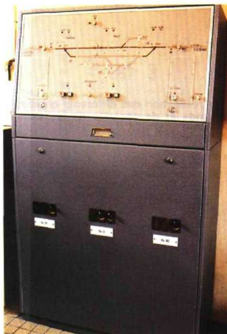
Fig. 12.15 Meuble PML d'une gare-type VD 1021 équipé de la table de commande et de contrôle (TCC) et des serrures et clés constituant les autorisations de manœuvre.
