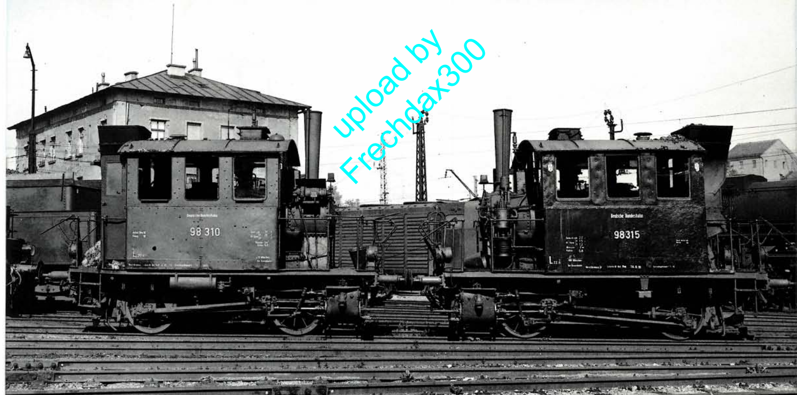
Bild 51: Die beiden Lokomotiven 98 310 und 98 315 zeigen schön die rechte und die linke Seite dieser Glaskasten-Bauform.
