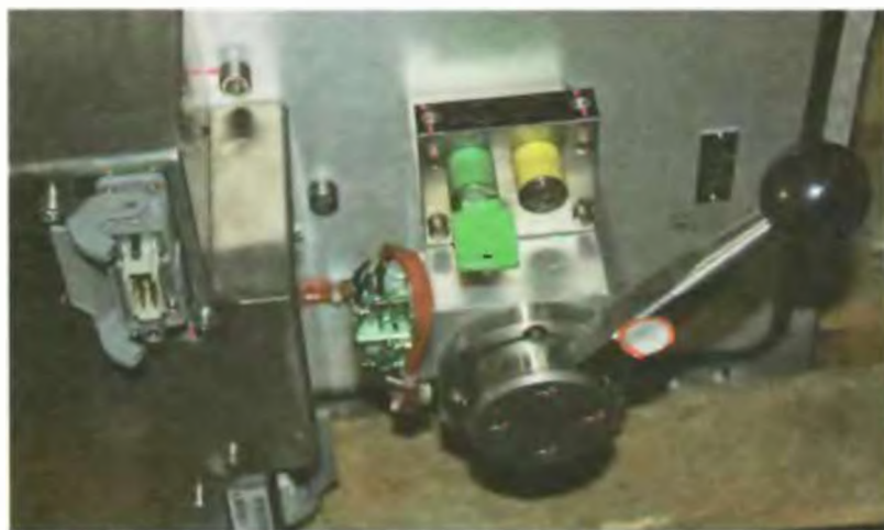
Рис. 4.33. Рукоятка заземлителя и блокировочное устройство ГВ
