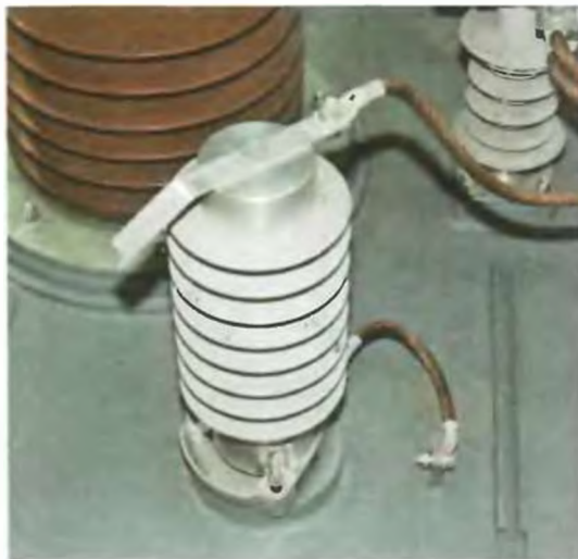
Рис. 4.16. Внешний вид разрядника переменного тока
