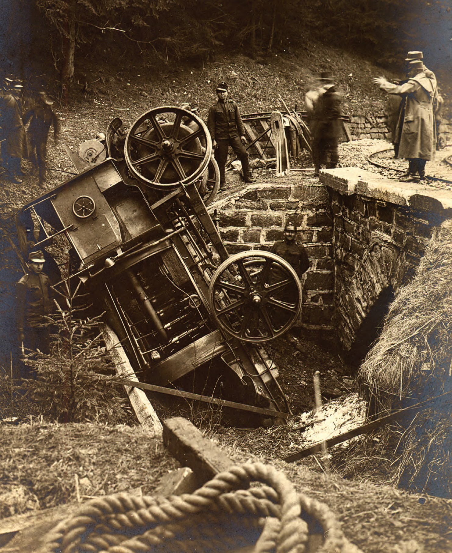
Un vagon generator tip 1-A / 1914, prăbușit de pe linie, într-o curbă aspră, la trecerea peste un podeț. Pe traseul liniei Dornișoara-Tiha Bârgăului se aflau circa 230 de curbe dintre care 18% cu raze de 18,5-40 m, 42% cu raze de 50-90m, 23% cu raze de 100-140 m și 17% cu raze de peste 150 m. Un accident asemănător a avut loc într-o curbă, la Tiha, la 22 mai 1937, soldat cu răsturnarea unui tren de marfă. Din cauza acestui accident, dar și a traficului scăzut, la 23 iunie 1939 administrația CFR a dispus sistarea definitivă a traficului pe calea ferată benzino-electrică Dornișoara-Tiha Bârgăului.
