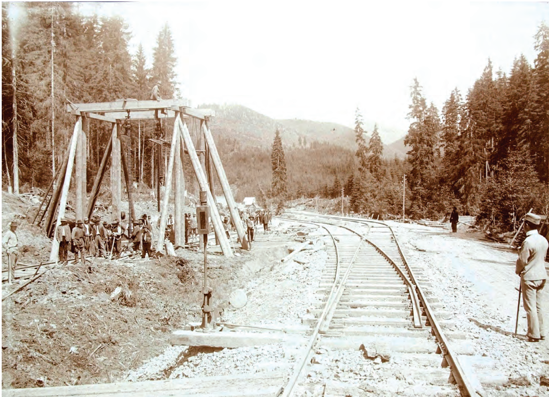
Instalația de ridicare, de la Dornișoara, a pieselor grele (de exemplu fremul locomotivelor cu abur) pentru încărcarea pe platformele căii ferate benzino-electrice.
