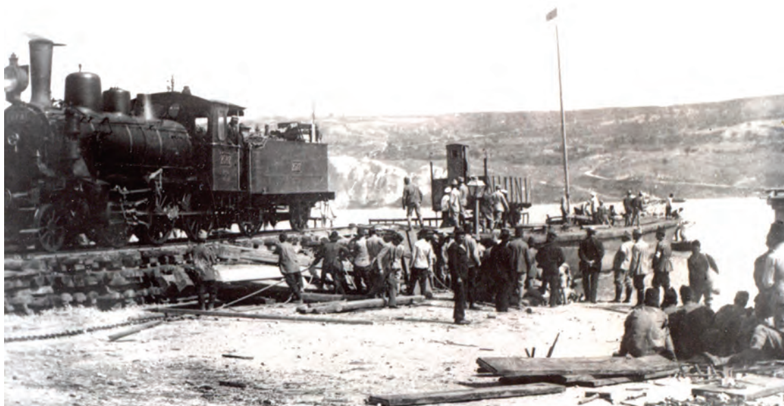
Trecerea peste Dunăre cu șlepurile, pe malul bulgăresc, în iulie 1913, a unor locomotive și vagoane CFR: în prim-plan, locomotiva CFR 2.507 tip 1C-n2 (WrN, nr. de fabricație 4.768/1907) manevrează pe cheiul de îmbarcare un vagon descoperit cu pereți mici cu cabină de frână.
