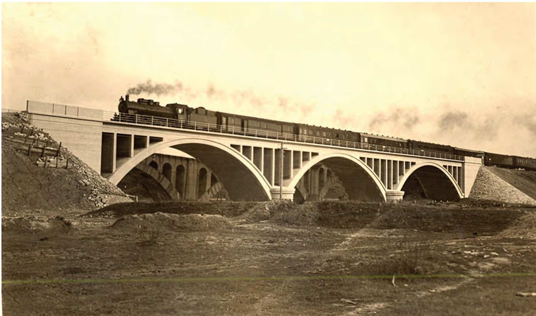
În timpul Primului Război Mondial, podurile liniei Buzău-Mărășești au fost distruse aproape în întregime. După terminarea războiului, s-a circulat mai întâi pe poduri improvizate, cu mai multe deschideri din grinzi laminate pe palei din lemn și apoi s-au realizat poduri cu bolți din beton. Imaginea prezintă podul de cale dublă peste Milcov, între stațiile Râmnicu Sărat și Focșani, realizat în 1935, după proiectele inginerului V. Wermescher, din trei bolți din beton armat, cu deschideri de 32 m. Imaginea datează din 26 aprilie 1937, când podul este traversat de un tren accelerat de călători.
