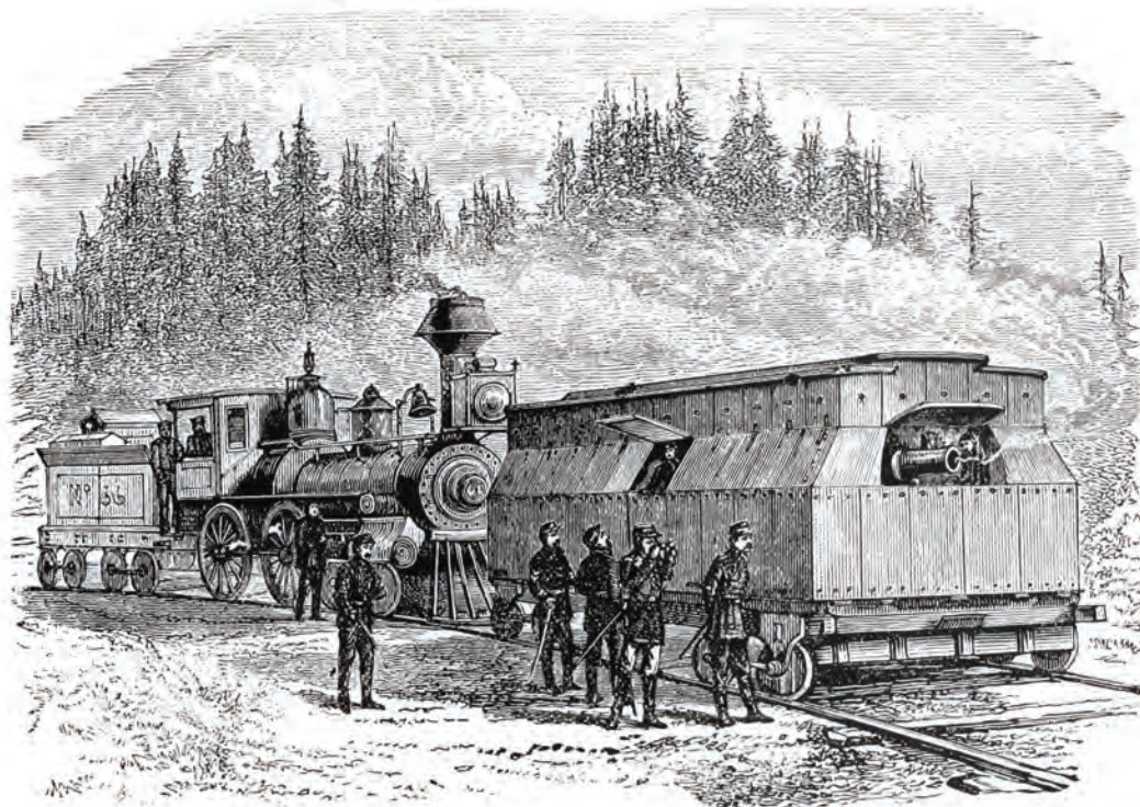
Două imagini ale primelor vagoane blindate din lume, construite în 1861, de firma Baldwin din Philadelphia, pentru Wilmington & Baltimore Railroad: au patrat în Havre de Grace și Baltimore (statul Maryland).
