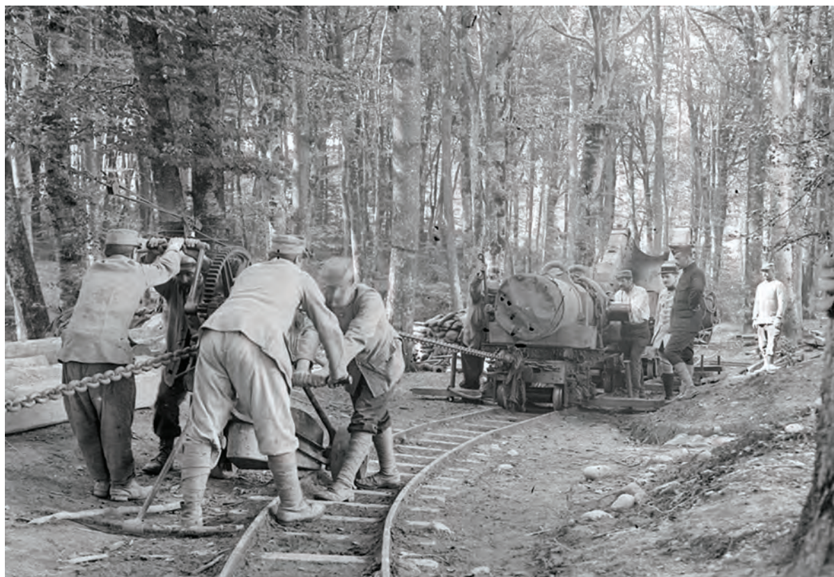
Manipularea pe o linie Decauville, la Dannemarie (Haut Rhin), a țevid unui obuzier A.L.V.F. de 240 mm, prin intermediul unui troliu acționat de 4 oameni.
