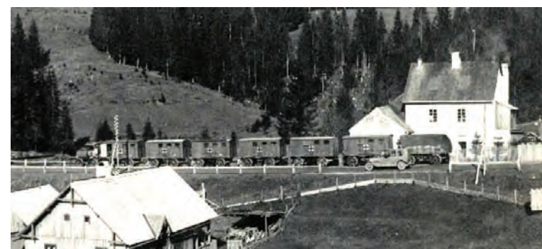
Vedere laterală a aceluiași tren sanitar, de la 31 octombrie 1916, care avea în componere vagonul-generator Nr. 21, șase vagoane sanitare pe 2 osii și un vagon de serviciu pe 2 osii pentru rechizite și unelte.
