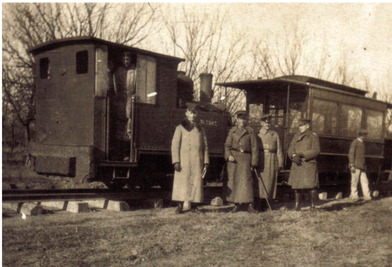
O linie militară, de 600 mm, construită în 1917 de trupele germane în România. Locația nu este precizată, posibil linia militară Râmnicu Sărat-Gulianca-Traian Sat (76,5 km), iar locomotiva-tender este tip C-n2t, cu trei osii cuplare. Vagonul pentru transportul trupelor poate să fi aparținut tramvaiului electric din Brăila sau Galați.
