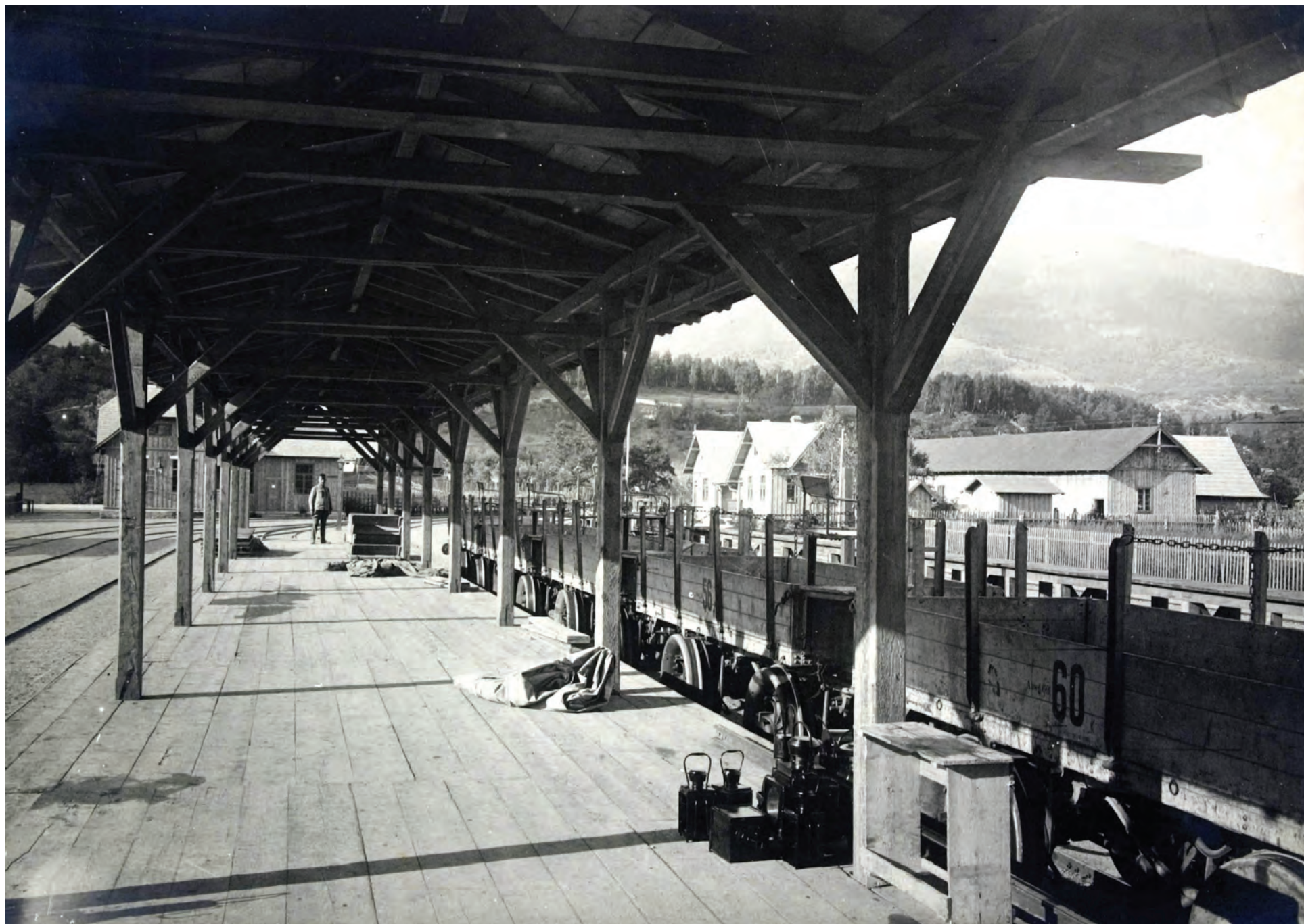
Rampa de încărcare-descărcare din stația Tiha Bârgăului la 1916: pe una dintre linii figurează vagoanele descoperite cu pereți mici, pe două osii, tip 1-A, Nr. 60, Nr. 56 și Nr. 53.
