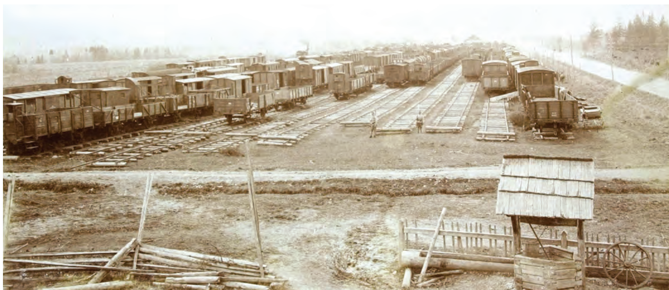
O altă imagine a triajului improvizat de la Dorna Burcut (Dorna Sauerbrunn), din iunie 1916: această metodă, de amplasare a vagoanelor pe linii dispuse direct pe teren, avea să fie utilizată și de CFR, la sfârșitul anului 1916, la retragerea armatei române în Moldova.
