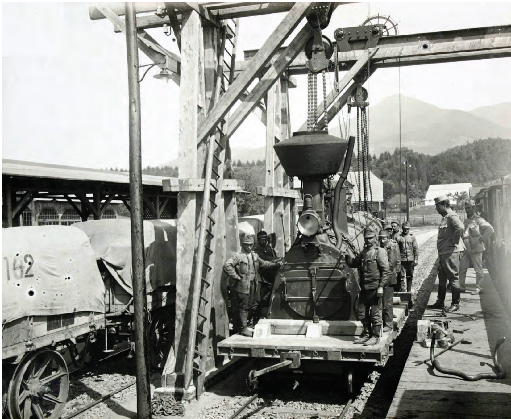
Instalația de ridicare de la Tiha Bârgăului: în prim-plan, descărcarea, la 4 iulie 1916, de pe un vagon platformă pe 4 osii tip 2-B a locomotivei-tender kkStB 94.35 tip C-n2t (Krl, nr. de fabricație 2.390/1891). Prima locomotivă, kkStB 94.33, a fost transportată pe linia Dornișoara-Tiha Bârgăului la 2 iulie 1916.
