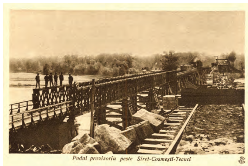
Podul provizoriu peste Siret de la Cosmești, realizat după Primul Război Mondial, cu grinzi independente dispuse pe palei din lemn.
