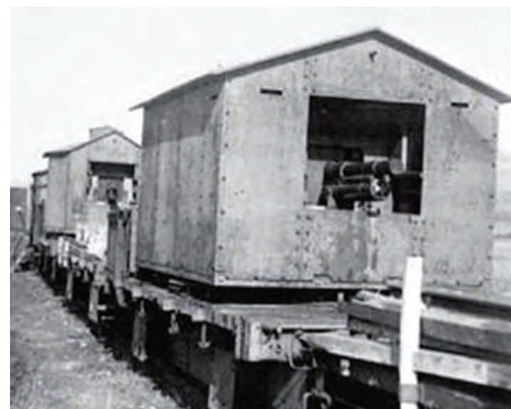
O locomotivă-tender blindată prusacă din seria pr.T 9³ tip 1C-n2t care circula, de obicei, cuplată cu unul sau două tendere blindate pe două osii.
