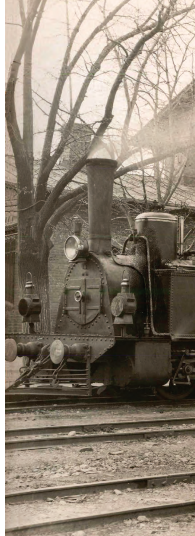
Unul dintre ultimele trenuri de călători ale liniei înguste Crasna-Huși, surprins la 14 aprilie 1937 în stația Huși, înainte de normalizarea liniei: este remorcat de locomotiva CFR 005-„CRASNA” (Hainaut, Couillet; nr. de fabricație 904/ 1887).
