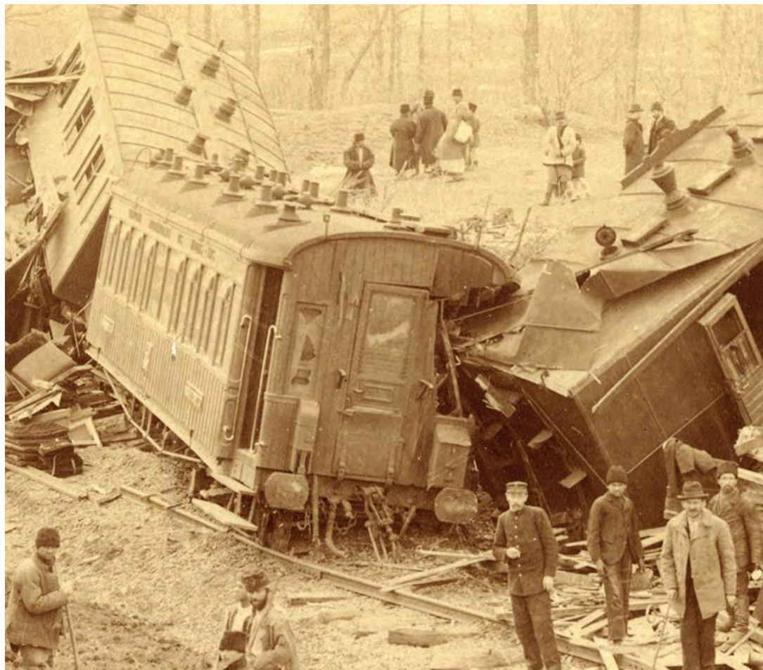
Un detaliu al vagonului de dormit CIWL pe patru osii, cu 8 compartimente/20 locuri clasa I, avariat la unul din capete de un vagon de poștă și bagaje, care a intrat cu partea dinspre compartimentul de poștă, cu două uși laterale, în platforma de acces.
