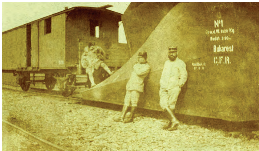
Un plug de zăpadă adus în România de la Varșovia, la 27 august 1917, de trupele germane: a fost repartizat la București, fiind numerotat Nr.1 și având înscrise, în germană, principalele date tehnice (greutatea - 8,52 tf. și ampatamentul - 2.900 mm). Fotografia datează din 13 martie 1919 când se găsea în triajul București și a fost fotografiat de un ofițer francez în trecere prin București.
