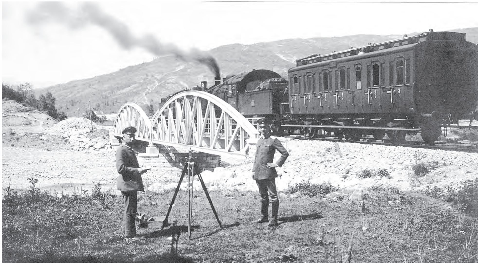
Proba, la 12 iunie 1918, a unui pod de cale ferată refăcut în România de trupele germane de căi ferate. Trenul de lucru era remorcat, în dublă tracțiune, de locomotive pr. G5 tip 1C-n2 și pr. G81 tip D-h2 și avea în componere și un vagon prusac de cl. a III-a, pe 3 osii, cu uși laterale și 5 compartimente /42 locuri.
