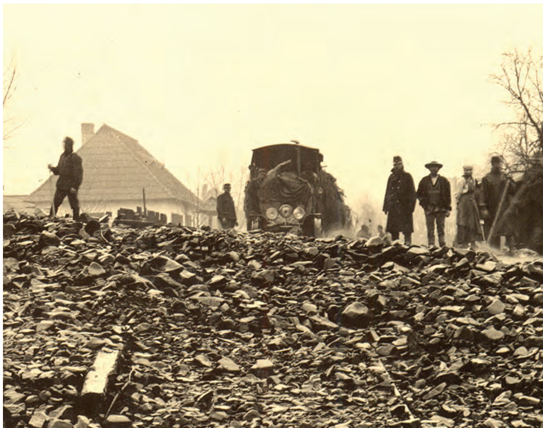
O porțiune a liniei Tiha Bârgăului-Dornișoara distrusă de ploi torențiale.
