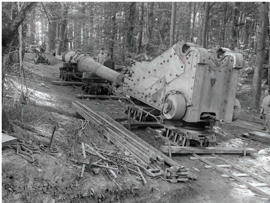
Deplasarea separată a afetului (pe două boghiuri Decauville) și a țevid (pe două boghiuri Péchot pe 3 osii) a unui obuzier francez A.L.V.F. de 240 mm pe o linie Decauville, de 600mm, în Alsacia, la Dannemarie (Haut Rhin), la 1 august 1916, în timpul Primului Război Mondial.
