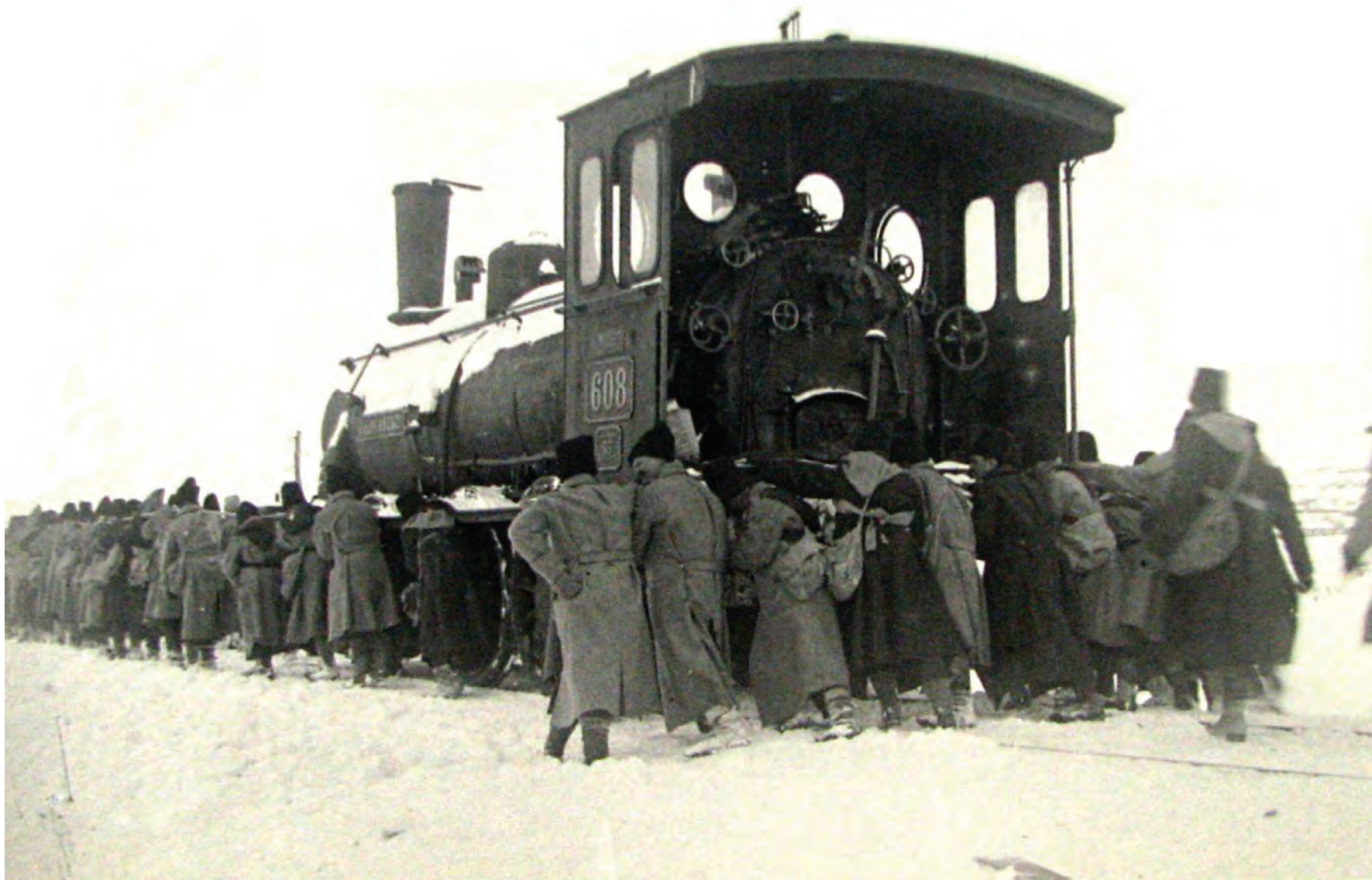
Transportul de către soldații români, pe liniile de cale ferată din Moldova, în iarna anului 1917, a locomotivei înghețate CFR 608-“CĂLIMĂNEȘTI”(ex.CFR 225-“CĂLIMĂNEȘTI”) tip C-n2 (Société Franco-Belge de Matériel de Chemins de Fer; nr.de fabricație 726/1890 ) din seria CFR 224-243/ CFR 607-626.Locomotiva avea greutatea în serviciu de 40,6 tf. și o viteză maximă de circulație de 55 km/h. (Foto. inginer Stelian Petrescu).
