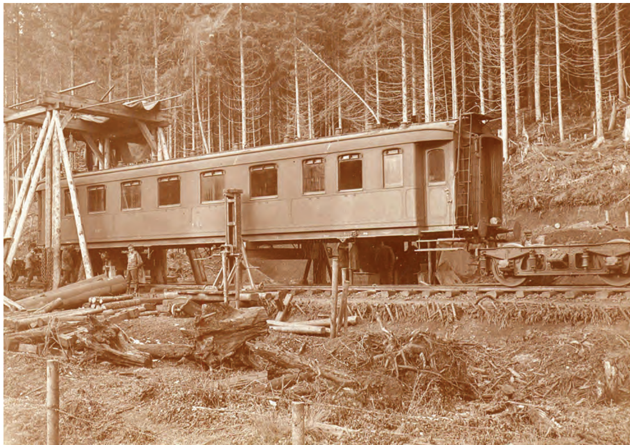
Ridicarea vagonului de călători austriac kStB Ca 37-292 pe 4 osii și încărcarea lui pe platformele pe 4 osii ale trenului benzino-electric. Vagonul făcea parte din garnitura trenului accelerat Cernăuți-Viena (remorcat de locomotiva kStB 206.40 iip 2B-n2v), care rămăsese blocată în Bucovina. Singura modalitate de evacuare era linia Dornișoara-Tiha Bârgăului, deoarece trupele austriece în retragere distruseseră podul de cale ferată peste Prut de la Cernăuți.
