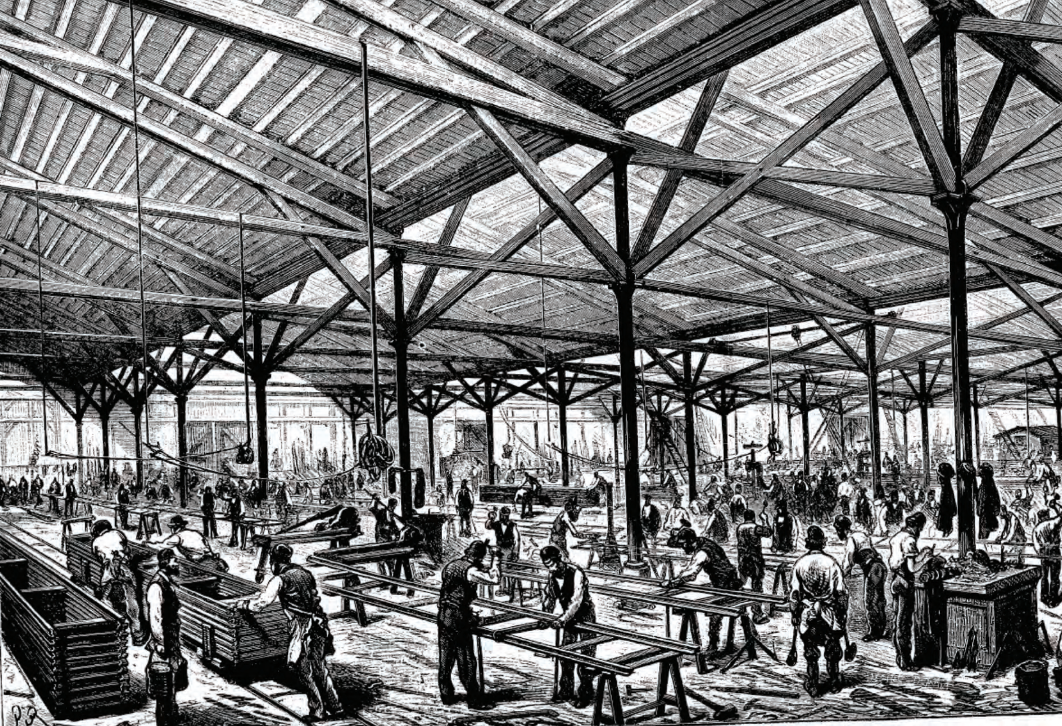
Atelierele Decauville de la Petit-Bourg (Seine et Oise) la 1878: se fabricau panouri drepte și curbe, plăci turnante și diferite tipuri de vagoneți. În perioada 1878-1892, societatea Decauville Ainé a livrat, ca intermediar, diferiților beneficiari, și un număr de 160 de locomotive-tender cu abur, de ecartament îngust, de tip B-n2t, B1-n2t, BB-n2t și C1-n2t, care au fost însă construite de fabricile de locomotive Corpet-Louvet, Hainaut-Couillet, Tubize, Franco Belge-Raismes și Weidknecht Frères (Atelier de Constructios du Pont Flandre, Weidknecht Frères, Paris). Aceste locomotive au figurat atât în listele de fabricație ale fabricilor care le-au construit cât și în listele de livrare ale societății Decauville unde au primit numere de la 1 la 160. Astfel, prima locomotivă utilizată pe o linie Decauville, de 500 mm, „LILIPUT” tip B-n2t (Corpet-Louvet; nr. de fabricație 242/1878) a purtat în listele de livrare ale societății Decauville Ainé nr. de livrare 1/1878.
