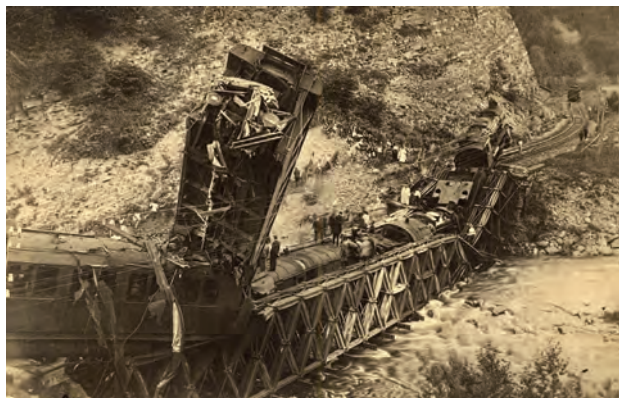
Podul de la Valea Largă, km 58+550, după ruperea lui, prin flambare laterală a grinzilor principale: a constituit primul pod din România căzut sub circulație.
