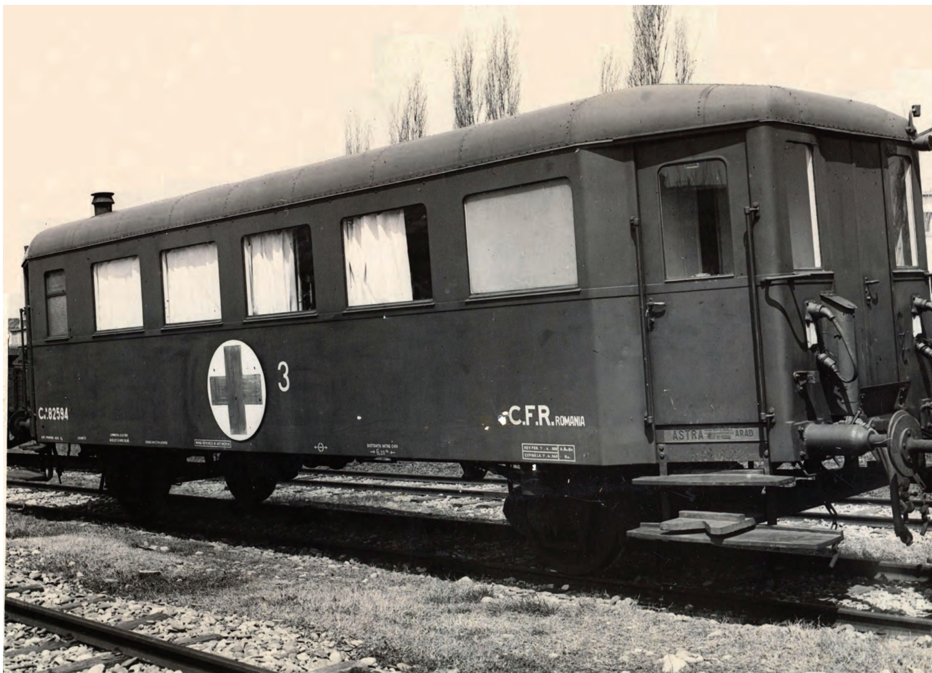
Vagonul sanitar CFR CMM 82.594 (ASTRA-Arad; nr. de fabricație 20.401/1938): a rezultat prin amenajarea unui vagon remorcă pe două osii pentru automotoare din seria CFR CMM 82.575-82.610 (ASTRA-Arad; fabricație 1937-1938). Avea lungimea peste tampoane de 11.530 mm, lungimea cutiei vagonului de 10.250 mm, ampatamentul de 6.200 mm și tara de 11 tf.
