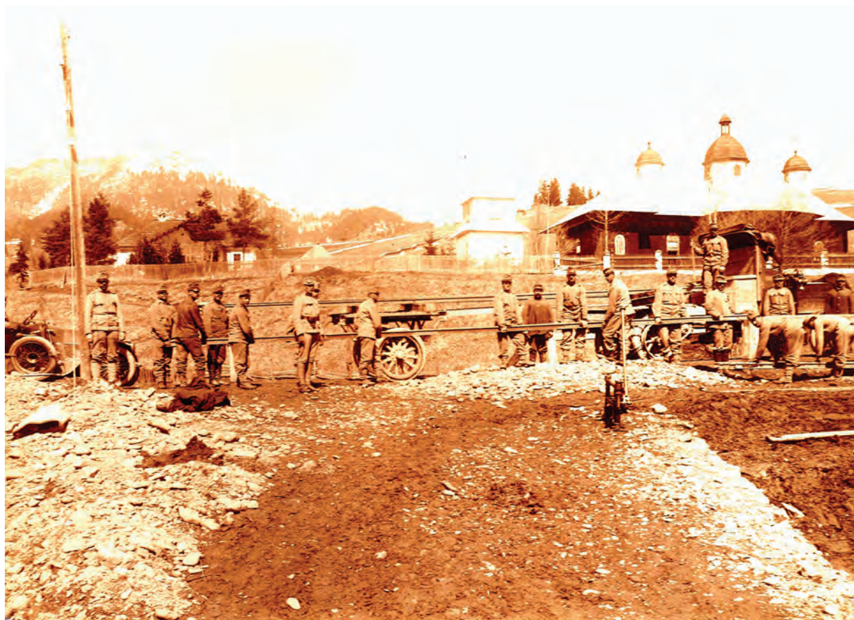
Punctul Pietra Fântânele, ulterior Mânăstirea Fântânelelor (alt. 1.145 m), între halta Măgura/Alter Umschlagplatz și halta Șândroaia, în vara anului 1915, la montarea liniilor de către k.u.k. Eisenbahn-Betriebskompanie Nr.2: transportul șinelor, cu lungimi de 10 m, se efectua cu tractoare și remorci rutiere.
