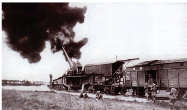
Un tun german tip 28 cm SK L/40 - „Bruno” de 283 mm în timpul tragerii: în perioada 1916-1918, firma Krupp a livrat 22 de unități, care erau montate pe platforme cu 10 osii (două boghiuri a câte 5 osii) și aveau o greutate de 156 tone. Puteau trimite un obuz de 240 kg, cu 785 m/s, la o distanță de 20,05 km. În cazul utilizării unui proiectil de 284 kg, acesta putea fi trimis, cu o viteză inițială de 740 m/s, la o distanță de 27,75 km.
