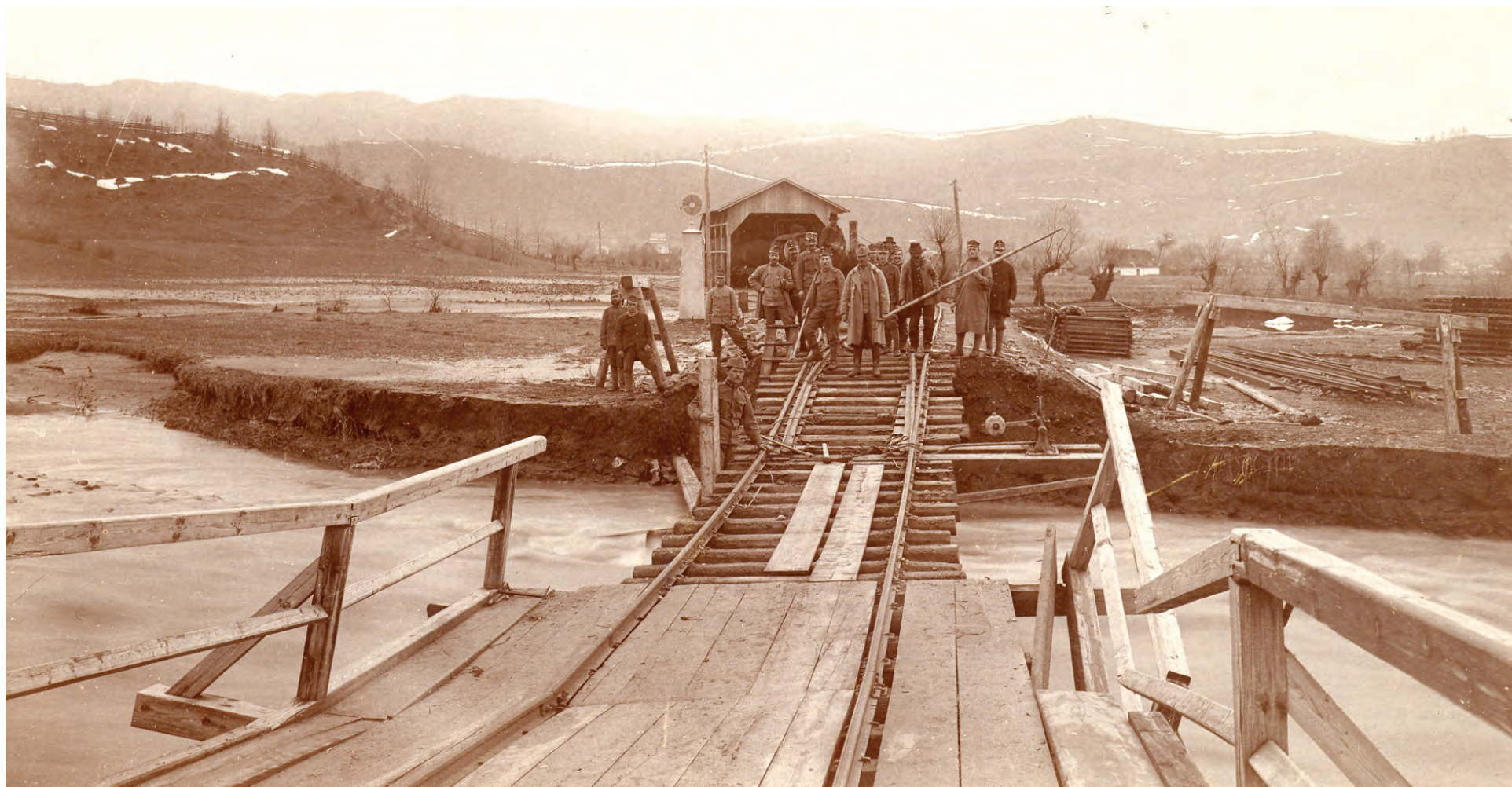
Pod din lemn peste râul Bistrița, în apropiere de Tiha Bârgăului, deteriorat în urma ploilor torențiale. La intrarea în stație, pe partea stângă a liniei, se afla un semnal tip Banovici.
