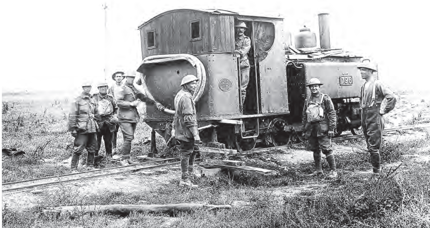
Locomotiva-tender militară Nr.796 tip 2C-n2t (Baldwin; fabricație 1917), de ecartament îngust (600 mm), cu batalionul 3 de pionieri al diviziei australiene, în 1917, în nordul Franței, la Harbonnières (Somme).
