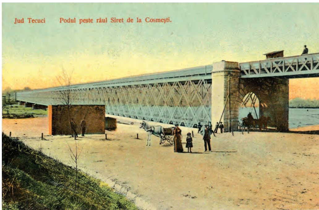
Podul combinat peste Siret, de la Cosmești, șosea la partea inferioară și cale ferată la partea superioară: a fost construit în 1885 după proiectele inginerului Anghel Saligny cu o structură din două grinzi continue pe trei deschideri de 69,32+77,04+69,32 m. În timpul Primului Război Mondial a fost aruncat în aer deși se afla în spatele frontului. Avea să fie refăcut, pentru cale dublă, în perioada 1924-1932, cu 8 deschideri de: 18,00+68,80+75,68+2x68,80+75,68+68,80+18,00 m.
