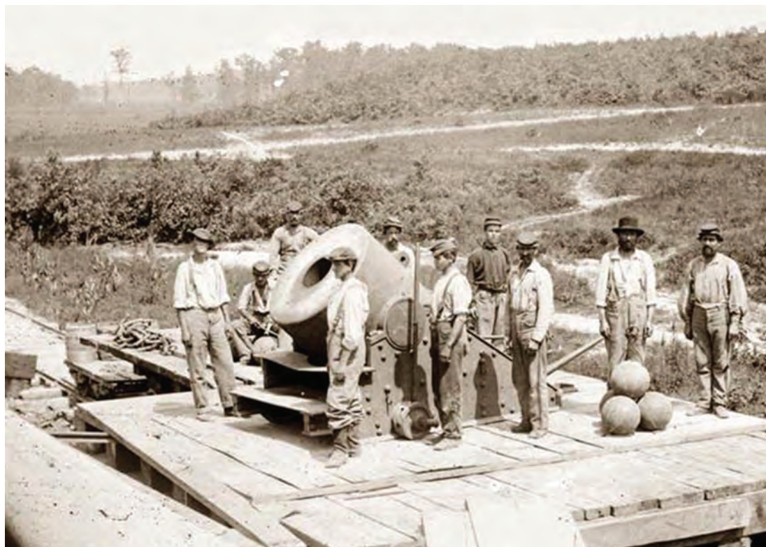
Două imagini cu vagonul platformă port-tun de 13 in (330 mm) „The Dictator” al armatei nordiste: a fost construit în 1864 și a participat la asediul trupelor sudiste din Petersburg și Richmond.
