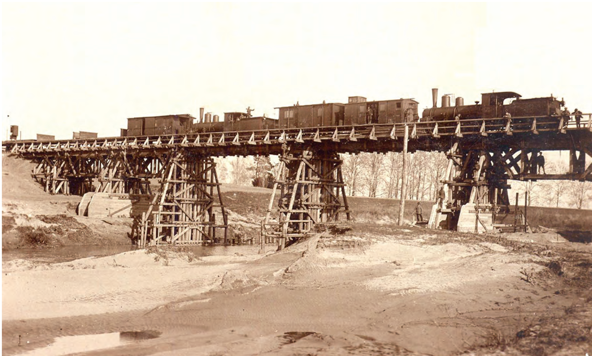
Refacerea, la 6 aprilie 1923, a podului de cale ferată peste Crișul Alb: imaginea este foarte rară și prezintă interes și prin faptul că pe pod staționează două locomotive din seria MÁV-CFR 220 tip 2B-n2 și trei vagoane vechi de bagaje.
