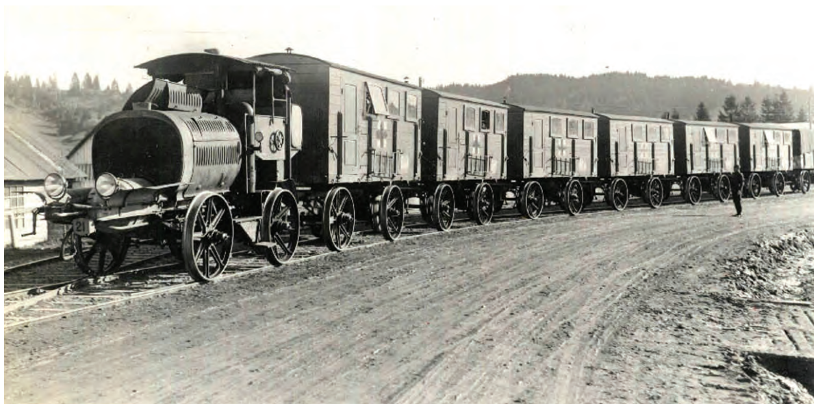
Tren sanitar pentru transportul răniților pe linia Dornișoara-Tiha Bârgăului, compus din șase vagoane sanitare și un vagon de ajutor (cu rechizite și unelte), dispus la coada trenului, remorcat la 31 octombrie 1916 de vagonul-generator tip 1-A / 1914 Nr. 21. Cele șase vagoane sanitare erau dotate cu instalație de iluminat și încălzire.
