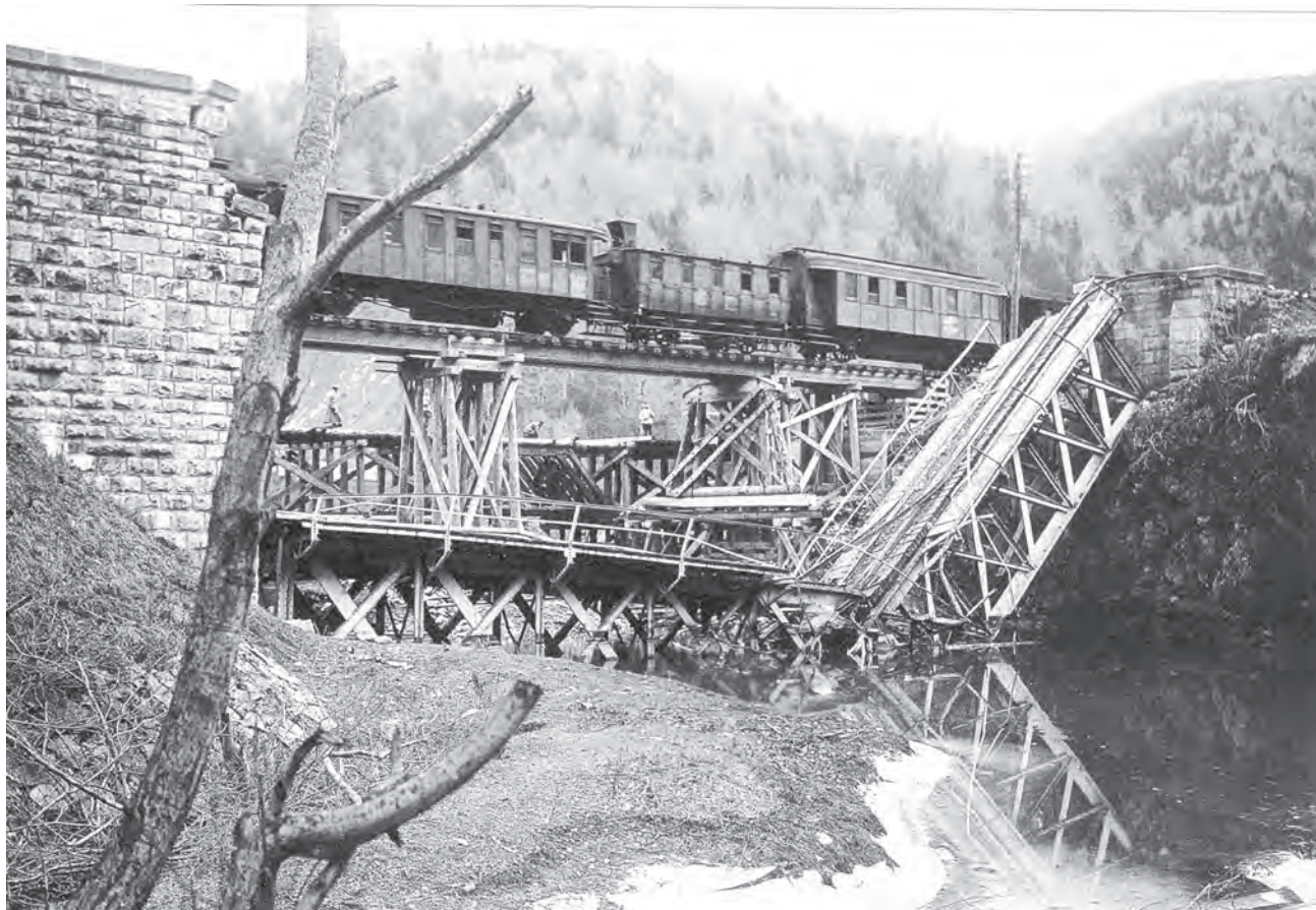
Podul Nr. 2 al liniei Predeal-Ploiești (situat la km 75,32 față de stația Ploiești) a fost refăcut de trupele bavareze de căi ferate și dat în exploatare provizorie în februarie 1917: pe pod figurează un tren de lucru cu vagoane bavareze și MÁV.
