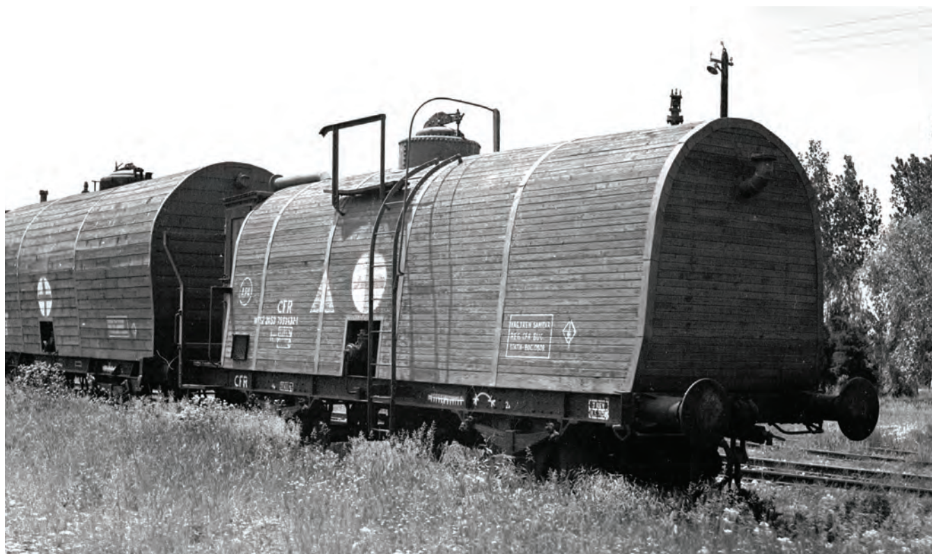
Două vagoane sanitare-cisternă pentru transportul apei, surprinse, la 1 iunie 1980, în stația Snagov: în prim plan, figurează vagonul CFR WTSZ 20 53-7993-432-1 cu tara de 11,5 tone și capacitatea de încărcare de 15 tone (15 m 3 ), care poartă înscrisul „Vagon tren sanitar. Reg. CFR Buc. Stația Buc.Obor”.
