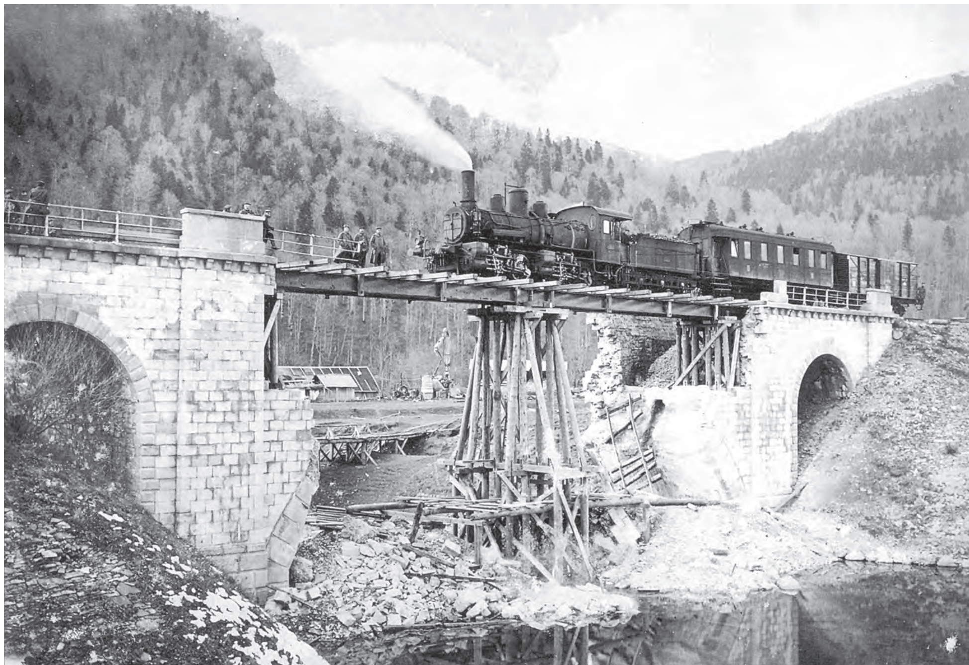
Podul Nr. 1 al liniei Predeal-Ploiești (amplasat, în 1916, față de stația Ploiești la km 77,0 și față de stația București Nord la km 136,5): a fost distrus de trupele române în retragere și refăcut în perioada octombrie 1916- februarie 1917 de trupele bavareze de căi ferate. Pe podul provizoriu, trenul de lucru era remorcat de o locomotivă Mallet tip BB-n4v din seria MÁV 422.
