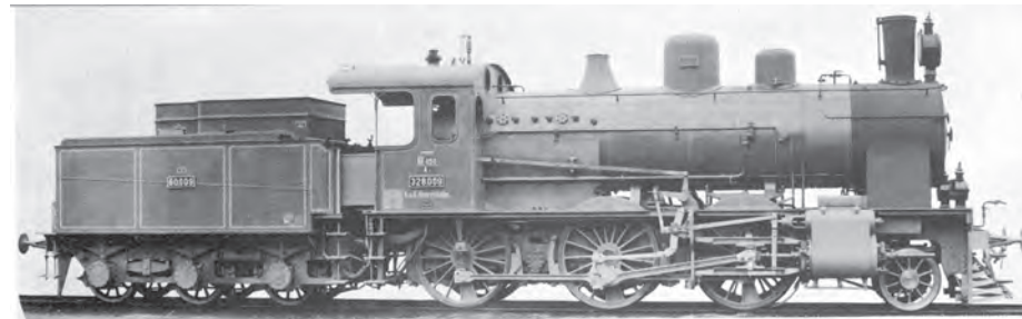
Locomotiva k.u.k. Heeresbahn 328.009 din seria k.u.k. HB 328.001-328.020 tip 1C-h2 (Schwartzkopff, Berlin; nr.de fabricație 5.456/1916-5.475/1916): făcea parte din seria CFR 2.070-2.093 ce fusese comandată, în 1915, în Germania, în 24 de unități. După livrarea, în 1916, a primelor 4 locomotive (CFR 2.070-2.073), România a intrat în război și următoarele locomotive din serie au fost livrate trupelor austro-ungare, ca k.u.k. HB 328.001-328.020, și au fost repartizate Direcției Militare Craiova (Militärdirektion Craiova).
