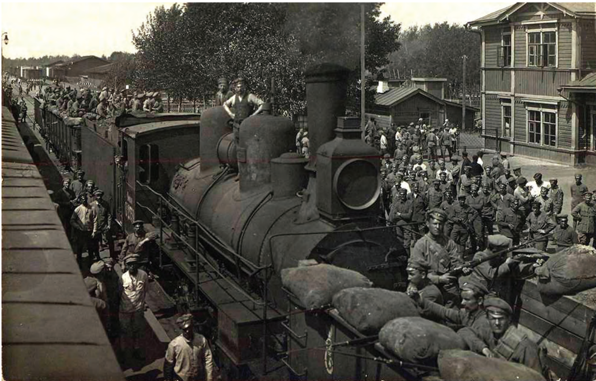
Unul dintre primele trenuri blindate improvizate ale legiunii cehe, în 1918, în stația Isil-Kul (Regiunea Omsk): era constituit dintr-o locomotivă din seria O B tip D-n2, dispusă central, și din două vagoane metalice pentru cărbuni, pe patru osii, protejate cu saci de nisip și echipate cu mitraliere.
