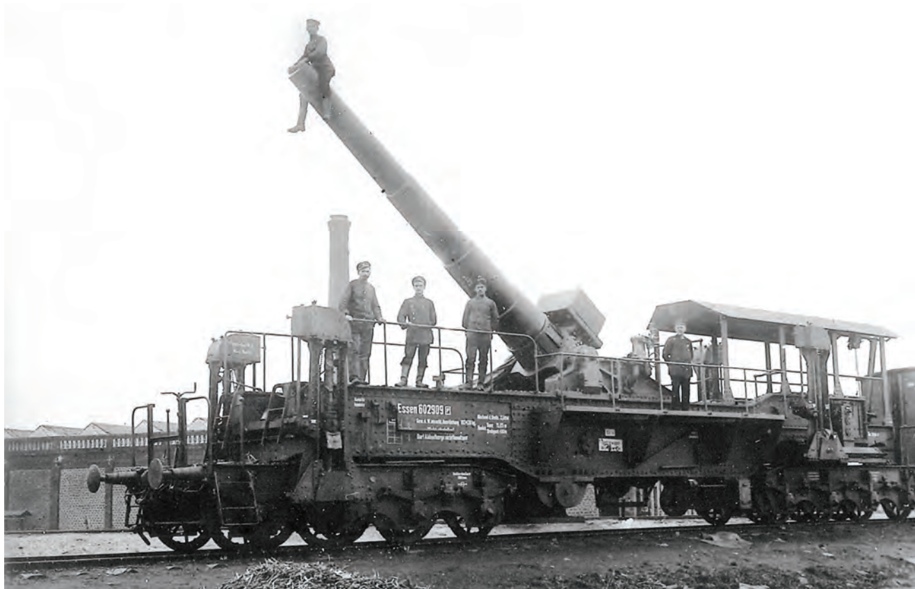
Tunul german tip 24 cm S.K. L/40 Essen 602.209 (Krupp; fabricație 1917), amplasat pe un vagon platformă pe 8 osii: avea greutatea totală de 103,43 tone, greutatea tunului de marină de 25,6 tone și putea trimite obuze de 140 sau 151 kg până la o distanță de 19,1 km.
