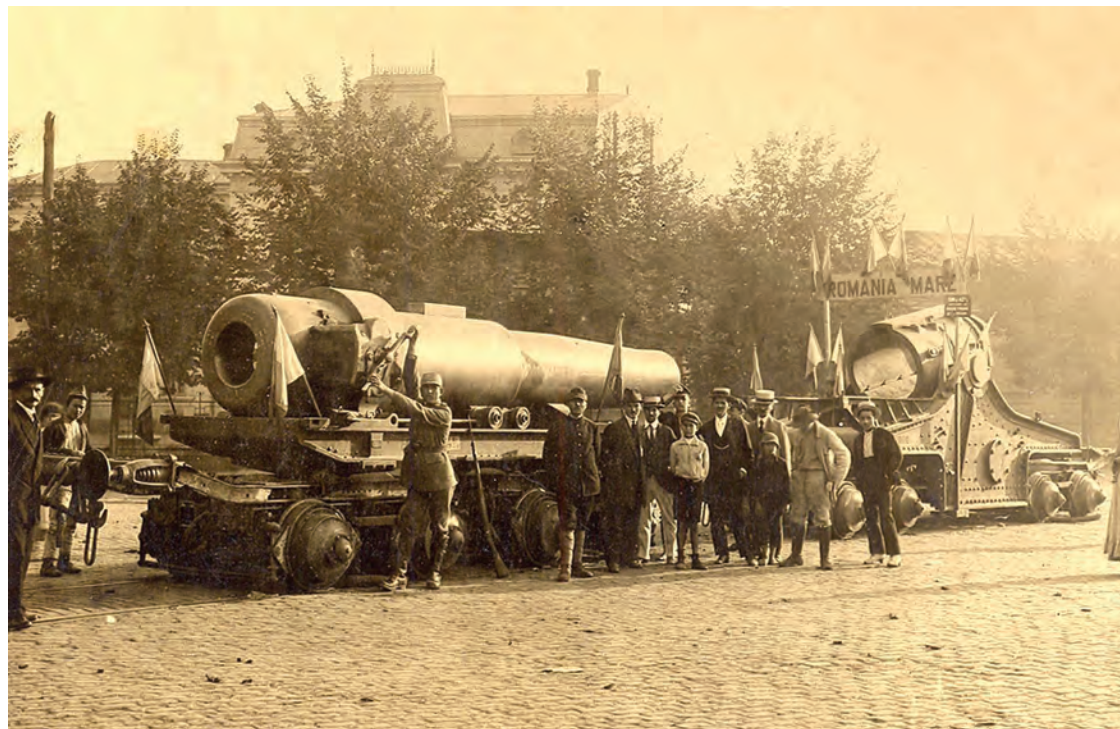
Două imagini ale vagonului port-afet și ale vagonului port-țeavă ale obuzierului, de 420 mm, Nr. 7 (Skoda Werke, Pilsen, nr. de fabricație 5.620/1916), expuse la 18 septembrie 1919 în fața rotondei centrale a Parcului Carol I: erau împodobite cu steaguri tricolore și purtau înscripția „ROMÂNIA MARE”.
