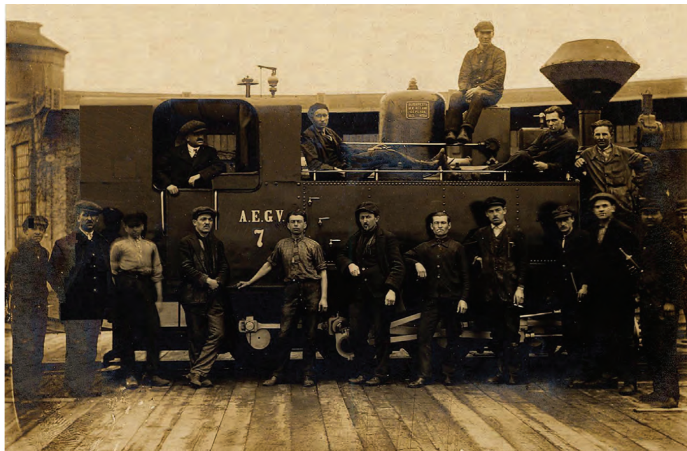
Locomotiva AEGV Nr. 7 - MÁV 492.011 tip D-n2t (MAVAG, Budapesta ; model MÁV 85 11 ; nr. de fabricație 4.755/1924) a liniei ungare AEGV (Alföldi Első Gazdasági Vasút), surprinsă în martie 1925 în depoul stației Bekéscsaba. Deși de un model cu mici îmbunătățiri, locomotivele din seria MÁV 492.010-018, construite în Ungaria după Primul Război Mondial, se aseamănau mult cu locomotivele din seria MÁV/CFR 492.001-008 (fabricație 1909-1910).
