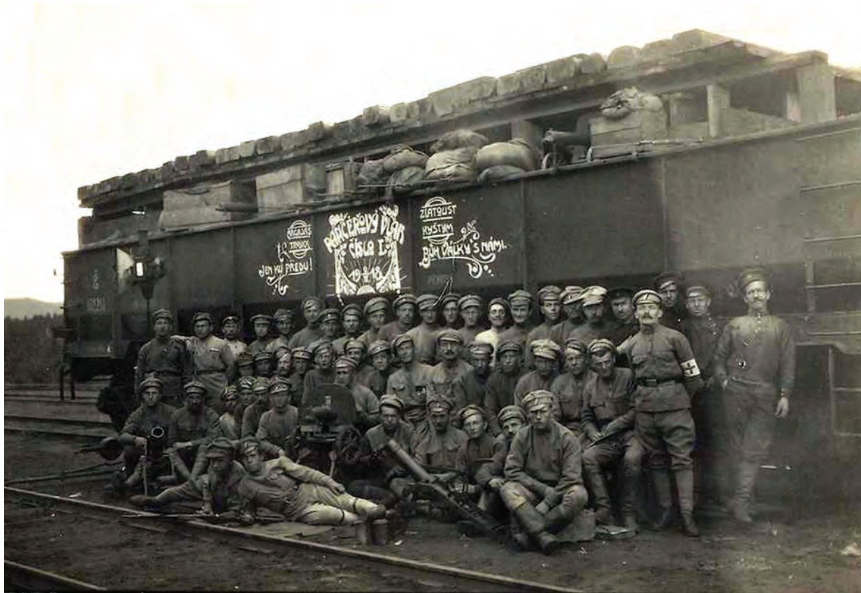
Un vagon blindat improvisat, pe 4 osii, din 1918, al legiunii cehoslovace din Siberia: era echipat cu mitraliere și, de această dată, avea montat și un acoperiș din traverse de lemn.
