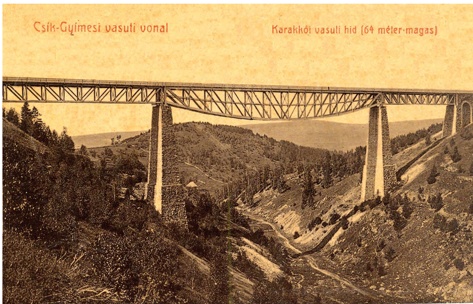
Viaductul Caracău, cu o înălțime de 64 m și o lungime totală de 264,60 m, inaugurat la 18 octombrie 1897, odată cu linia Ciceu-Ghimeș (41 km). Deschiderea centrală, de 101,76 m, a fost distrusă de trupele austro-ungare în vara anului 1916 și refăcută, apoi, în perioada 1 noiembrie 1916-27 martie 1917.
