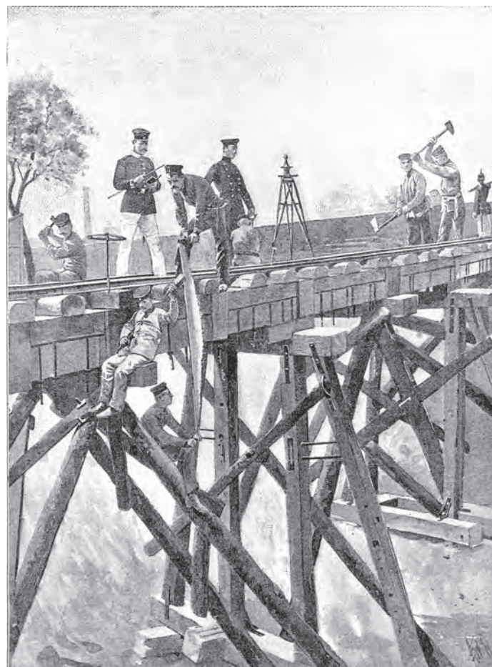
Construcția unui pod provizoriu de trupele germane de cale ferată la 1897: după, The Graphic, October 16, 1897.
