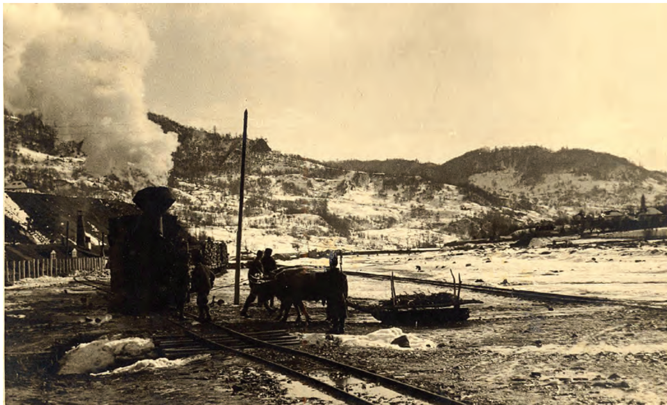
Linia militară Prislopbahn, la 1917, pe tronsonul Prislop-Cârlibaba-Iacobeni (28 de km), cu declivități maxime de 39 mm/m.
