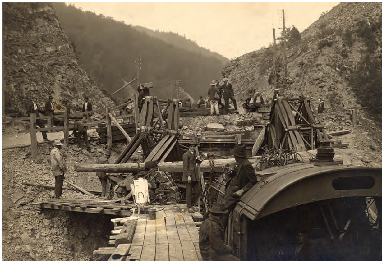
Podul de la Valea Largă prăbușit, în timpul lucrărilor de restabilire a circulației.
