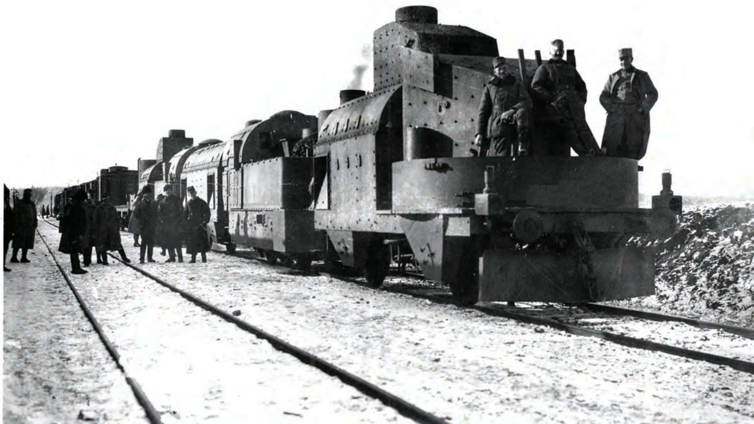
Trenul blindat austro-ungar Nr. VIII, de tip greu, așa numitul „Schwerer Panzerzug”. Era format din două locomotive din seria MÁV 377 tip C-n2t, un vagon blindat de infanterie pe 2 osii și două vagoane-tun blindate, dispuse la capetele trenului.
