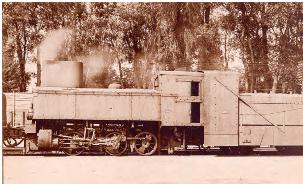
Locomotiva-tender blindată kkStB 97.247 (tip C-n2t), cuplată cu tenderul blindat pe 3 osii kkStB 76.177, din compunerea trenului blindat austro-ungar Nr. XI, (în 1917, renumerotat Nr. IX).
