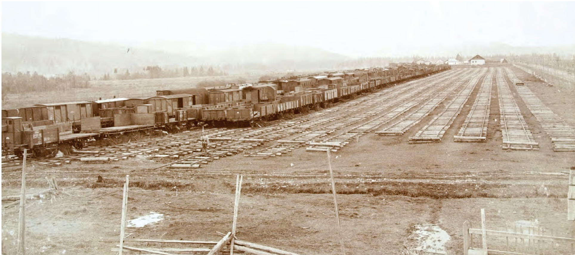
Triajul de la Dorna Burcut în iunie 1916: aici aveau să fie depozitate, înainte de expedierea lor pe linia Dornișoara-Tiha Bârgăului, pe linii montate direct pe teren, 2.484 vagoane de diverse tipuri.
