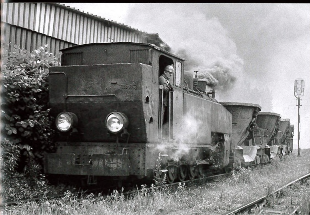
Chorzów. Huta „Kościuszko”. Parowóz nr 3 13953 (seria PKP Tw53) ciągnie kadzie do przewożenia płynnego żużlu. 21.06.1991 r.
