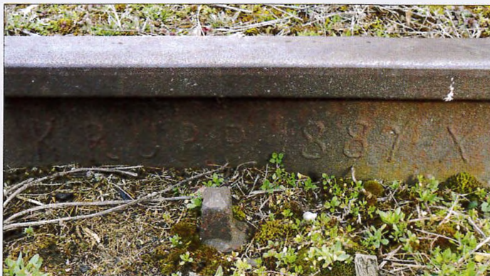
Szyna wąskotorowa firmy Krupp z 1887 r. zamontowana w torze jezdny suwnicy. 26.03.2016 r.
