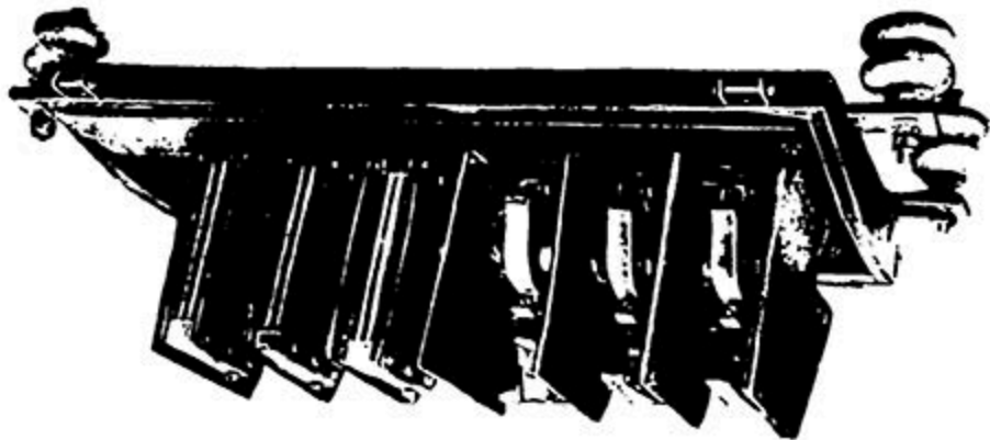
Рис. 61. Ящик со смонтированными электромагнитными контакторами ДБ-928.
