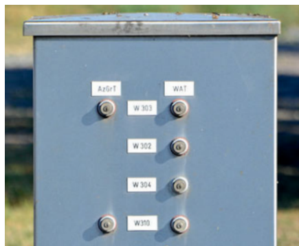
Schaltschrank mit Hilfstasten WAT (Weichenauffahrtaste) und AzGrT (Achszählergrundstellungstaste)
