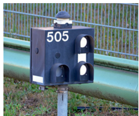
Dieser EOW-Leuchtmelder gehört zu einer Weiche mit Vorzugslage und trägt einen zusätzlichen lokalen Taster zur Weichenumstellung.
