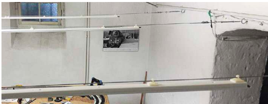
Mit selbstklebenden Sockeln werden die Kabelkanäle am Drahtseil befestigt. Dabei kommen zwischen den Sockel und dem Drahtseil Kabelbinder zum Einsatz. Seilspanner sorgen dafür, dass Seile und Kabelkanäle nicht durchhängen.
