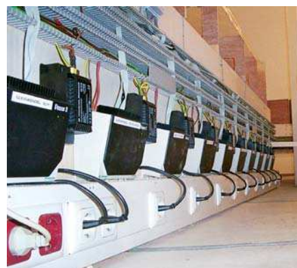
Eine lange Reihe von Boostern sorgt dafür, dass alle Züge ausreichend Strom bekommen.
