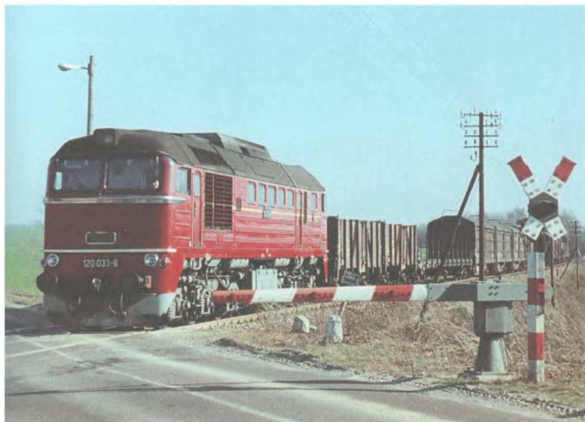
Die 120 033 passiert am 24. März 1974 mit ihrem Güterzug einen Bahnübergang bei Bergen. Die Lokomotive wurde nachträglich mit einem in der VES-M entwickelten Schalldämpfer ausgerüstet, der an seiner kantigen Form auf dem Dach gut erkennbar ist. Foto: Hans Dörschel
