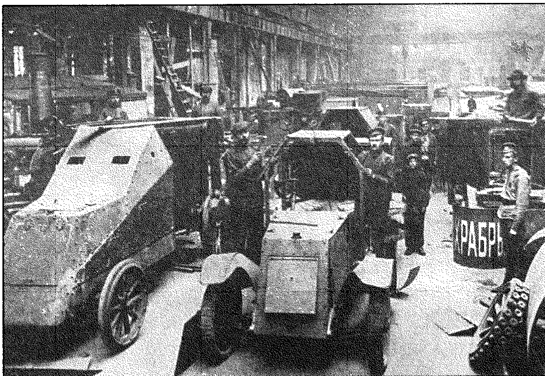
Бронировка грузовика «Уайт» (слева) и перебронировка «Остина» 1-й серии на Ижорском заводе. 1915 год (РГАКФД СПб).
