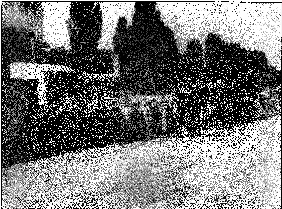
Бронепоезд «Хунхуз», построенный 4-й ротой 2-го Заамурского железнодорожного батальона в Киевских мастерских. Сентябрь 1915 года. На будке машиниста видна табличка с названием (РГВИА).
