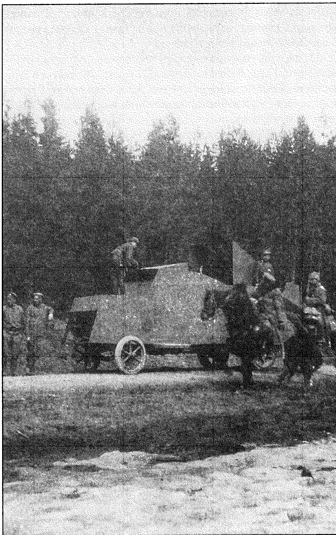
Бронированный грузовик «Маннесманн-Мулаг» с 37-мм автоматической пушкой готовится к бою. 1916 год (ГЦМСИР).
