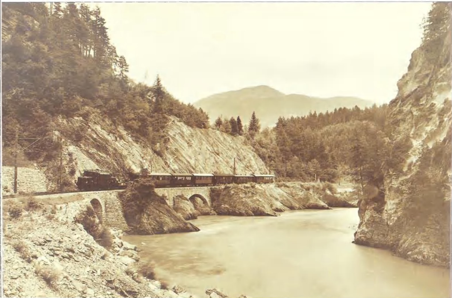
Bild 39: Die Kurve beim Wackenauer Sporn zwischen Trin und Reichenau-T. wird 1922 von einem elektrischen Probezug durchfahren. Die Experten im Flachwagen hinter der Krokodillok Ge 6/6 verfolgen genau den Verlauf des Fahrdrabtes. Abb.: Archiv RhB
