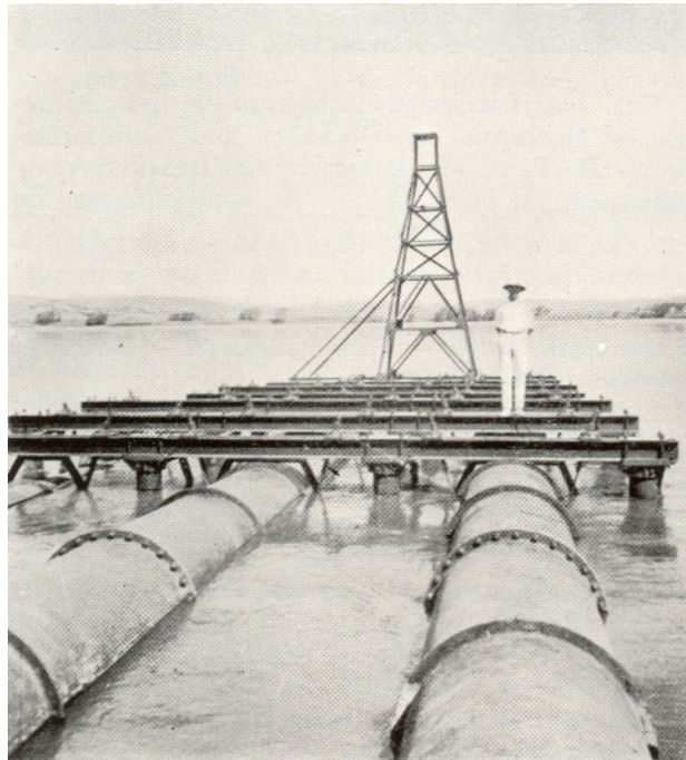
3 ábra. Vasszerkezet a szívóvezeték felfüggesztésére a folyóban. – Eisenkonstruktion zur Aufhängung der Saugleitung im Flusse. – Iron construction for suspending the suction piping in the river. – Construction de fer pour la suspension de la tuyauterie d'aspiration dans le fleuve.
