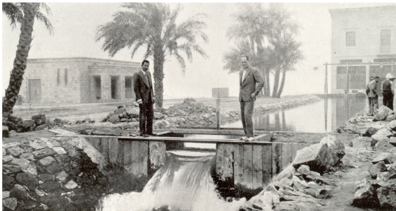
10. ábra. Bukógát vízméréshez. – Überfallwehr für die Wassermessung. – Overfall weir for the measurement of water. – Digue de déversoir pour la mesure de l'eau.
